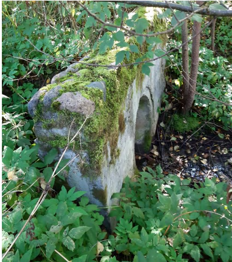
Фото 21. Вид на бетонный оголовок трубы.
