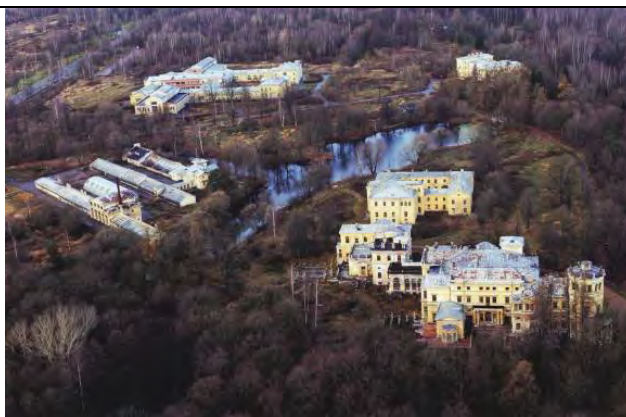
Общий вид дворцово-паркового ансамбля Михайловской дачи с восточной стороны. Фотография. 2007 // Андреева В.И., Герасимов В.В. Михайловская дача. Дворцово-парковый ансамбль. СПб., 2013. С. 8
