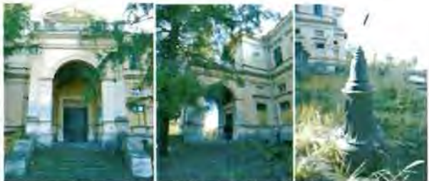
Главный подъезд Большого дворца. Тумба фонаря. Фотография, 2015
