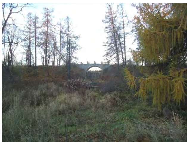
Мост-плотина. Вид от Нижней дороги. Фотография. 2015
