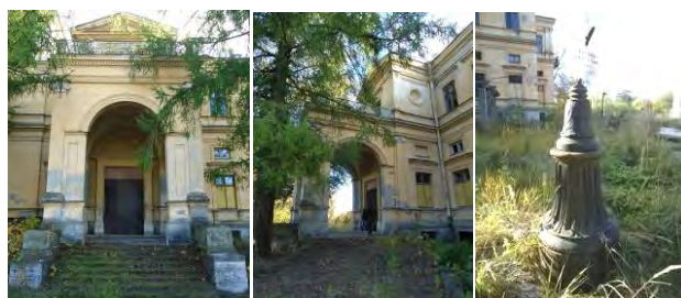
Главный подъезд Большого дворца. Тумба фонаря. Фотография. 2015
