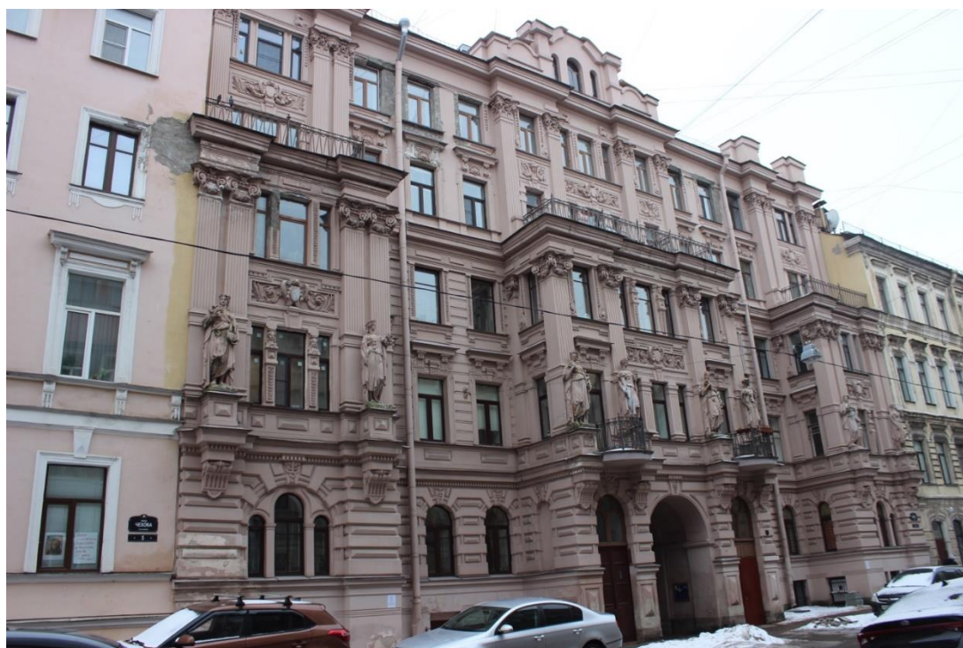
1. Здание по адресу: Санкт-Петербург, улица Чехова, д.3, Лит. А. Общий вид лицевого фасада
