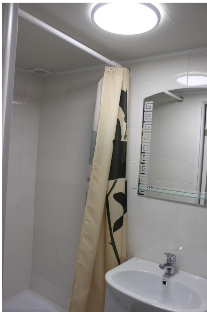
8. Здание по адресу: Санкт-Петербург, улица Чехова, д.3, Лит. А. Санузел в квартире № 6
