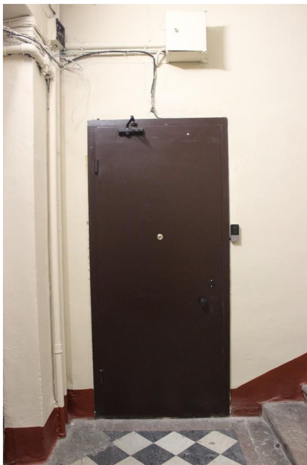
4. Здание по адресу: Санкт-Петербург, улица Чехова, д.3, Лит. А. Вход в квартиру № 6
