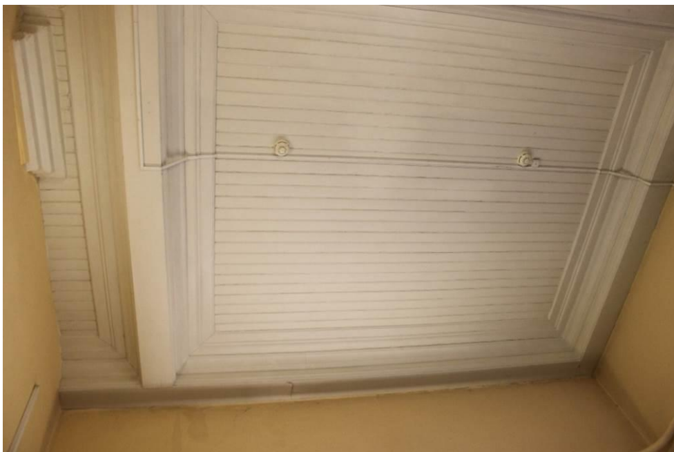
Фото 13. Объект культурного наследия регионального значения «Железнодорожная станция Левашово: вокзал» по адресу: г. Санкт-Петербург, п. Левашово, Железнодорожная ул., д. 7, лит. А (Левашово, железнодорожная станция. Вокзальное шоссе, 43). Вид на плафоны подшивные кессонированные в помещениях №10, являющиеся предметом охраны. Дата: 28.11.2022г.
