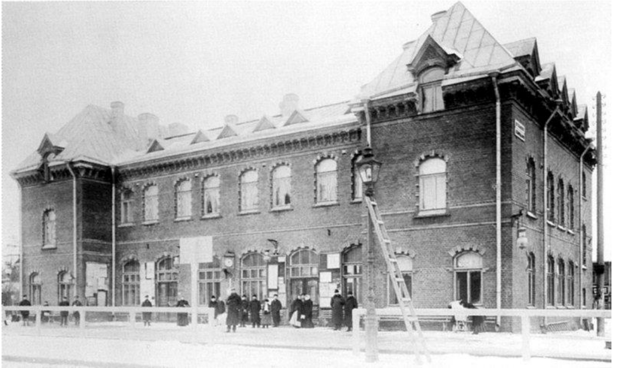
22. Финляндская железная дорога. Вокзал станции Шувалово. Вид со стороны путей (без навеса). Арх. Бруно Гренхольм. 1898. Фото. Конец XIX – нач. XX вв. [railway/ru_shuvalovo.php]
