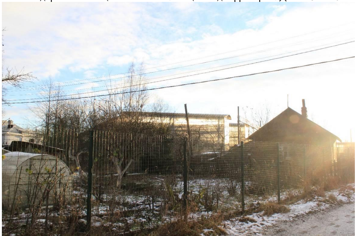
Фото 36. Территория объекта культурного наследия регионального значения «Железнодорожная станция Левашово». Общий вид территории Дата: 28.11.2022 г.
