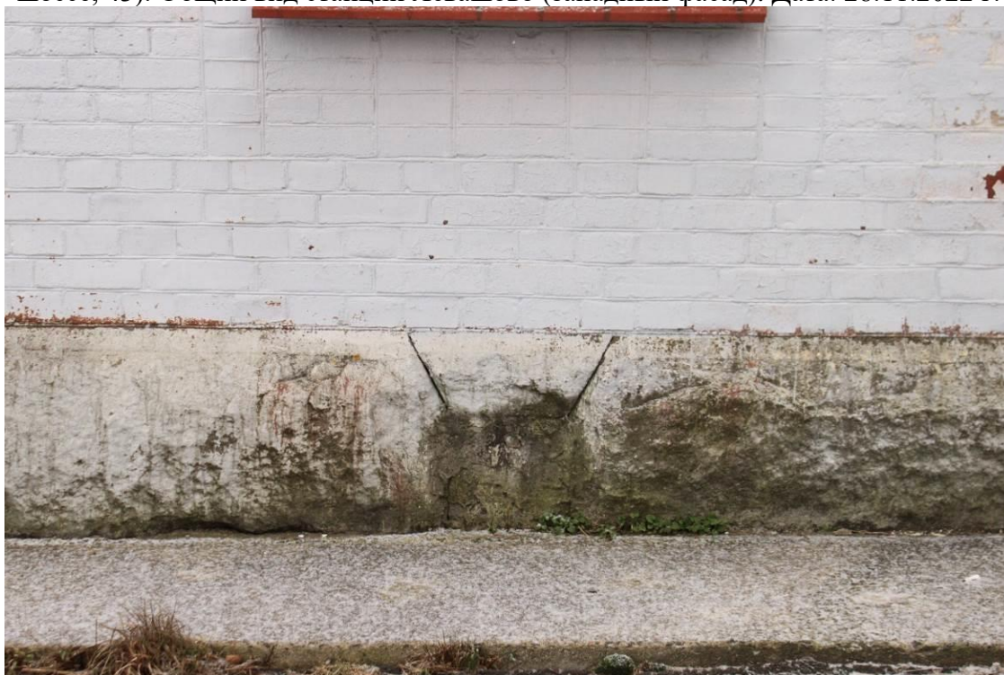
Фото 18. Объект культурного наследия регионального значения «Железнодорожная станция Левашово: вокзал» по адресу: г. Санкт-Петербург, п. Левашово, Железнодорожная ул., д. 7, лит. А (Левашово, железнодорожная станция. Вокзальное шоссе, 43). Вид на заложенное вентиляционное окно в уровне цоколя (западный фасад). Дата: 28.11.2022 г.
