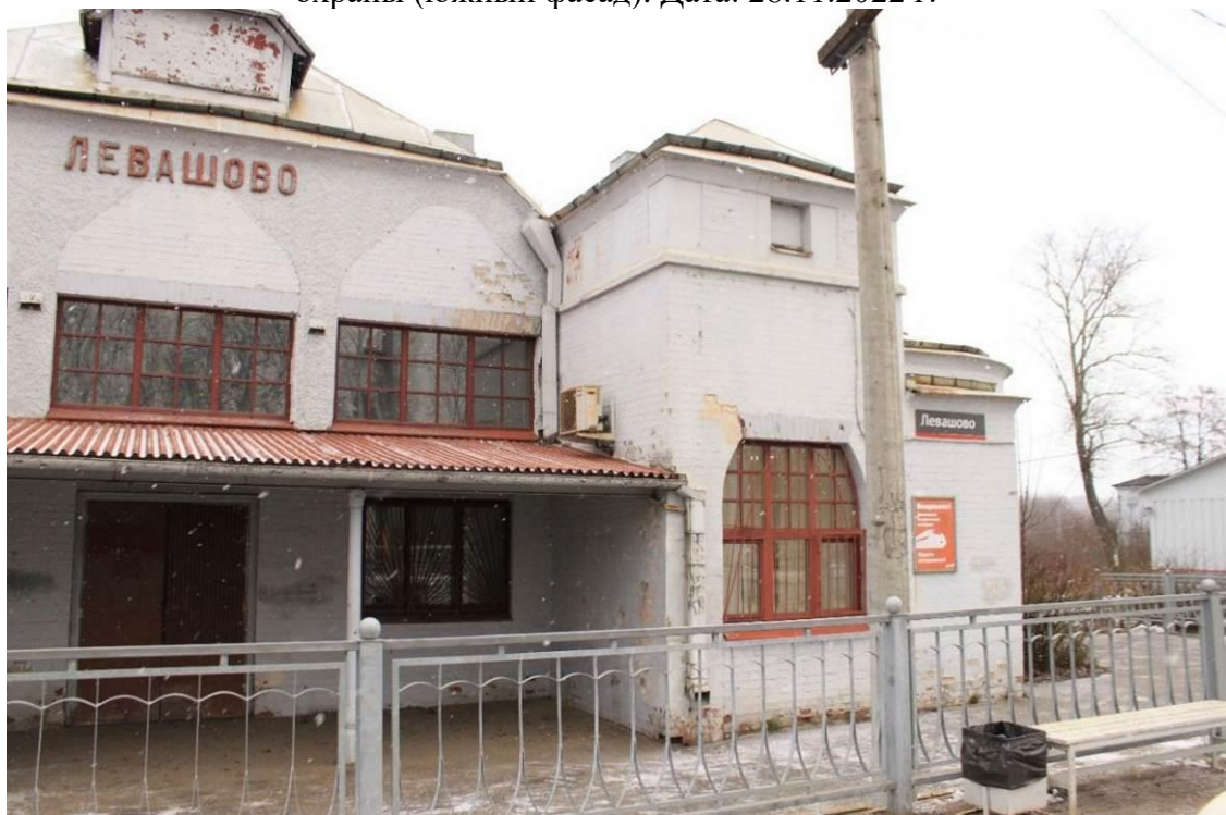
Фото 6. Объект культурного наследия регионального значения «Железнодорожная станция Левашово: вокзал» по адресу: г. Санкт-Петербург, п. Левашово, Железнодорожная ул., д. 7, лит. А (Левашово, железнодорожная станция. Вокзальное шоссе, 43). Общий вид станции Левашово (южный фасад). Дата: 28.11.2022 г.
