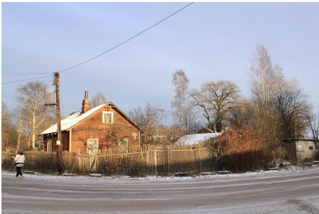
Фото 33. Территория объекта культурного наследия регионального значения «Железнодорожная станция Левашово». Общий вид территории. Дата: 28.11.2022 г.
