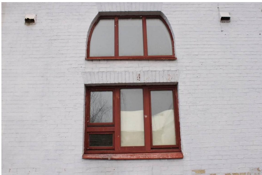
Фото 19. Объект культурного наследия регионального значения «Железнодорожная станция Левашово: вокзал» по адресу: г. Санкт-Петербург, п. Левашово, Железнодорожная ул., д. 7, лит. А (Левашово, железнодорожная станция. Вокзальное шоссе, 43). Вид на исторические окна, являющимися предметом охраны (западный фасад) Дата: 28.11.2022 г.
