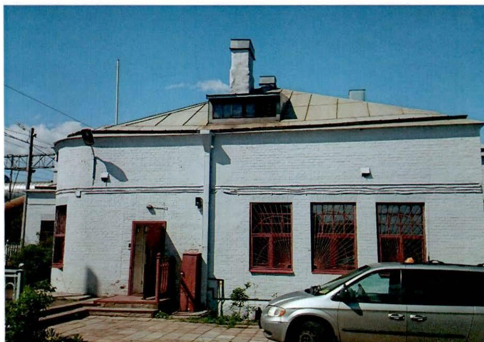
4. Здание вокзала (восточный фасад).
