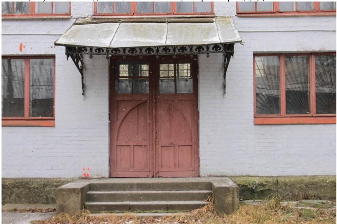
Фото 12. Объект культурного наследия регионального значения «Железнодорожная станция Левашово: вокзал» по адресу: г. Санкт-Петербург, п. Левашово, Железнодорожная ул., д. 7, лит. А (Левашово, железнодорожная станция. Вокзальное шоссе, 43). Вид на исторический козырек и деревянную дверь, являющимися предметом охраны (северный фасад). Дата: 28.11.2022 г.
