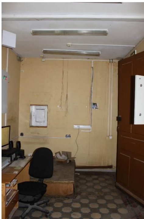
Фото 33. Объект культурного наследия регионального значения «Железнодорожная станция Левашово: вокзал» по адресу: г. Санкт-Петербург, п. Левашово, Железнодорожная ул., д. 7, лит. А (Левашово, железнодорожная станция. Вокзальное шоссе, 43). Общий вид на помещение №2 и сохранившийся керамический пол, являющийся предметом охраны. Дата: 28.11.2022 г.
