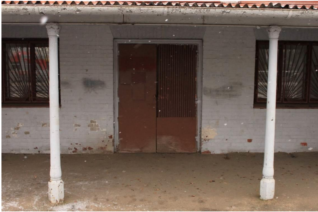
Фото 5. Объект культурного наследия регионального значения «Железнодорожная станция Левашово: вокзал» по адресу: г. Санкт-Петербург, п. Левашово, Железнодорожная ул., д. 7, лит. А (Левашово, железнодорожная станция. Вокзальное шоссе, 43). Вид на опорные столбы козырька главного входа, являющимися предметом охраны (южный фасад). Дата: 28.11.2022 г.
