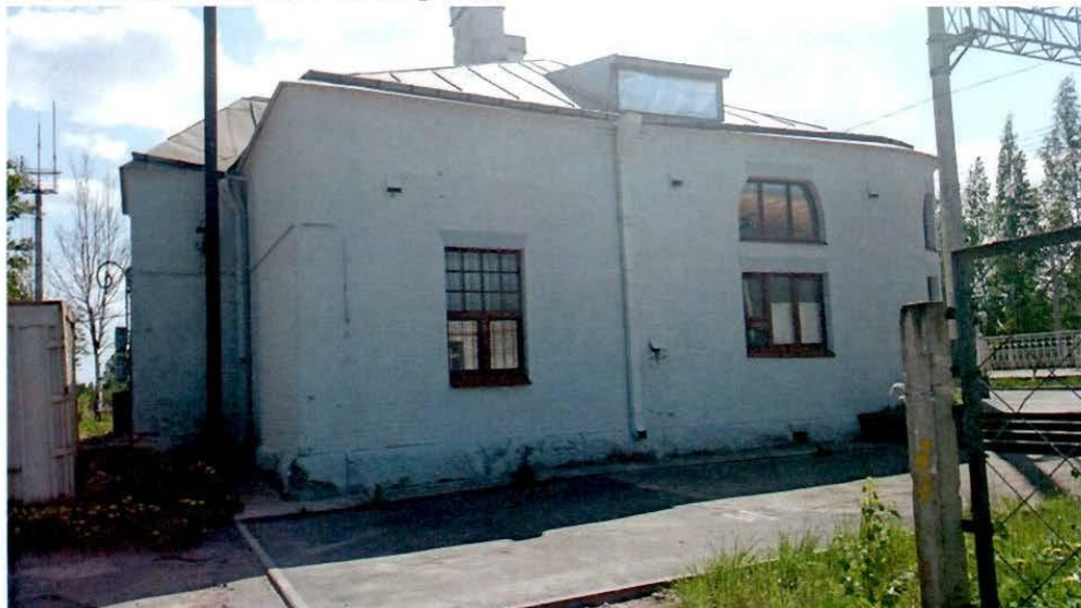
3. Здание вокзала (западный фасад).
