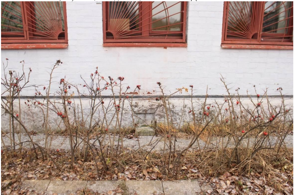
Фото 8. Объект культурного наследия регионального значения «Железнодорожная станция Левашово: вокзал» по адресу: г. Санкт-Петербург, п. Левашово, Железнодорожная ул., д. 7, лит. А (Левашово, железнодорожная станция. Вокзальное шоссе, 43). Вид на заложное вентиляционное окно в уровне цоколя (восточный фасад). Дата: 28.11.2022 г.
