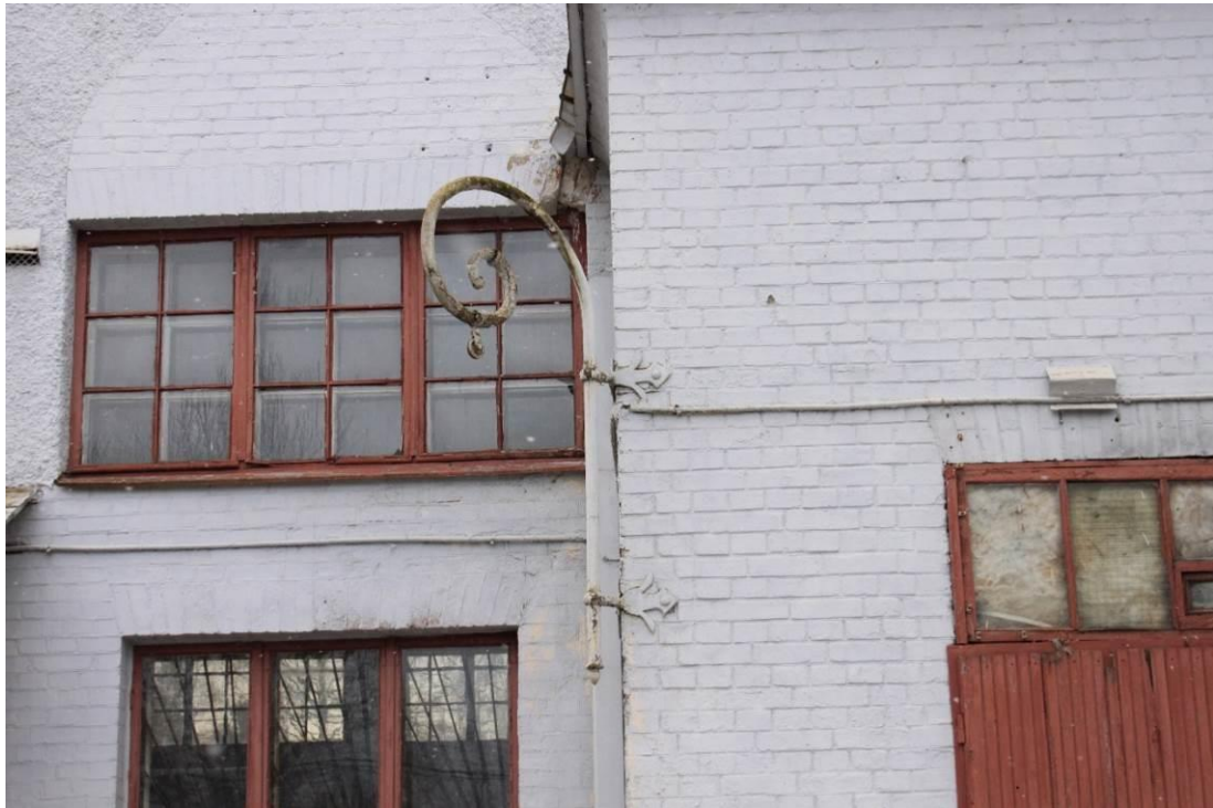
Фото 13. Объект культурного наследия регионального значения «Железнодорожная станция Левашово: вокзал» по адресу: г. Санкт-Петербург, п. Левашово, Железнодорожная ул., д. 7, лит. А (Левашово, железнодорожная станция. Вокзальное шоссе, 43). Вид на металлический кованый кронштейн, являющийся предметом охраны (северный фасад). Дата: 28.11.2022 г.
