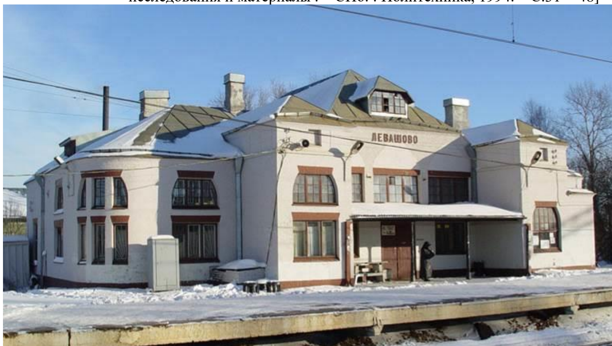
40. Финляндская железная дорога. Вокзал станции Левашово. Вид со стороны путей. Фото 2000-х гг.
