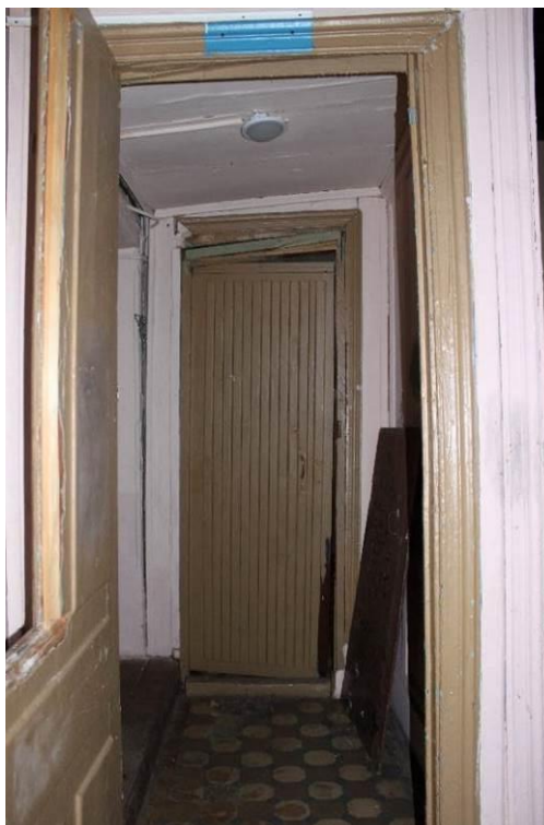
Фото 27. Объект культурного наследия регионального значения «Железнодорожная станция Левашово: вокзал» по адресу: г. Санкт-Петербург, п. Левашово, Железнодорожная ул., д. 7, лит. А (Левашово, железнодорожная станция. Вокзальное шоссе, 43). Общий вид помещения №1. Деревянный тамбур, являющийся предметом охраны. Дата: 28.11.2022г.
