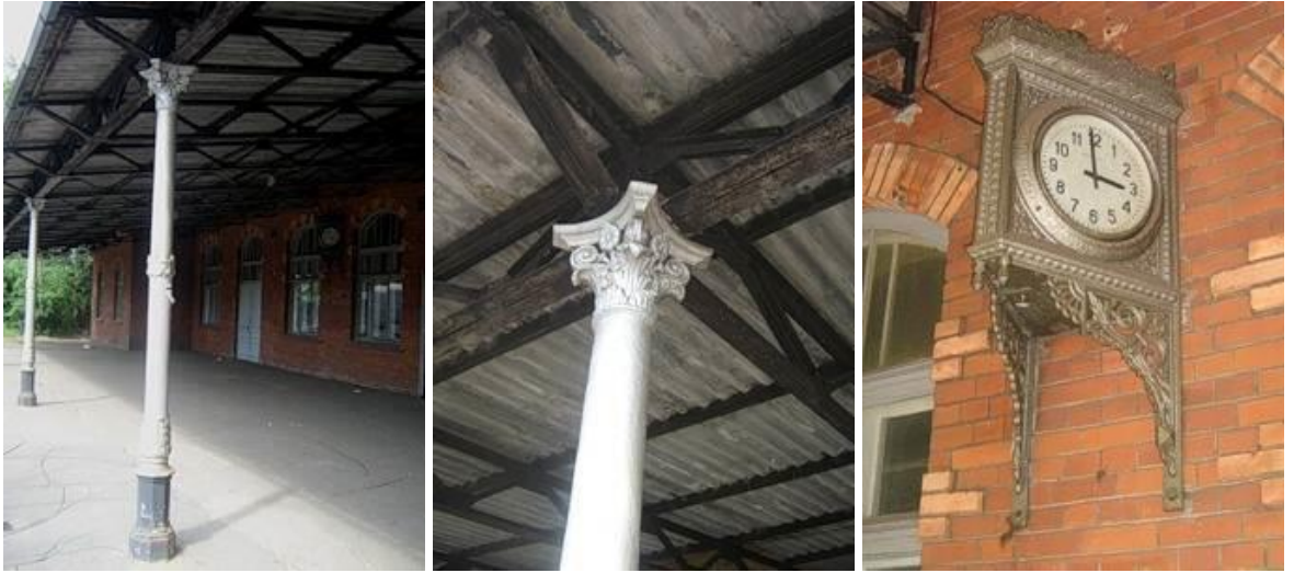
26. Финляндская железная дорога. Вокзал станции Шувалово. Фрагменты фасада. Фото 2000-х гг.
