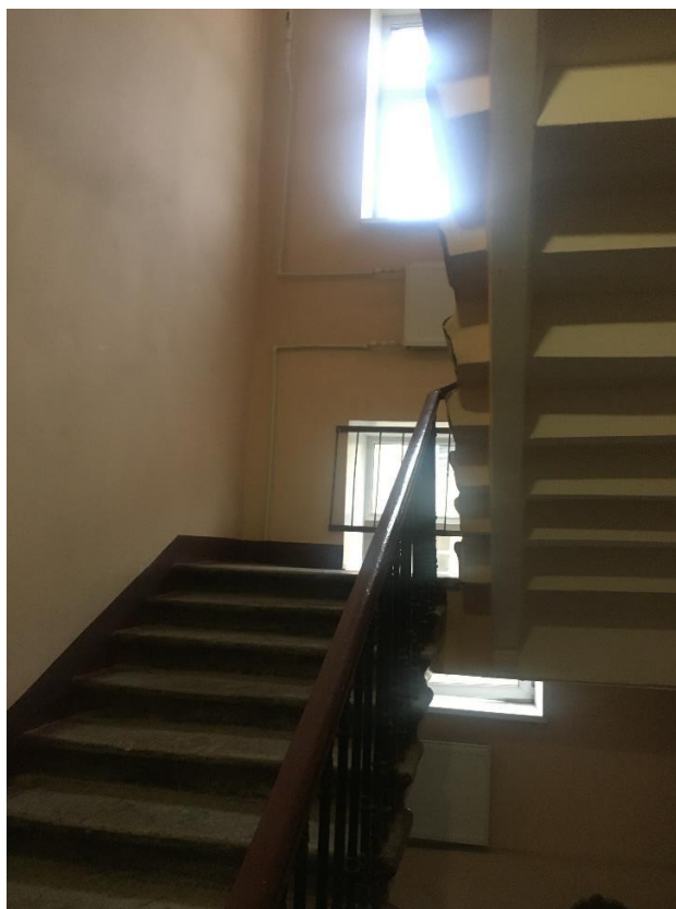
28. Фотофиксация 5-го этажа здания Невский пр., д.82, литера А. Лестничная клетка ЛК-2.
