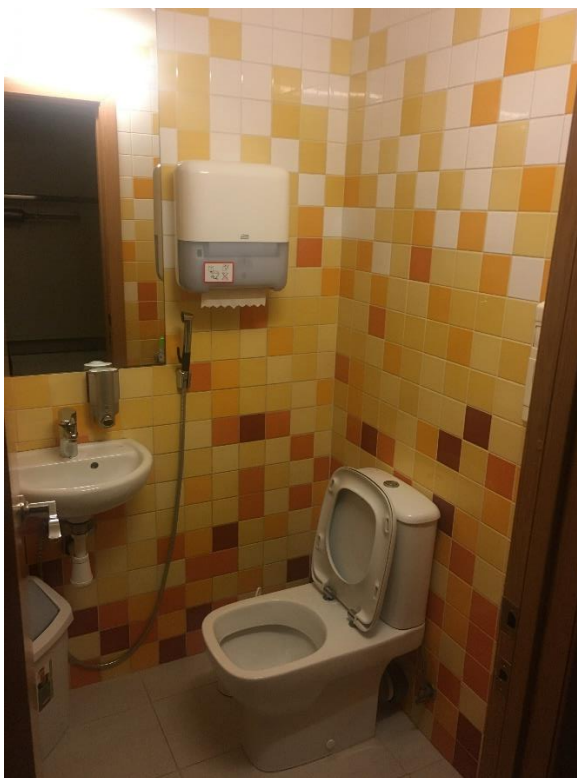
17. Фотофиксация 4-го этажа здания Невский пр., д.82, литера А. Квартира № 48. Санузел.
