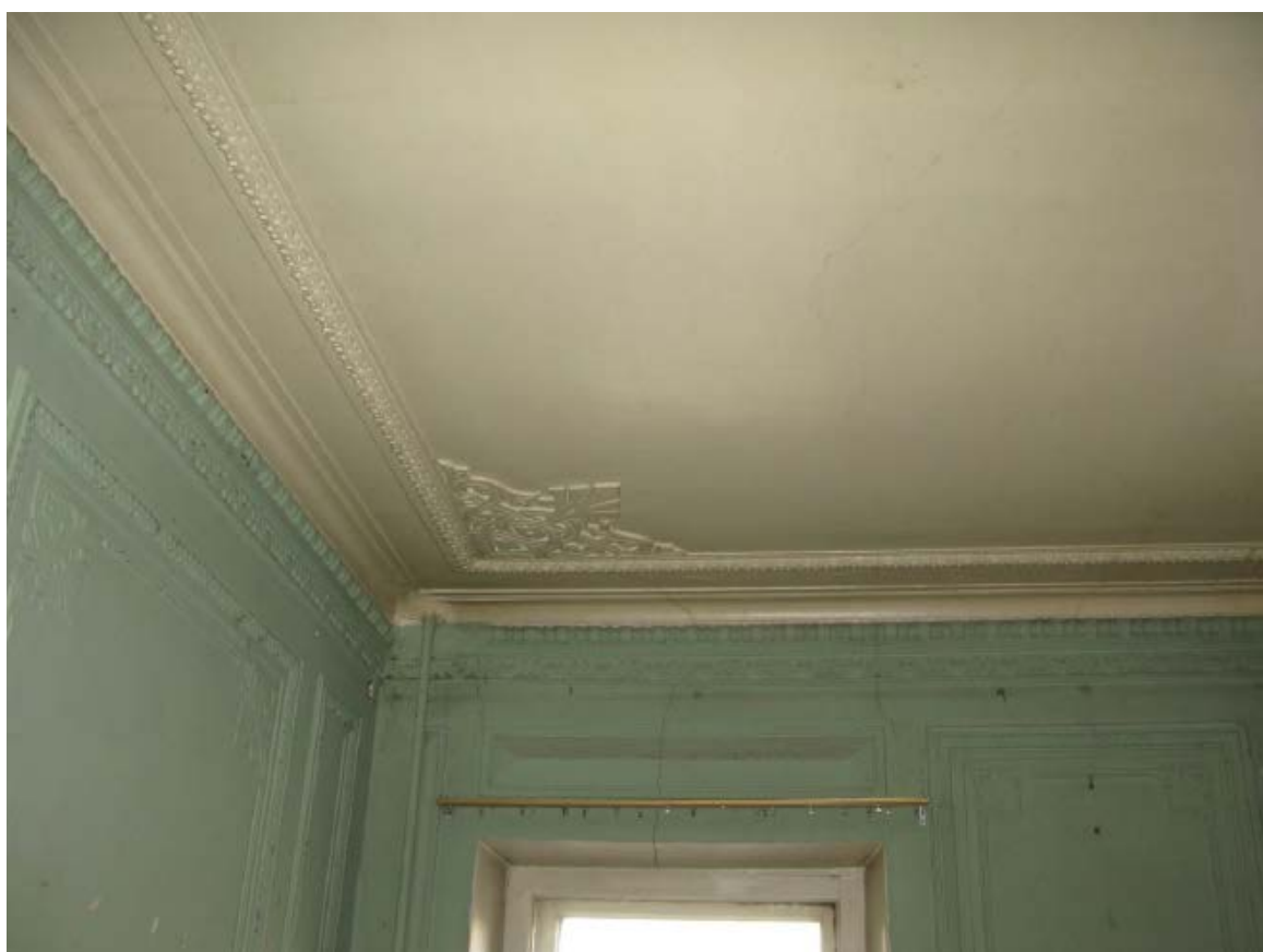
9. Помещение № 10 квартиры №14 в уровне 4-го этажа объекта культурного наследия федерального значения «Дом, где в 1887-1891 гг. жил композитор Рубинштейн А.Г. Здесь в 1905-1906 гг. проходили заседания ЦК РСДРП», расположенного по адресу: г. Санкт-Петербург, Загородный пр., д. 9, литера А. 09.09.2022
