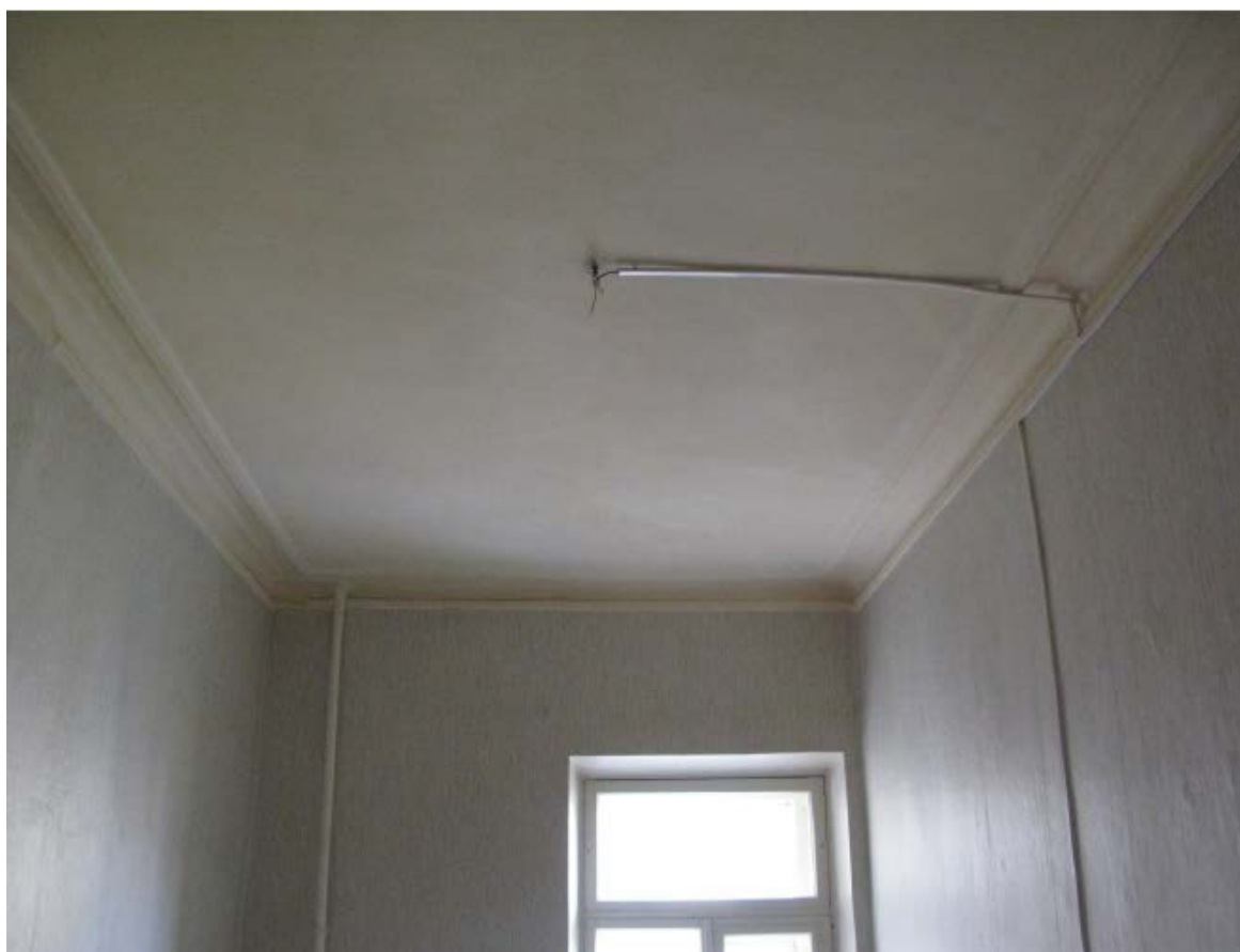
14. Помещение № 13 квартиры №14 в уровне 4-го этажа объекта культурного наследия федерального значения «Дом, где в 1887-1891 гг. жил композитор Рубинштейн А.Г. Здесь в 1905-1906 гг. проходили заседания ЦК РСДРП», расположенного по адресу: г. Санкт-Петербург, Загородный пр., д. 9, литера А. 09.09.2022
