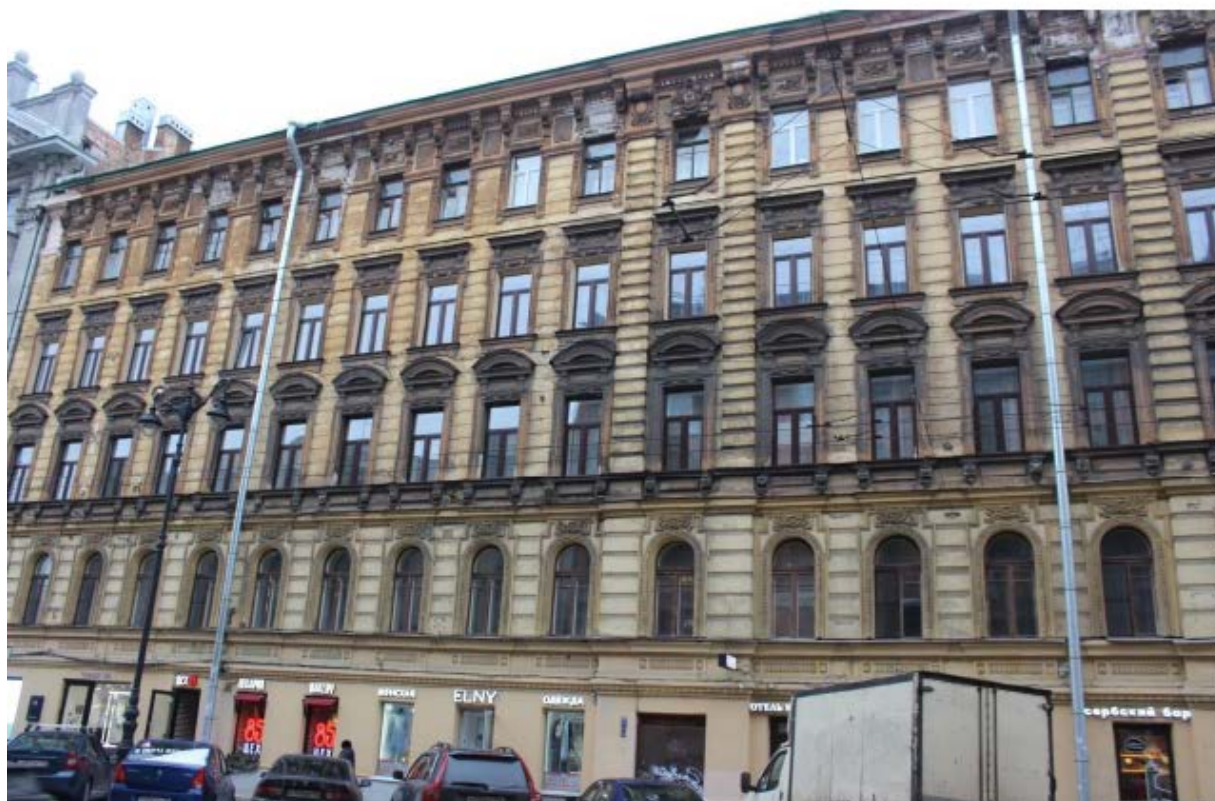
1. Юго-восточный лицевой фасад объекта культурного наследия федерального значения «Дом, где в 1887-1891 гг. жил композитор Рубинштейн А.Г. Здесь в 1905-1906 гг. проходили заседания ЦК РСДРП», расположенного по адресу: г. Санкт-Петербург, Загородный пр., д. 9, литера А. 09.09.2022
