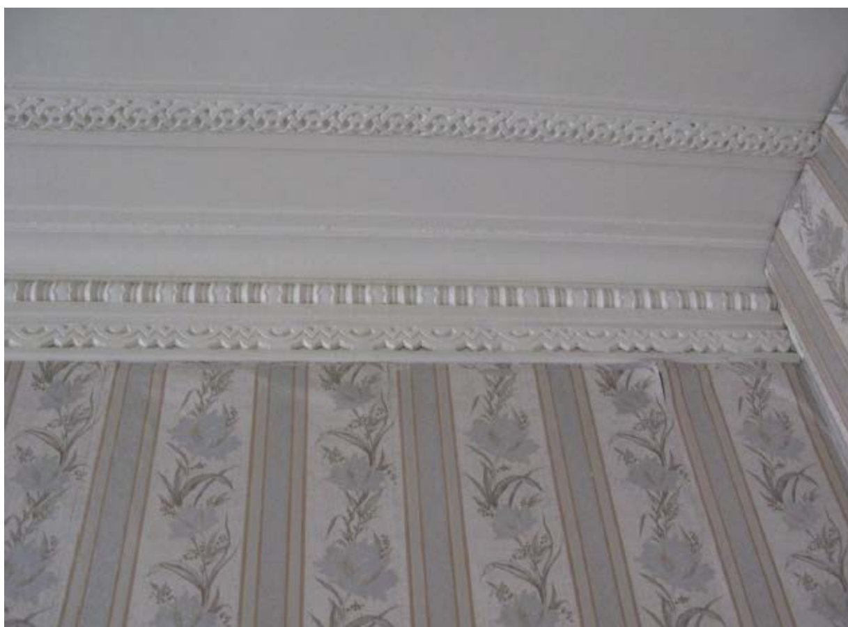
22. Помещение № 15 квартиры №13 в уровне 4-го этажа объекта культурного наследия федерального значения «Дом, где в 1887-1891 гг. жил композитор Рубинштейн А.Г. Здесь в 1905-1906 гг. проходили заседания ЦК РСДРП», расположенного по адресу: г. Санкт-Петербург, Загородный пр., д. 9, литера А. 09.09.2022
