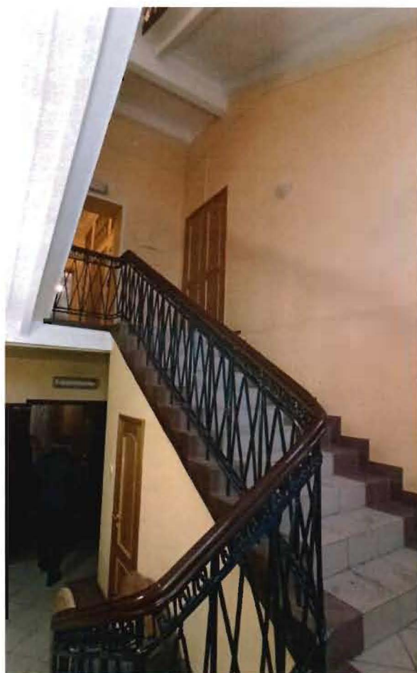
4. Лестница в западной части объекта культурного наследия (г. Санкт-Петербург наб. реки Мойки, дом 120, литера А).
