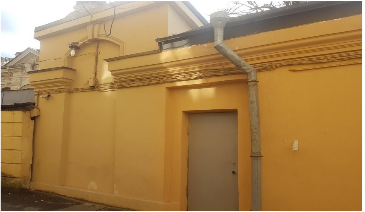
Фото 19. Служебный флигель. Вид со двора.
