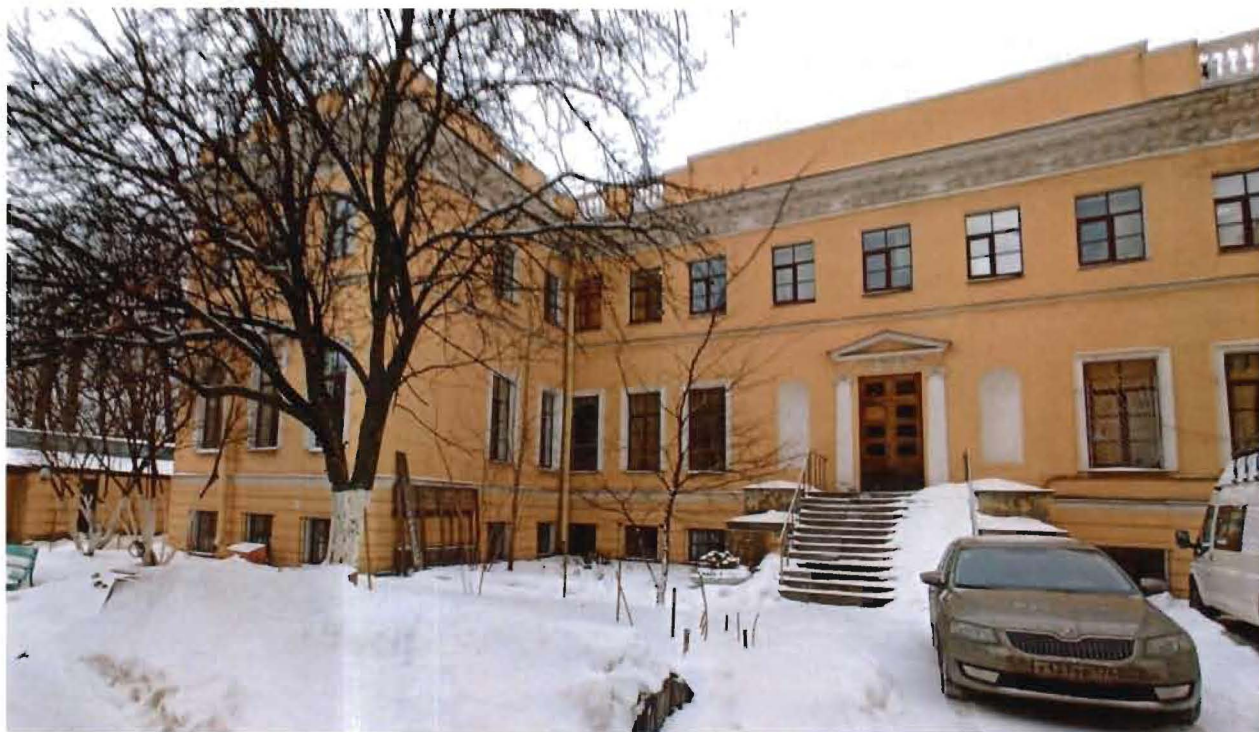
2. Вид с юго-восточной стороны на часть объекта культурного наследия (г. Санкт-Петербург, набережная реки Мойки, дом 120, литера А).
