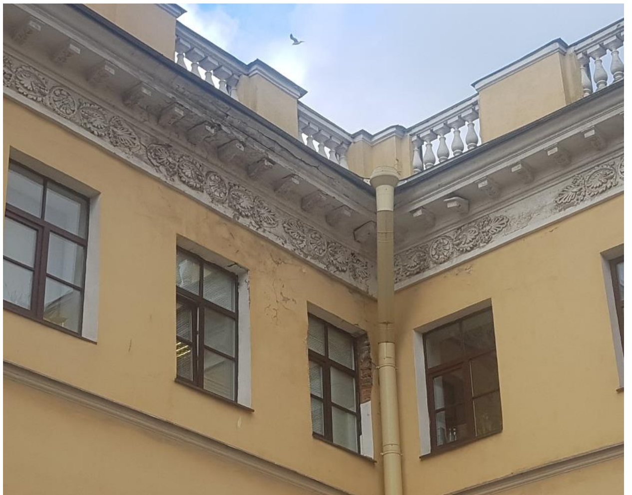
Фото 11. Южный фасад. Профилированный венчающий карниз.
