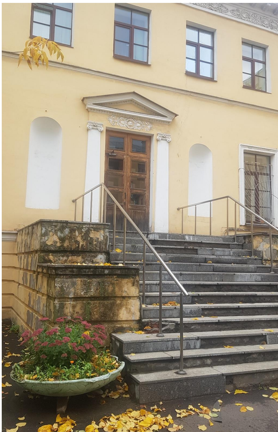
Фото 12. Южный фасад. Лестница.
