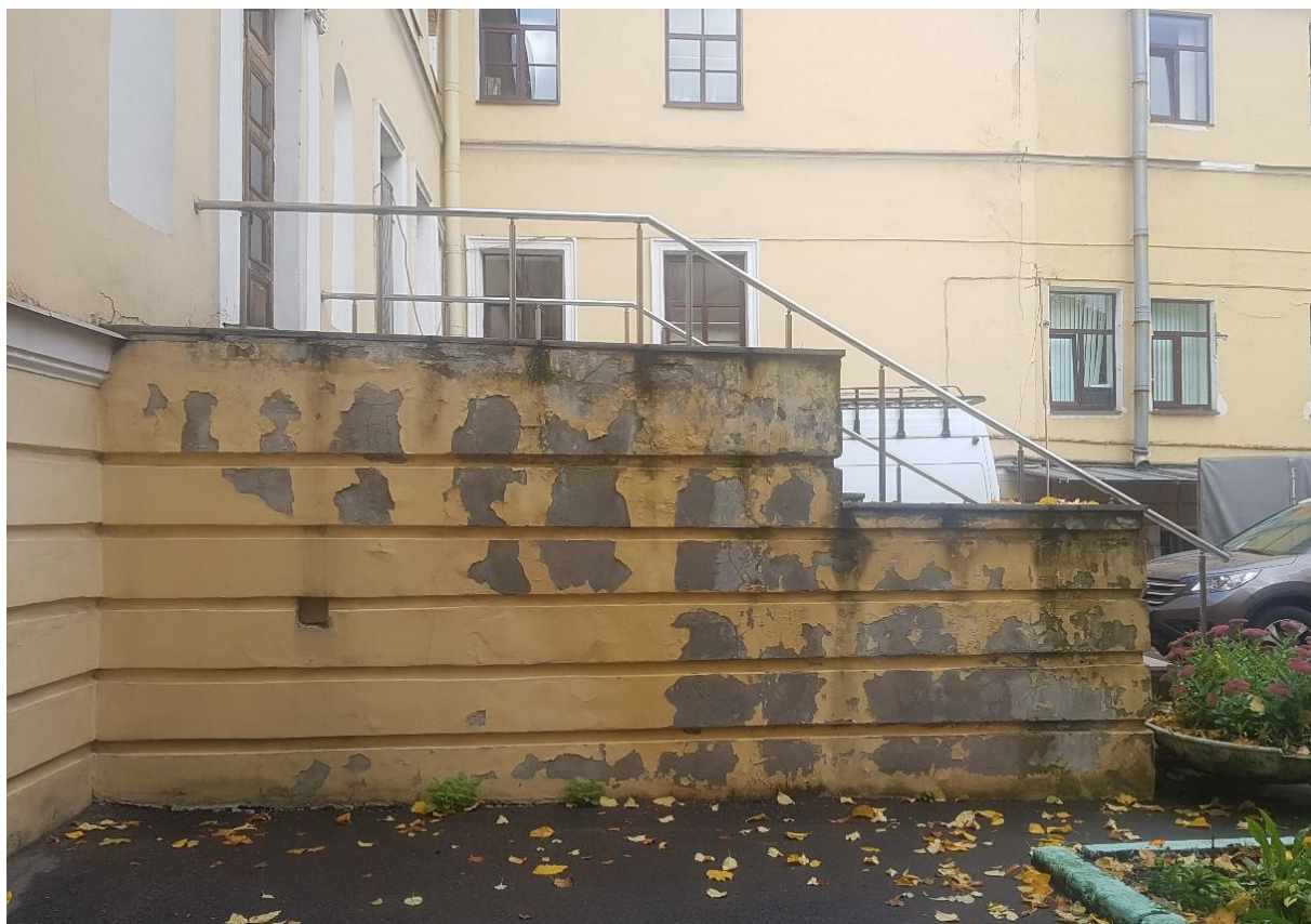
Фото 13. Южный фасад. Лестница.
