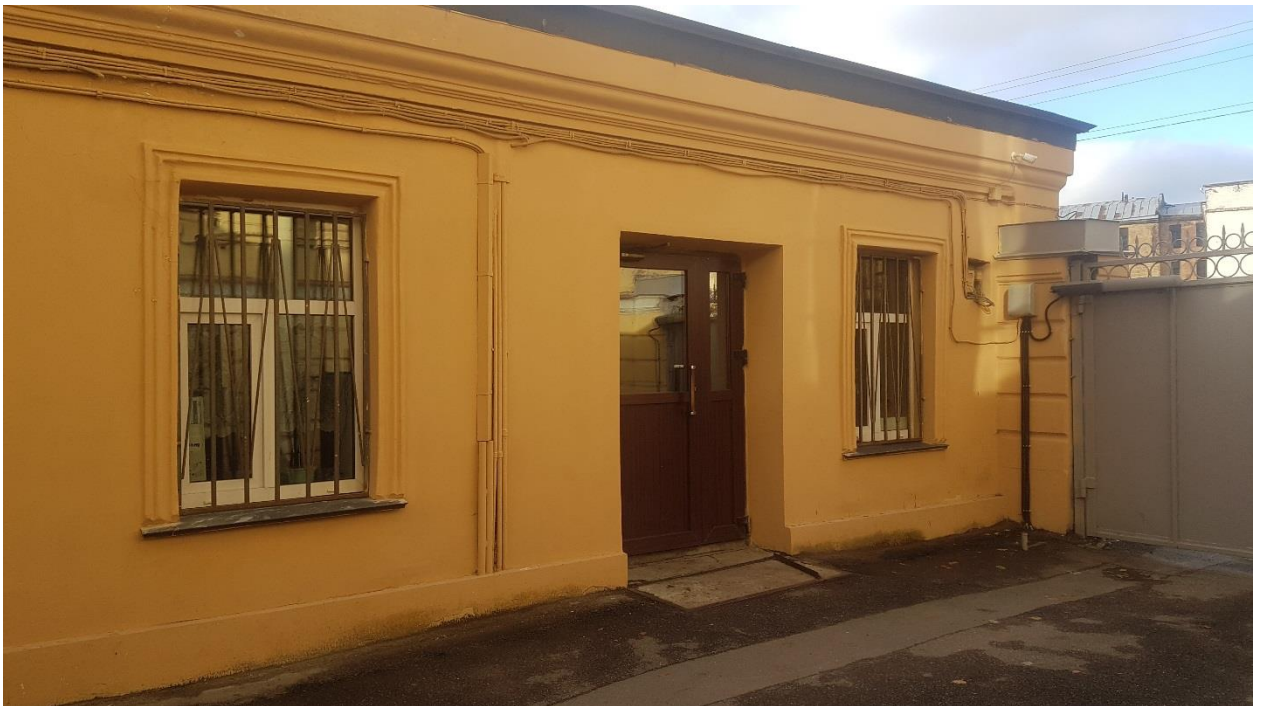
Фото 20. Служебный флигель. Вид со двора.
