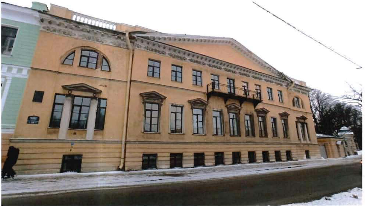
1. Вид на объект культурного наследия с северо-восточной стороны.
