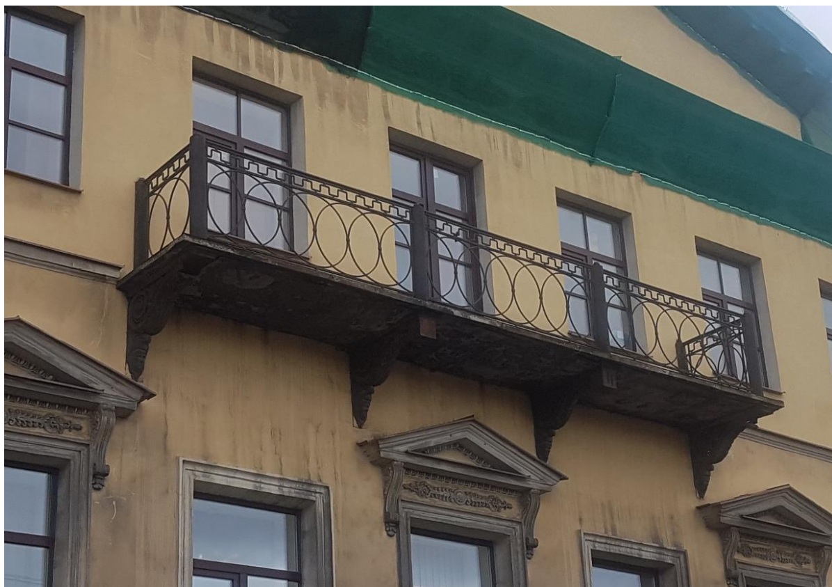
Фото 5. Лицевой фасад. Балкон на чугунных кронштейнах.
