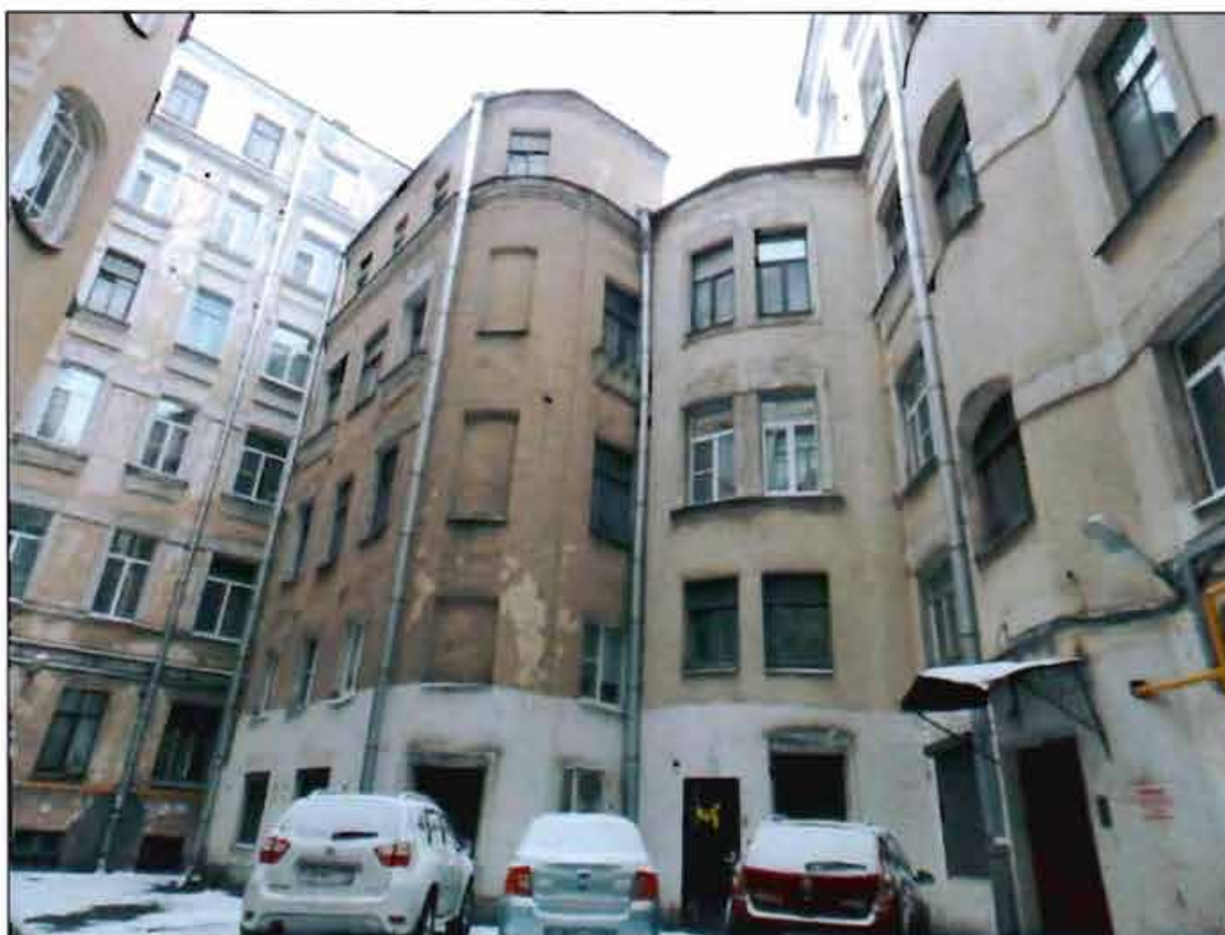
Фото 14. Фрагмент дворового фасада. Северный двор. Западный фасад
