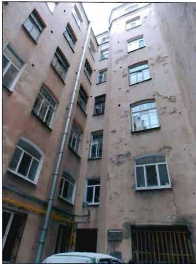
Фото 21. Фрагмент дворового фасада. Южный двор. Западный фасад.
