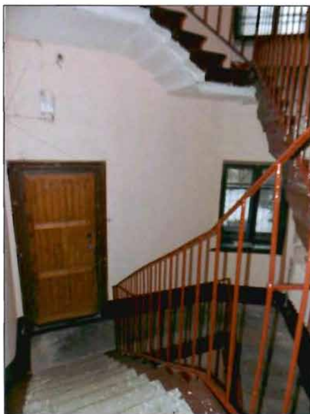
Фото 40. Интерьер. Лестница 4-ЛК.
