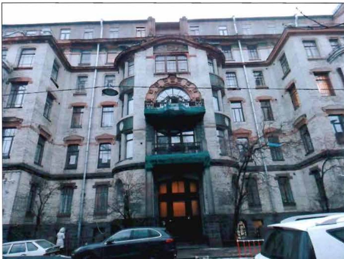
Фото 2. Фрагмент западного фасада.
