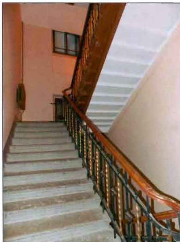
Фото 36. Интерьер. Лестница 2-ЛК.
