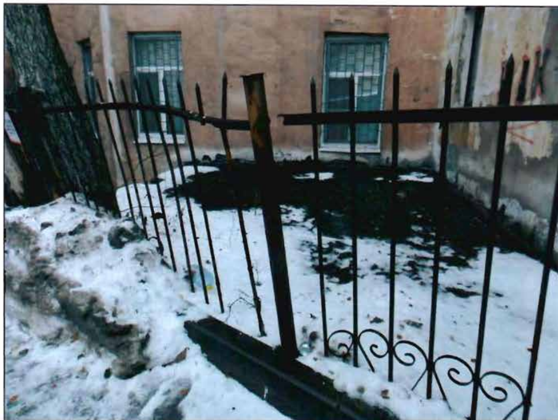
Фото 23. Восточный двор. Ограда.
