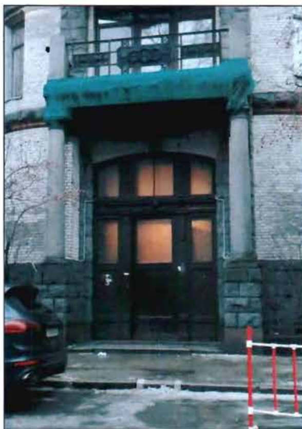
Фото 5. Фрагмент западного фасада. Вход (парадная лестница).
