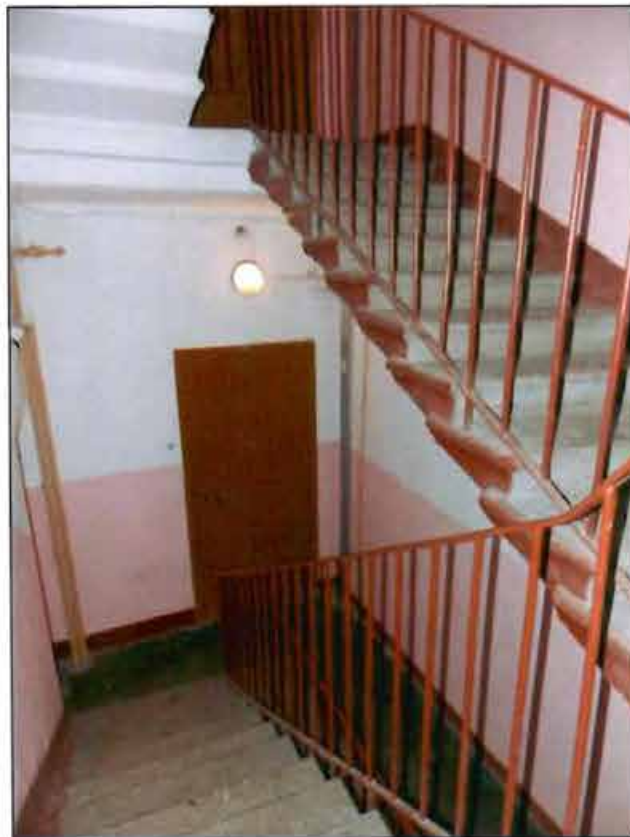
Фото 43. Интерьер. Лестница 6-ЛК.
