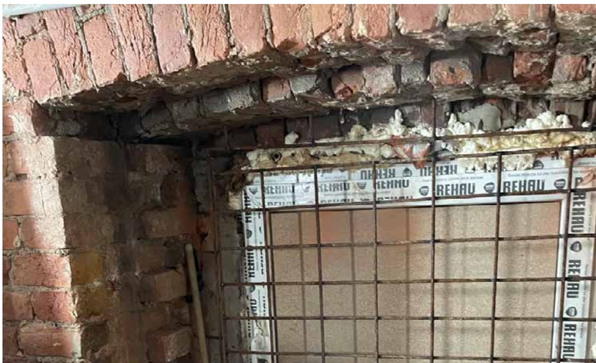
Фото 7 – Фрагмент окна 1050x1210мм. Кирпичная перемычка.
