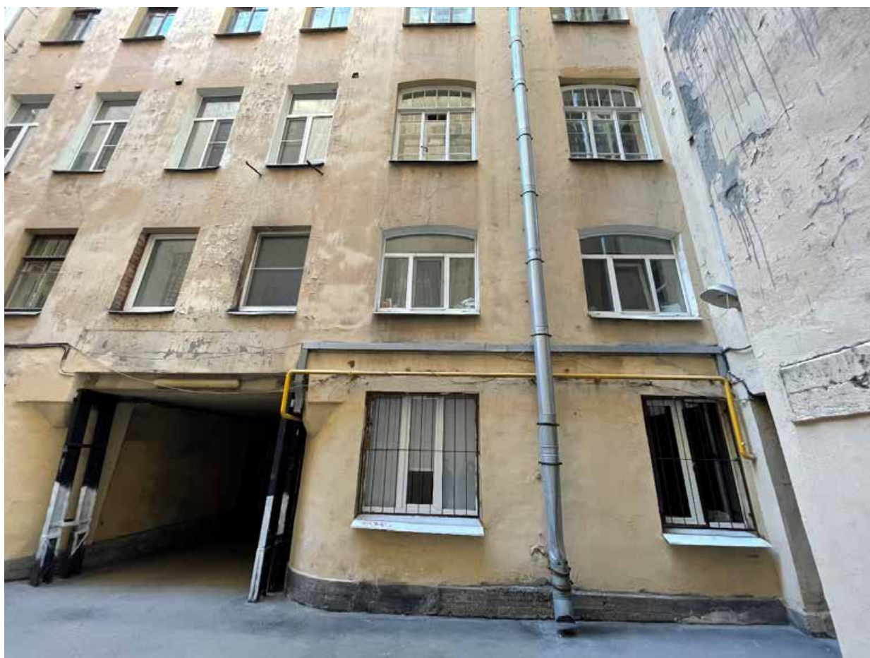
Фото 5 – Фрагмент фасада с окнами 1580x1750мм и 1120x1750мм
