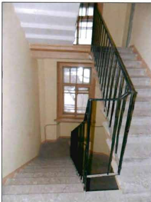
Фото 39. Интерьер. Лестница 3-ЛК.
