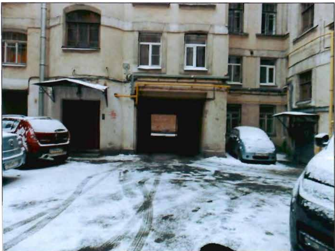
Фото 17. Фрагмент дворового фасада. Северный двор. Северный фасад. Воротный проезд между дворами.
