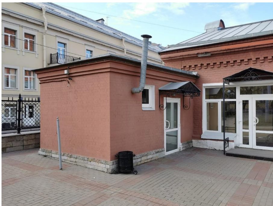
37. "Служебное здание" в составе ансамбля "Комплекс главной станции Санкт-Петербургских городских водопроводов", ул. Шпалерная, д. 56, лит. Р. Южный фасад. Фрагмент. Фото 08.08.2022г.
