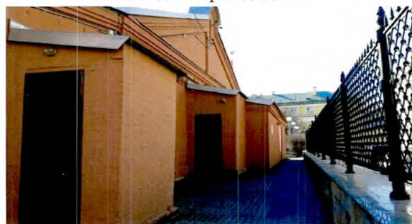
3. Западный фасад здания
