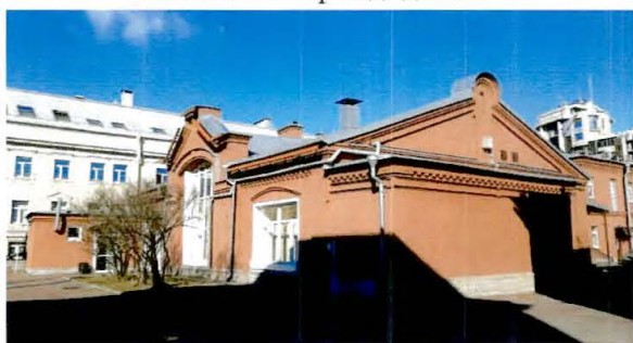
2. Восточный фасад здания
