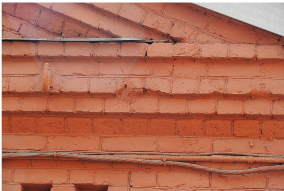
9. "Служебное здание" в составе ансамбля "Комплекс главной станции Санкт-Петербургских городских водопроводов", ул. Шпалерная, д. 56, лит. Р. Северный фасад. Фрагмент. Фото 08.08.2022г.
