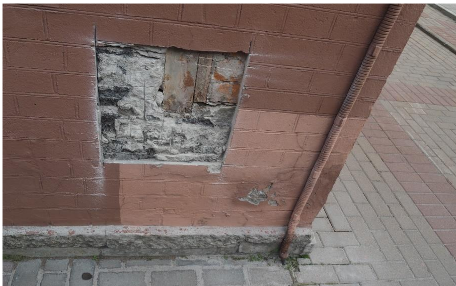
36. "Служебное здание" в составе ансамбля "Комплекс главной станции Санкт-Петербургских городских водопроводов", ул. Шпалерная, д. 56, лит. Р. Западный фасад. Фрагмент. Фото 08.08.2022г.
