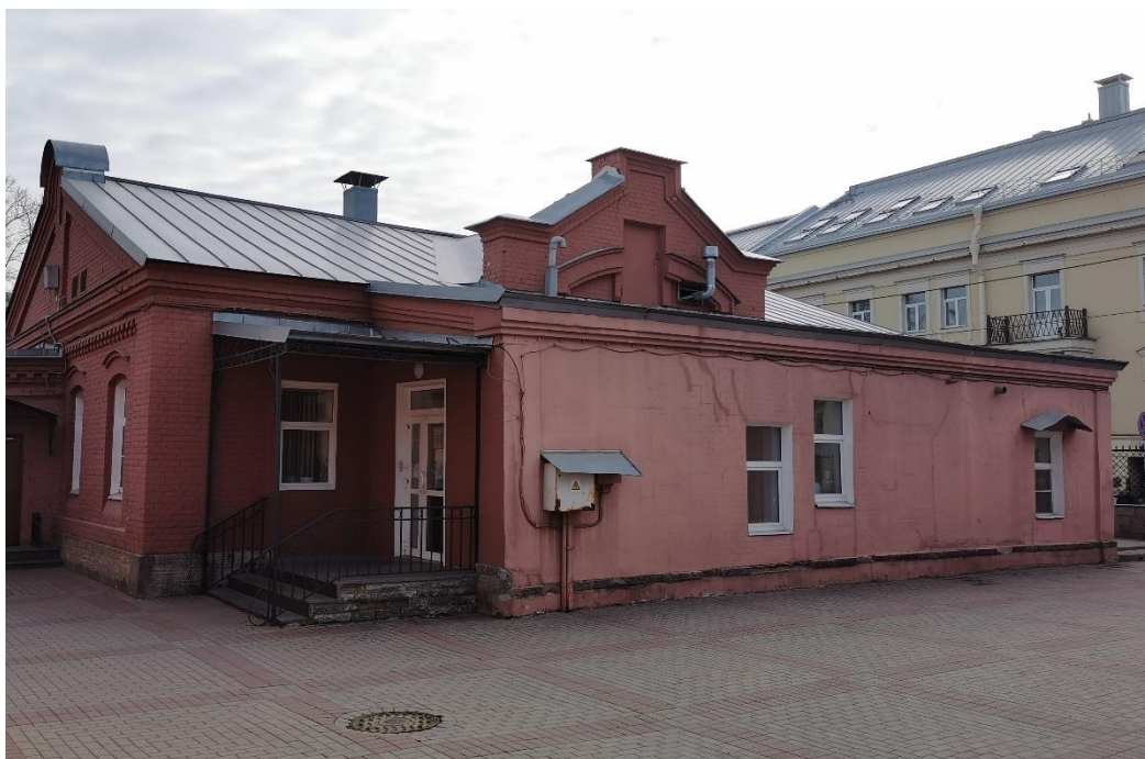
1. "Служебное здание" в составе ансамбля "Комплекс главной станции Санкт-Петербургских городских водопроводов", ул. Шпалерная, д. 56, лит. Р. Северный фасад. Общий вид. Фото 08.08.2022г.
