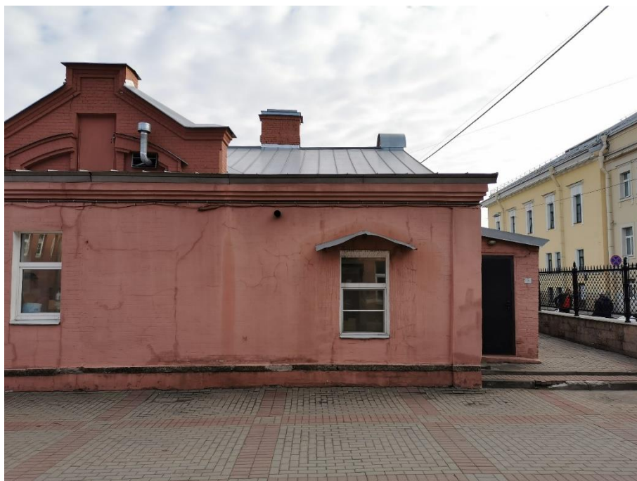
7. "Служебное здание" в составе ансамбля "Комплекс главной станции Санкт-Петербургских городских водопроводов", ул. Шпалерная, д. 56, лит. Р. Северный фасад. Фрагмент. Фото 08.08.2022г.
