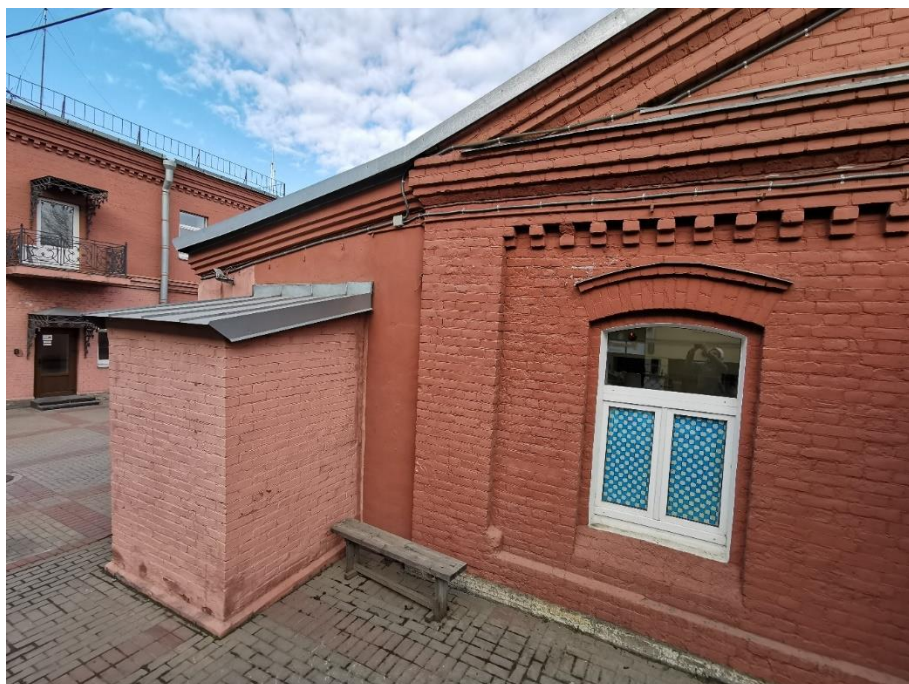
29. "Служебное здание" в составе ансамбля "Комплекс главной станции Санкт-Петербургских городских водопроводов", ул. Шпалерная, д. 56, лит. Р. Западный фасад. Фрагмент. Фото 08.08.2022г.
