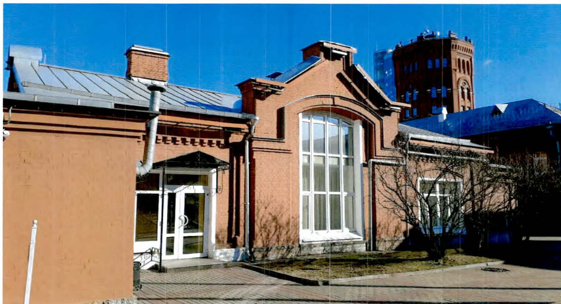
1. Южный фасад здания
