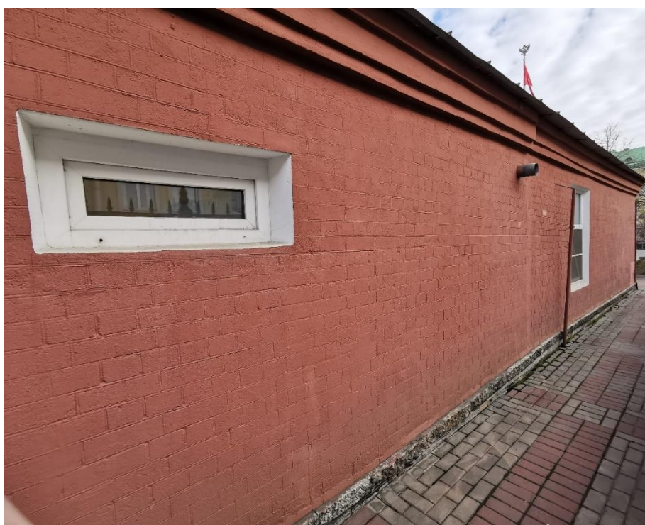
30. "Служебное здание" в составе ансамбля "Комплекс главной станции Санкт-Петербургских городских водопроводов", ул. Шпалерная, д. 56, лит. Р. Западный фасад. Фрагмент. Фото 08.08.2022г.
