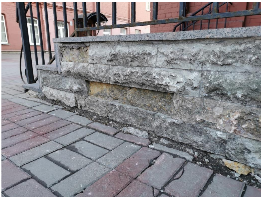
11. "Служебное здание" в составе ансамбля "Комплекс главной станции Санкт-Петербургских городских водопроводов", ул. Шпалерная, д. 56, лит. Р. Северный фасад. Фрагмент. Фото 08.08.2022г.
