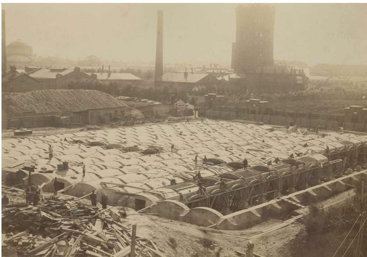
Илл. 6. Строительство фильтров. кон. 1880-х гг.
