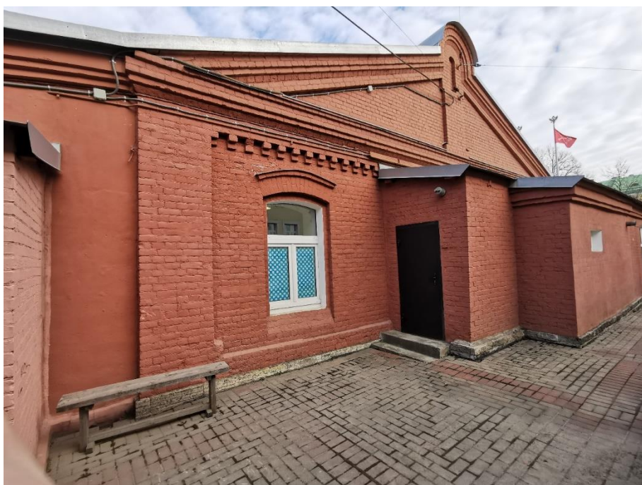
26. "Служебное здание" в составе ансамбля "Комплекс главной станции Санкт-Петербургских городских водопроводов", ул. Шпалерная, д. 56, лит. Р. Западный фасад. Фрагмент. Фото 08.08.2022г.
