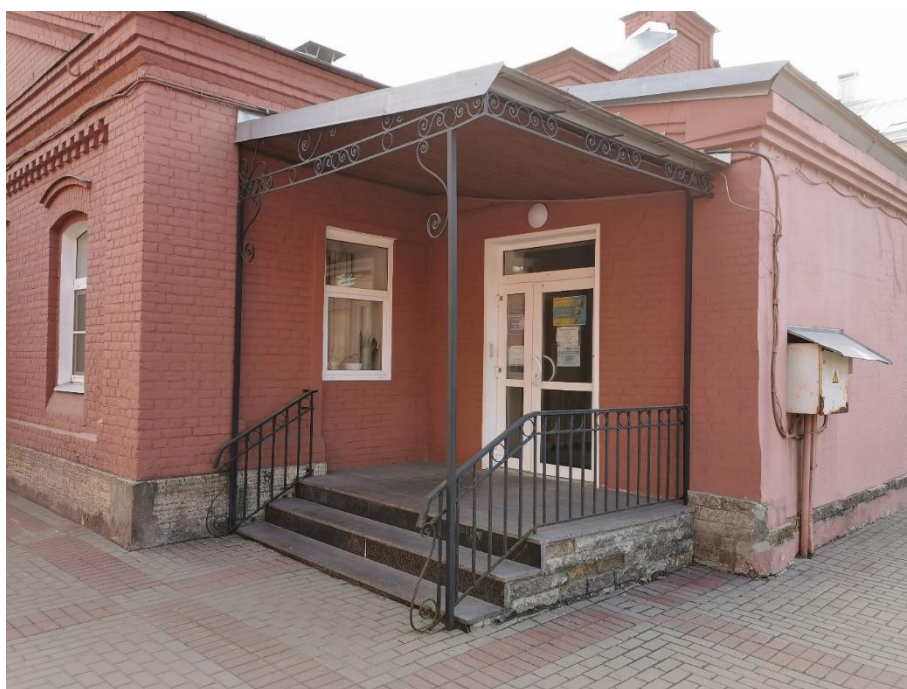
24. "Служебное здание" в составе ансамбля "Комплекс главной станции Санкт-Петербургских городских водопроводов", ул. Шпалерная, д. 56, лит. Р. Восточный фасад. Фрагмент. Фото 08.08.2022г.
