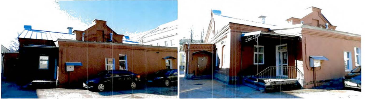
4,5. Северный фасад здания, металлические козырьки над крыльцами
