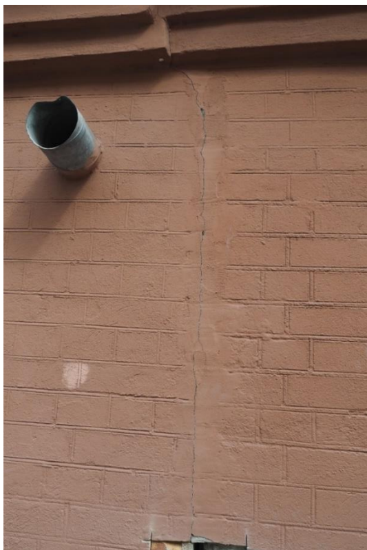
34. "Служебное здание" в составе ансамбля "Комплекс главной станции Санкт-Петербургских городских водопроводов", ул. Шпалерная, д. 56, лит. Р. Западный фасад. Фрагмент. Фото 08.08.2022г.
