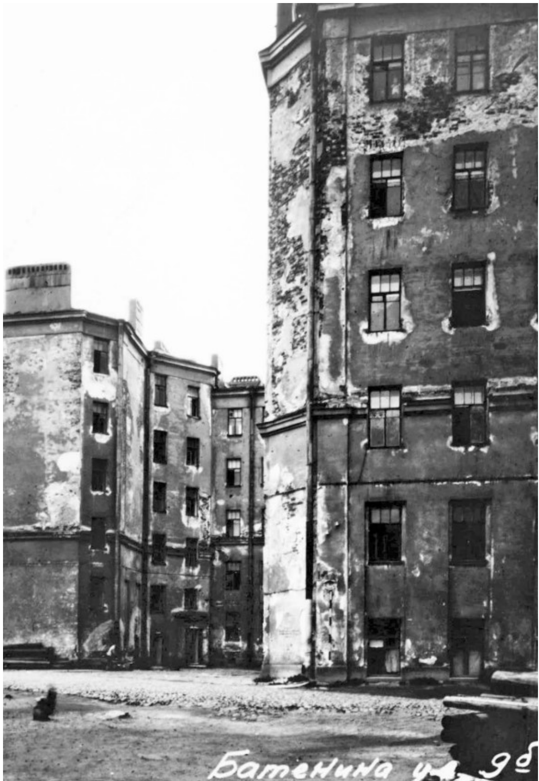
Илл. 19. Вид части д. 96 по Батенина ул. Фотография 1949 г. ЦГАКФФД. Гр 70516.
