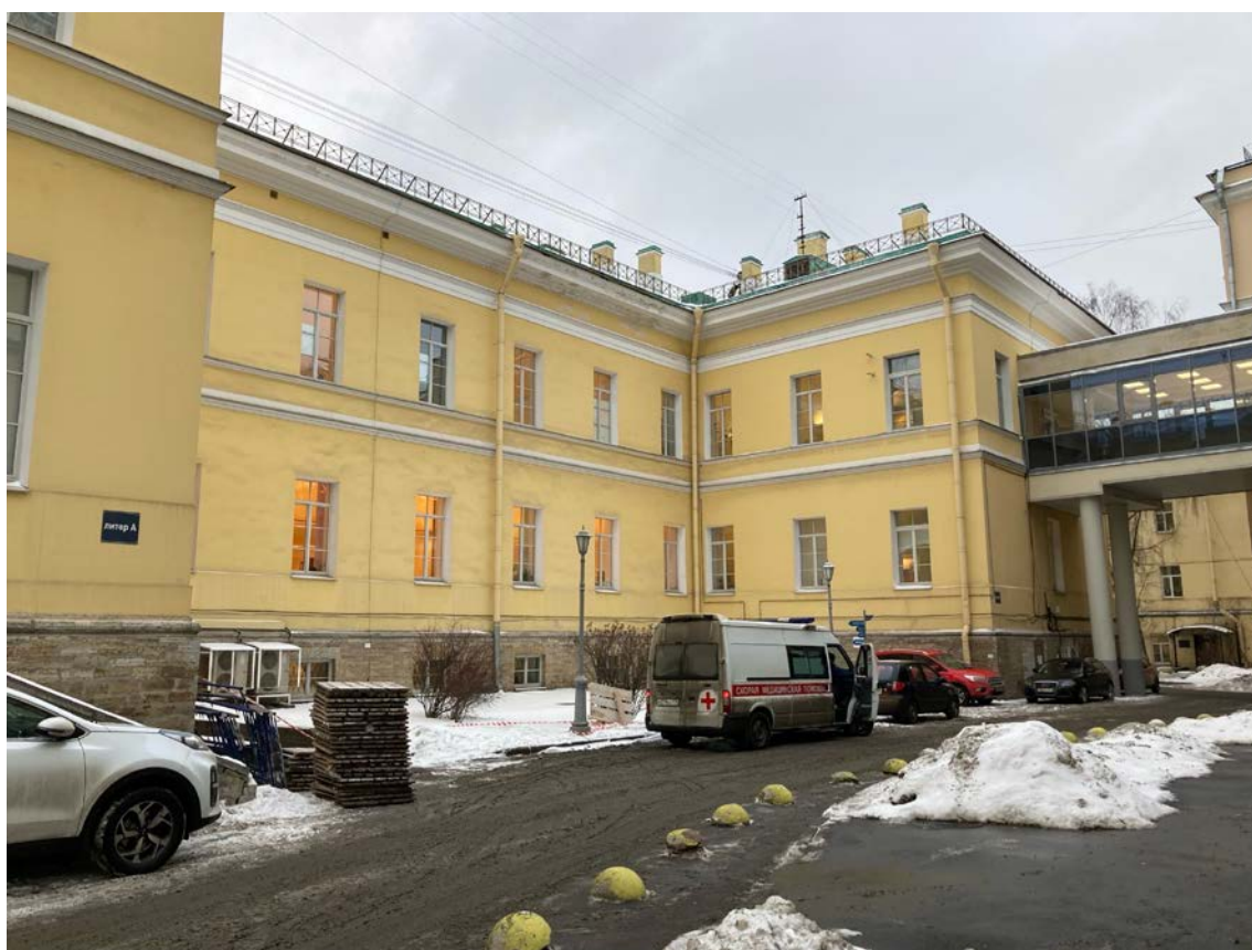
Фото 10. Фрагмент дворового фасада объекта культурного наследия федерального значения «Корпус главный», входящего в состав объекта культурного наследия федерального значения «Больница Мариинская»
