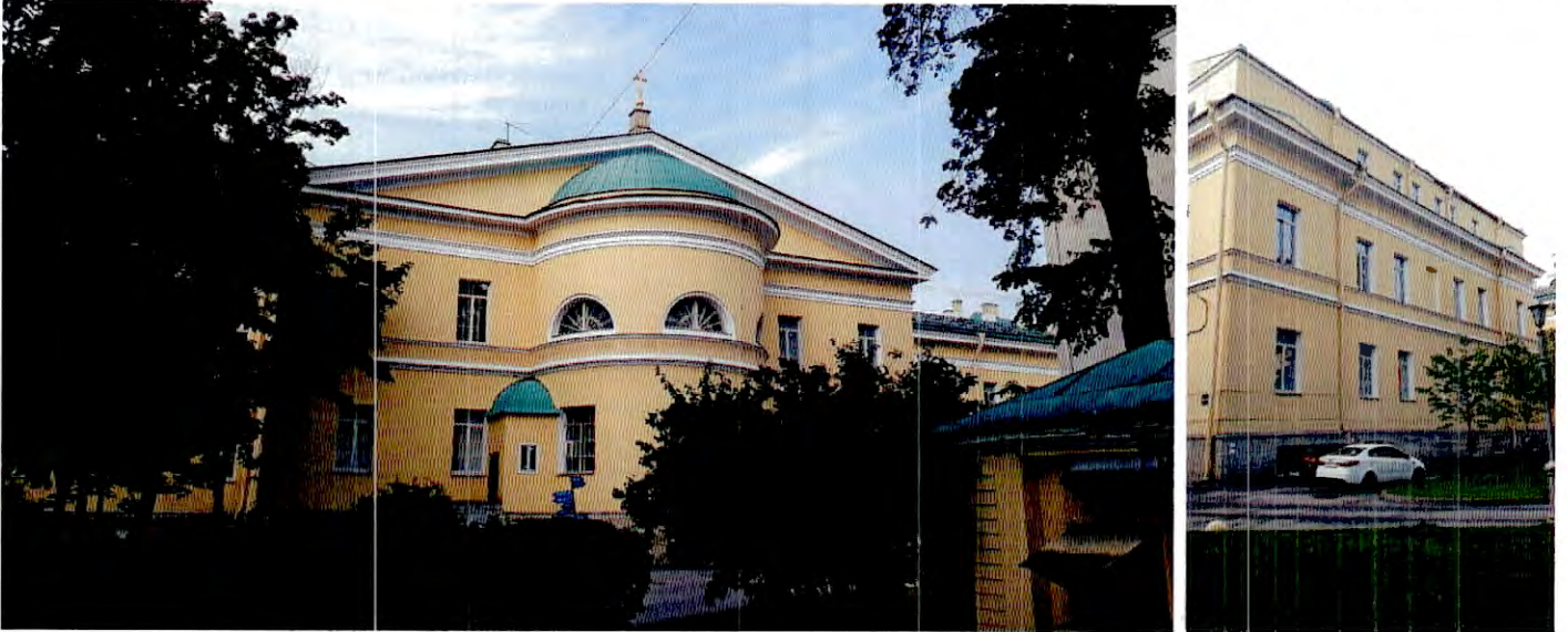
12. Центральная часть здания восточного фасада 13. Внутридворовая часть здания с южной стороны
