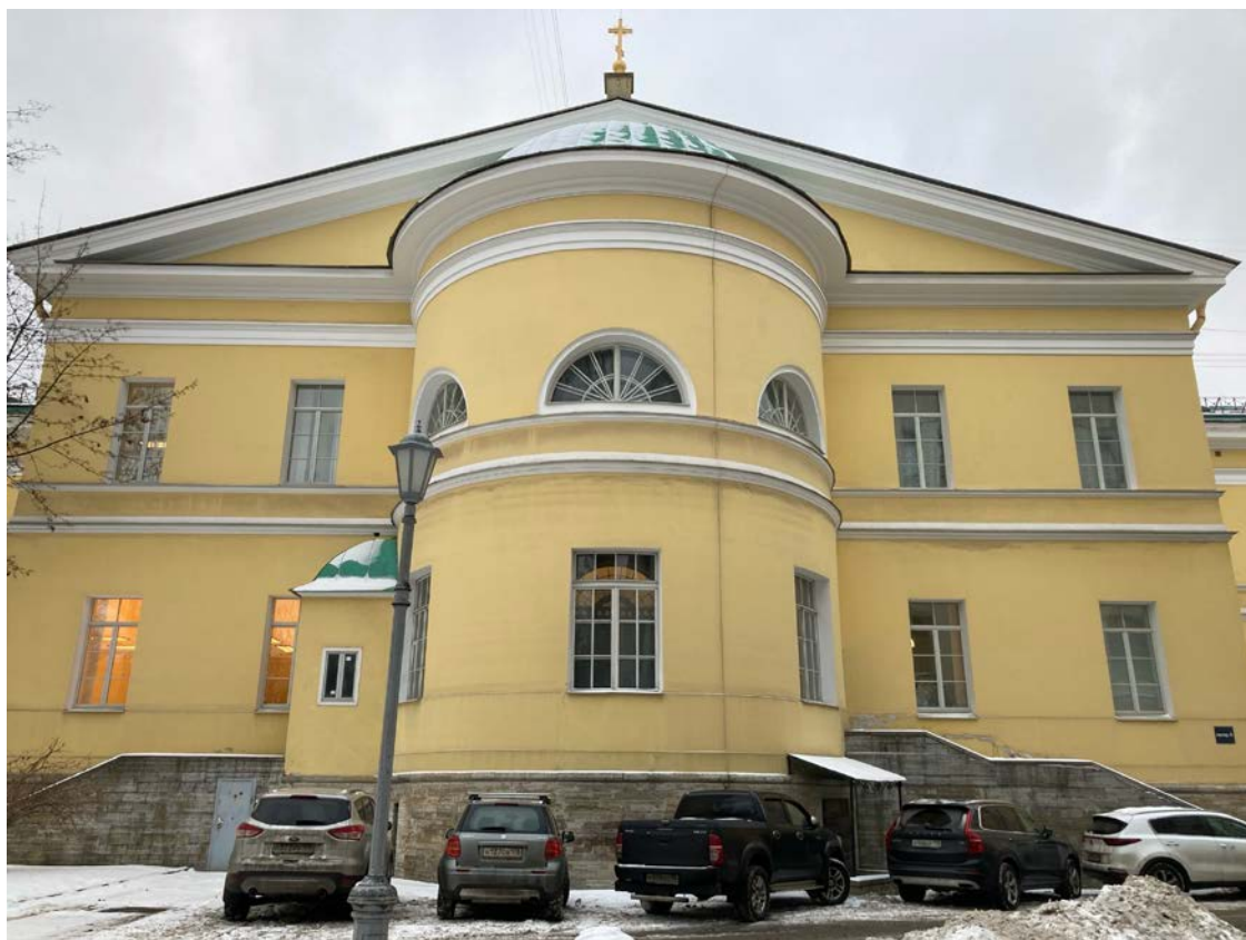
Фото 9. Фрагмент дворового фасада объекта культурного наследия федерального значения «Корпус главный», входящего в состав объекта культурного наследия федерального значения «Больница Мариинская»
