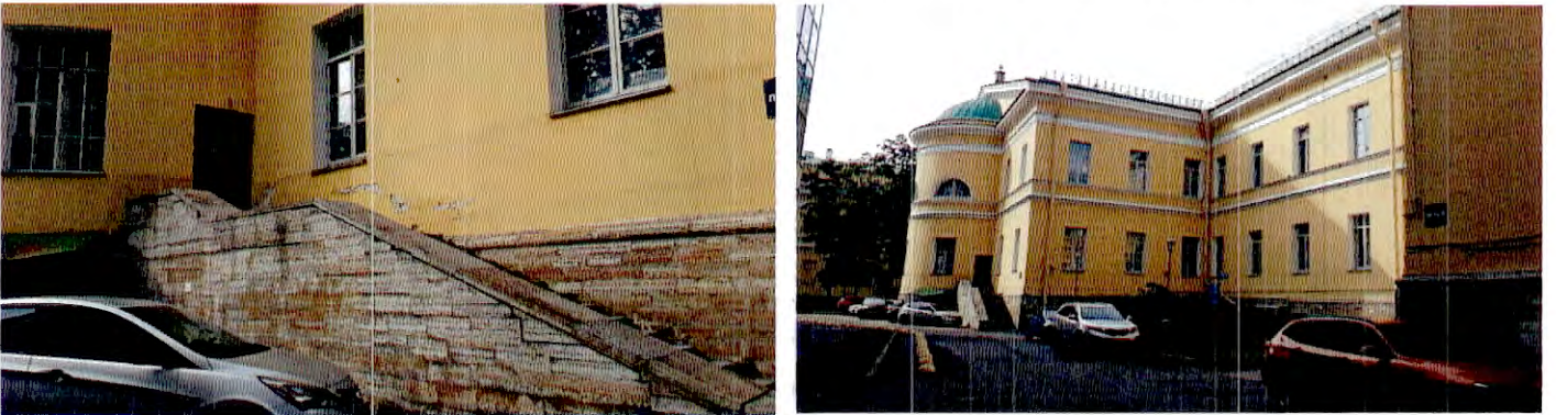
14. Лестничный подъем с восточной стороны здания 15. Вид с северо-восточной стороны
