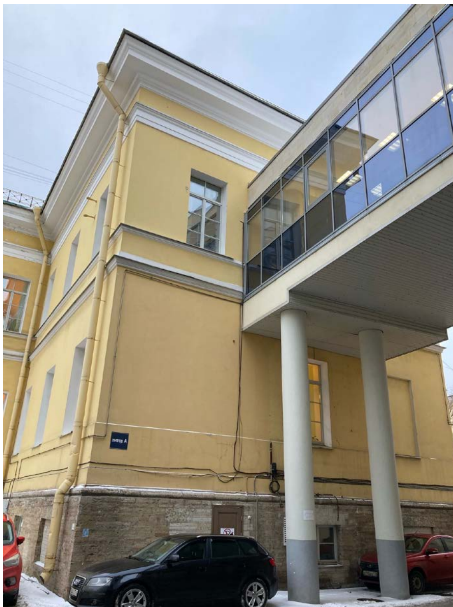
Фото 13. Фрагмент дворового фасада объекта культурного наследия федерального значения «Корпус главный», входящего в состав объекта культурного наследия федерального значения «Больница Мариинская»
