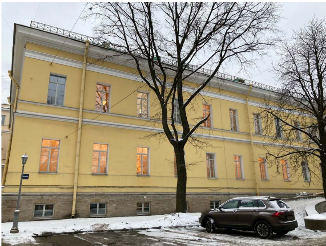
Фото 3. Фрагмент лицевого фасада объекта культурного наследия федерального значения «Корпус главный», входящего в состав объекта культурного наследия федерального значения «Больница Мариинская»
