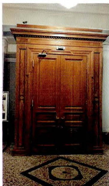
34. Дверь входного тамбура
