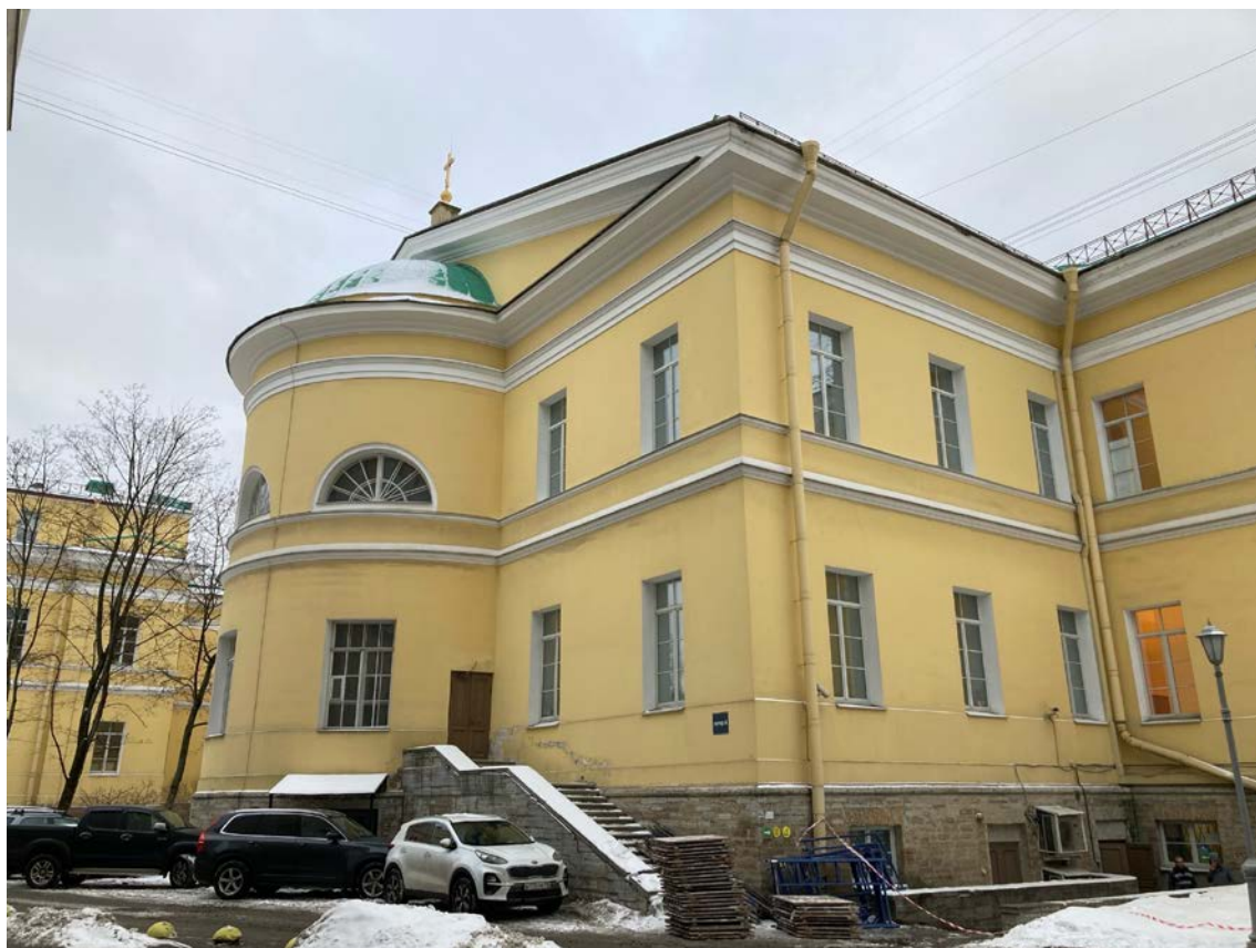
Фото 11. Фрагмент дворового фасада объекта культурного наследия федерального значения «Корпус главный», входящего в состав объекта культурного наследия федерального значения «Больница Мариинская»
