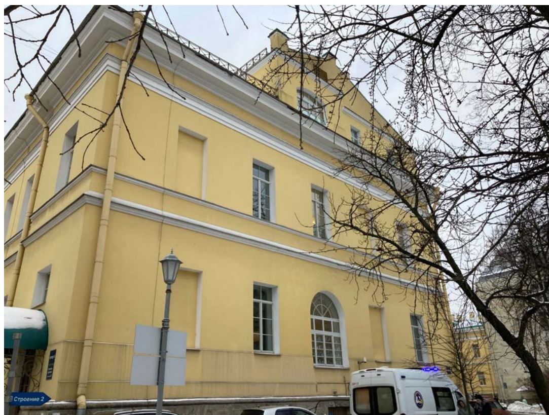
Фото 6. Фрагмент дворового фасада объекта культурного наследия федерального значения «Корпус главный», входящего в состав объекта культурного наследия федерального значения «Больница Мариинская»
