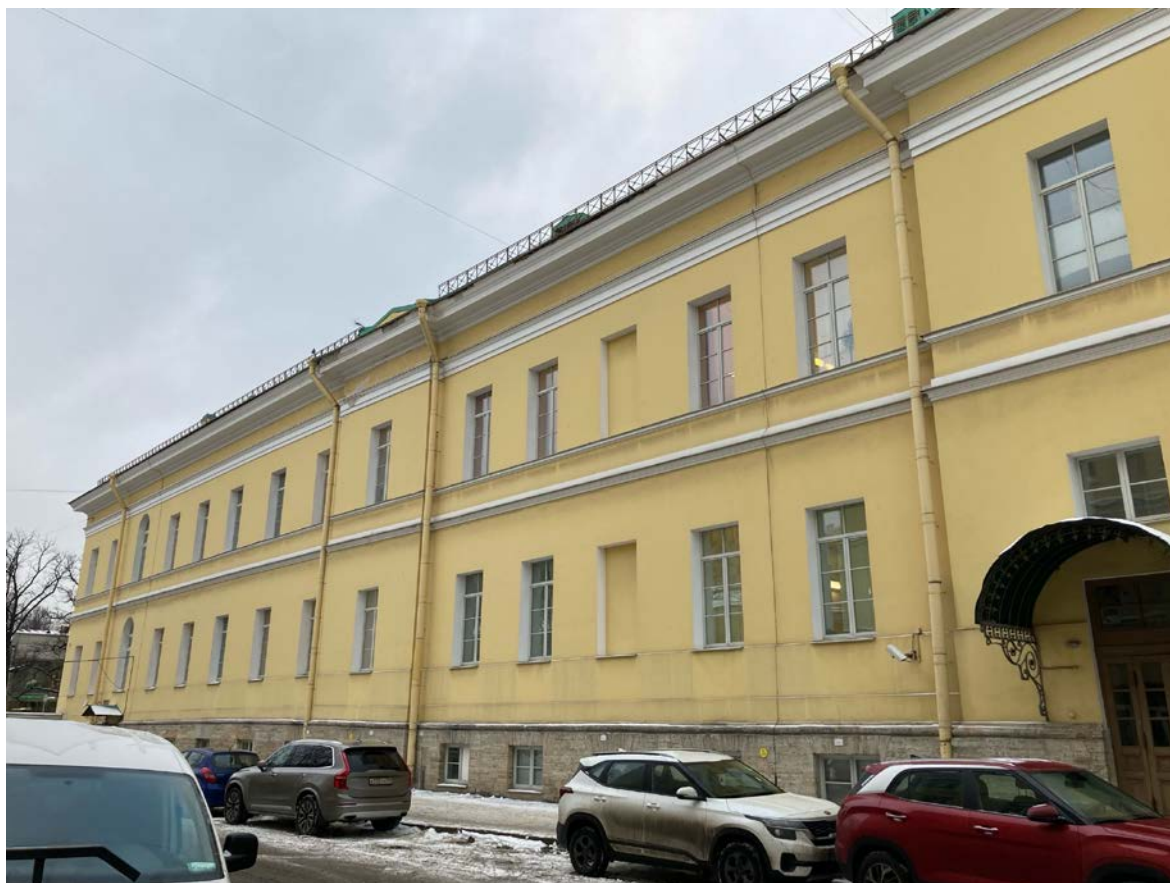
Фото 5. Фрагмент фасада объекта культурного наследия федерального значения «Корпус главный», входящего в состав объекта культурного наследия федерального значения «Больница Мариинская»
