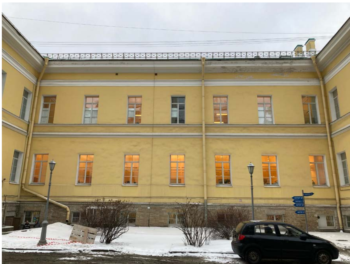
Фото 12. Фрагмент дворового фасада объекта культурного наследия федерального значения «Корпус главный», входящего в состав объекта культурного наследия федерального значения «Больница Мариинская»
