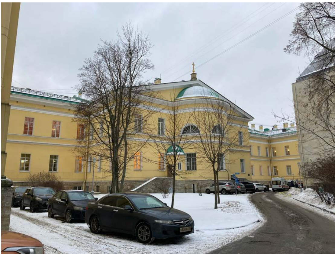
Фото 7. Фрагмент дворового фасада объекта культурного наследия федерального значения «Корпус главный», входящего в состав объекта культурного наследия федерального значения «Больница Мариинская»
