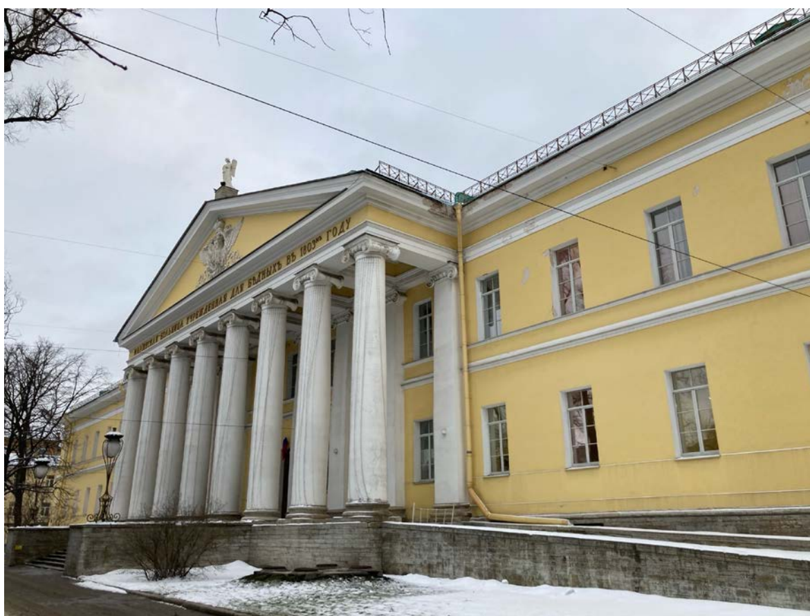
Фото 2. Фрагмент лицевого фасада объекта культурного наследия федерального значения «Корпус главный», входящего в состав объекта культурного наследия федерального значения «Больница Мариинская»
