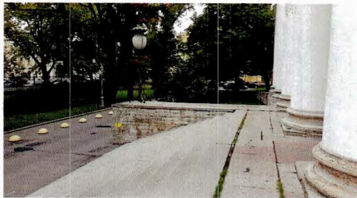
6. Крыльцо с западной стороны здания
