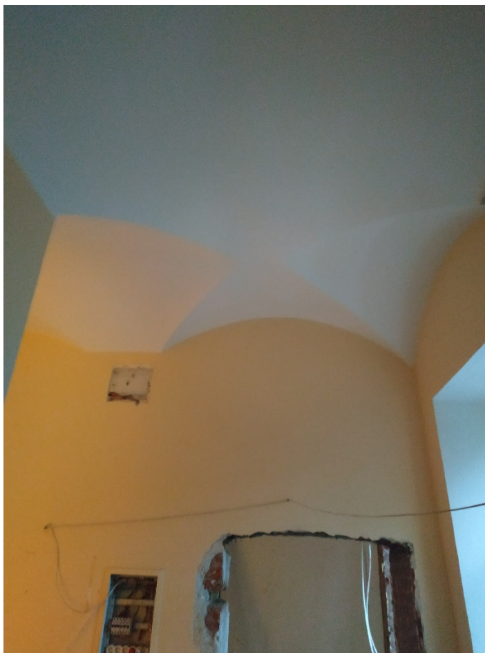
Фото 1. Вид на вход в квартиру № 5 со стороны ЗЛК.
