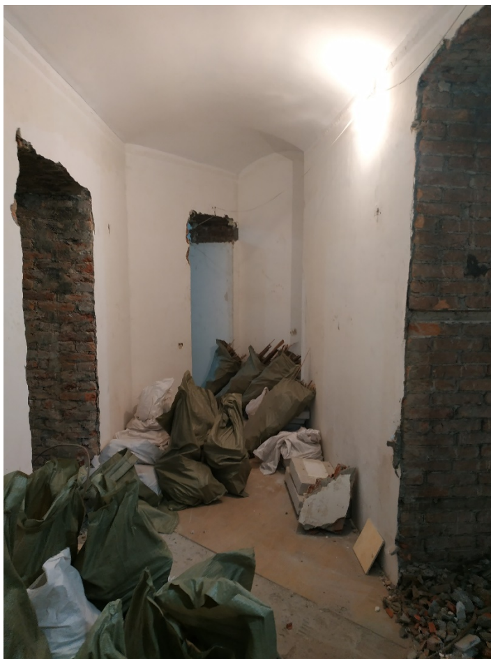
Фото 39. Отсутствие внешней отделки, складирование строительного мусора.
