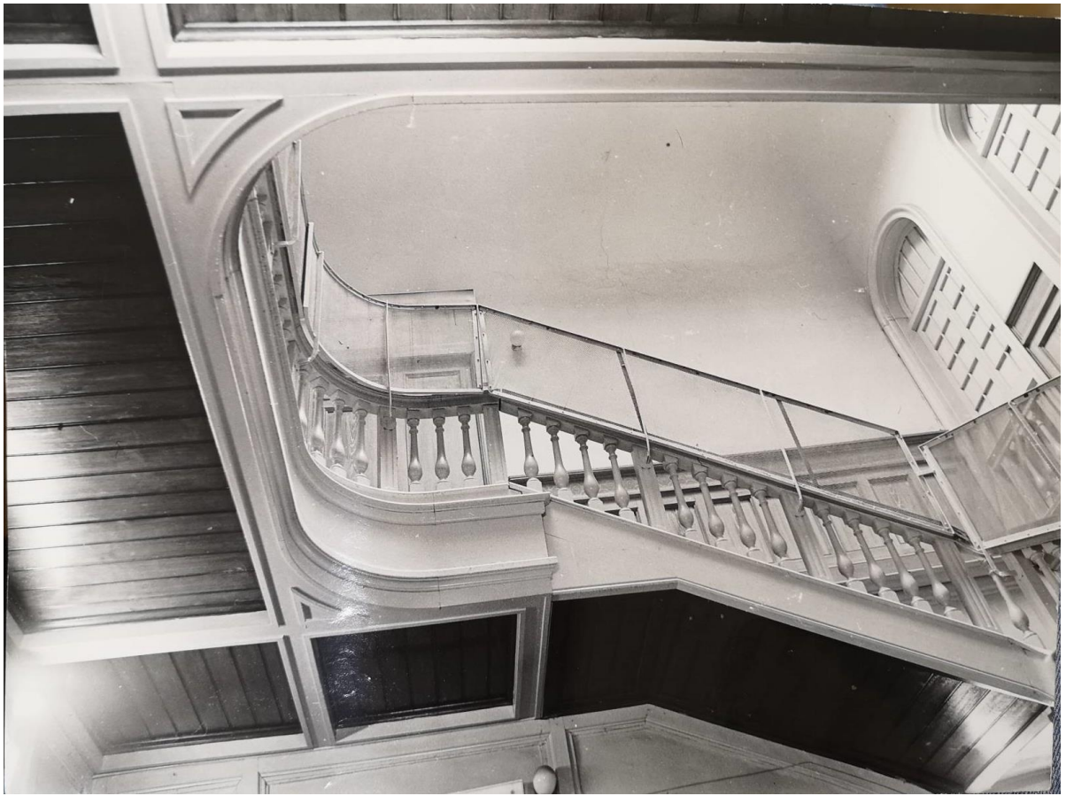
Илл. 35. Бывший дом Гудовича. Пушкин, Парковая 18. Фото 1973 г.//Архив КГИОП. П. 226-Г-61.
