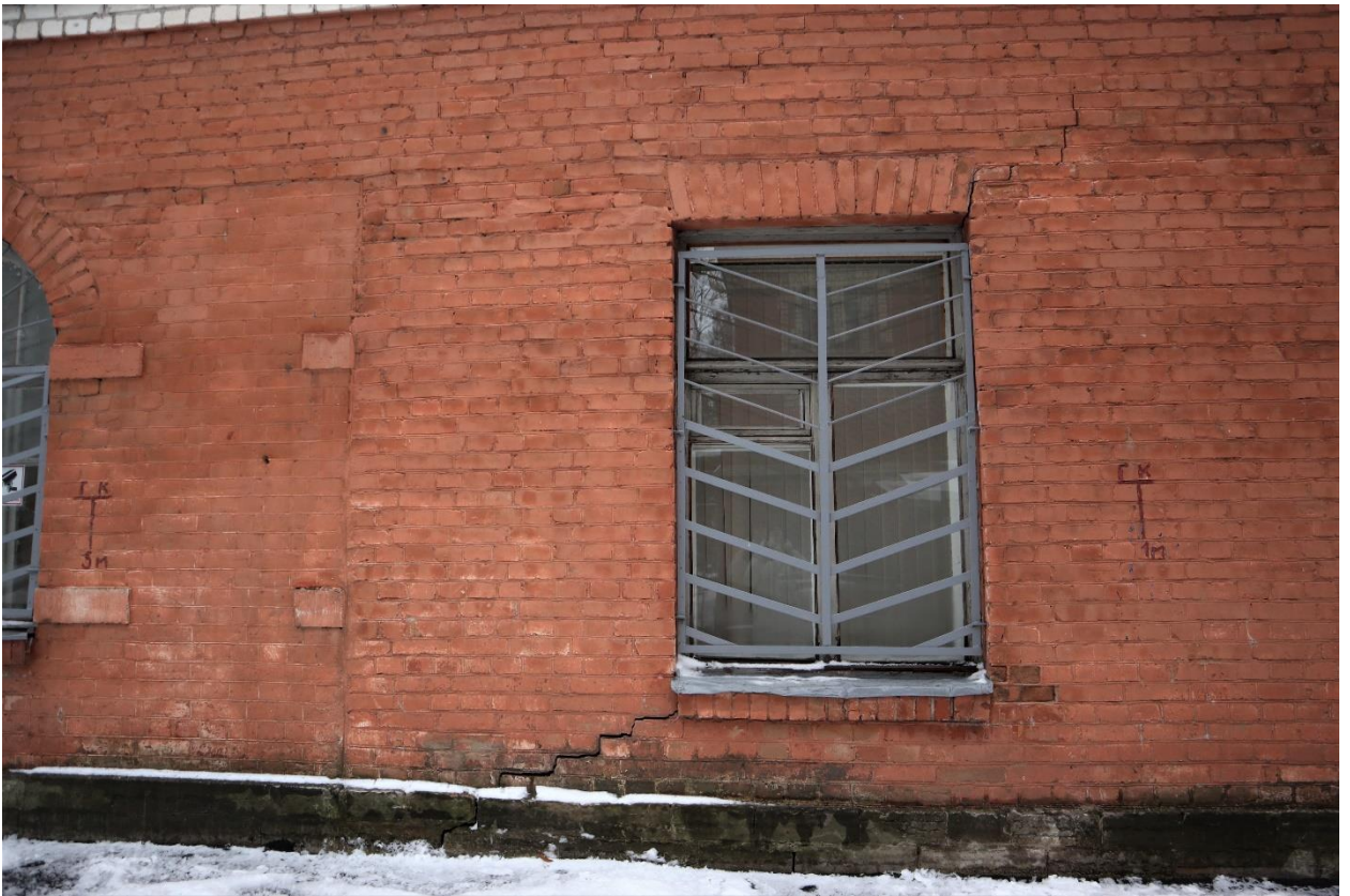
Фото 4. Фрагмент северного фасада, оконный проем первого этажа.
