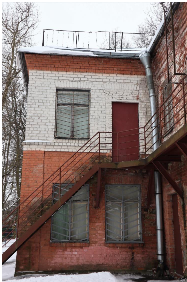
Фото 16. Фрагмент восточного фасада.
