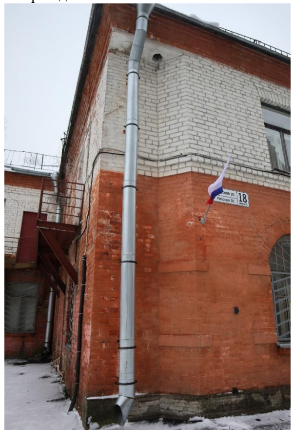
Фото 3. Фрагмент северного фасада.
