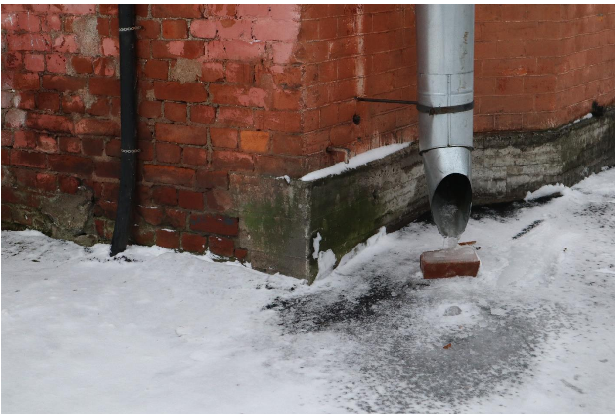
Фото 19. Фрагмент восточного фасада.
