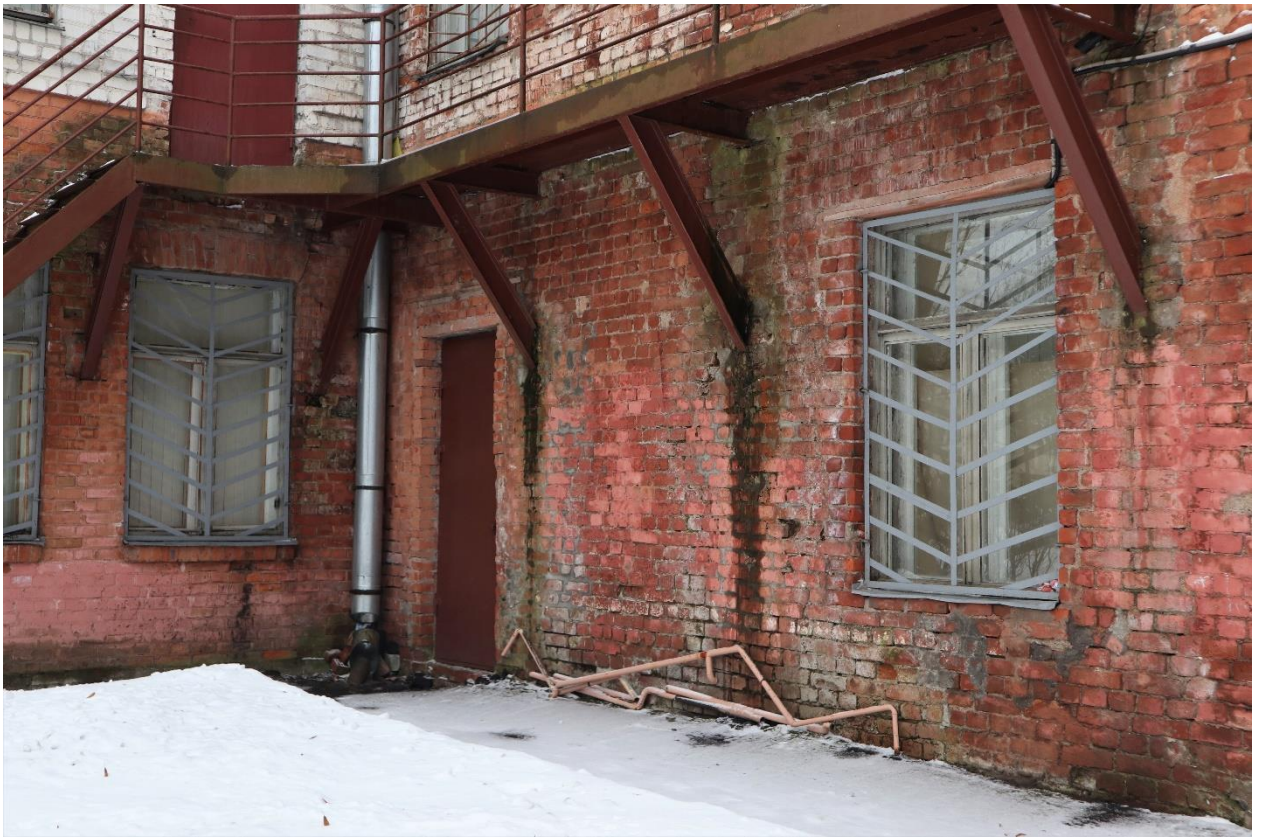
Фото 17. Фрагмент восточного фасада.
