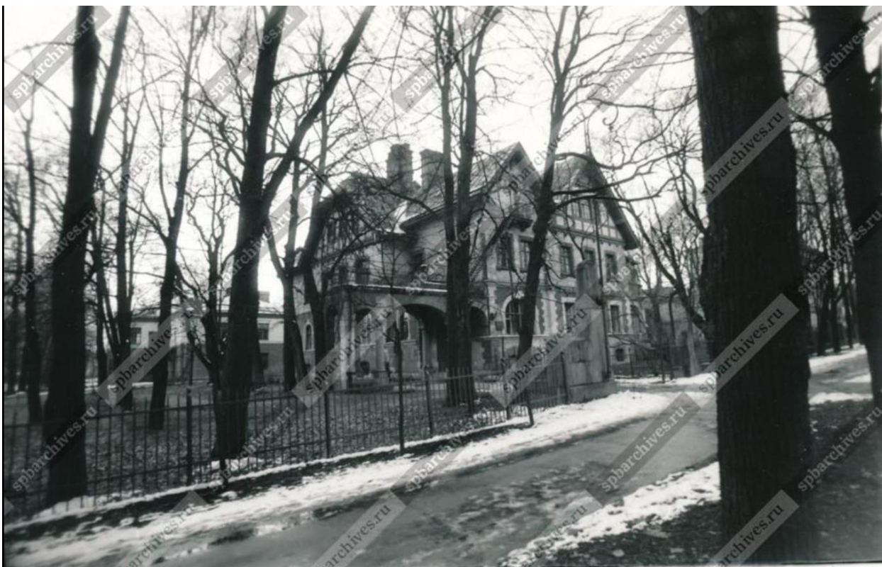
Илл. 25. Вид северного фасада особняка графа В.В. Гудовича по Парковой улице, 18 (архитектор С.А. Данини, 1905-1906 гг.). 18 апреля 1992 год. Автор съемки Овчинников Кирилл Владимирович//ЦГАКФФД СПб. Фотодокумент Ар 248000
