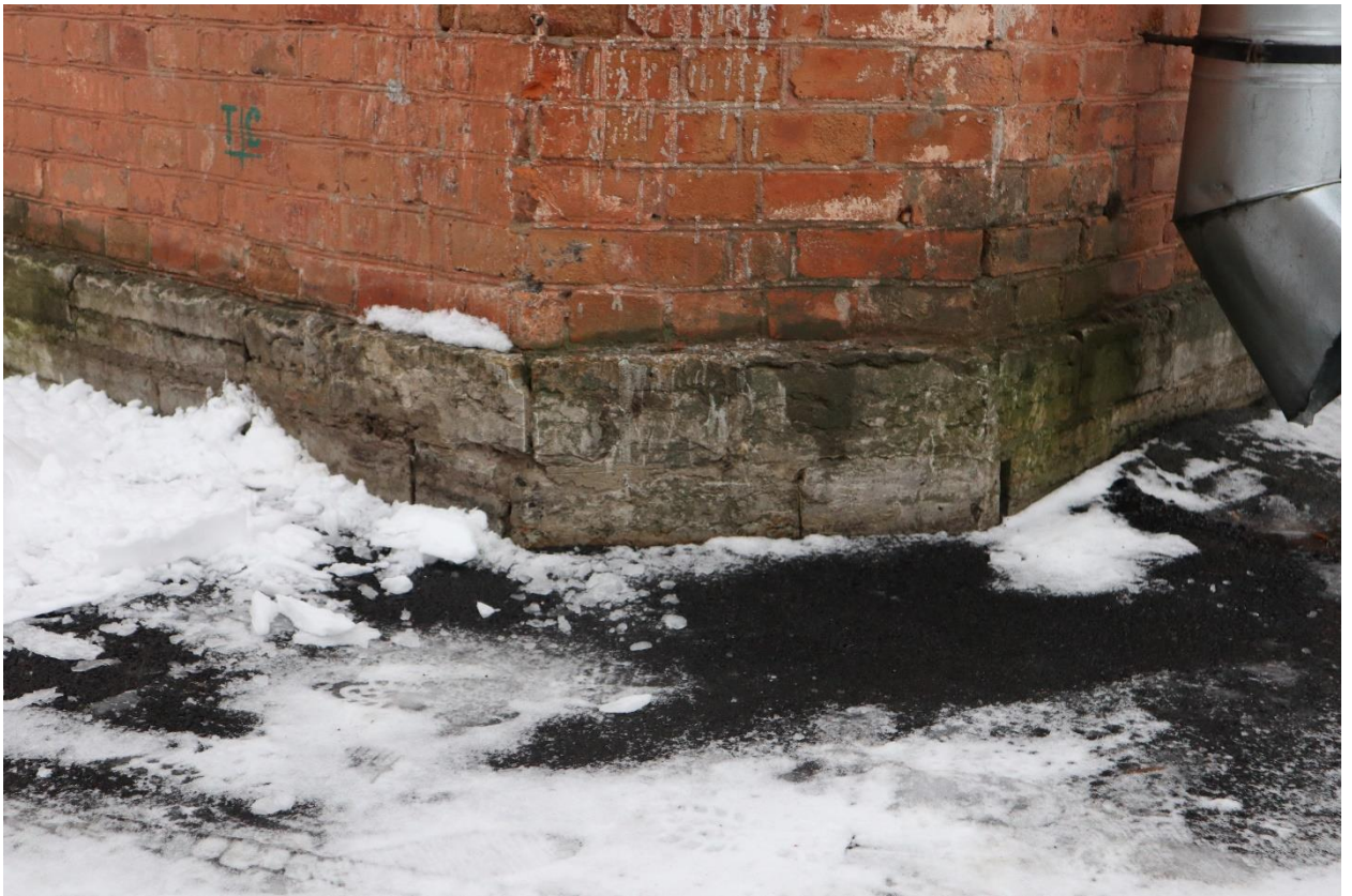
Фото 6. Фрагмент северного фасада, цоколь.
