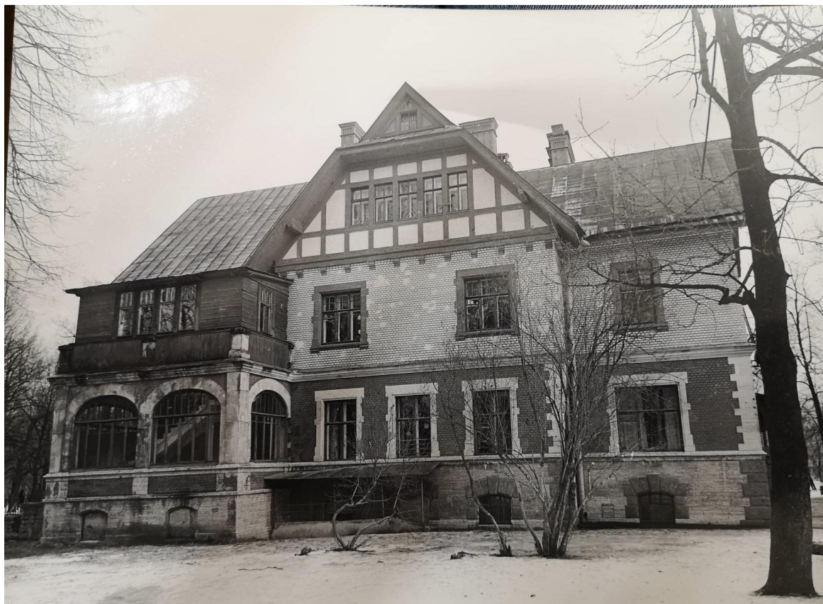
Илл. 20. Бывший дом Гудовича. Пушкин, Парковая 18. Фото 1973 г.//Архив КГИОП. П. 226-Г-61.
