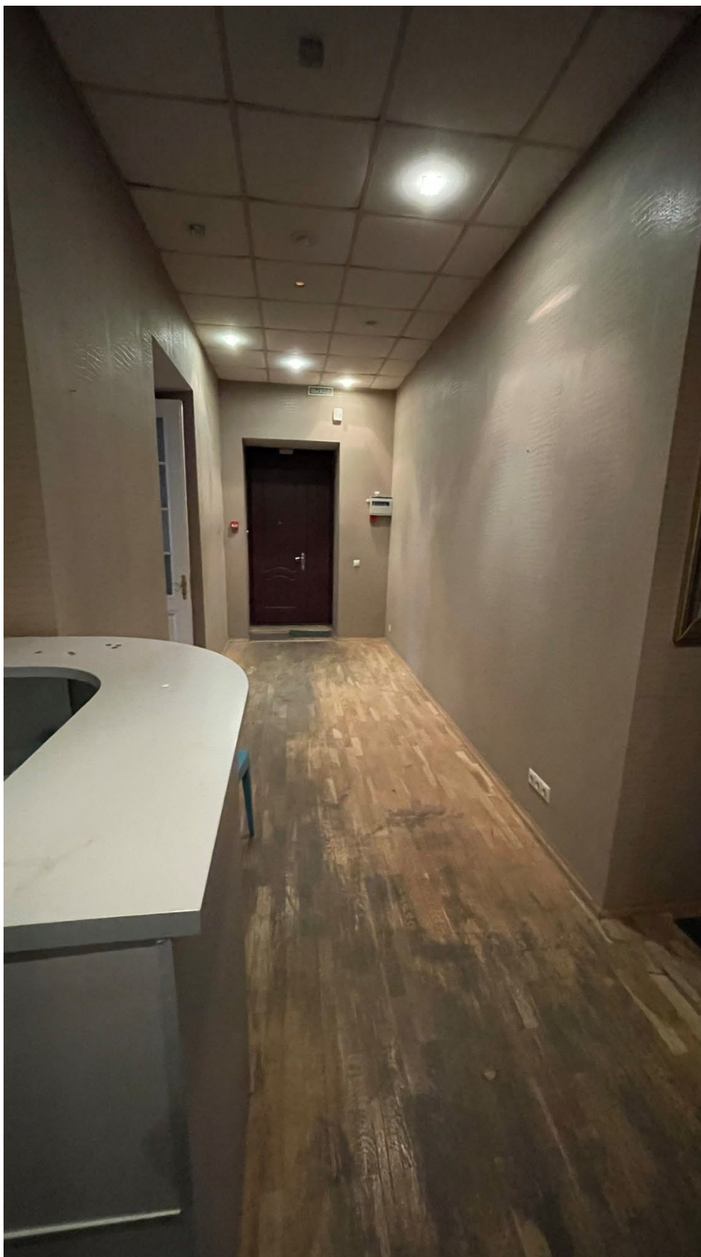
8. Фрагмент интерьера коридора (помещение 3/10.7);
