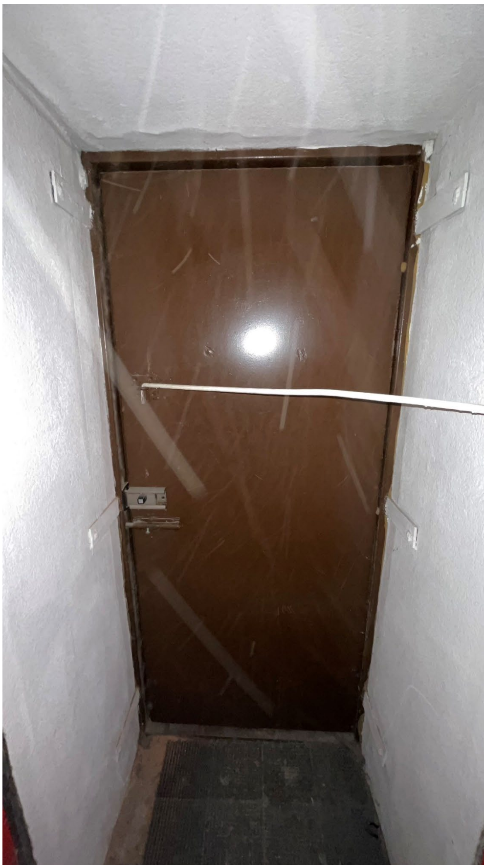
16. Вид на входную дверь;
