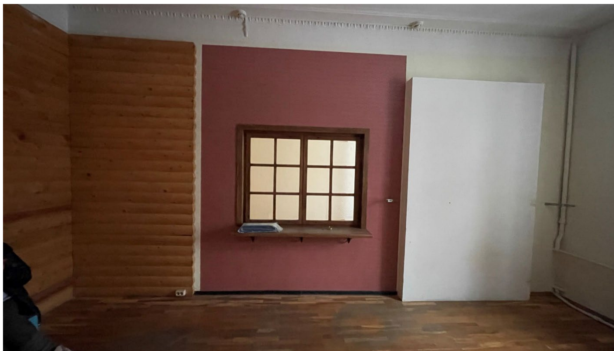
31.Фрагмент интерьера комнаты (помещение 15/28.7);
