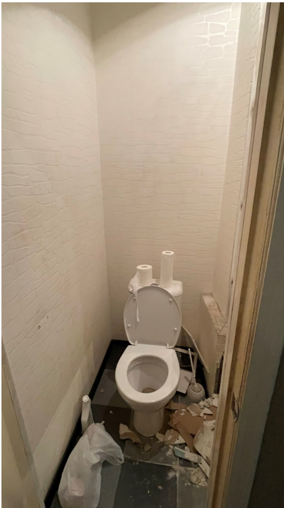
18. Вид на санузел (помещение 10);
