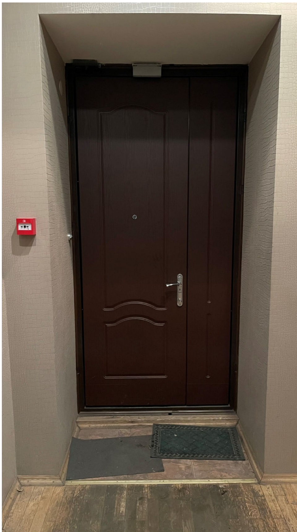
5. Вид на входную дверь в квартире;
