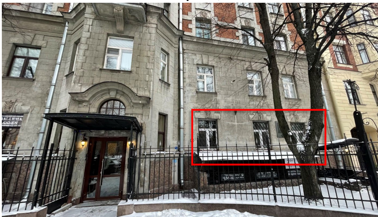
2. Вид на главный фасад здания и окна помещения с Кронверкской улицы;
