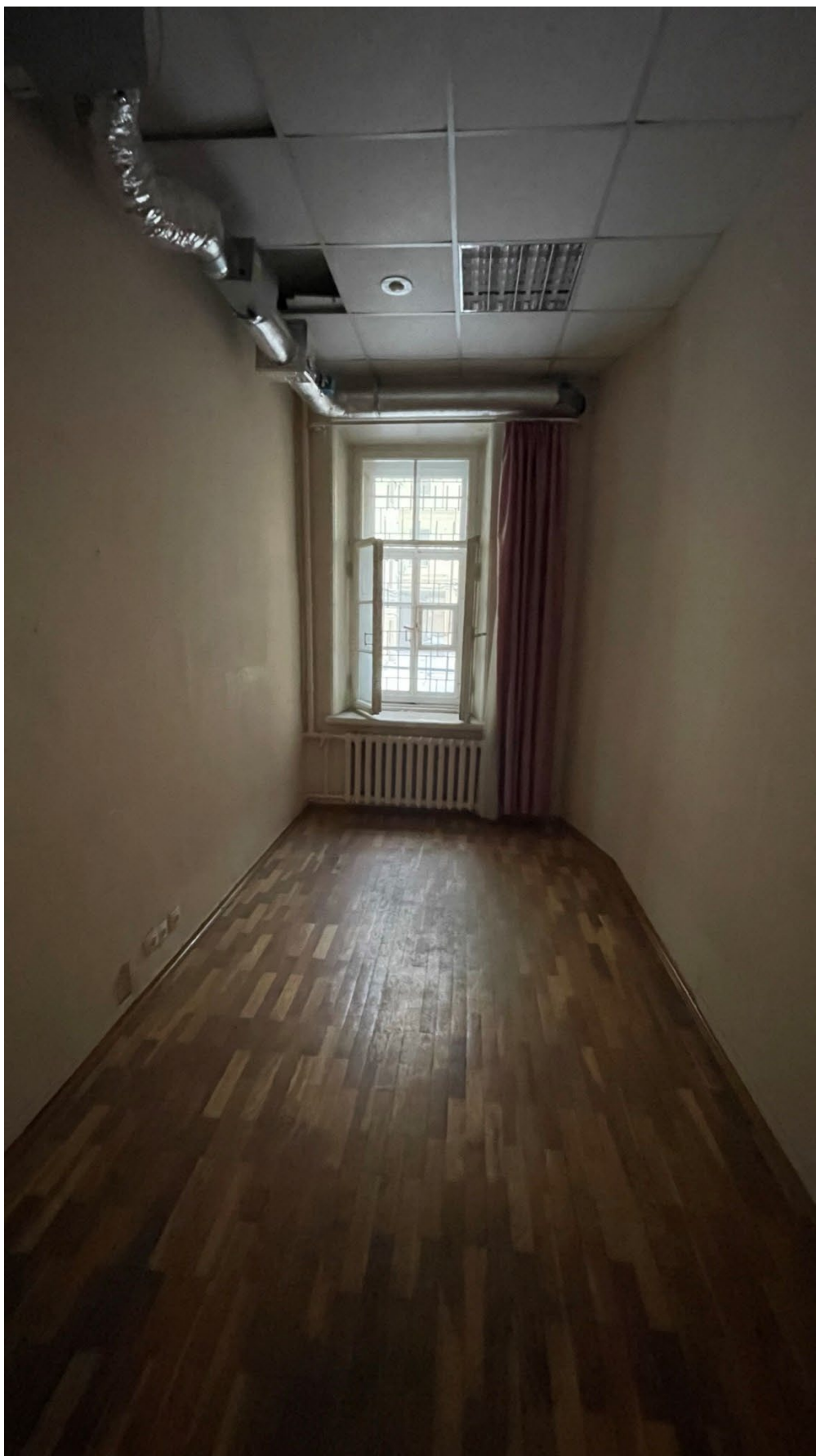
10.Фрагмент интерьера комнаты (помещение 4/10.2);
