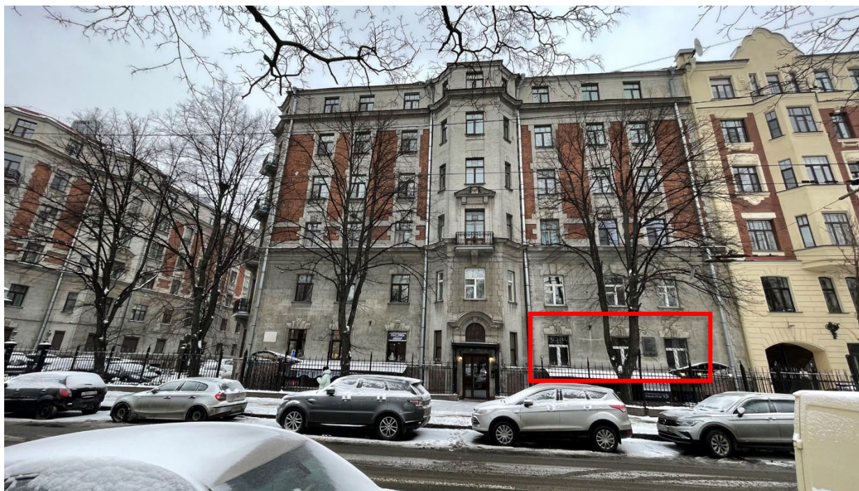
1. Вид на главный фасад здания и окна помещения с Кронверкской улицы;
