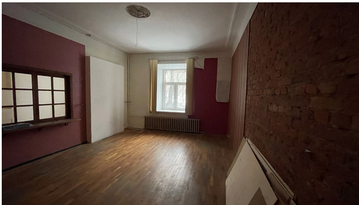
29.Фрагмент интерьера комнаты (помещение 15/28.7);
