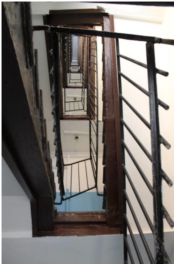
26. Вид выявленного объекта культурного наследия «С.И. Ширвиндта». Дата съемки 19.04.2021
