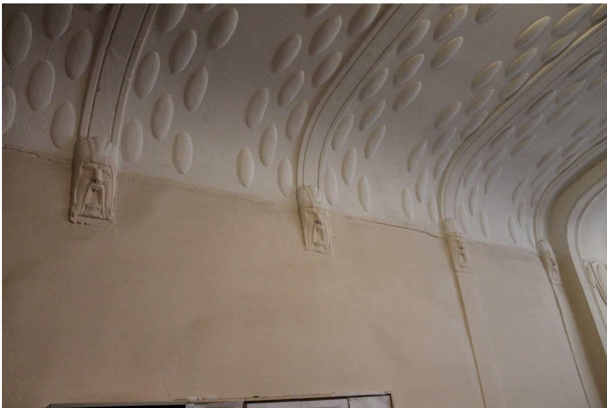
13. Вид выявленного объекта культурного наследия «С.И. Ширвиндта». Направление съемки север. Дата съемки 19.04.2021
