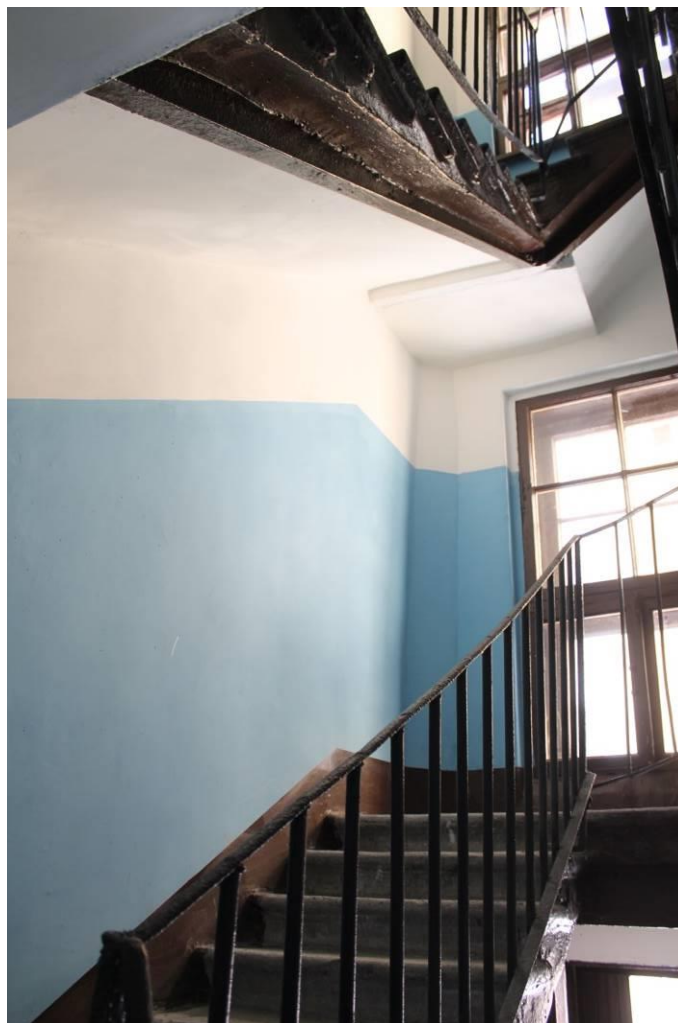
27. Вид выявленного объекта культурного наследия «С.И. Ширвиндта». Направление съемки север-запад. Дата съемки 19.04.2021
