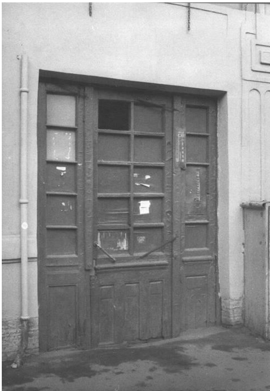
52. Дом С.И. Ширвиндта. Фрагмент фасада. Парадная дверь. 1998 г.
