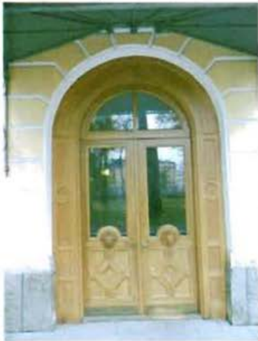
52. Входной проем со стороны сада
