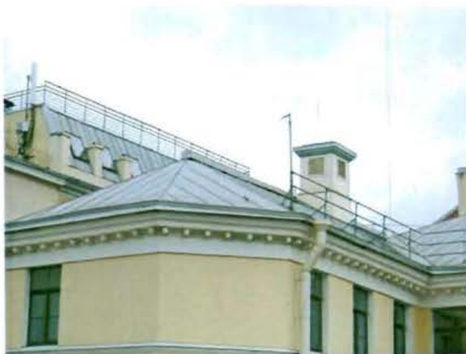
8. Металлическое покрытие кровли
