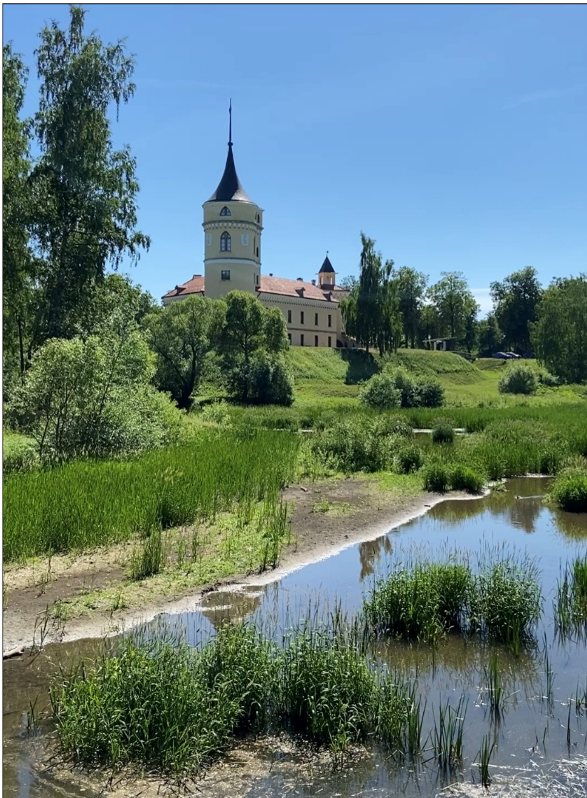
24. Крепость Бил. Вид на юг с Горбатого моста. 30.08.2022 г.
