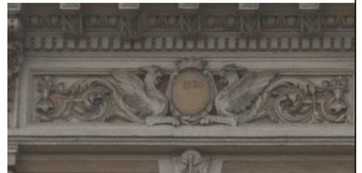
венчающий профилированный раскрепованный карниз с модульонами, поясами иоников и дентикул, на двоянных орнаментированных кронштейнах (в части центральной раскреповки фасада);
