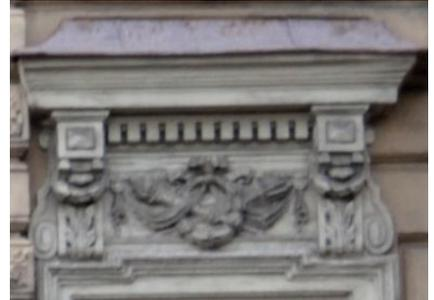
оформление оконных проемов и дверного (балконного) в уровне 4-го этажа – профилированные наличники, замковые камни с кадуцеем, профилированные подоконные доски, фигурные «полотенца» с растительным орнаментом;
