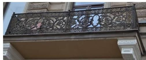
балконные ограждения в уровне 3-го этажа – конфигурация, материал (черный металл), техника исполнения (литье, ковка), рисунок (ажурные секции геометрического с растительным орнаментом с верхним горизонтальным поясом меандра и нижним поясом из кругов, с угловыми стойками с навершием в виде шара);
