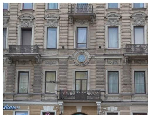
балконное ограждение в уровне 2-го этажа – конфигурация, материал (черный металл), техника исполнения (литье, ковка), рисунок (секции из переплетающихся растительных завитков с бордюром из пояса меандра, между секциями - вертикальные стойки с навершием в виде шара);
