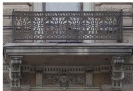
балконное ограждение в уровне 4-го этажа – конфигурация, , материал (черный металл), техника исполнения (литье, ковка), рисунок (ажурные секции с вытянутыми желобками в обрамлении геометрического орнамента с завитками, с угловыми стойками с шарообразным навершием);
