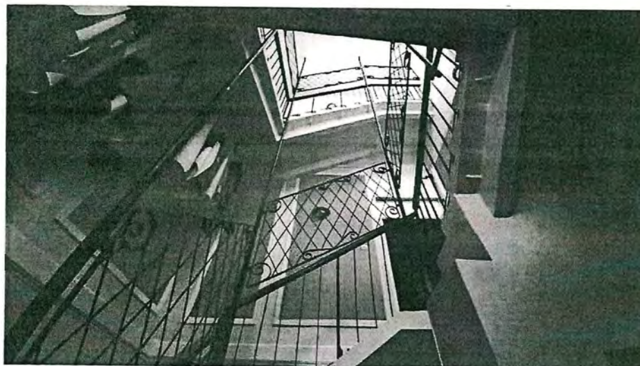
13. Флигель, интерьеры. Главная лестница
