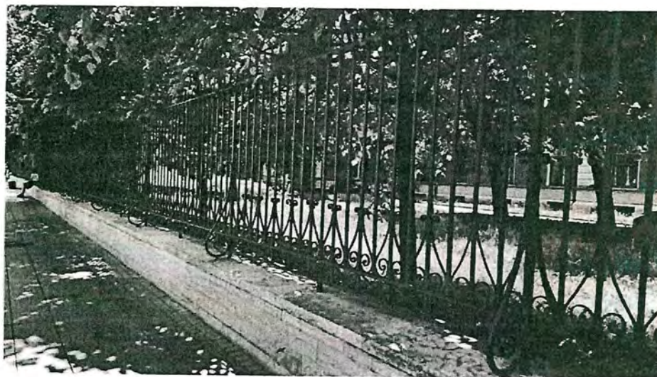
15. Ограда. Общий вид
