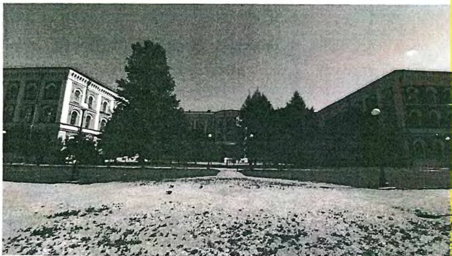
2. Здание института. Западный фасад
