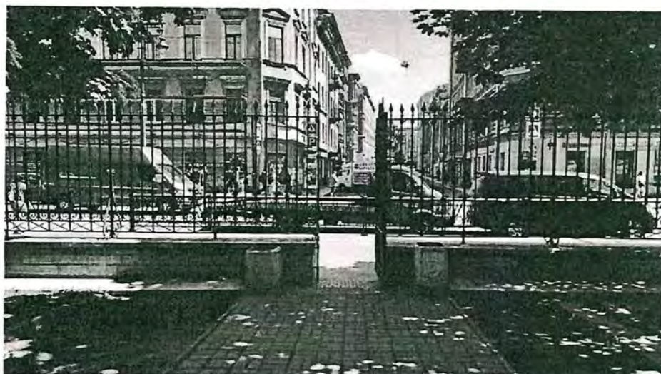
17. Ограда. Вид со стороны здания института.
