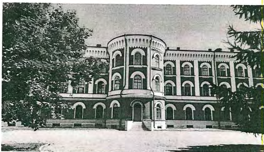
1. Здание института. Полуциркульный ризалит западного фасада
