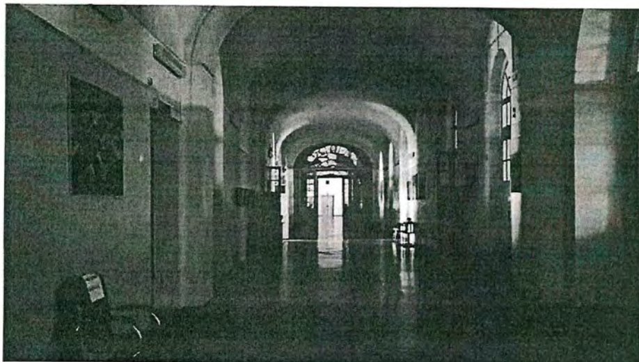
7. Здание института, интерьеры. Коридор второго этажа
