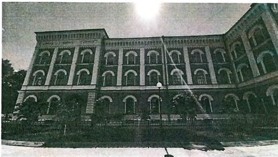
4. Здание института. Фрагмент северного фасада
