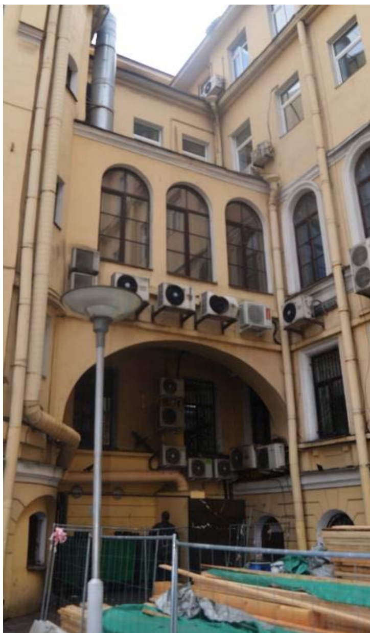
20. Выявленный объект культурного наследия «Дом Глазуновых». Соединение восточного дворового флигеля с лицевым домом. Вид с запада. Съемка 26.04.2021
