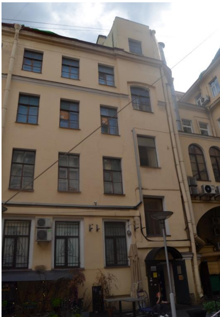
23. Выявленный объект культурного наследия «Дом Глазуновых». Восточный дворовый флигель. Южная часть западного фасада. Вид с запада. Съемка 26.04.2021
