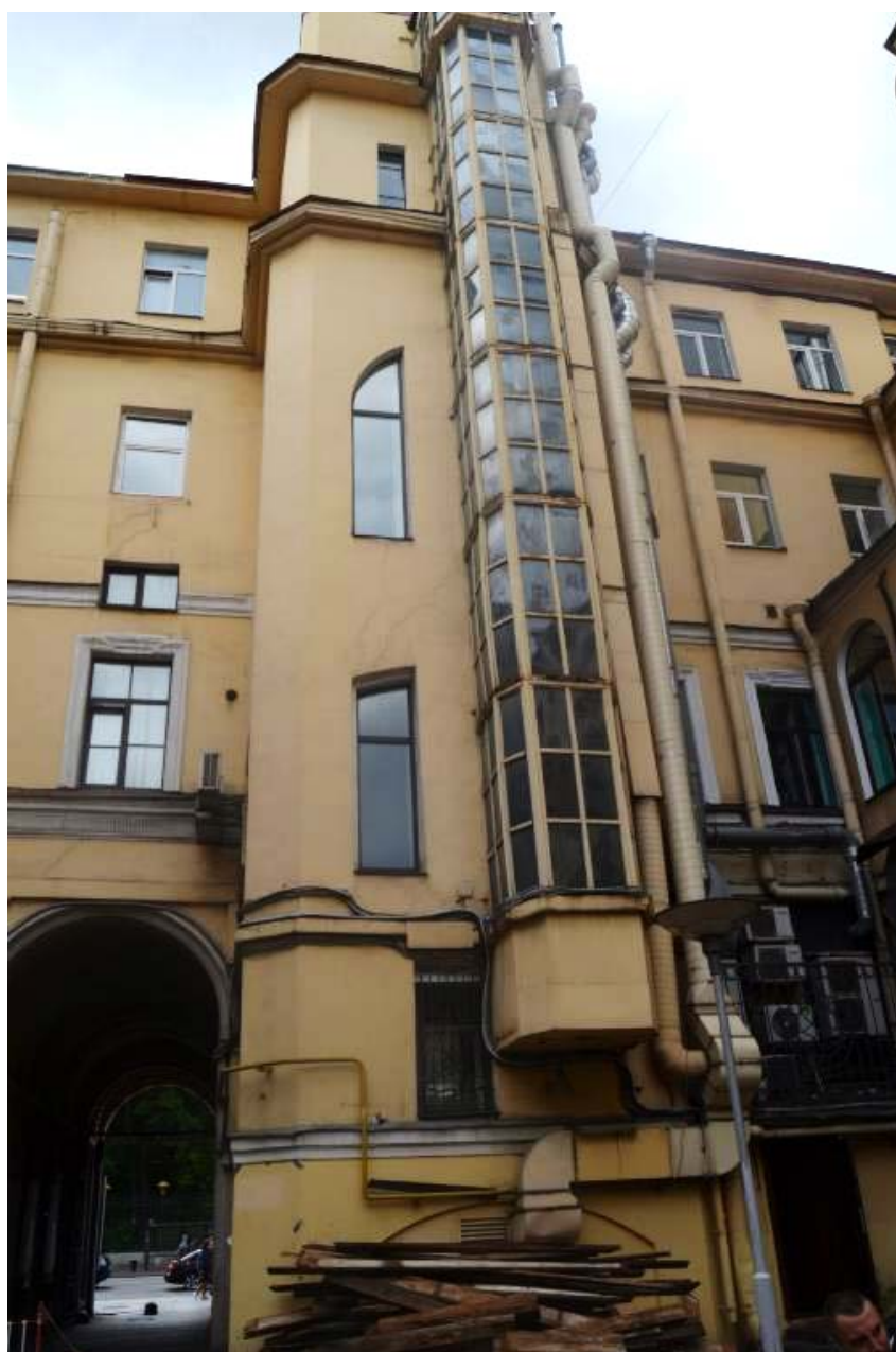
18. Выявленный объект культурного наследия «Дом Глазуновых». Дворовый (северный) фасад лицевого дома. Центральная и западная часть. Вид с севера. Съемка 26.04.2021
