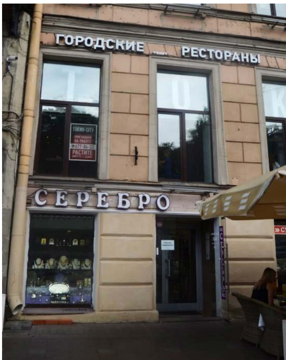
5. Выявленный объект культурного наследия «Дом Глазуновых». Лицевой (южный) фасад лицевого дома. Оформление первого и второго этажей фасада. Вид с юга. Съемка 26.04.2021
