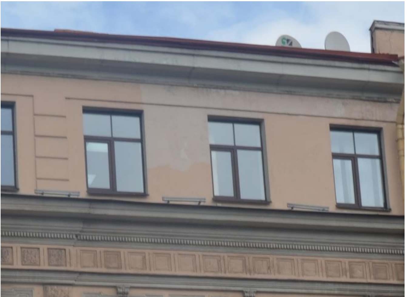
8. Выявленный объект культурного наследия «Дом Глазуновых». Лицевой (южный) фасад лицевого дома. Оформление пятого этажа и кровельного узла фасада. Вид с юга. Съемка 26.04.2021
