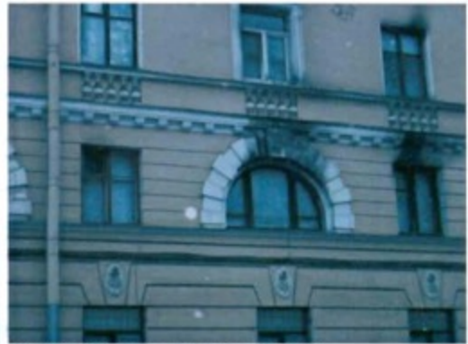
12. Оконные проемы второго этажа.
