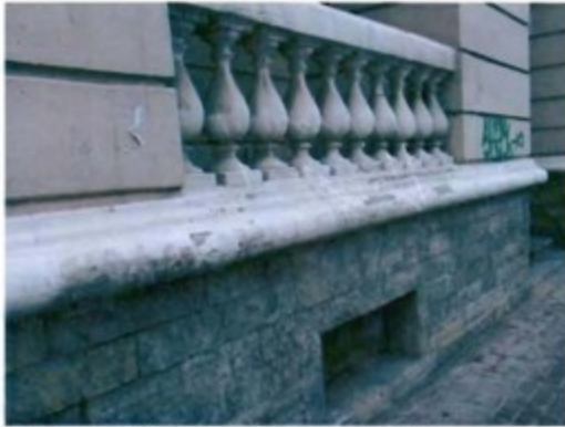
15. Балюстрада и цоколь крыльца портика.
