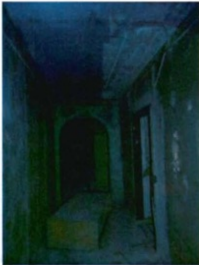
17. Помещение первого этажа.
