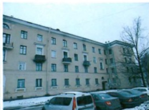
8. Фрагмент фасада. Вид с северо-востока.
