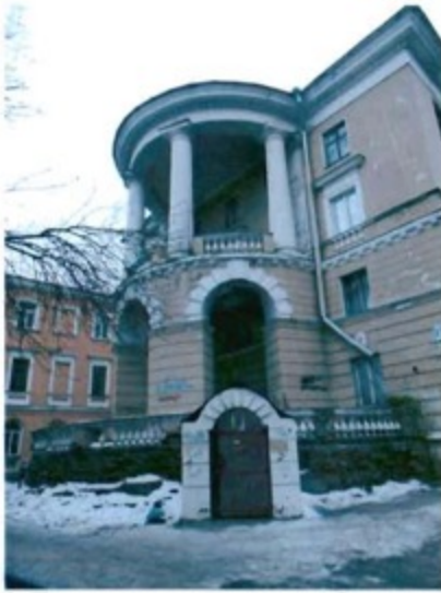
9. Полуциркульный ризалит с балконом и террасой.
