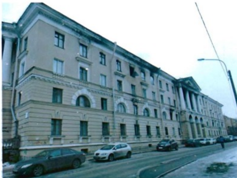
2. Лицевой фасад. Вид с запада.
