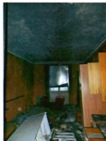
20. Помещение третьего этажа.
