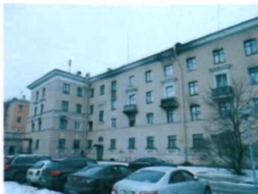
7. Фрагмент фасада. Вид с севера.
