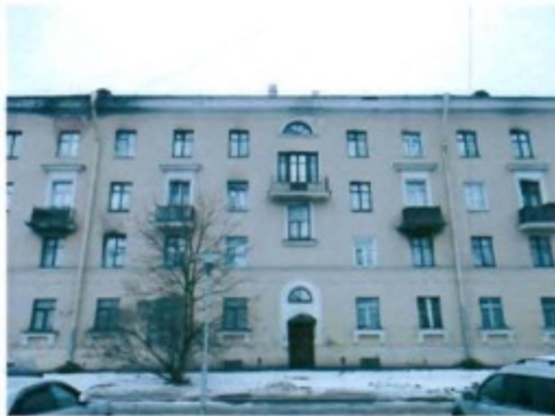
5. Фрагмент фасада. Вид с северо-востока.
