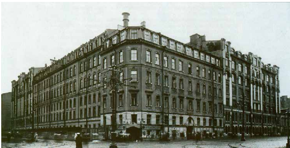
11. Табачная фабрика Урицкого. 1930 г. — Штиглиц М.С., Лелина В.И., Гордеева М.А., Кириков Б.М. Памятники промышленной архитектуры Санкт-Петербурга. 2-е изд. - СПб.: Белое и Черное, 2005.
