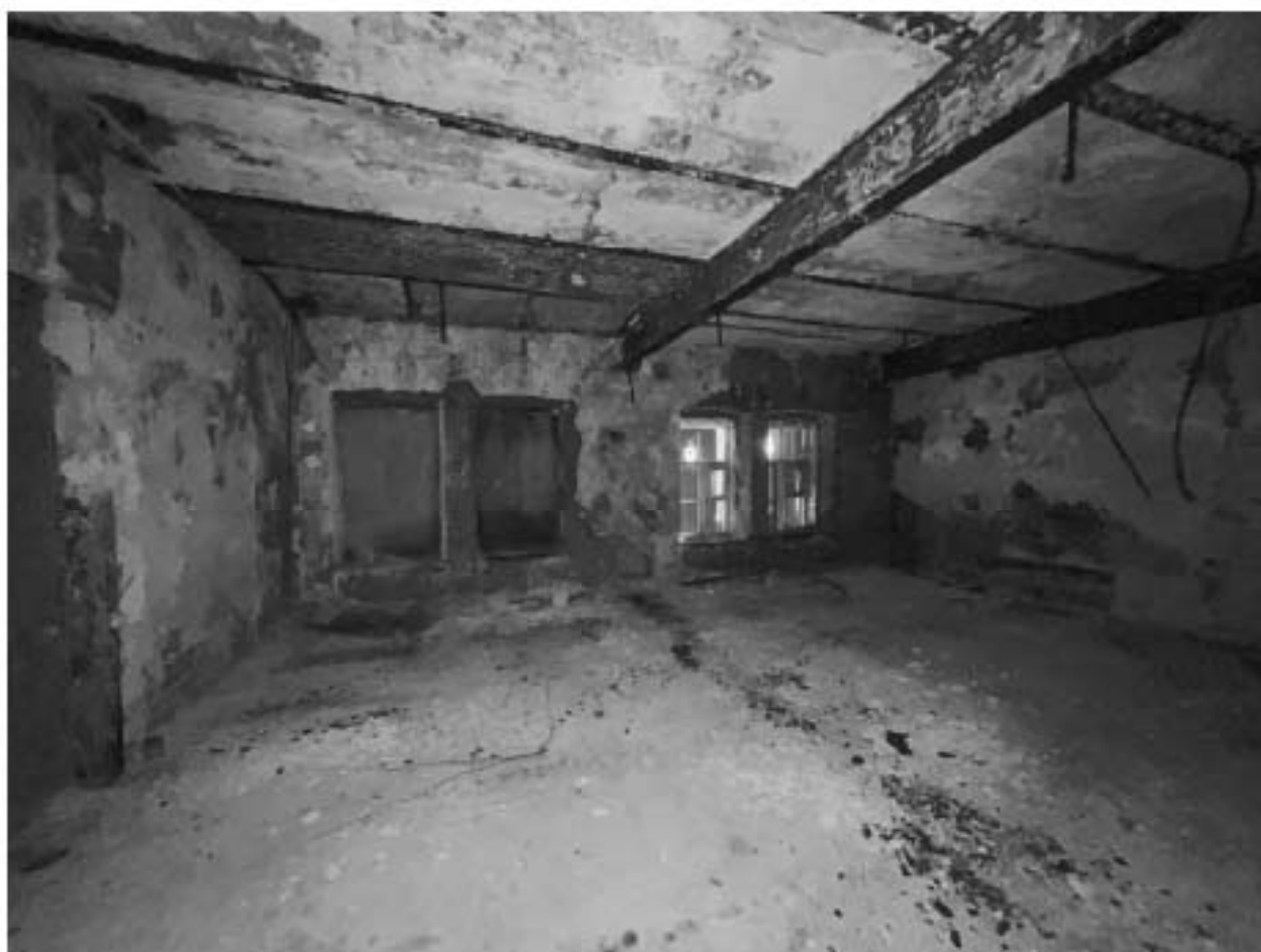
Фото №37. Объект культурного наследия регионального значения «Сельдяной ряд Никольского рынка», помещения второго этажа.
