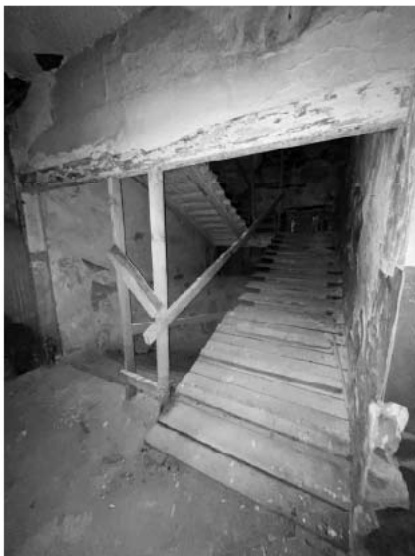
Фото №51. Объект культурного наследия регионального значения «Сельдяной ряд Никольского рынка», помещения третьего этажа.
