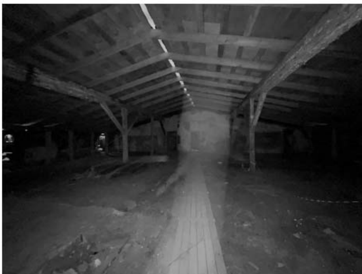
Фото №56. Объект культурного наследия регионального значения «Сельдяной ряд Никольского рынка», помещения мансарды.
