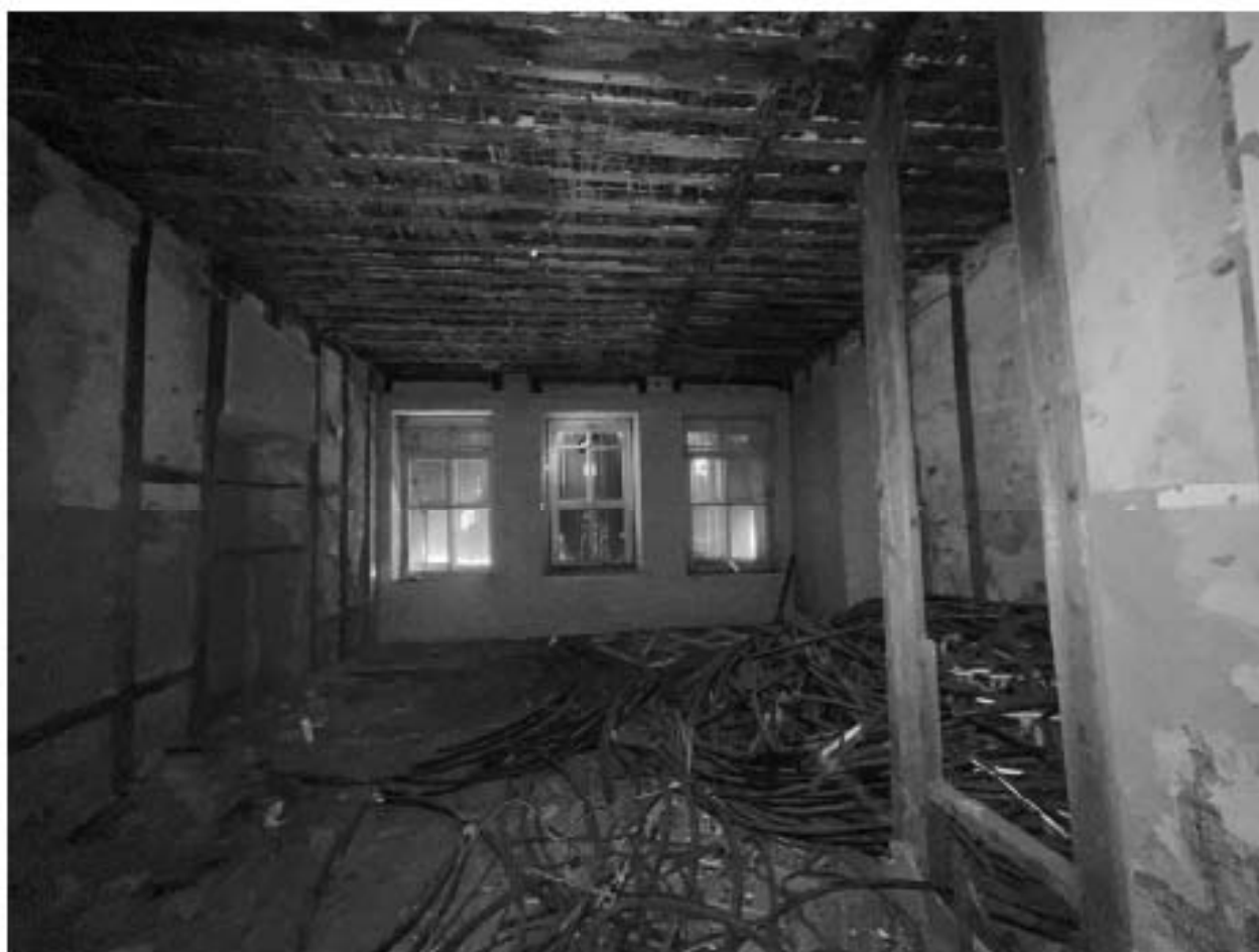
Фото №40. Объект культурного наследия регионального значения «Сельдяной ряд Никольского рынка», помещения второго этажа.
