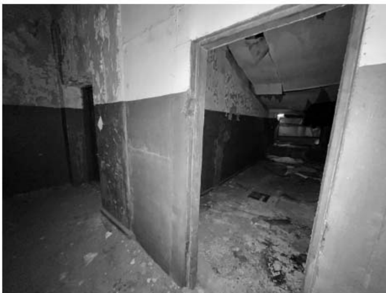
Фото №57. Объект культурного наследия регионального значения «Сельдяной ряд Никольского рынка», помещения мансарды.
