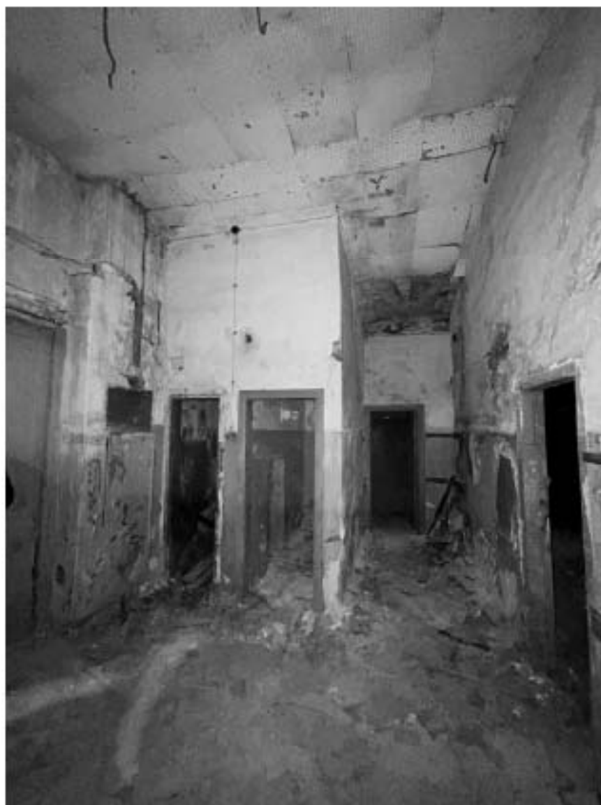
Фото №52. Объект культурного наследия регионального значения «Сельдяной ряд Никольского рынка», помещения третьего этажа.
