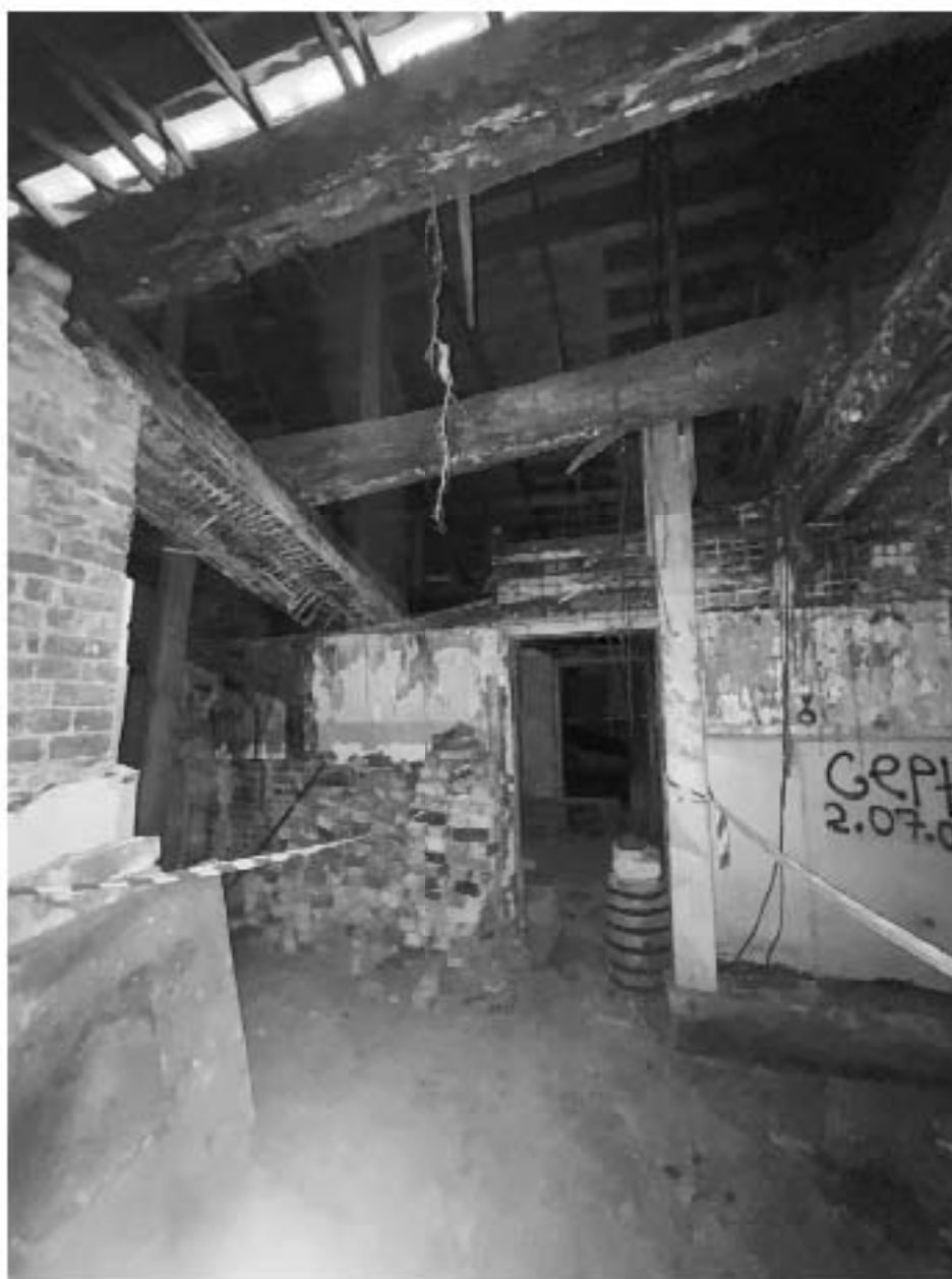
Фото №43. Объект культурного наследия регионального значения «Сельдяной ряд Никольского рынка», помещения второго этажа.
