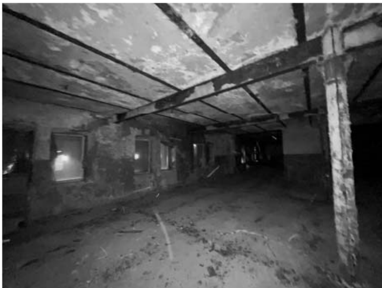
Фото №49. Объект культурного наследия регионального значения «Сельдяной ряд Никольского рынка», помещения третьего этажа.
