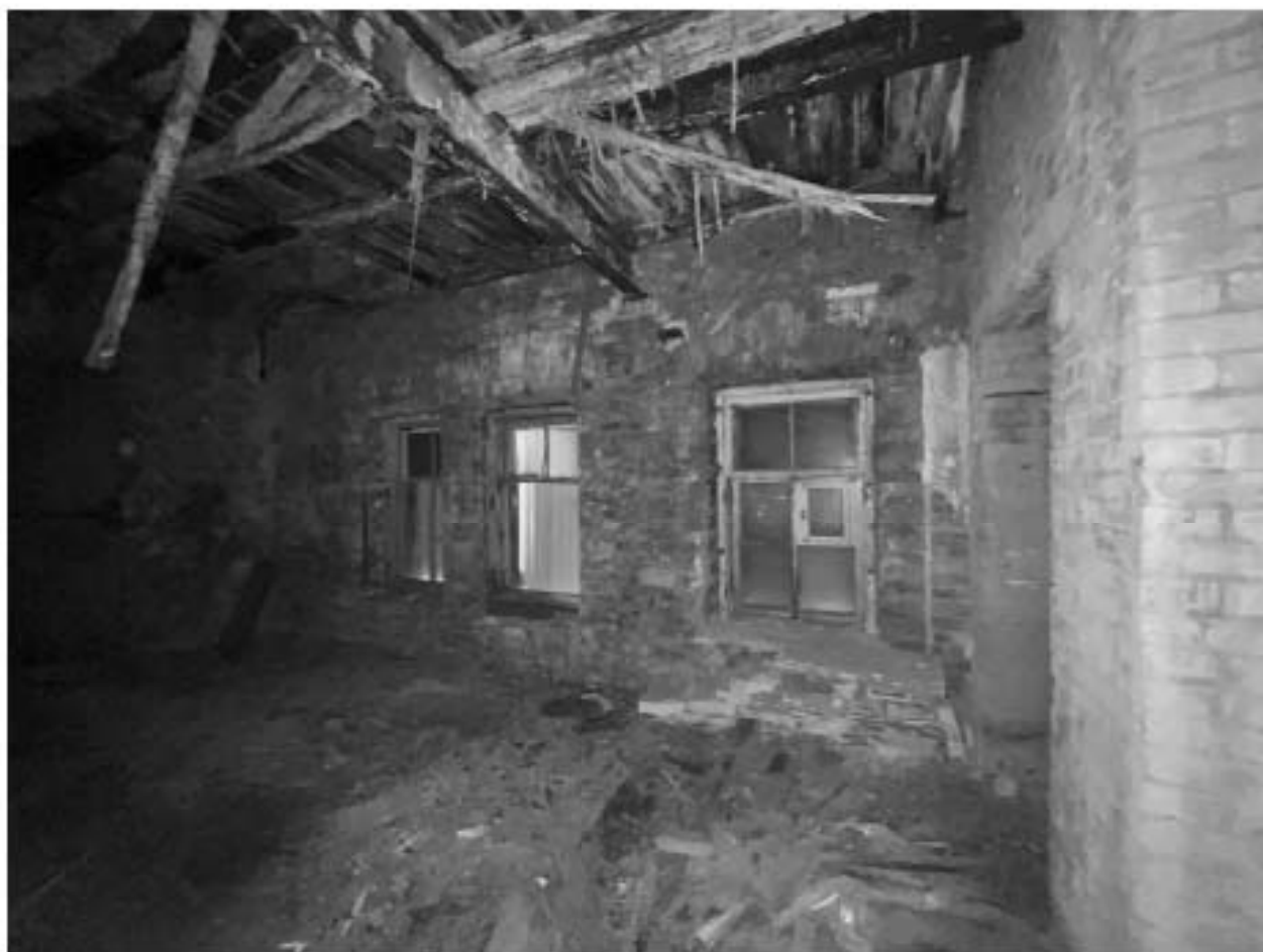
Фото №32. Объект культурного наследия регионального значения «Сельдяной ряд Никольского рынка», помещения второго этажа.
