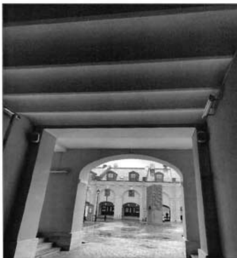
7. Прусские своды арки воротного проезда со стороны ул. Садовая.
