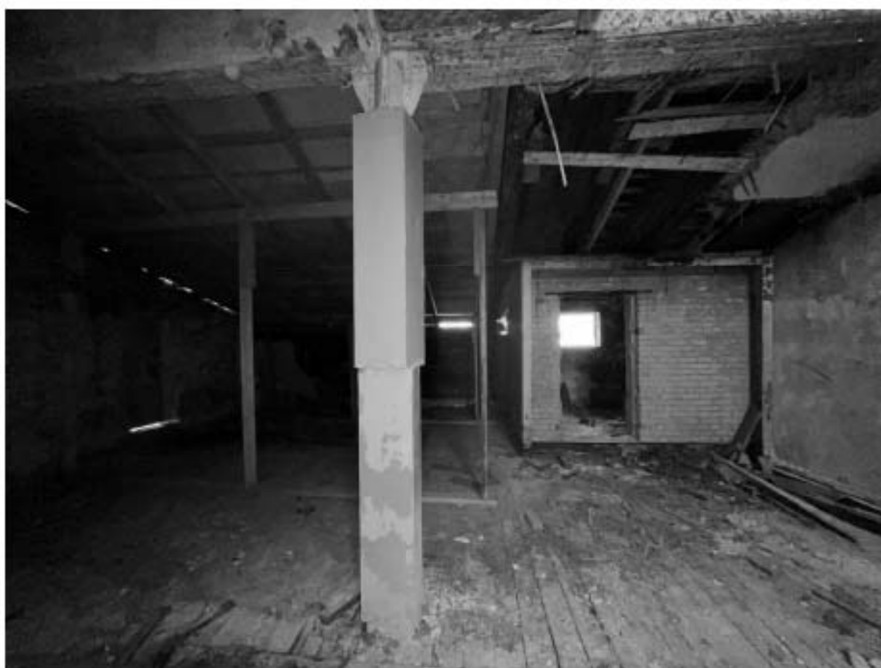
Фото №53. Объект культурного наследия регионального значения «Сельдяной ряд Никольского рынка», помещения мансарды.
