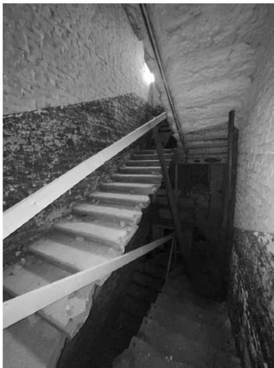
Фото №39. Объект культурного наследия регионального значения «Сельдяной ряд Никольского рынка», помещения второго этажа.
