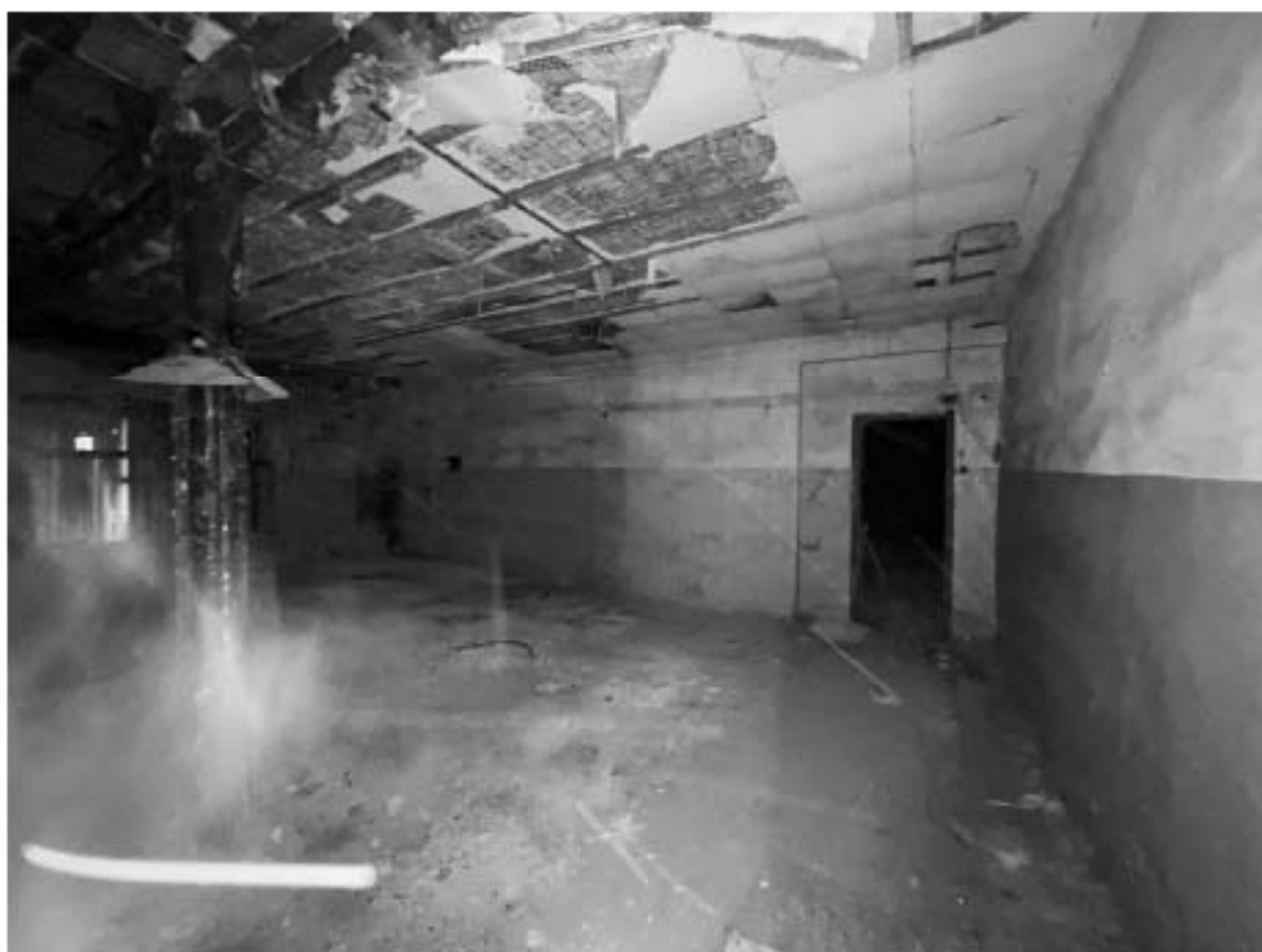
Фото №50. Объект культурного наследия регионального значения «Сельдяной ряд Никольского рынка», помещения третьего этажа.
