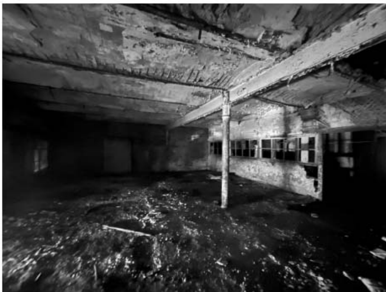
Фото №31. Объект культурного наследия регионального значения «Сельдяной ряд Никольского рынка», помещения второго этажа.
