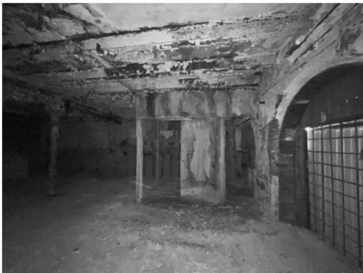
Фото №19. Объект культурного наследия регионального значения «Сельдяной ряд Никольского рынка», подвал, пом. 5-Н (2).
