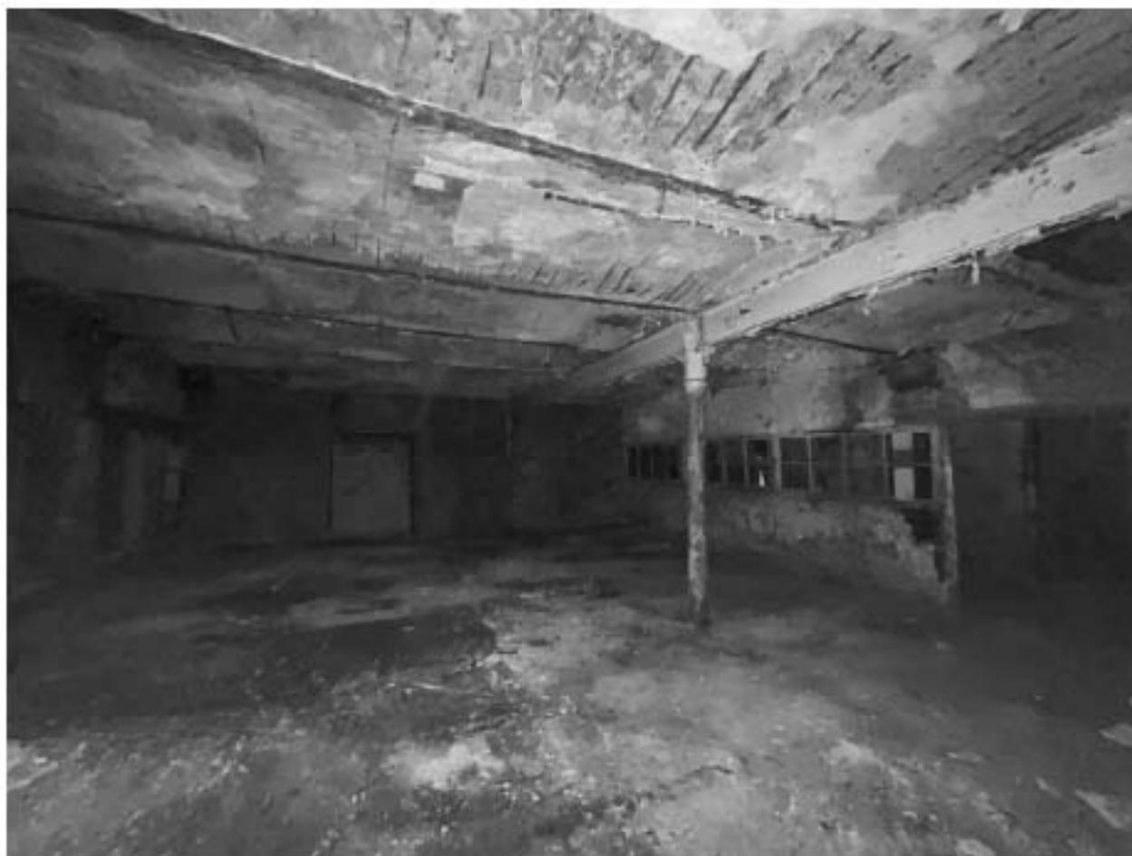
Фото №33. Объект культурного наследия регионального значения «Сельдяной ряд Никольского рынка», помещения второго этажа.
