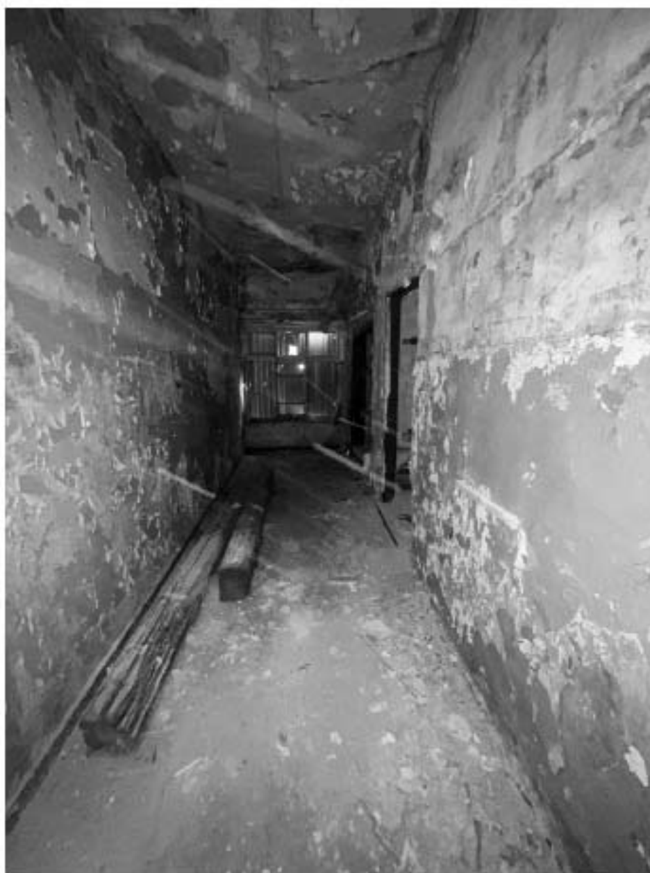
Фото №38. Объект культурного наследия регионального значения «Сельдяной ряд Никольского рынка», помещения второго этажа.
