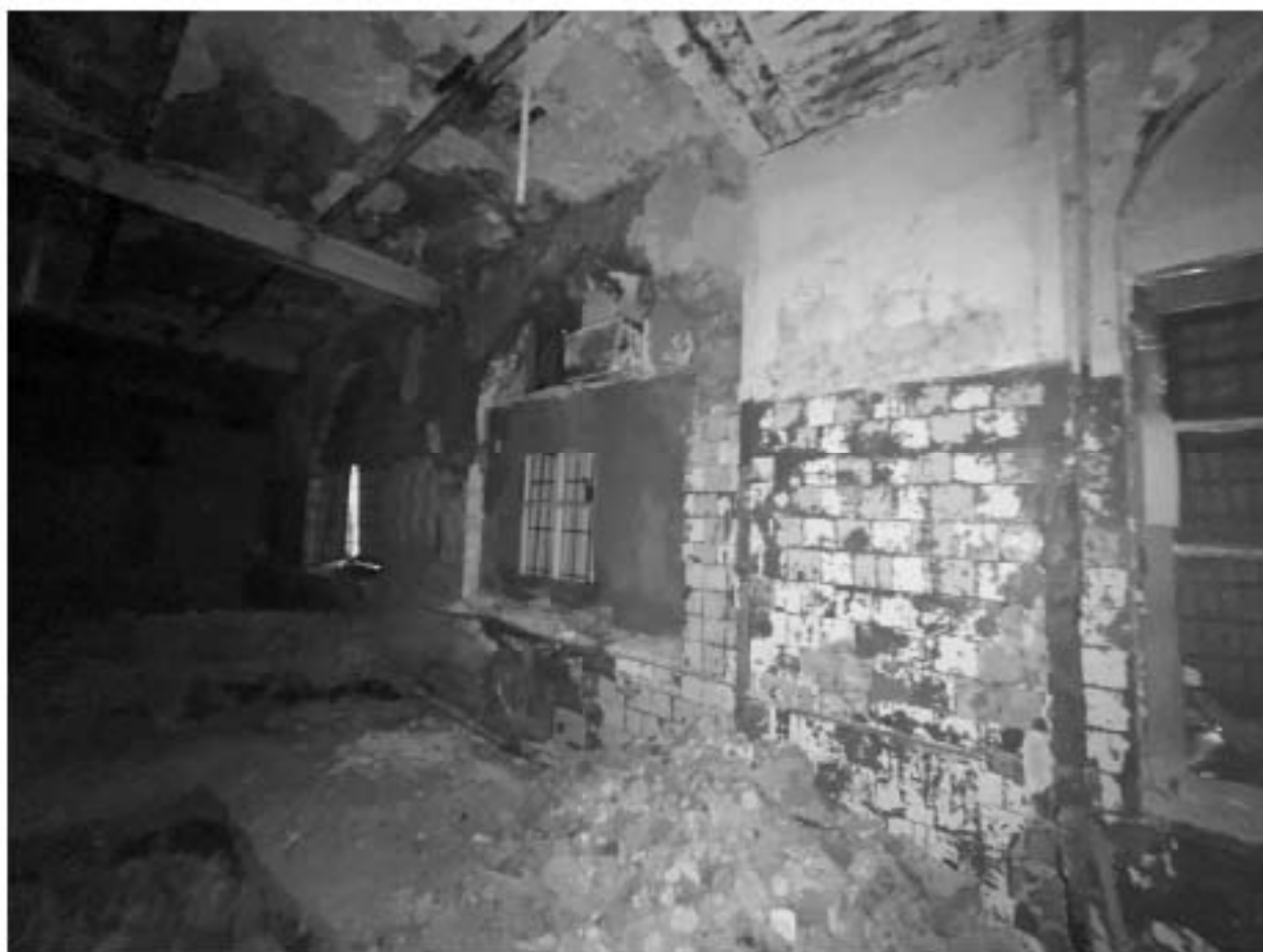
Фото №27. Объект культурного наследия регионального значения «Сельдяной ряд Никольского рынка», подвал, пом. 5-Н (5).
