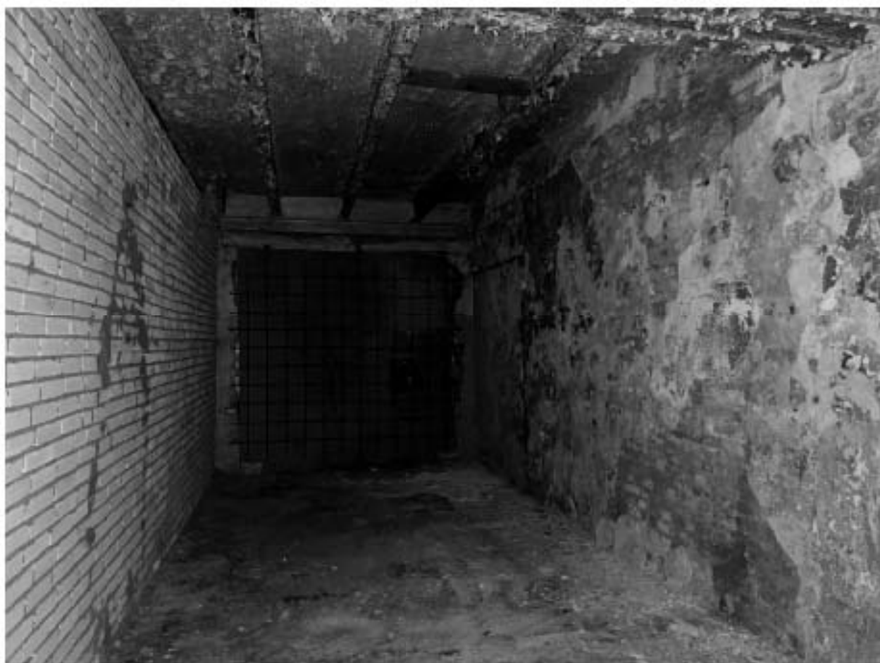
Фото №24. Объект культурного наследия регионального значения «Сельдяной ряд Никольского рынка», подвал, пом. 5-Н (6).
