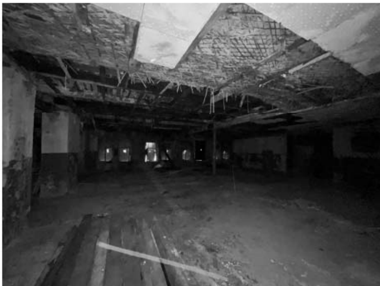
Фото №46. Объект культурного наследия регионального значения «Сельдяной ряд Никольского рынка», помещения третьего этажа.
