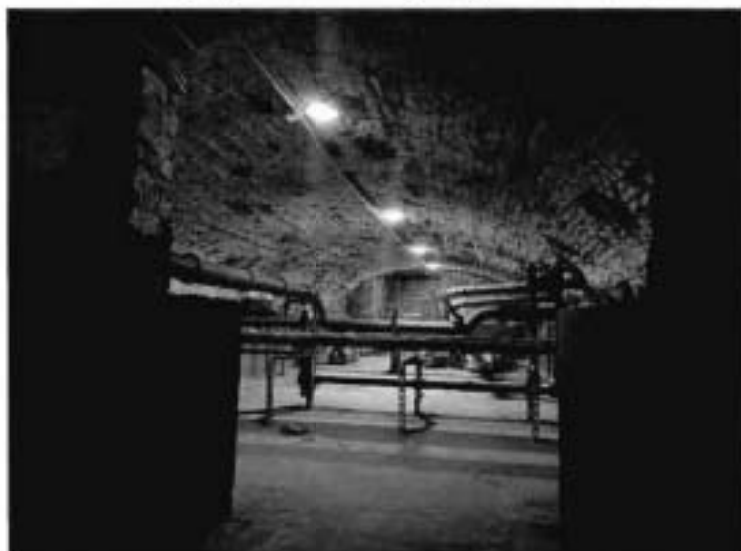
5. Подвалы объекта культурного наследия. Своды.
