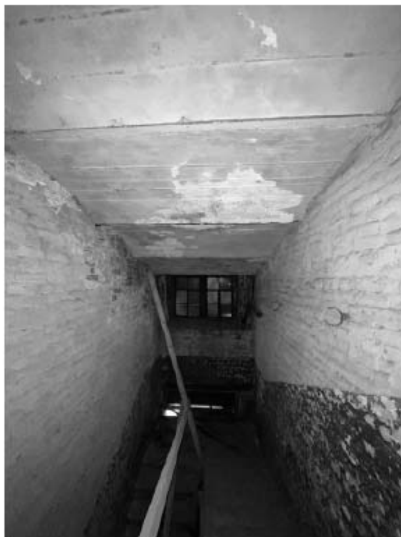
Фото №58. Объект культурного наследия регионального значения «Сельдяной ряд Никольского рынка», помещения мансарды.
