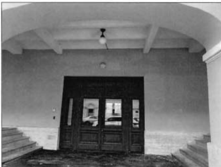
10. Фрагмент южного фасада. Деревянные двери.
