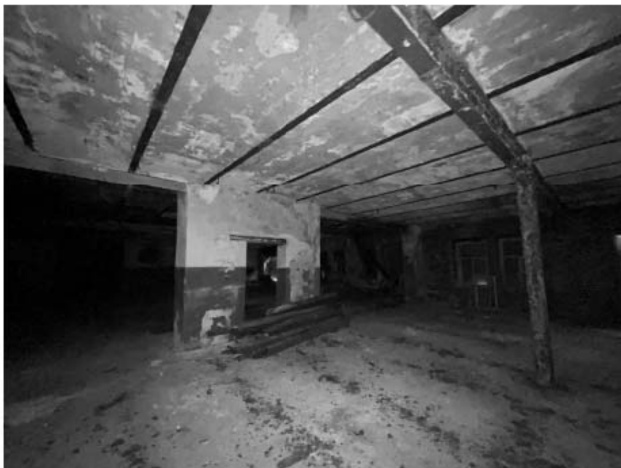
Фото №45. Объект культурного наследия регионального значения «Сельдяной ряд Никольского рынка», помещения третьего этажа.
