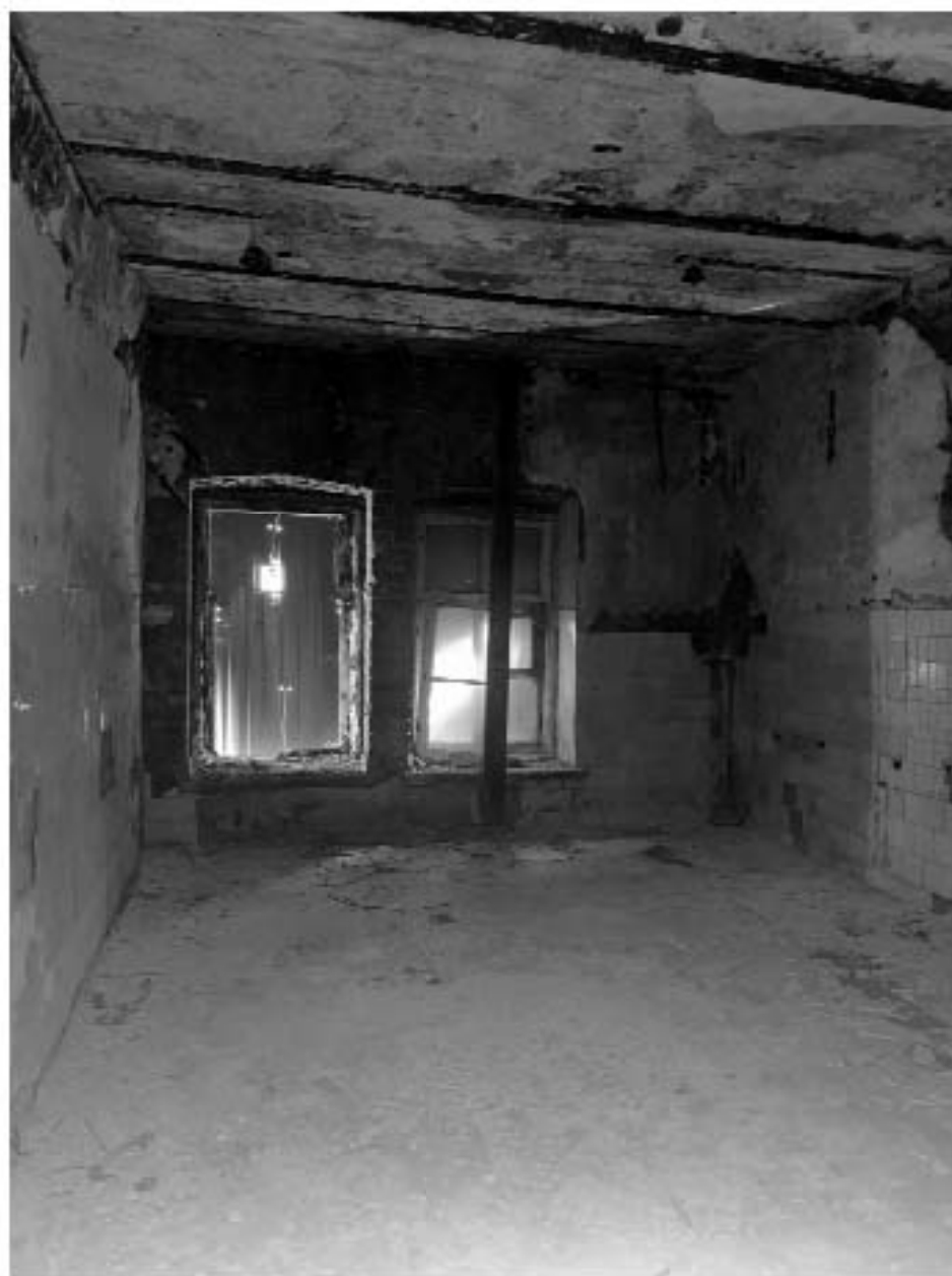
Фото №35. Объект культурного наследия регионального значения «Сельдяной ряд Никольского рынка», помещения второго этажа.
