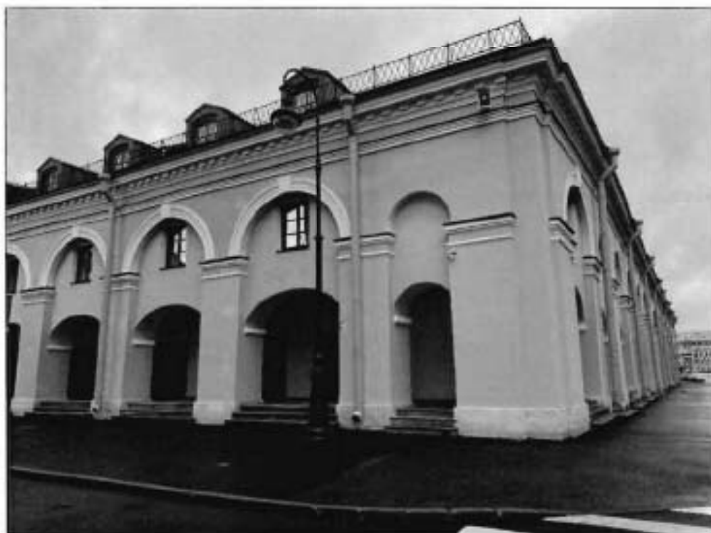
9. Фрагмент объекта культурного наследия Вид со стороны Никольского переулка.
