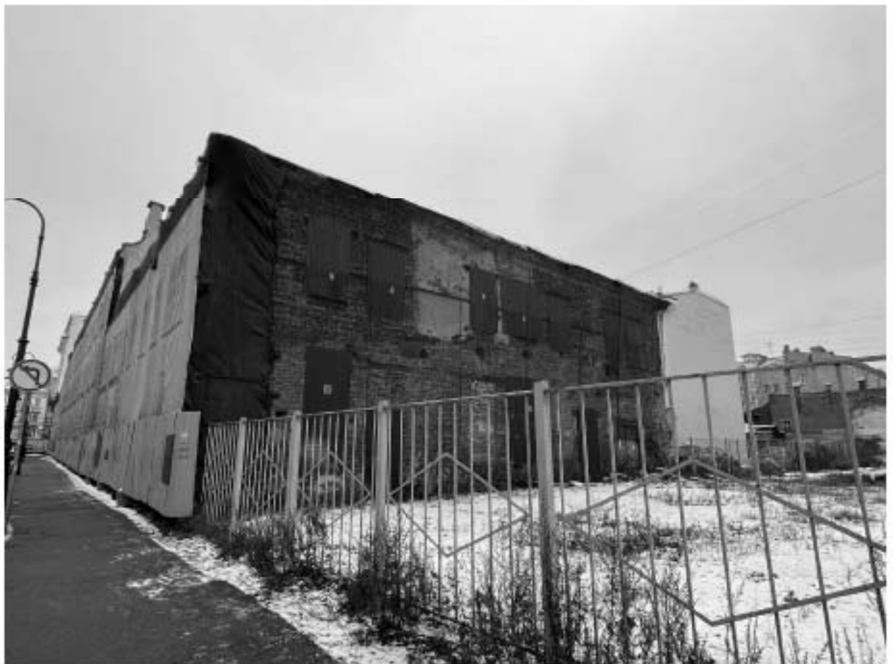
Фото №9. Объект культурного наследия регионального значения «Сельдяной ряд Никольского рынка», юго-западный торцевой фасад (не входит в границы памятника).
