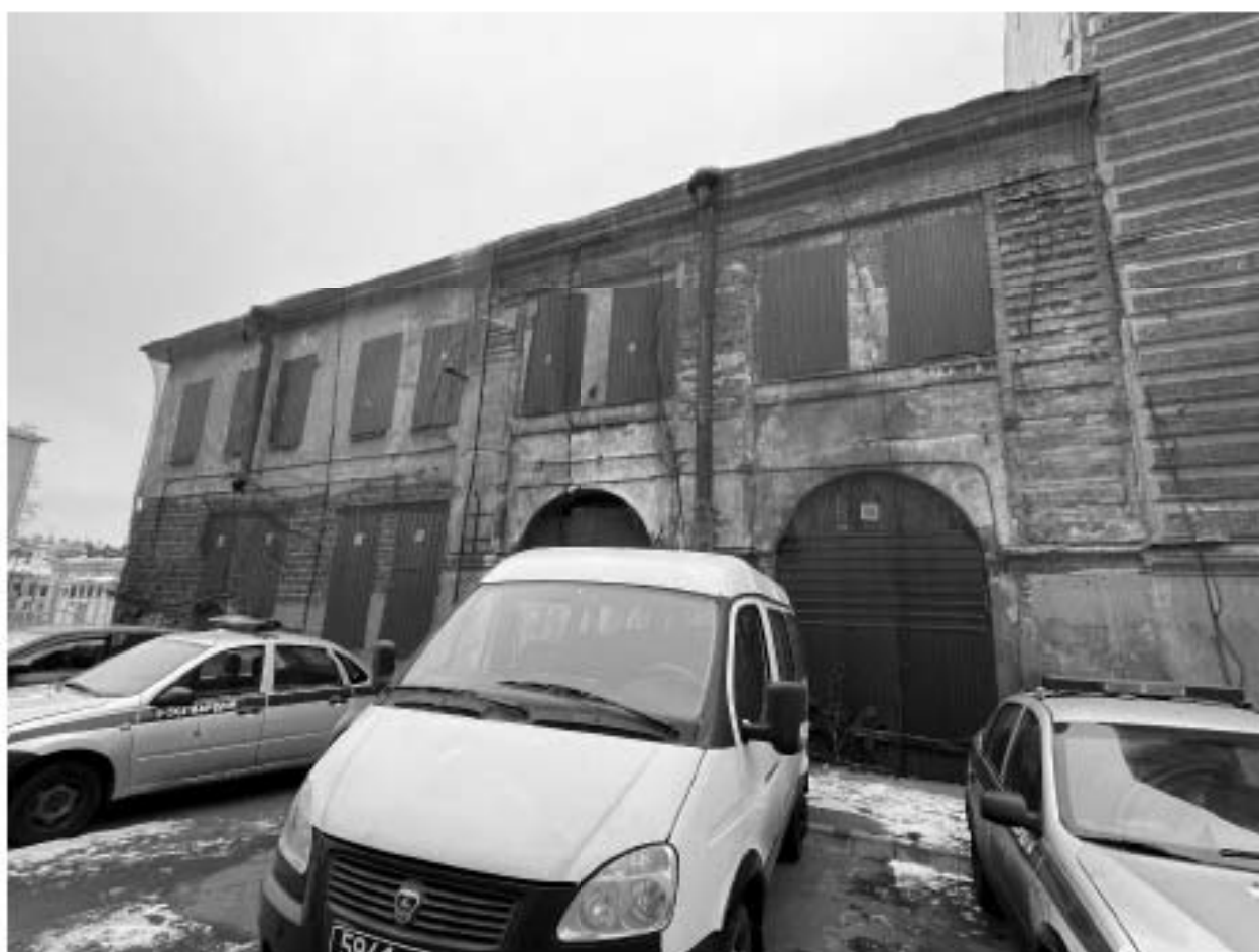
Фото №4. Объект культурного наследия регионального значения «Сельдяной ряд Никольского рынка», юго-западный фасад, двухэтажная западная часть (объем здания на 4 оси слева не входит в границы памятника).
