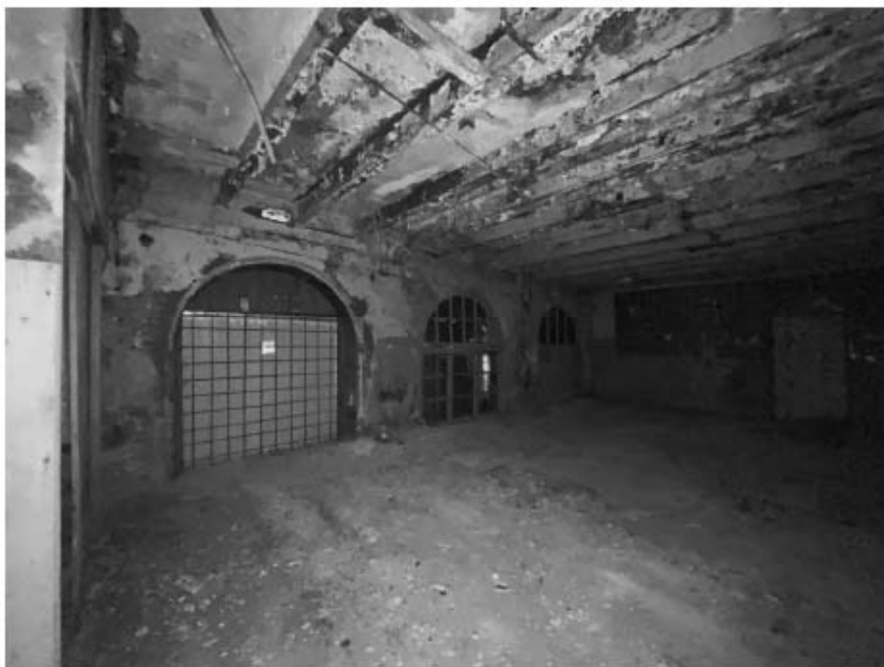
Фото №18. Объект культурного наследия регионального значения «Сельдяной ряд Никольского рынка», подвал, пом. 5-Н.
