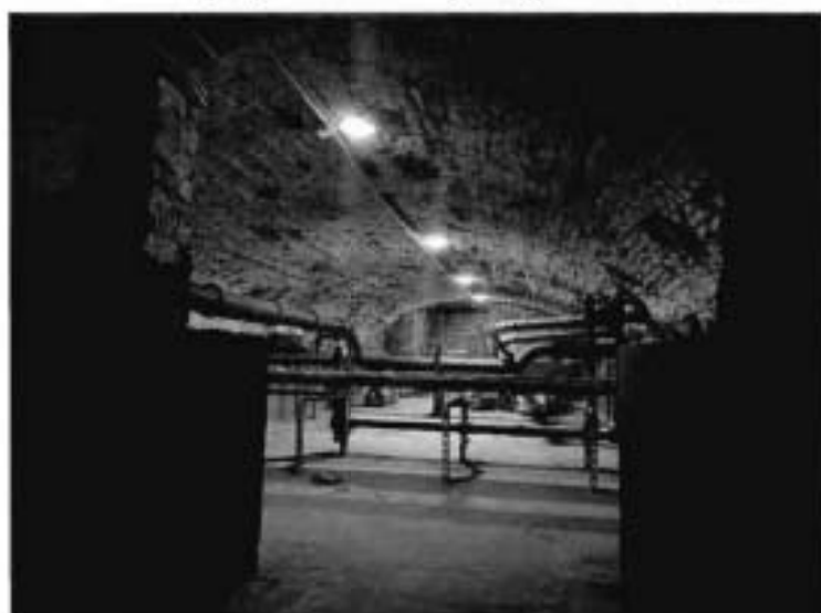
5. Подвалы объекта культурного наследия. Своды.
