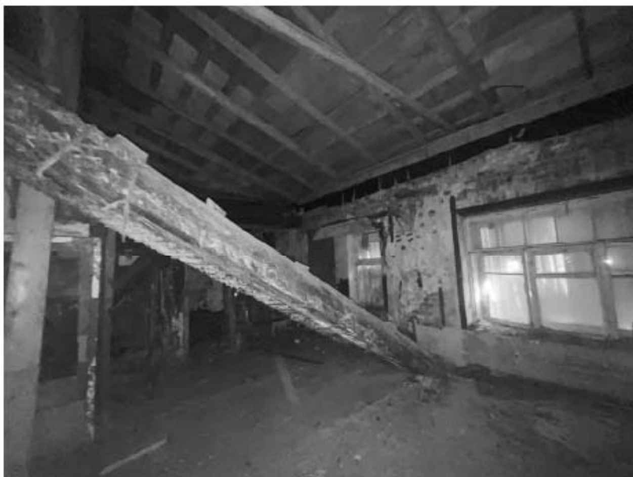
Фото №41. Объект культурного наследия регионального значения «Сельдяной ряд Никольского рынка», помещения второго этажа.
