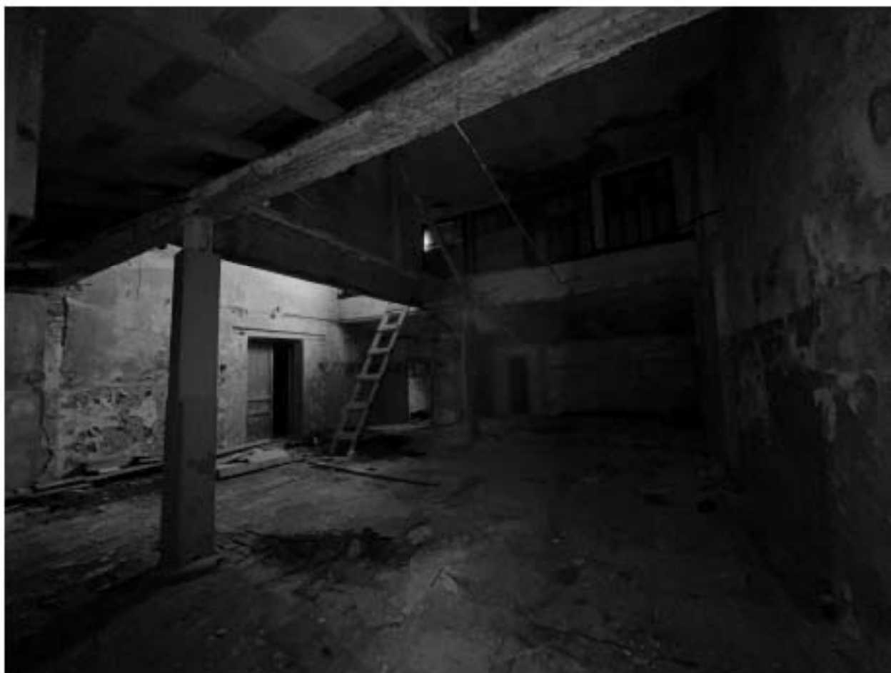
Фото №54. Объект культурного наследия регионального значения «Сельдяной ряд Никольского рынка», помещения мансарды.
