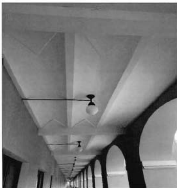
11. Фрагмент обходной галереи вдоль ул. Садовой. Своды
