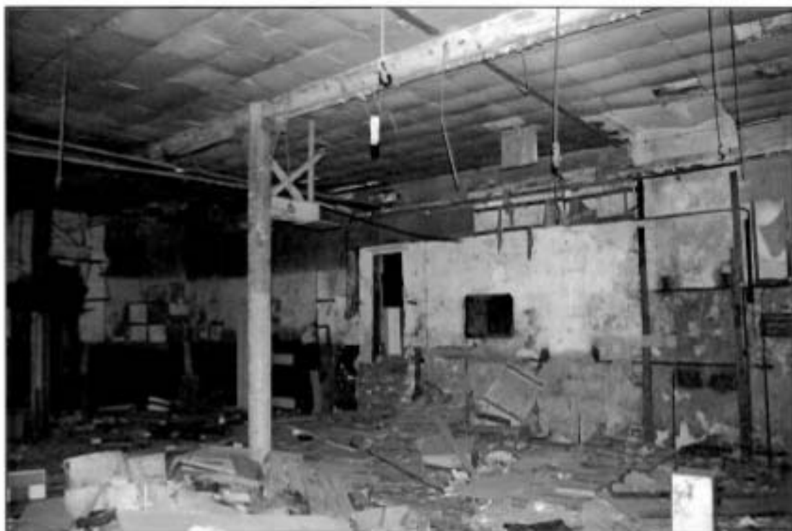
6. Интерьер. Фрагмент. Помещение 2-Н (6).
