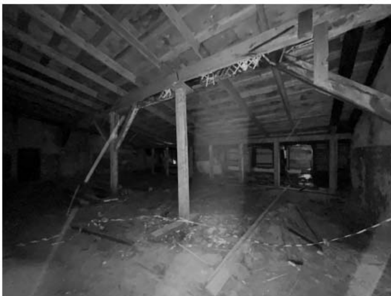
Фото №55. Объект культурного наследия регионального значения «Сельдяной ряд Никольского рынка», помещения мансарды.
