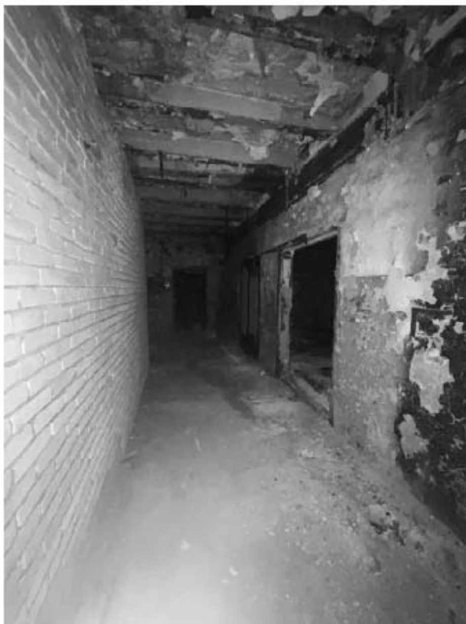
Фото №22. Объект культурного наследия регионального значения «Сельдяной ряд Никольского рынка», подвал, пом. 5-Н (3).
