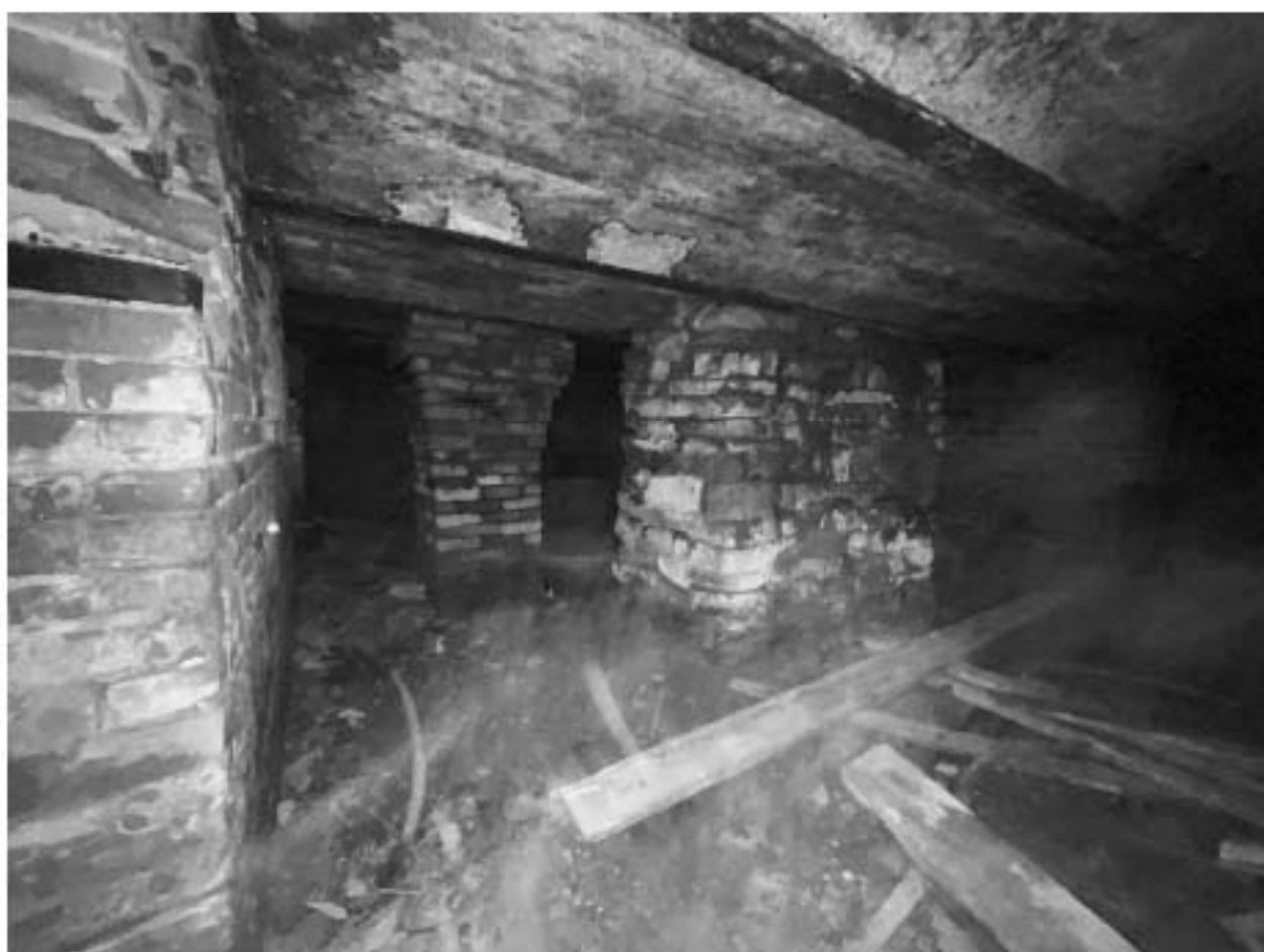
Фото №15. Объект культурного наследия регионального значения «Сельдяной ряд Никольского рынка», подвал, пом. 4-Н (2).
