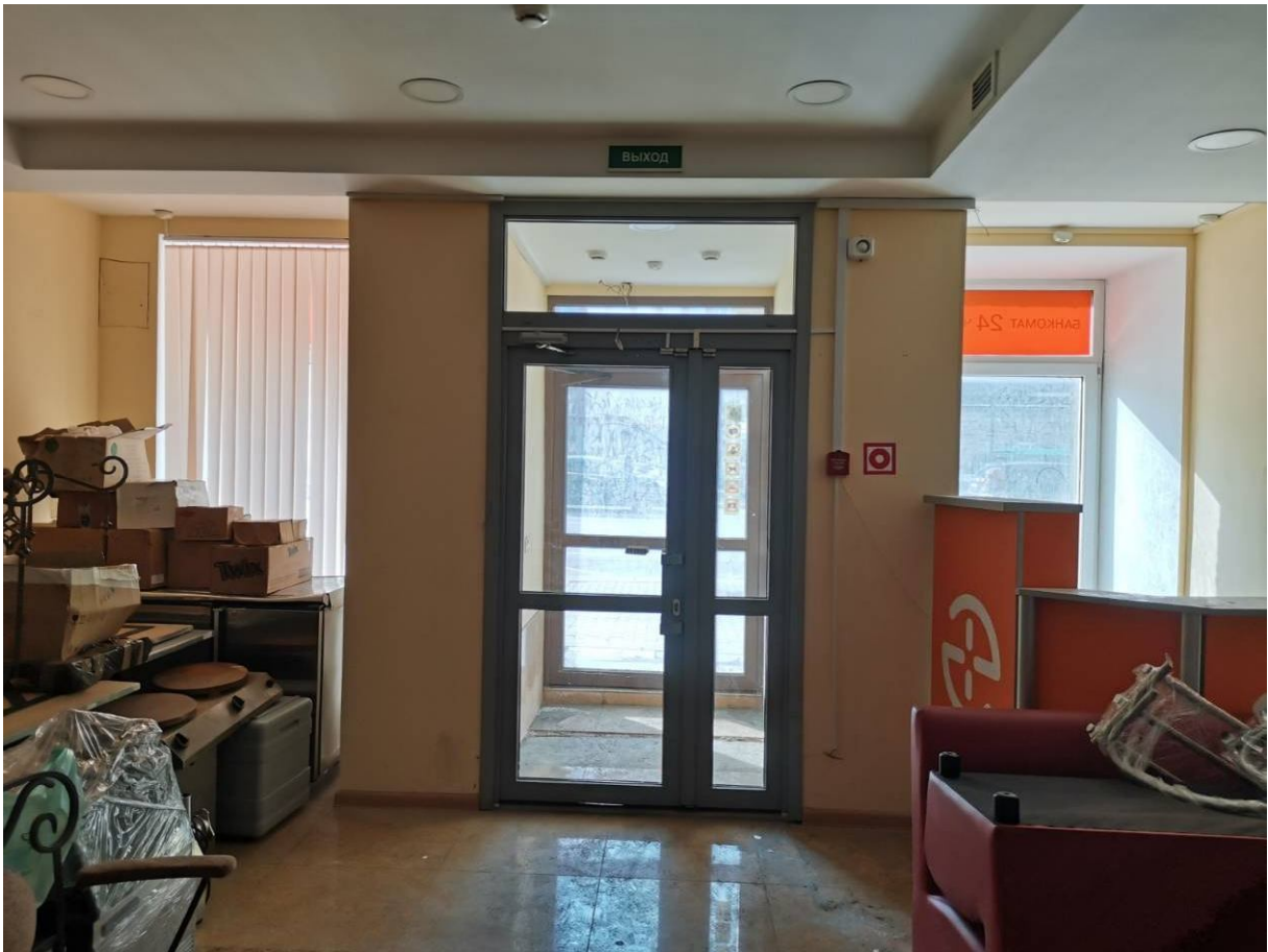
9. Вид на вход в пом. 6-Н со стороны Московского проспекта.
