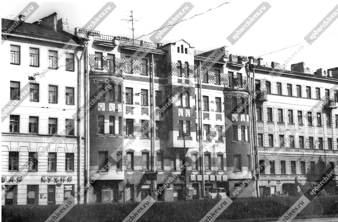
27. Общий вид фасада жилого дома № 126 на Московском проспекте (бывший доходный дом Мальцева, архитектор С.А.Баранкеев, 1910 г. Фотография 1993 г. ЦГАКФФД СПб Ар 224580.
