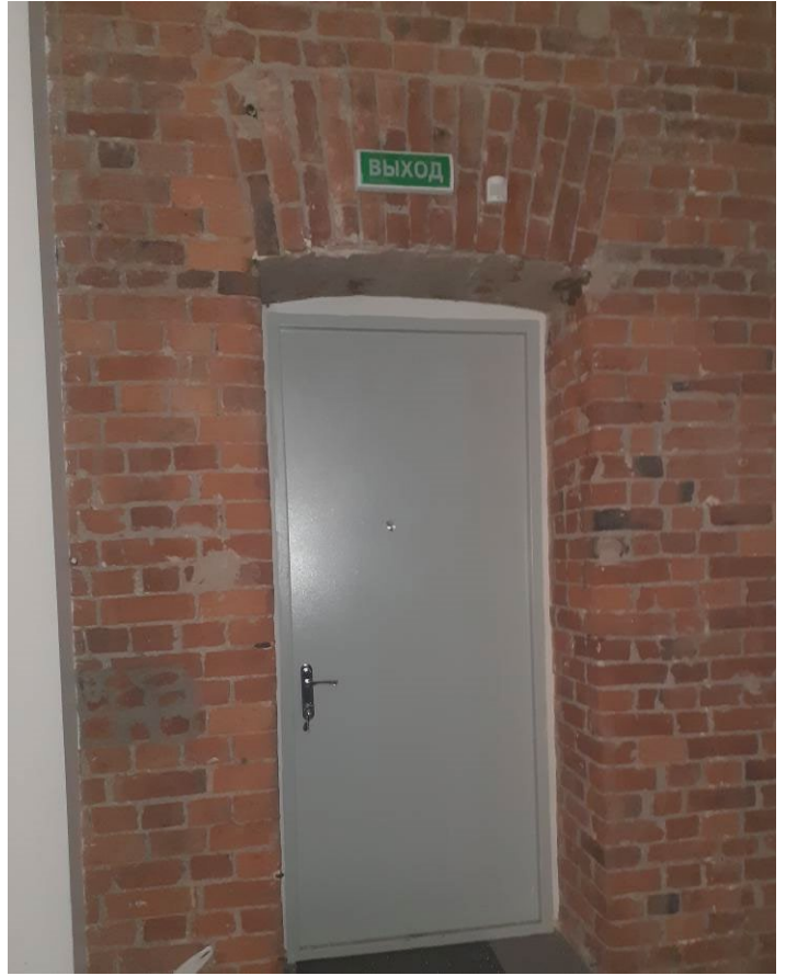
Фото 6. Входная дверь со стороны помещения 2-Н.
