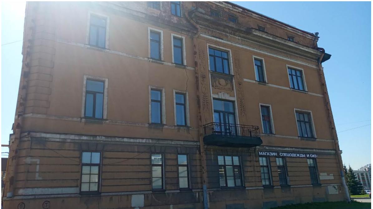
Фото 3. Общий вид бокового северо-западного фасада здания.
