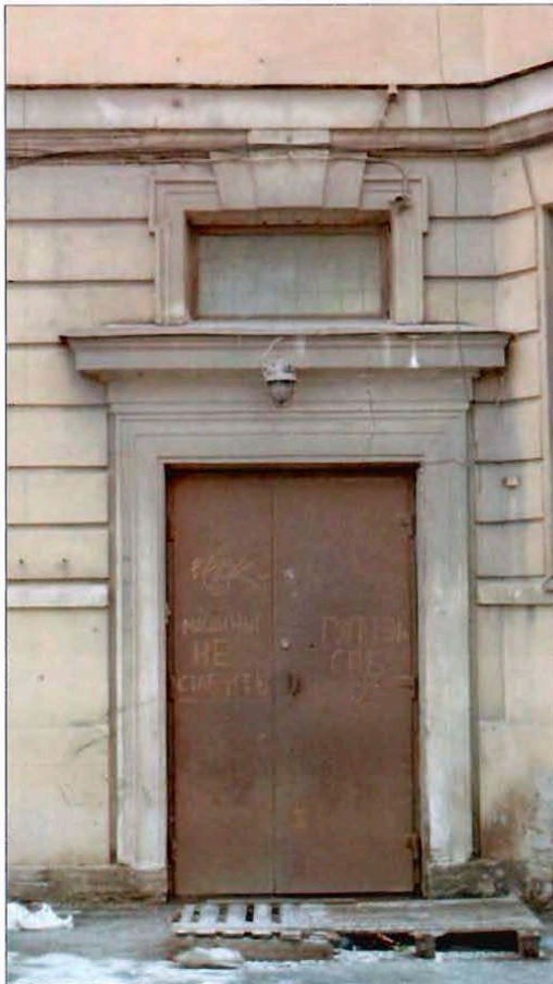
6. Оформление дверного проема. Юго-восточный фасад. Фрагмент.
