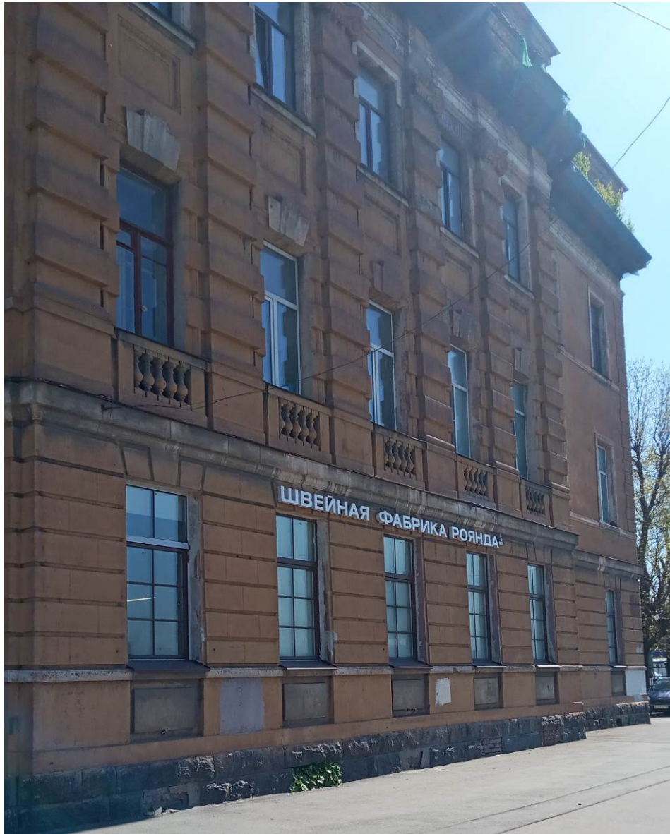
Фото 4. Общий вид лицевого юго-западного фасада здания.
