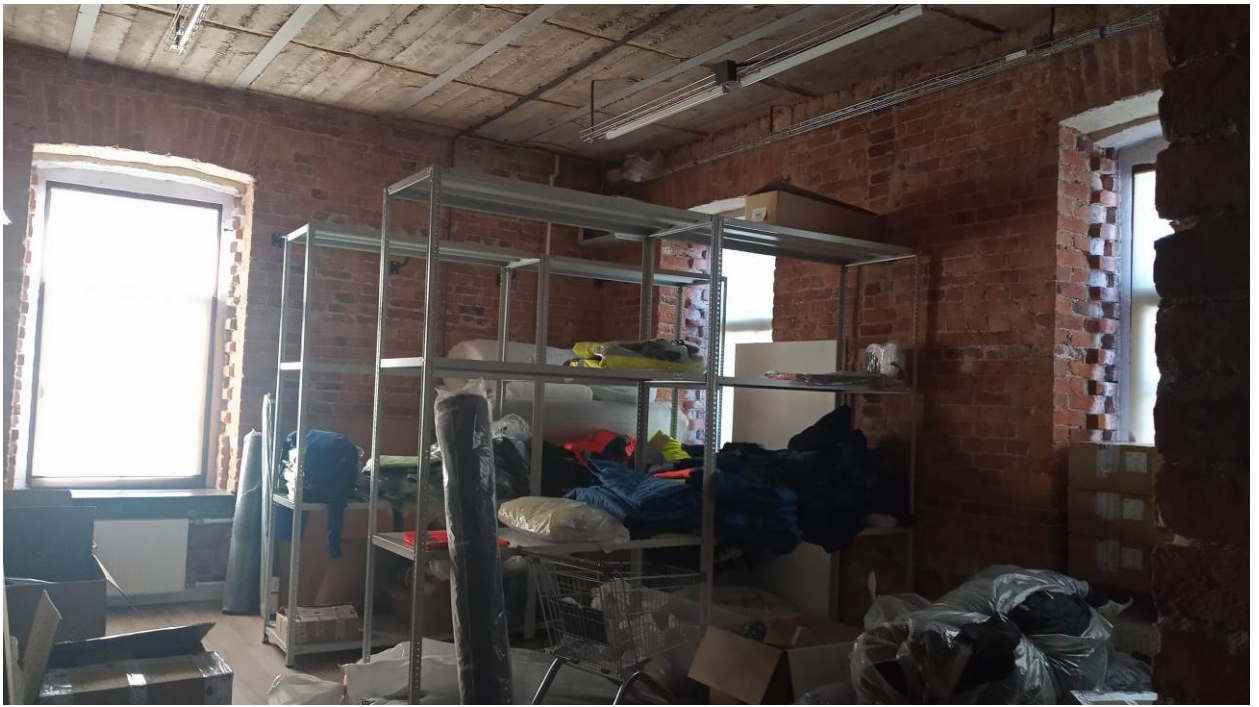
Фото 12. Оконные проемы комнат 23 и 28 в помещении 2-Н.
