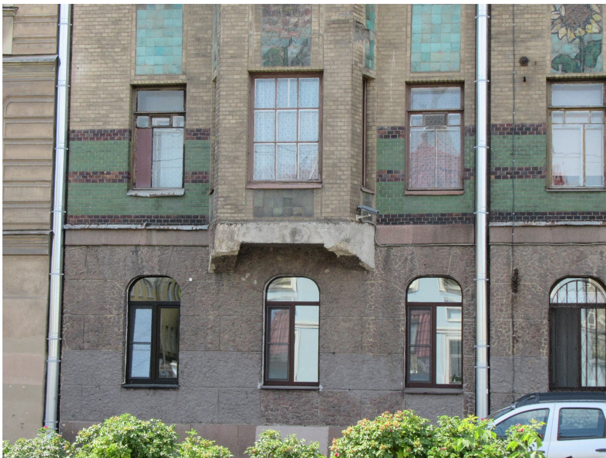
27. 15-я линия В.О., 70. Дом М.М. Кудрявцева. Нижняя часть южного эркера лицевого фасада.
