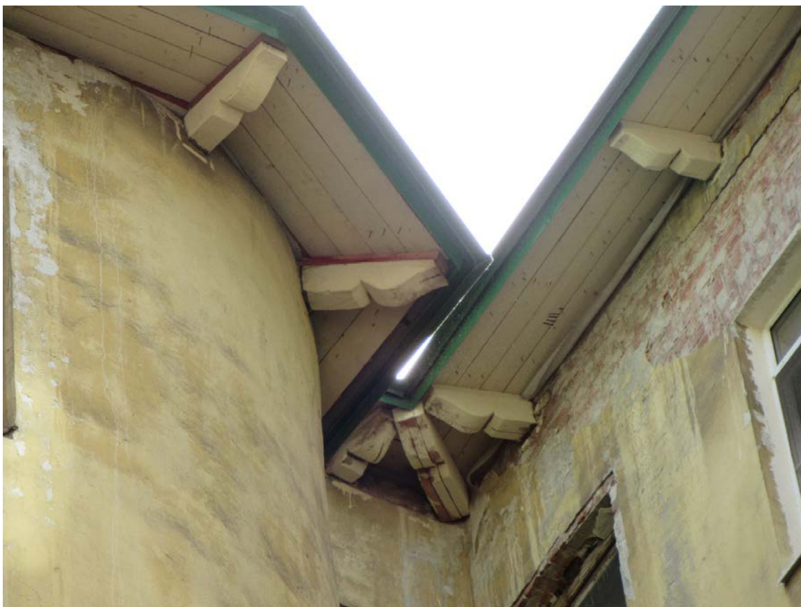
33. 15-я линия В.О., 70. Дом М.М. Кудрявцева. Фрагмент свесов кровли с деревянной подшивкой на кобылках восточного двора.
