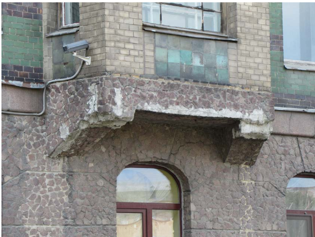
23. 15-я линия В.О., 70. Дом М.М. Кудрявцева. Нижняя часть северного эркера лицевого фасада.
