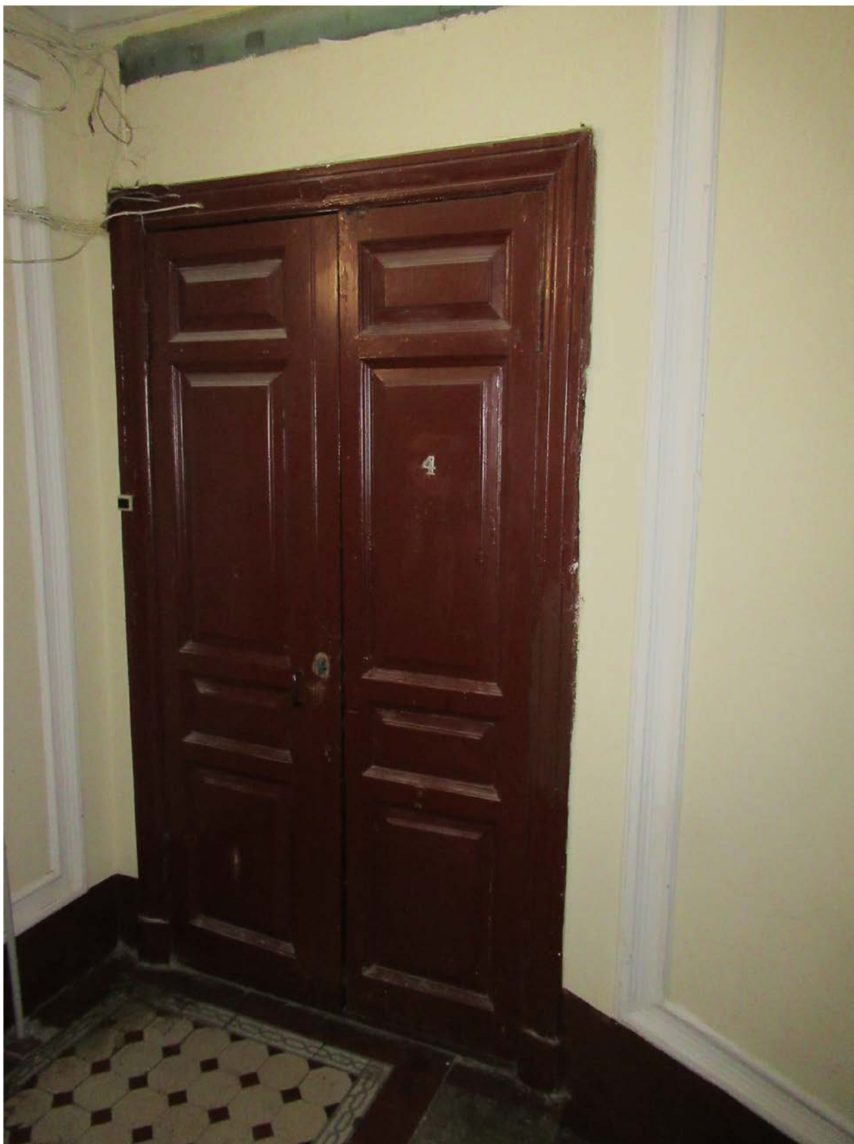
66. 15-я линия В.О., 70. Дом М.М. Кудрявцева. 1ЛК (парадная лестница). Дверной проем квартиры с историческим деревянным заполнением.
