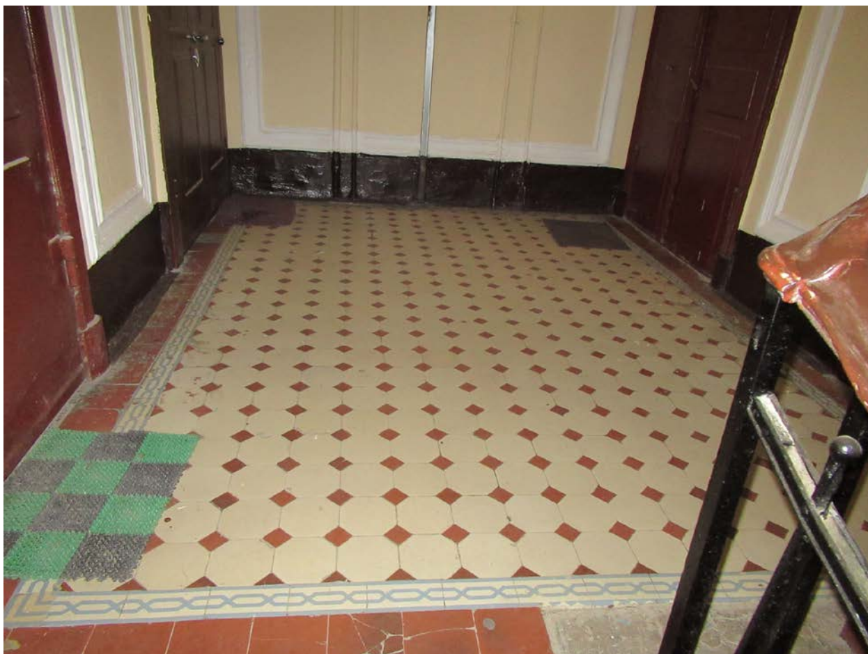
70. 15-я линия В.О., 70. Дом М.М. Кудрявцева. 4ЛК, площадка с покрытием пола метлахской плиткой.
