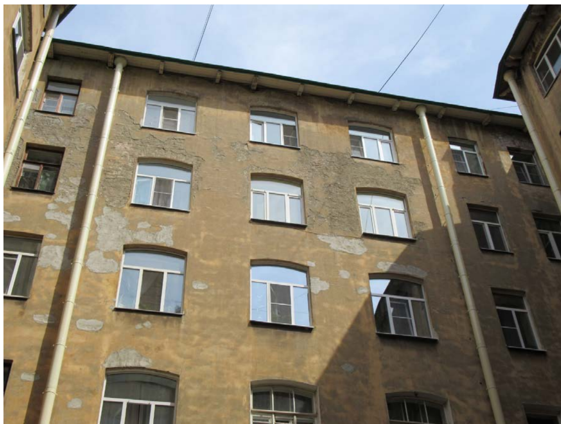
51. 15-я линия В.О., 70. Дом М.М. Кудрявцева. Верхняя часть северо-восточного фасада западного двора.
