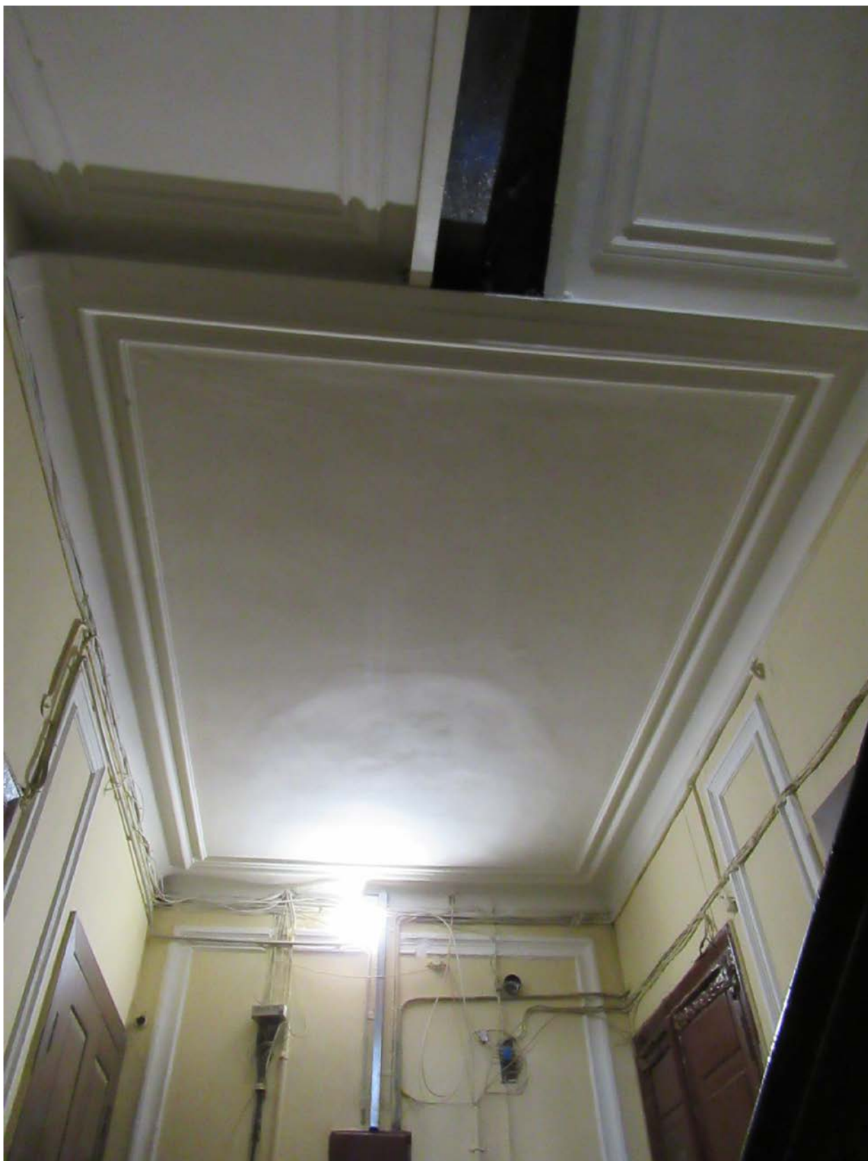
71. 15-я линия В.О., 70. Дом М.М. Кудрявцева. 4ЛК, потолок лестничной площадки.
