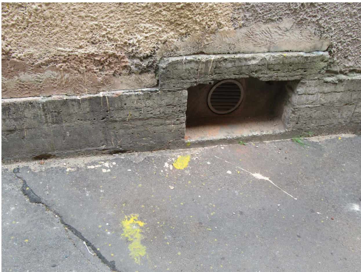
54. 15-я линия В.О., 70. Дом М.М. Кудрявцева. Фрагмент отделки цоколя юго-западного фасада.
