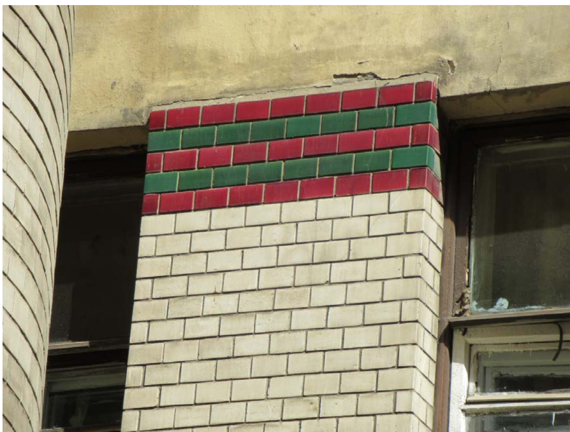
41. 15-я линия В.О., 70. Дом М.М. Кудрявцева. Фрагмент отделки стены восточного двора облицовочной плиткой и штукатуркой.
