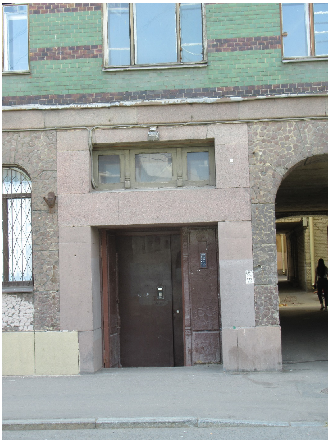
10. 15-я линия В.О., 70. Дом М.М. Кудрявцева. Входной проем лицевого фасада.
