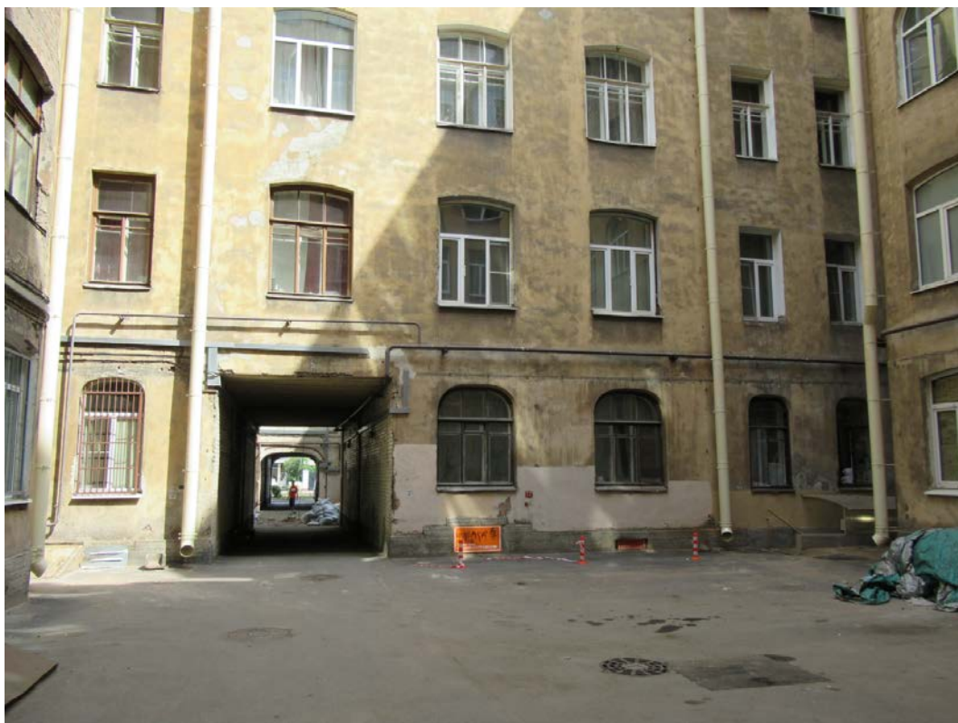
50. 15-я линия В.О., 70. Дом М.М. Кудрявцева. Нижняя часть северо-восточного фасада западного двора.
