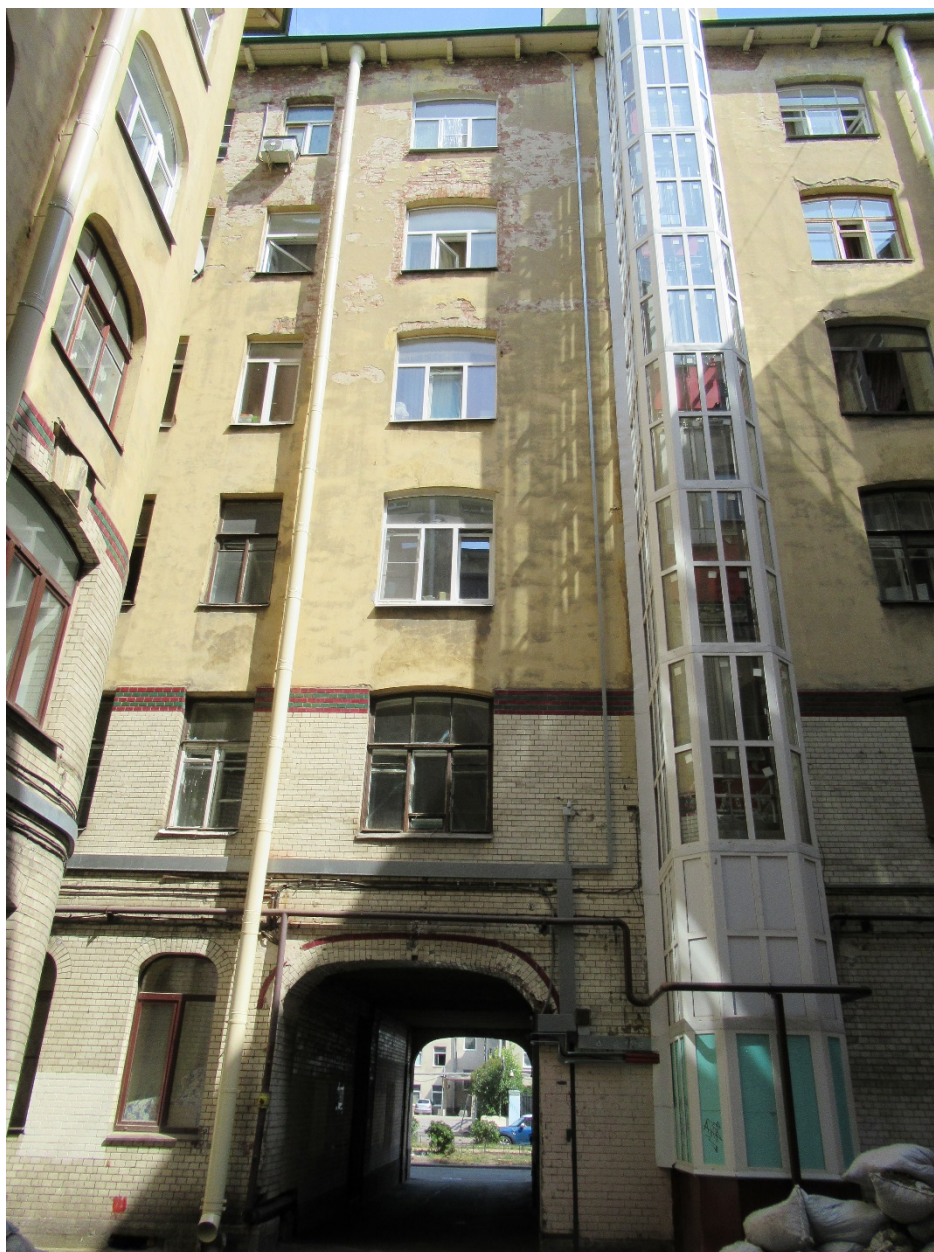
39. 15-я линия В.О., 70. Дом М.М. Кудрявцева. Северо-восточный фасад восточного двора.
