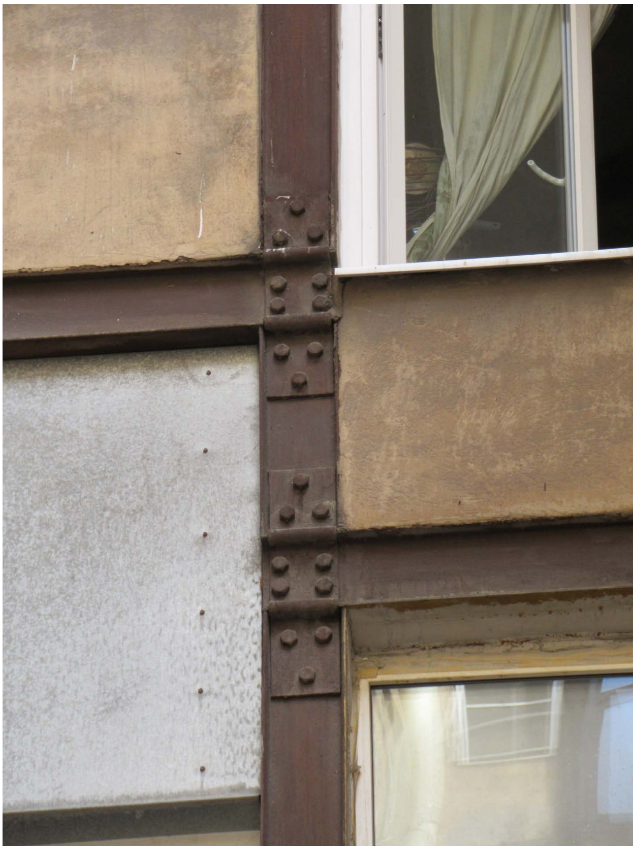
47. 15-я линия В.О., 70. Дом М.М. Кудрявцева. Выпущенные двутавровые металлические балки юго-западного угла западного двора.
