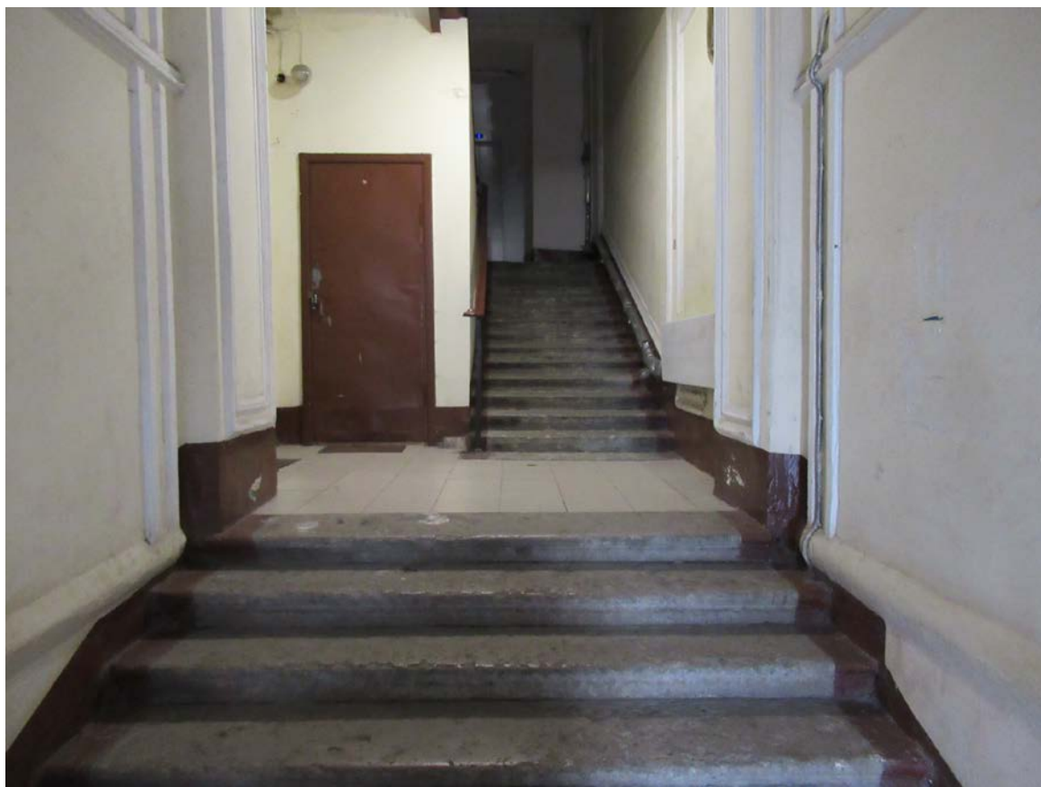
58. 15-я линия В.О., 70. Дом М.М. Кудрявцева. 1ЛК (парадная лестница). Вид на лестницу из вестибюля.
