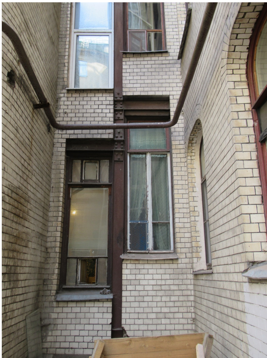
38. 15-я линия В.О., 70. Дом М.М. Кудрявцева. Выпущенные двутавровые металлические балки в юго-западном углу восточного двора.
