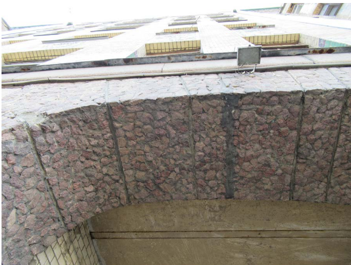
19. 15-я линия В.О., 70. Дом М.М. Кудрявцева. Фрагмент отделки воротного проезда со стороны лицевого фасада.
