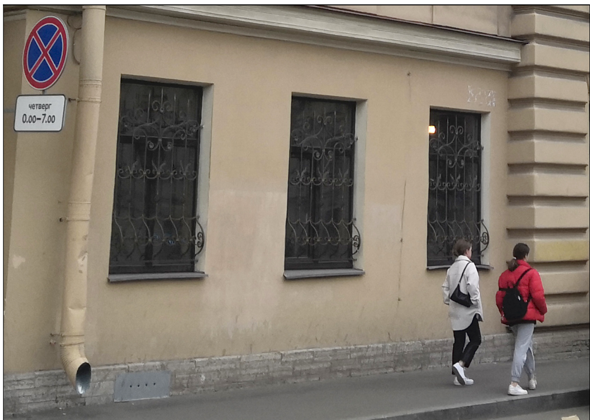
4. Дом В.А. Ратькова-Рожнова. Фрагменты лицевых фасадов здания по Казначейской улице и по набережной канала Грибоедова: окна квартиры № 63.
