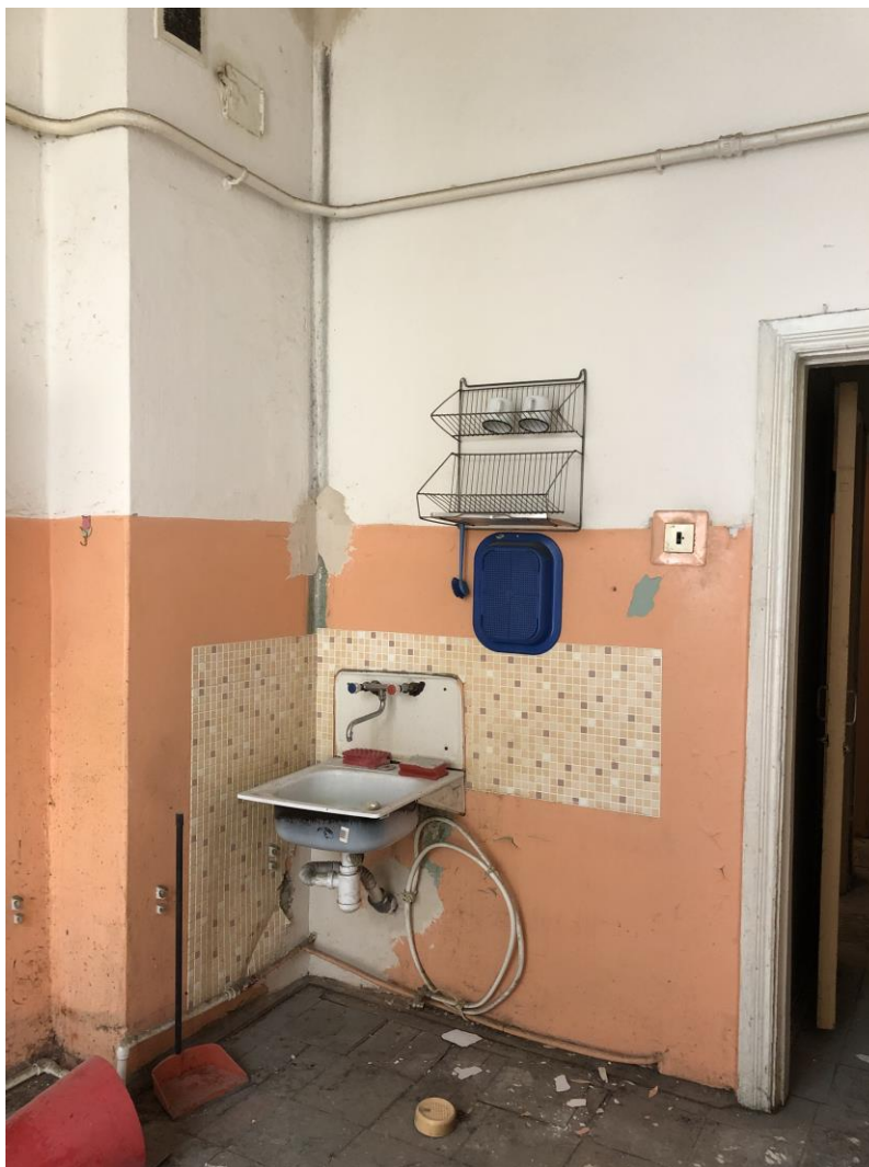
19. Объект культурного наследия федерального значения «Дом Демидова П.Г.», входящий в состав объекта культурного наследия федерального значения «Усадьба Демидовых» по адресу: г. Санкт-Петербург, пер. Гривцова, д. 5, лит. А (Гривцова пер., 1). Квартира №28. Кухня (помещение №5 согласно техническому паспорту). Фрагмент интерьера.
