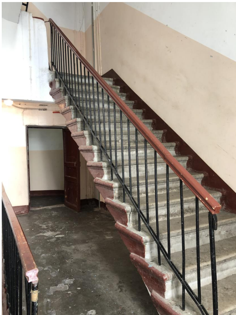
5. Объект культурного наследия федерального значения «Дом Демидова П.Г.», входящий в состав объекта культурного наследия федерального значения «Усадьба Демидовых» по адресу: г. Санкт-Петербург, пер. Гривцова, д. 5, лит. А (Гривцова пер., 1). Лестничная клетка. Общий вид.
