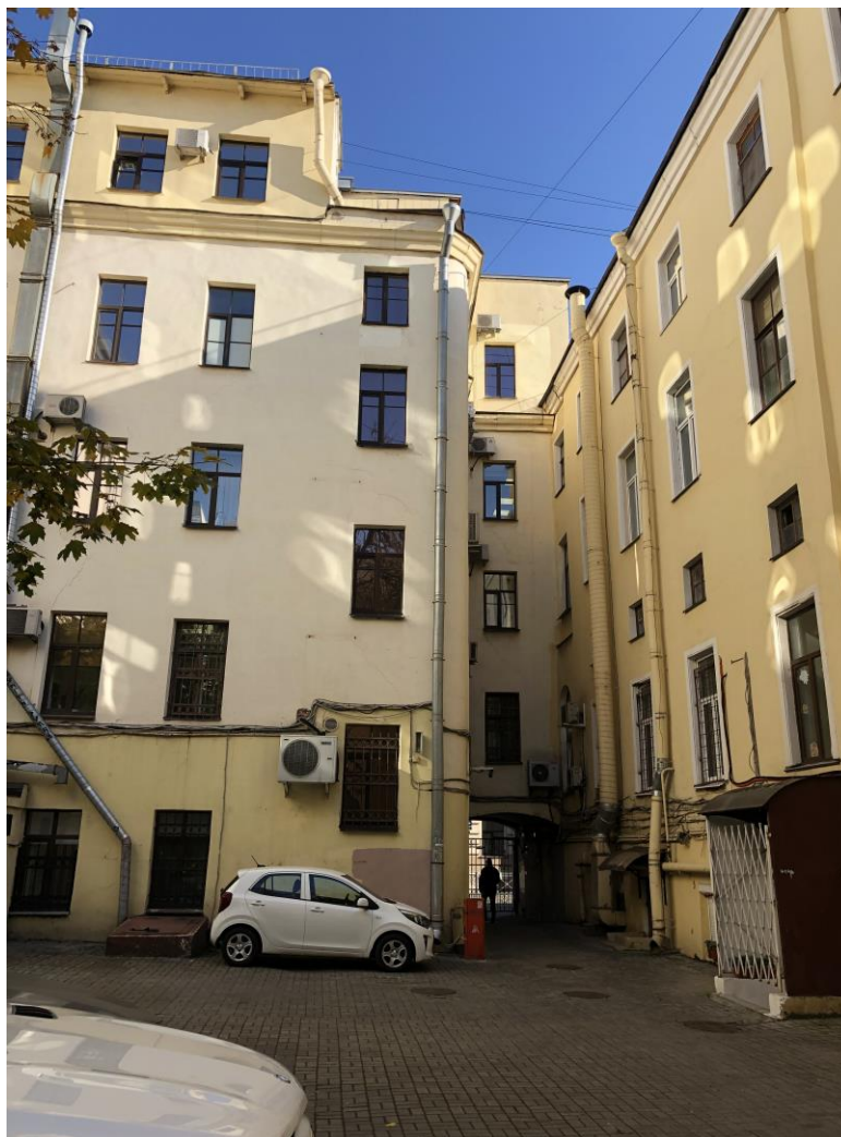
4. Объект культурного наследия федерального значения «Дом Демидова П.Г.», входящий в состав объекта культурного наследия федерального значения «Усадьба Демидовых» по адресу: г. Санкт-Петербург, пер. Гривцова, д. 5, лит. А (Гривцова пер., 1). Дворовые фасады. Общий вид.
