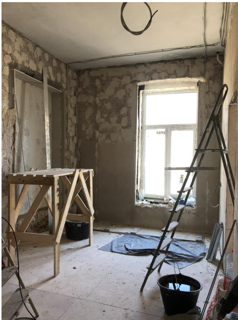
15. Объект культурного наследия федерального значения «Дом Демидова П.Г.», входящий в состав объекта культурного наследия федерального значения «Усадьба Демидовых» по адресу: г. Санкт-Петербург, пер. Гривцова, д. 5, лит. А (Гривцова пер., 1). Квартира №28. Жилая комната Жилая комната (помещение №8 (комната) согласно техническому паспорту). Общий вид.
