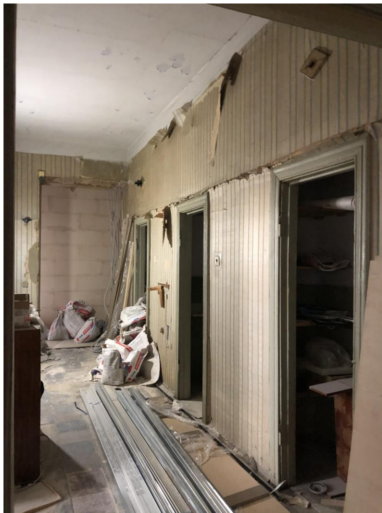
9. Объект культурного наследия федерального значения «Дом Демидова П.Г.», входящий в состав объекта культурного наследия федерального значения «Усадьба Демидовых» по адресу: г. Санкт-Петербург, пер. Гривцова, д. 5, лит. А (Гривцова пер., 1). Квартира №28. Коридор (помещение №2 согласно техническому паспорту). Общий вид со стороны входа в квартиру.
