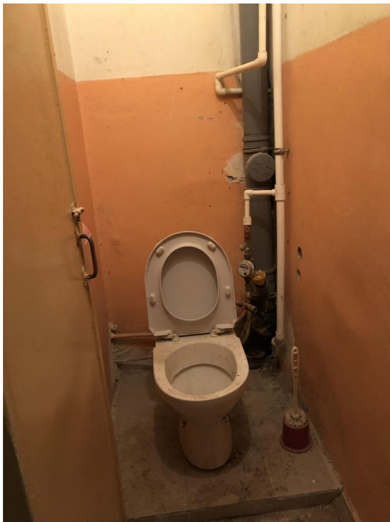
21. Объект культурного наследия федерального значения «Дом Демидова П.Г.», входящий в состав объекта культурного наследия федерального значения «Усадьба Демидовых» по адресу: г. Санкт-Петербург, пер. Гривцова, д. 5, лит. А (Гривцова пер., 1). Квартира №28. Туалет (помещение №7 согласно техническому паспорту). Общий вид.
