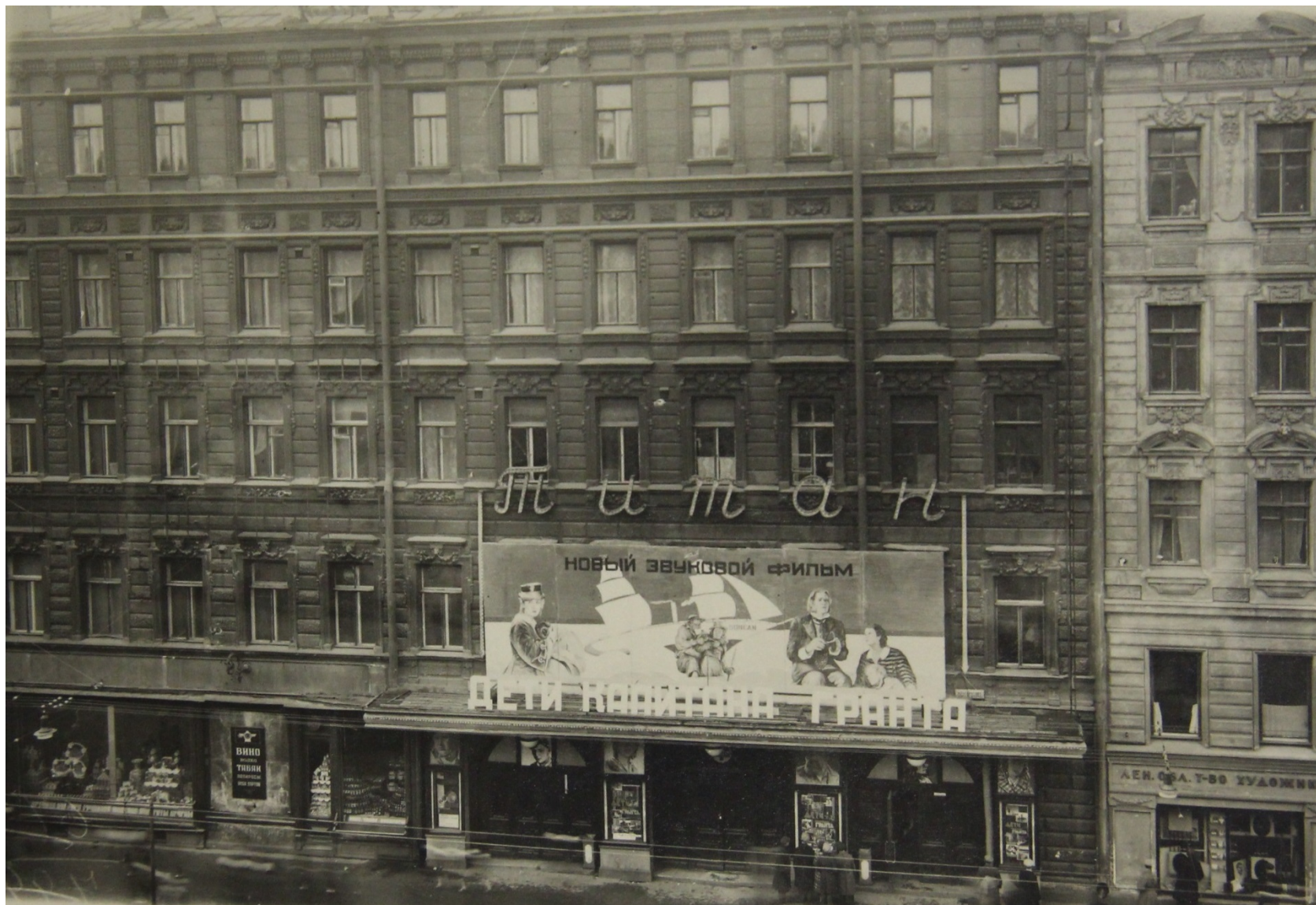
12. Наружный вид здания кинотеатра «Титан». 1936 г. // ЦГА КФФД. Шифр: Гр. 54609.
