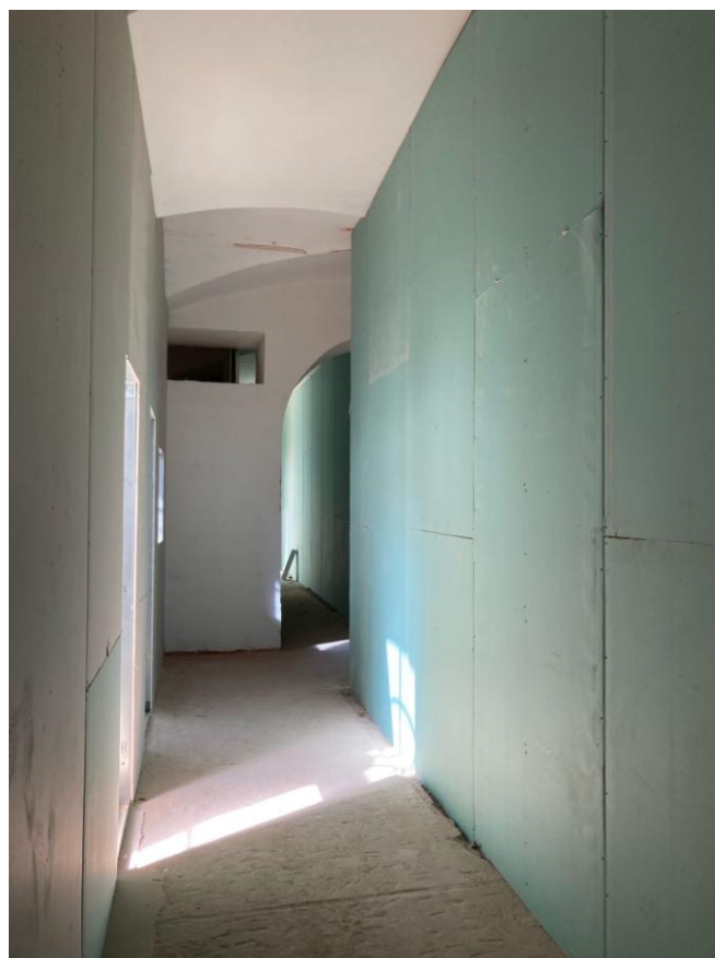
Фото 35. Интерьер объекта культурного наследия федерального значения «Казармы(Трехэскадронный корпус)», пом. 7-Н
