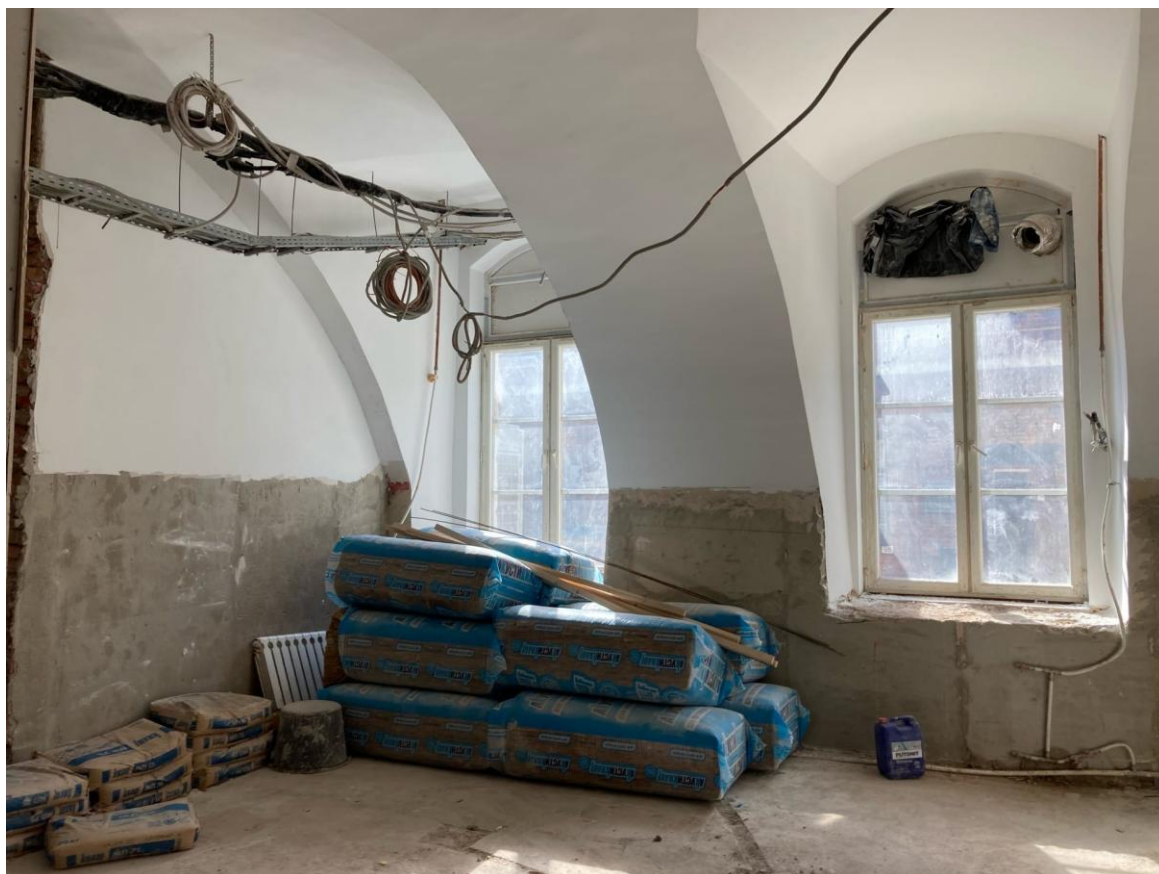
Фото 22. Интерьер объекта культурного наследия федерального значения «Казармы(Трехэскадронный корпус)», пом. 6-Н
