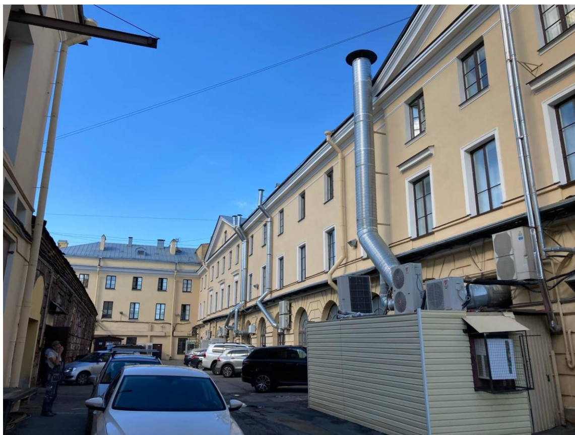
Фото 14. Фрагмент дворового фасада объекта культурного наследия федерального значения «Казармы(Трехэскадронный корпус)»
