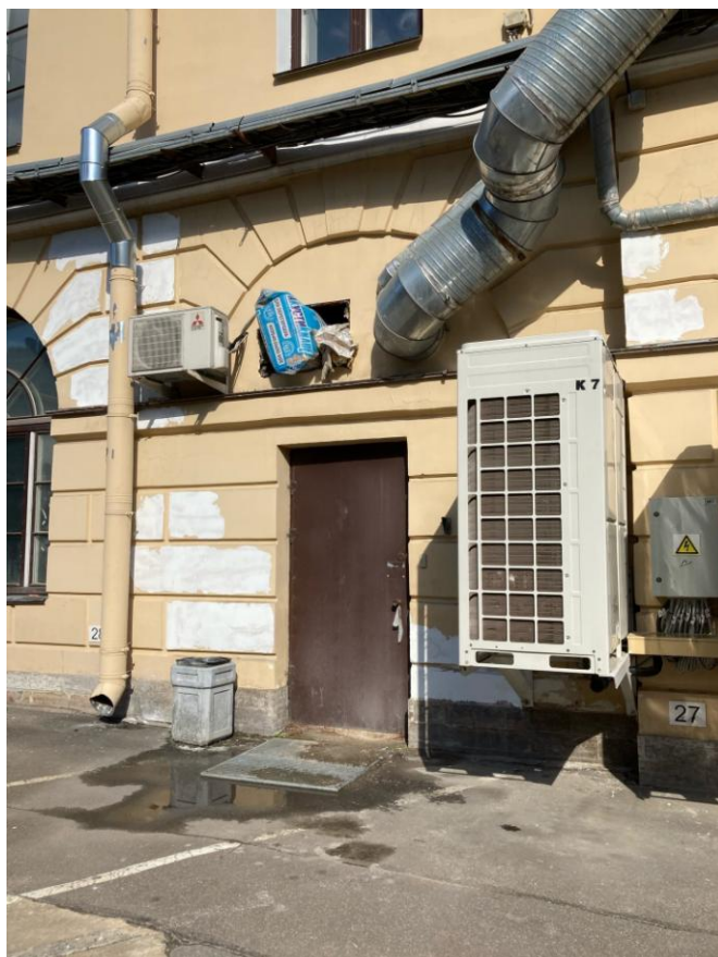
Фото 17. Фрагмент дворового фасада объекта культурного наследия федерального значения «Казармы(Трехэскадронный корпус)», вход в пом. 7-Н
