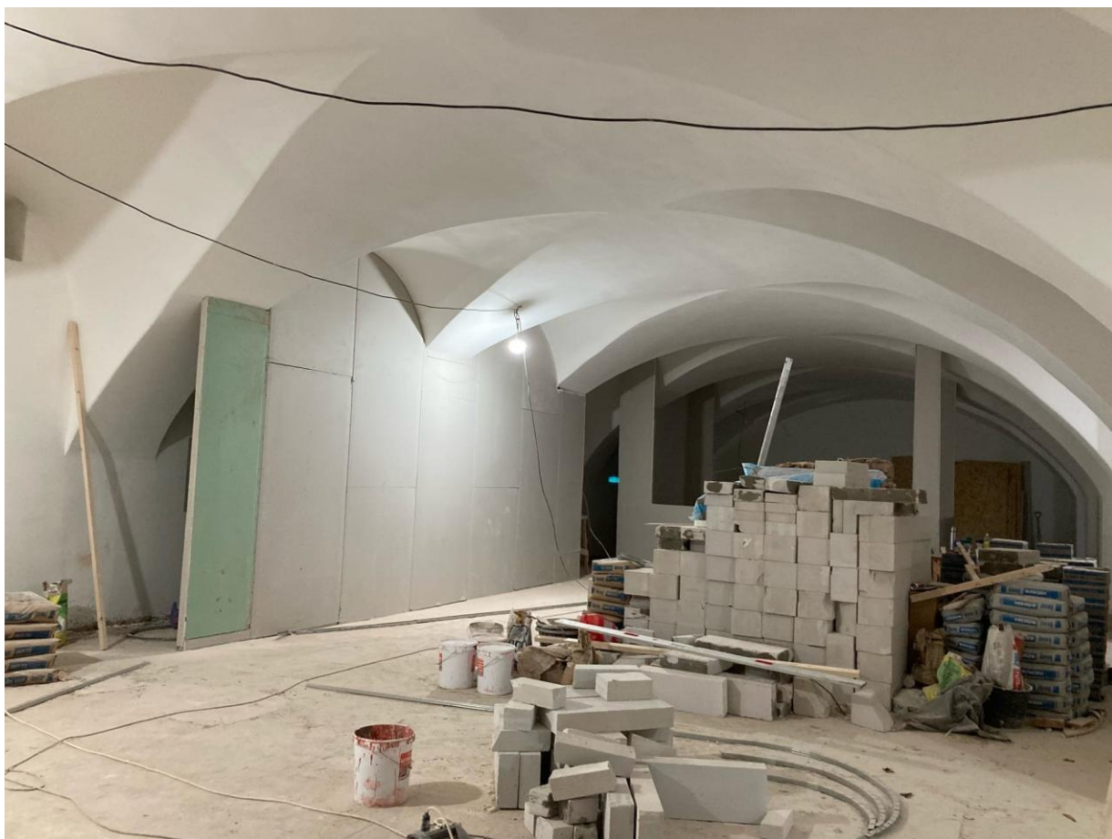
Фото 25. Интерьер объекта культурного наследия федерального значения «Казармы(Трехэскадронный корпус)», пом. 7-Н
