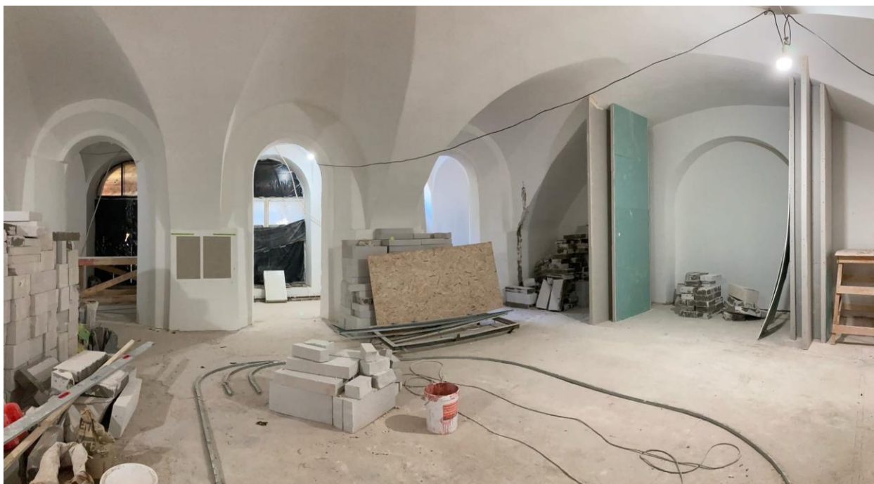
Фото 26. Интерьер объекта культурного наследия федерального значения «Казармы(Трехэскадронный корпус)», пом. 7-Н
