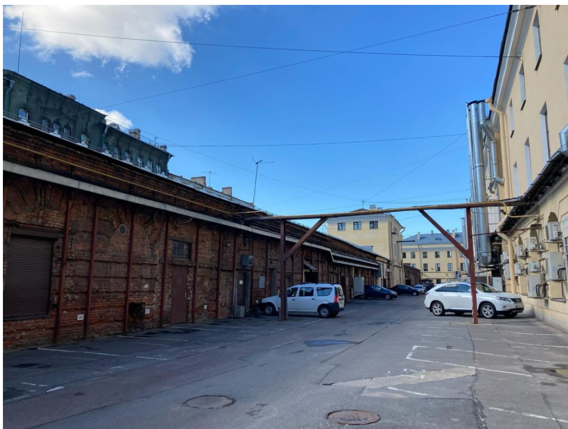
Фото 18. Фрагмент дворового фасада объекта культурного наследия федерального значения «Казармы(Трехэскадронный корпус)»
