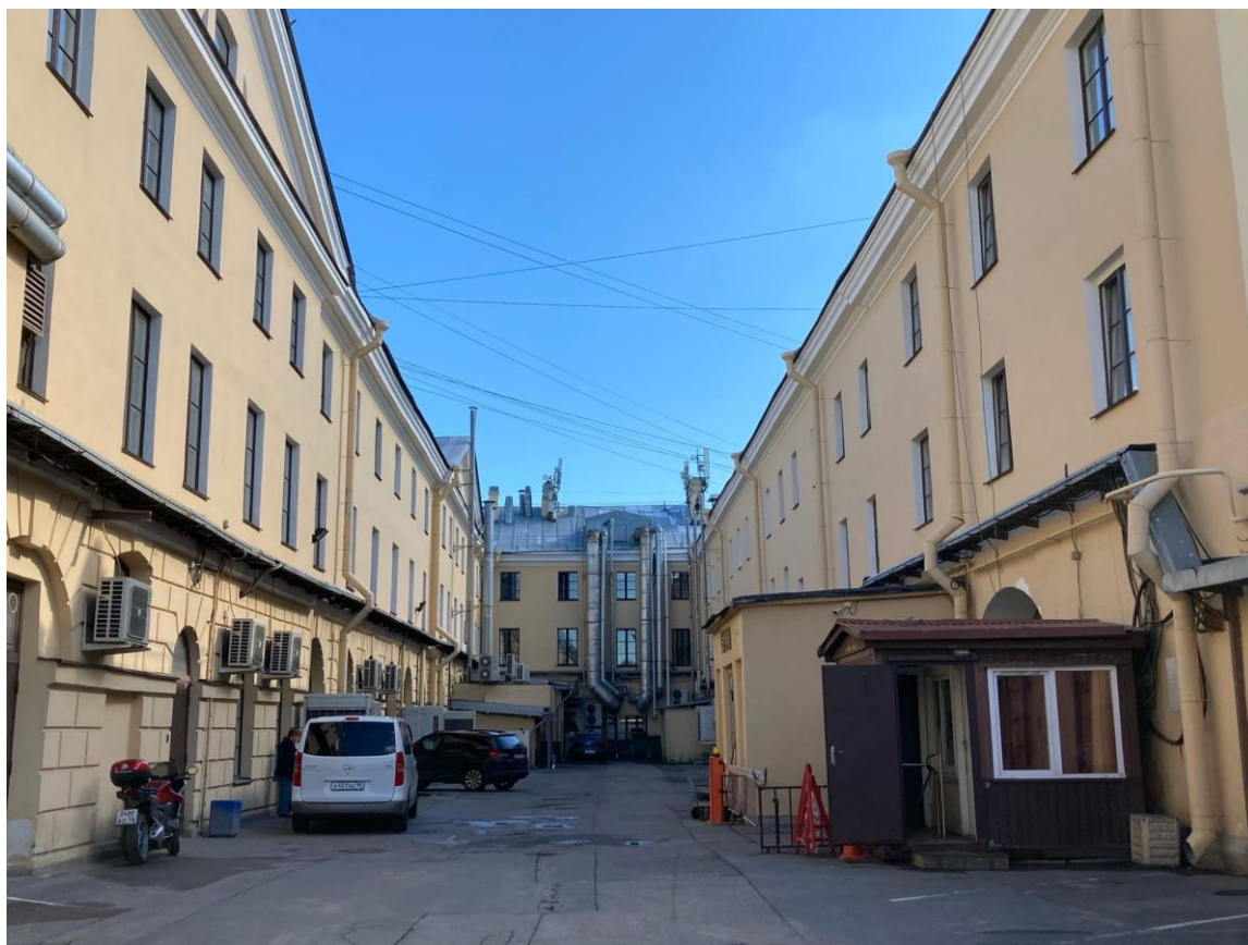
Фото 19. Фрагмент дворового фасада объекта культурного наследия федерального значения «Казармы(Трехэскадронный корпус)»
