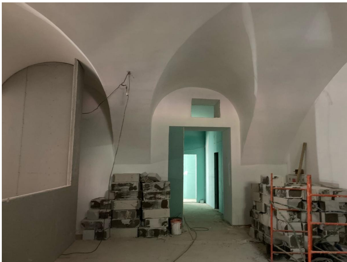
Фото 30. Интерьер объекта культурного наследия федерального значения «Казармы(Трехэскадронный корпус)», пом. 7-Н
