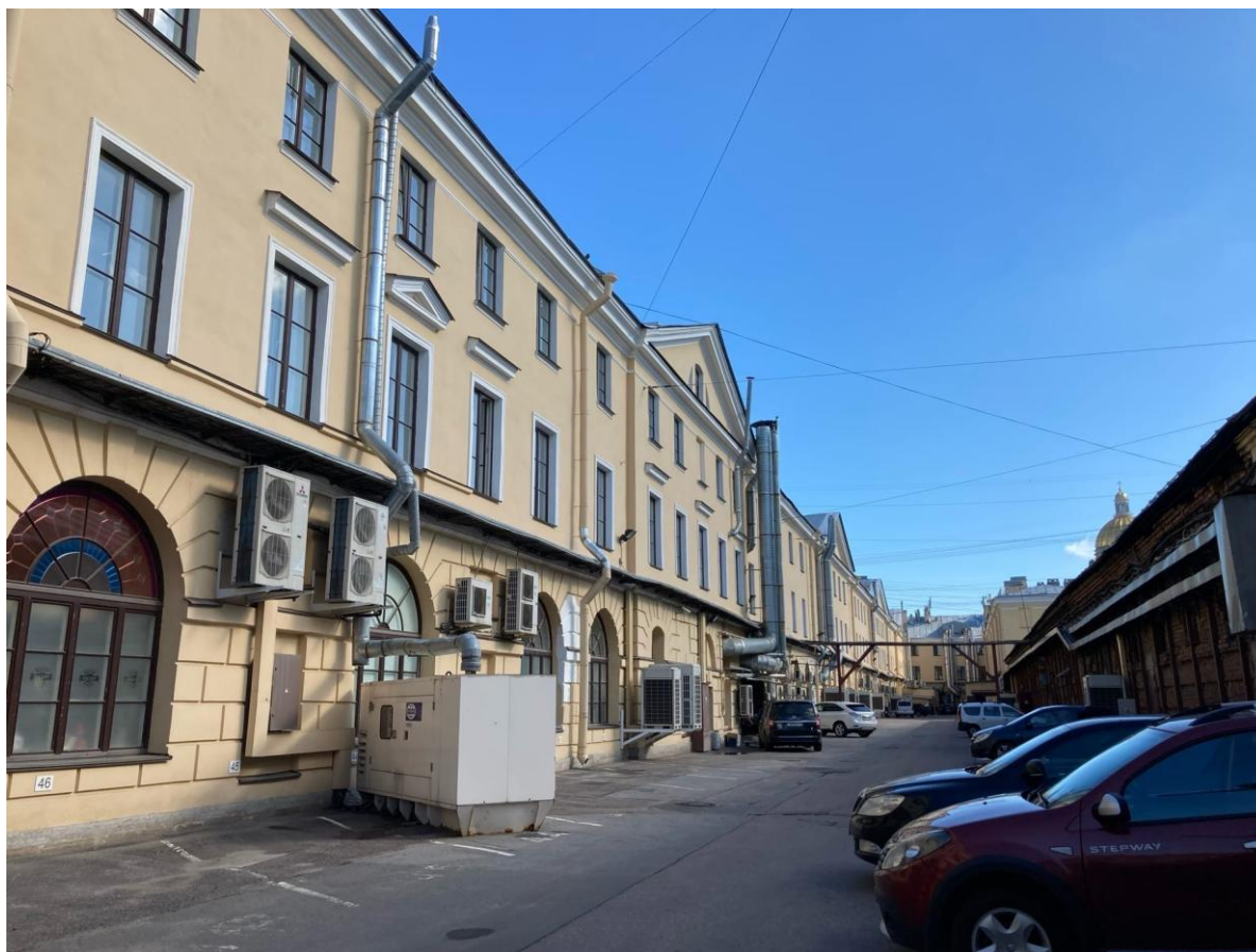
Фото 15. Фрагмент дворового фасада объекта культурного наследия федерального значения «Казармы(Трехэскадронный корпус)»
