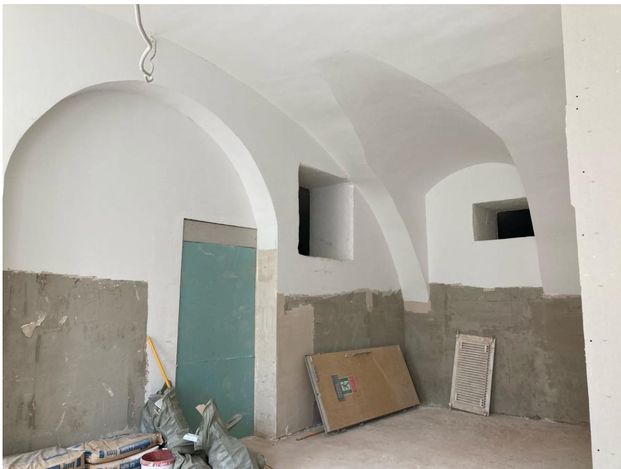
Фото 23. Интерьер объекта культурного наследия федерального значения «Казармы(Трехэскадронный корпус)», пом. 6-Н
