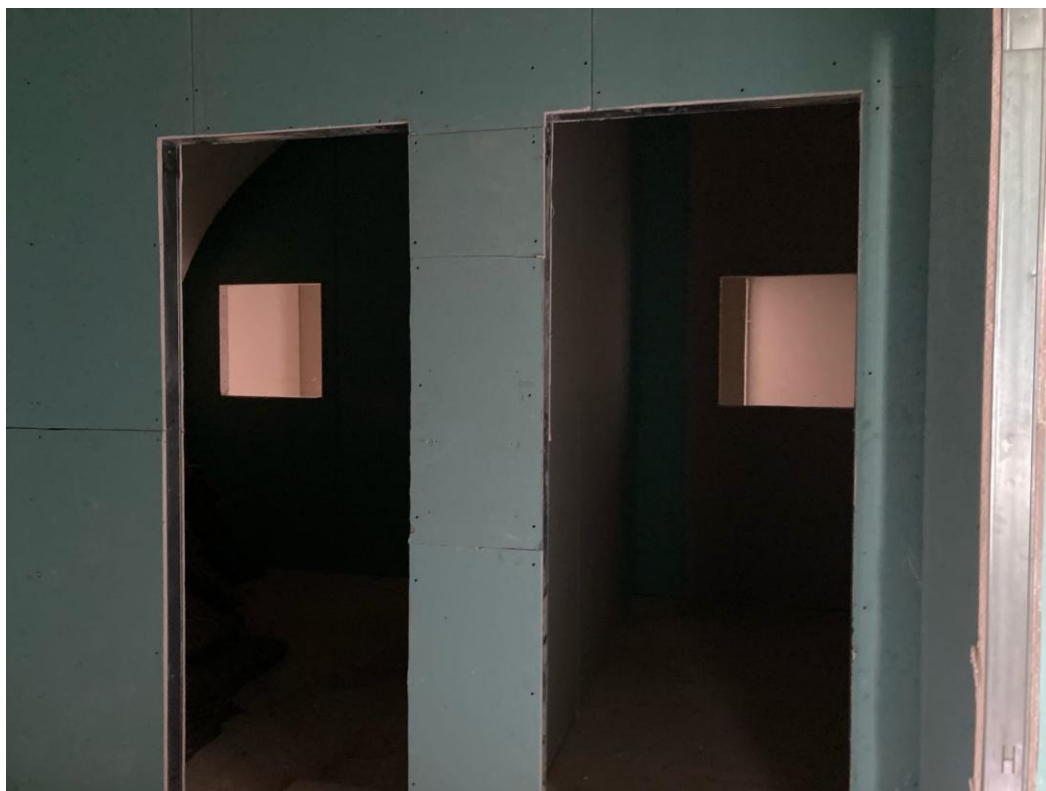
Фото 34. Интерьер объекта культурного наследия федерального значения «Казармы(Трехэскадронный корпус)», пом. 7-Н
