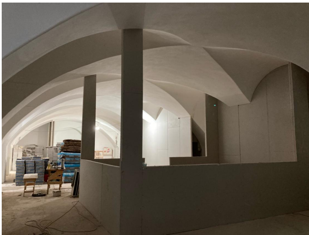
Фото 28. Интерьер объекта культурного наследия федерального значения «Казармы(Трехэскадронный корпус)», пом. 7-Н
