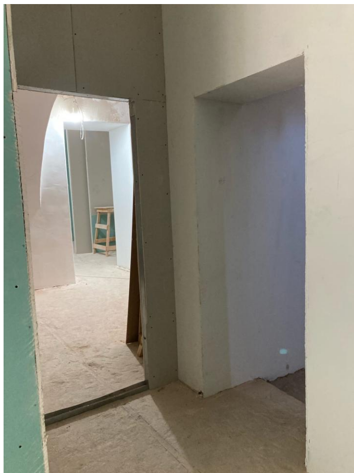
Фото 36. Интерьер объекта культурного наследия федерального значения «Казармы(Трехэскадронный корпус)», пом. 7-Н
