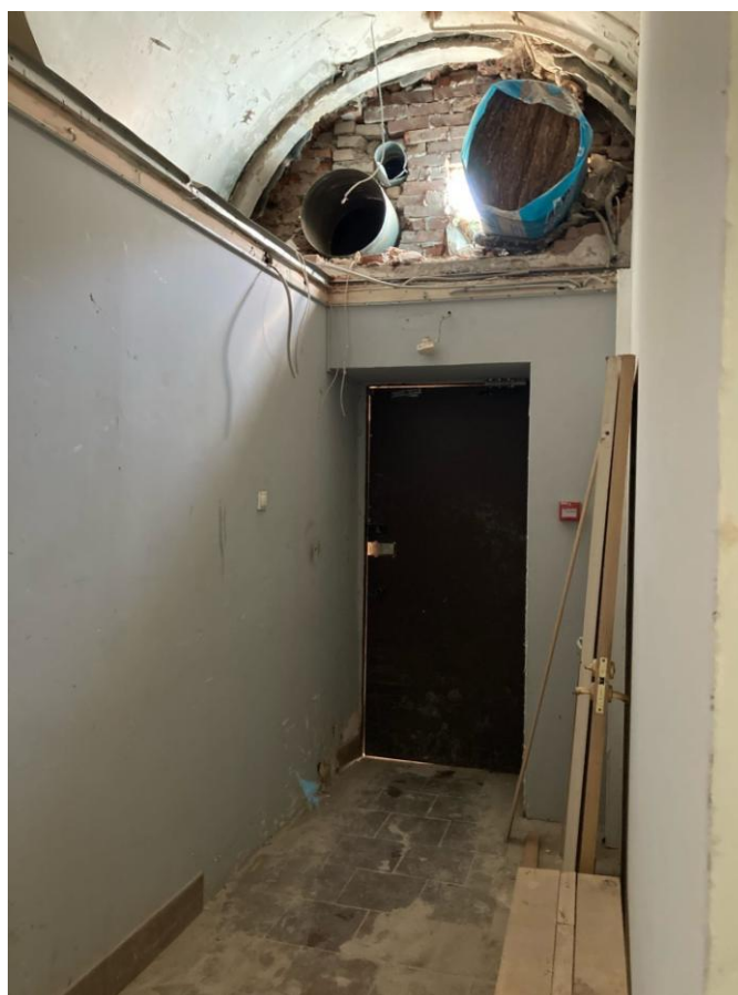
Фото 20. Интерьер объекта культурного наследия федерального значения «Казармы(Трехэскадронный корпус)», вход в пом. 7-Н со двора
