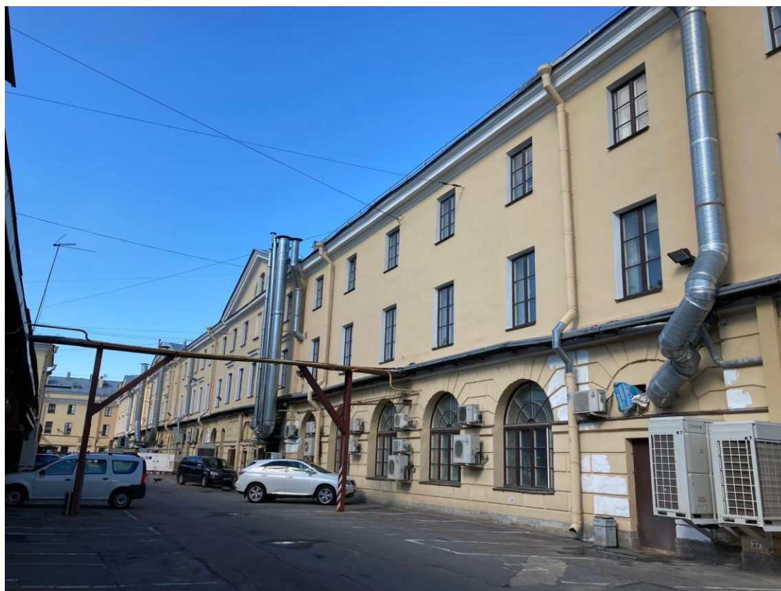
Фото 16. Фрагмент дворового фасада объекта культурного наследия федерального значения «Казармы(Трехэскадронный корпус)»
