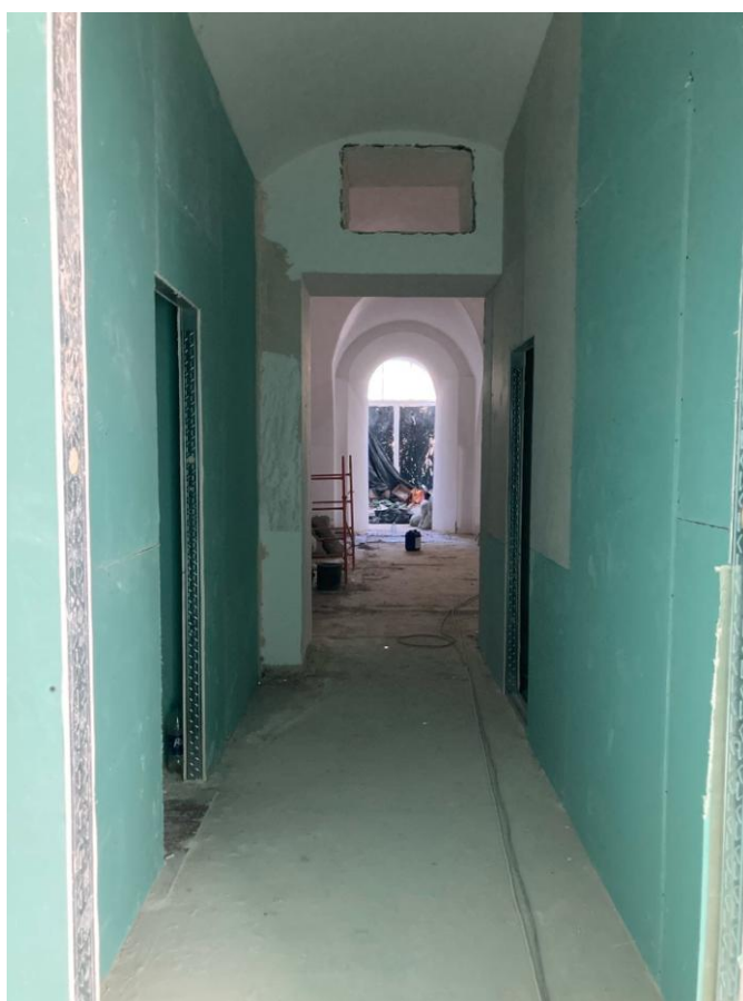
Фото 31. Интерьер объекта культурного наследия федерального значения «Казармы(Трехэскадронный корпус)», пом. 7-Н
