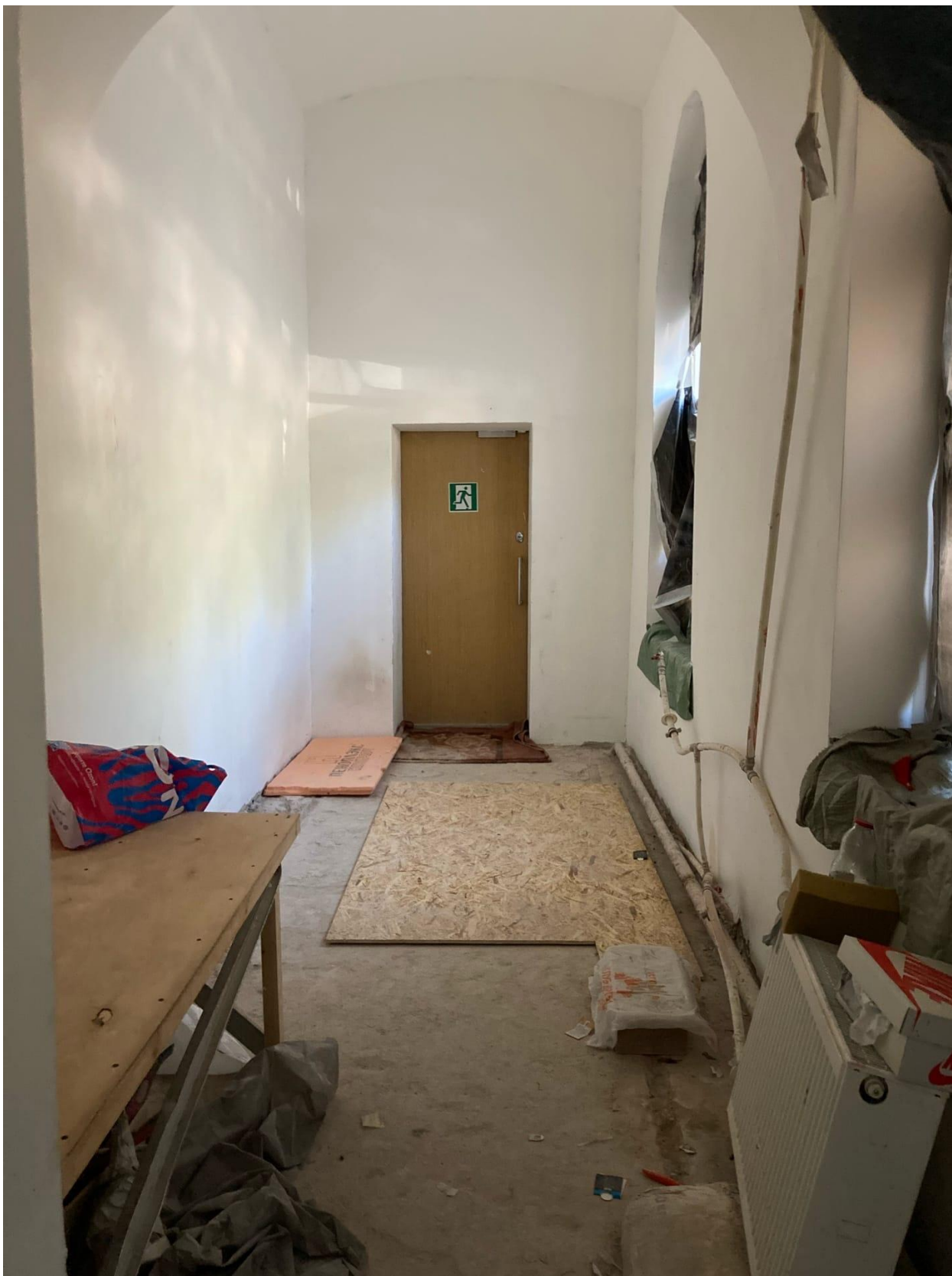
Фото 29. Интерьер объекта культурного наследия федерального значения «Казармы(Трехэскадронный корпус)», пом. 7-Н
