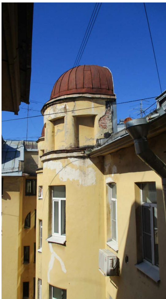
20. Санкт-Петербург, Василеостровский район, 11 линия В.О., дом 20, литера А. Лицевой корпус, фрагмент дворового фасада.
