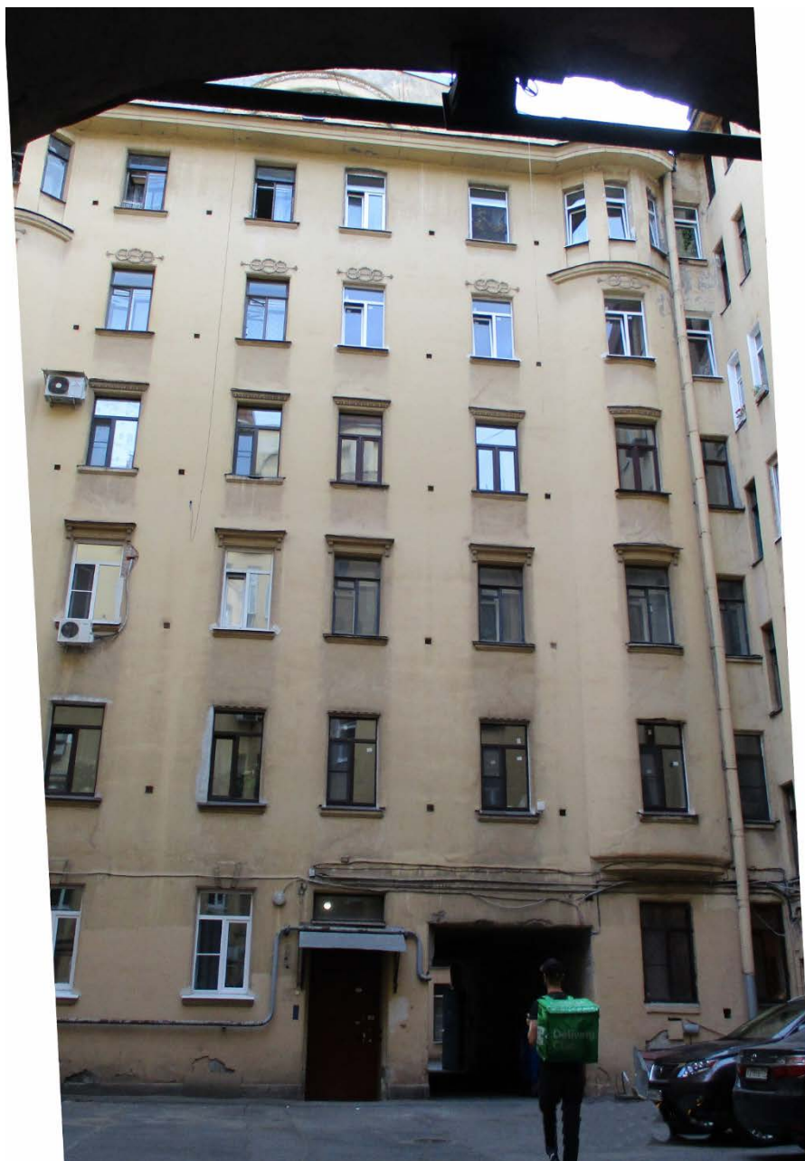
14. Санкт-Петербург, Василеостровский район, 11 линия В.О., дом 20, литера А. Западный флигель.
