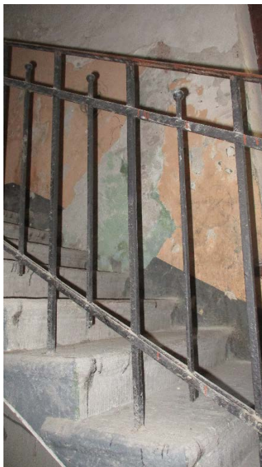
47. Санкт-Петербург, Василеостровский район, 11 линия В.О., дом 20, литера А. Западный флигель. Интерьер. Лестница Л-5, служебная (южная). Ограждение маршей.
