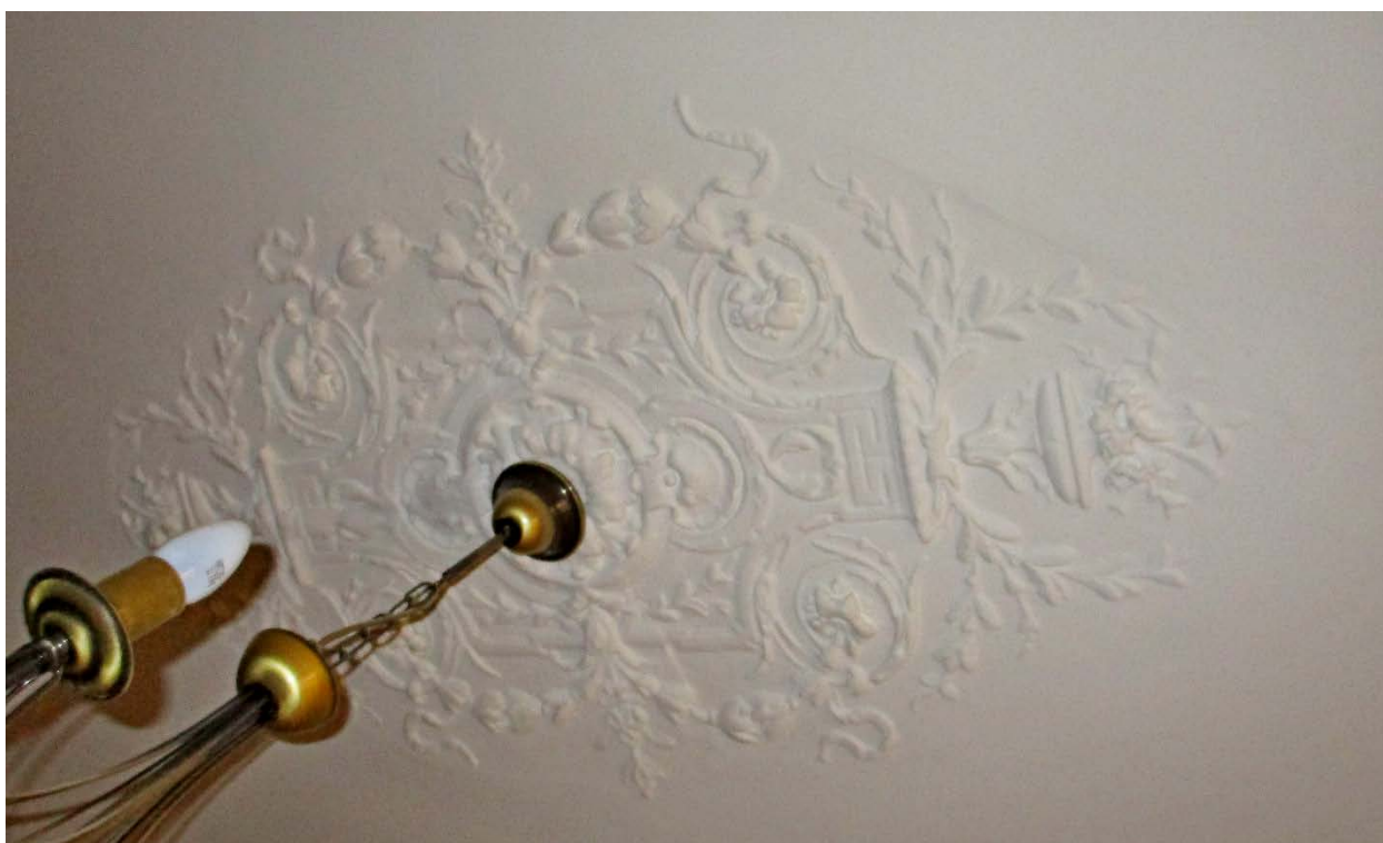
23. Санкт-Петербург, Василеостровский район, 11 линия В.О., дом 20, литера А. Лицевой корпус. Интерьер. Квартира № 34 (2 этаж), пом.8. Декоративное оформление плафона, лепная розетка в центре.
