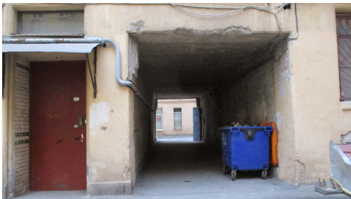
21. Санкт-Петербург, Василеостровский район, 11 линия В.О., дом 20, литера А. Западный флигель. Фрагмент восточного фасада.
