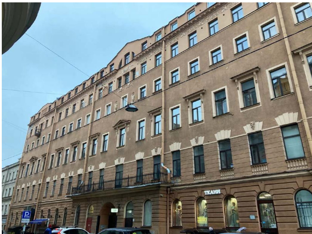
Фото 3. Лицевой фасад выявленного объекта культурного наследия «Дом Зверкова (И.С. Никитина)» (по Столярному переулку)
