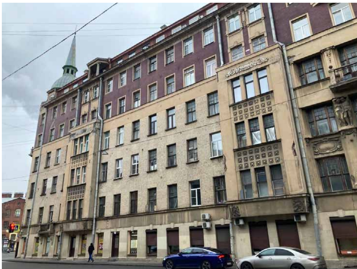
Фото 2. Фрагмент лицевого фасада объекта культурного наследия регионального значения «Дом М.Н. Полежаева»
