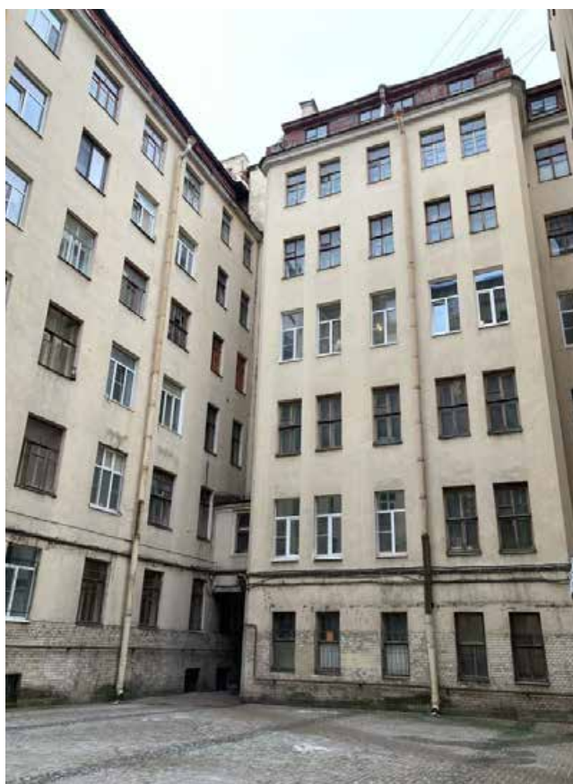
Фото 10. Фрагмент дворового фасада объекта культурного наследия регионального значения «Дом М.Н. Полежаева»
