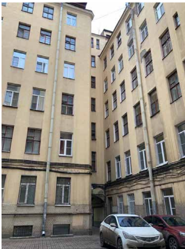
Фото 17. Фрагмент дворового фасада объекта культурного наследия регионального значения «Дом М.Н. Полежаева»
