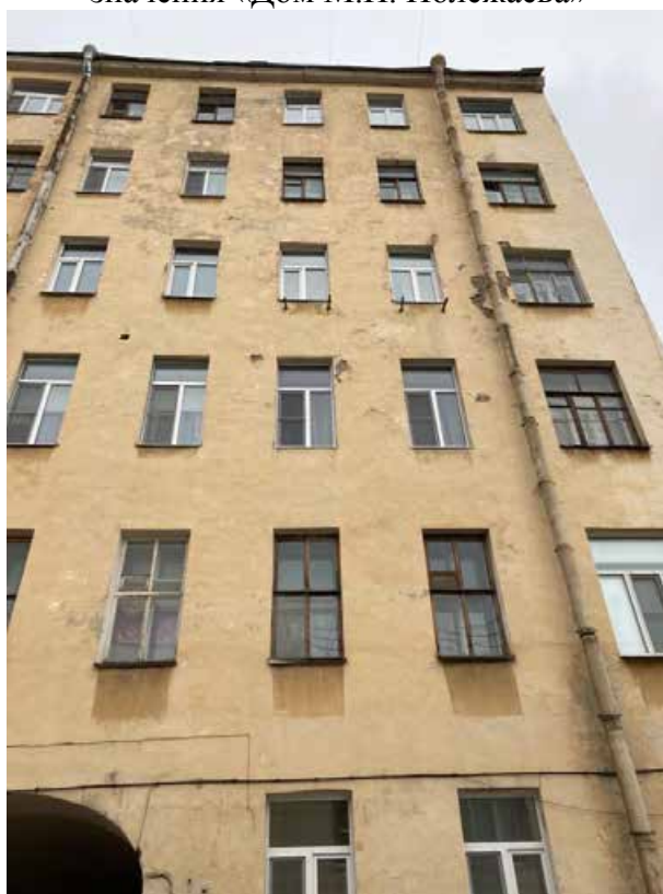
Фото 12. Фрагмент дворового фасада объекта культурного наследия регионального значения «Дом М.Н. Полежаева»
