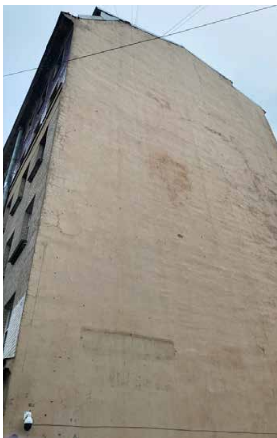
Фото 14. Фрагмент дворового фасада объекта культурного наследия регионального значения «Дом М.Н. Полежаева»
