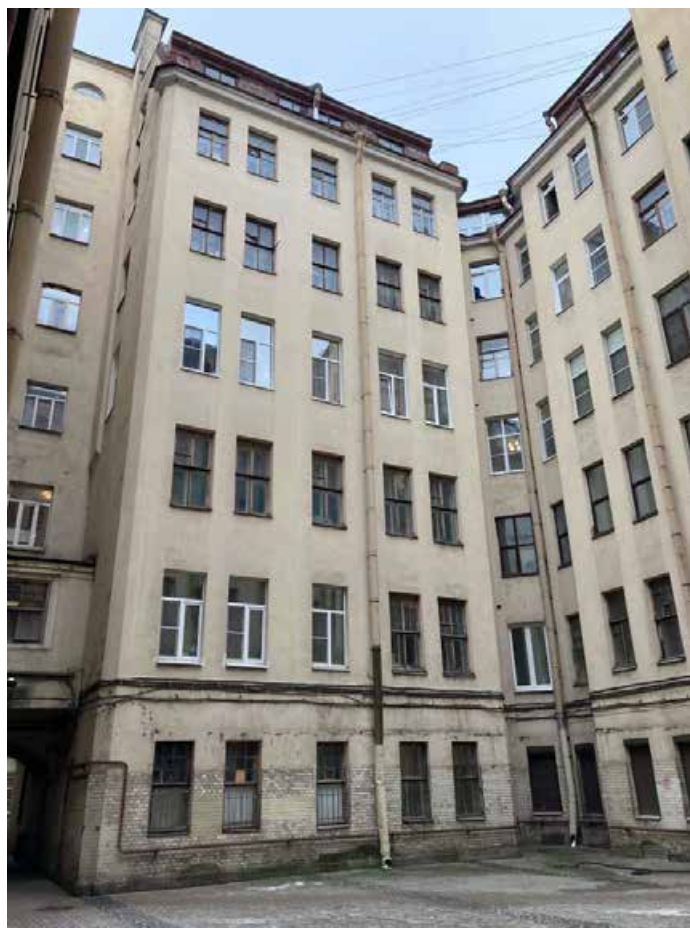
Фото 11. Фрагмент дворового фасада объекта культурного наследия регионального значения «Дом М.Н. Полежаева»
