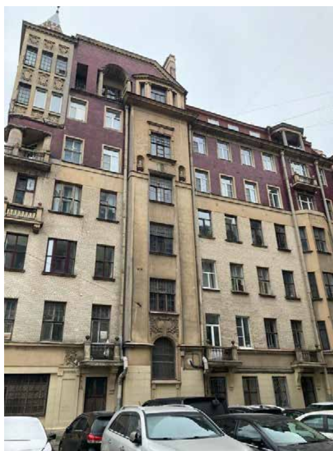
Фото 4. Фрагмент лицевого фасада объекта культурного наследия регионального значения «Дом М.Н. Полежаева»
