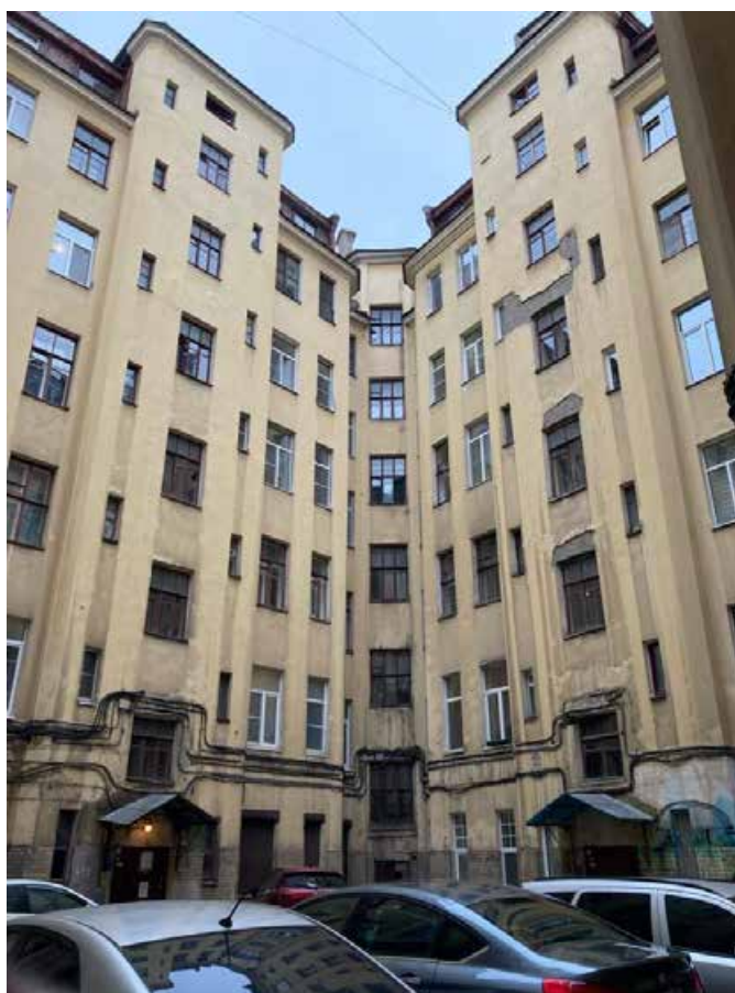
Фото 16. Фрагмент дворового фасада объекта культурного наследия регионального значения «Дом М.Н. Полежаева»
