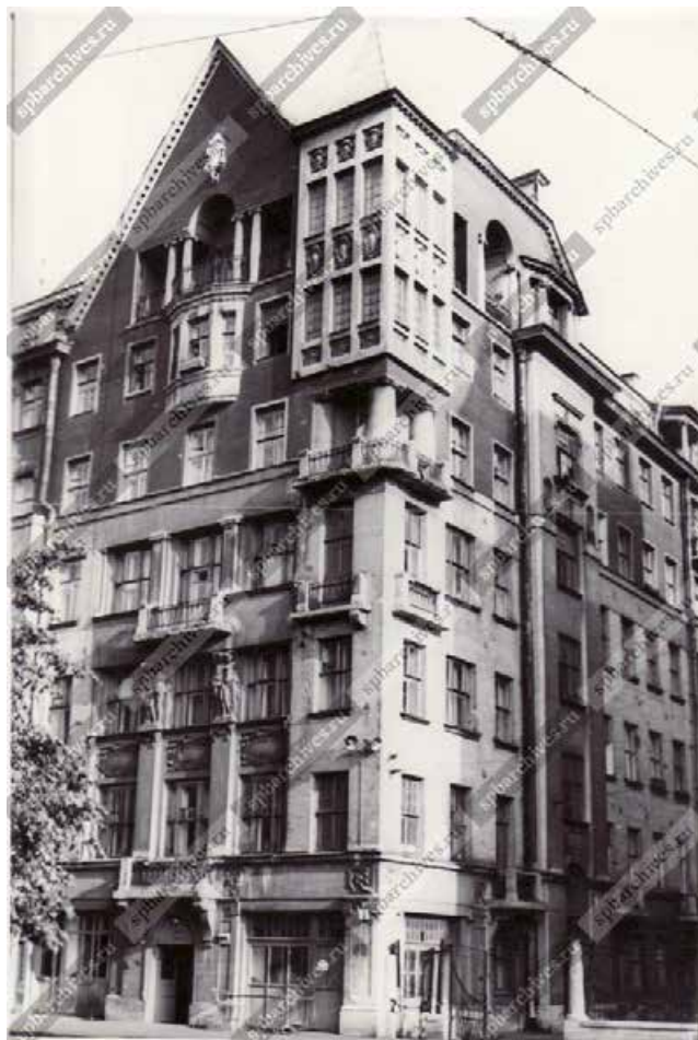
12. Вид части фасада жилого дома № 5/3 со стороны Старорусской улицы, завершеного квадратной башней- эркером (бывш. дом купца 1-й гильдии М.Н.Полежаева, 1913-1915 гг. - арх. И.И.Яковлев). 27 июня 1981 г. — ЦГАКФФД СПб Ар 215054.
