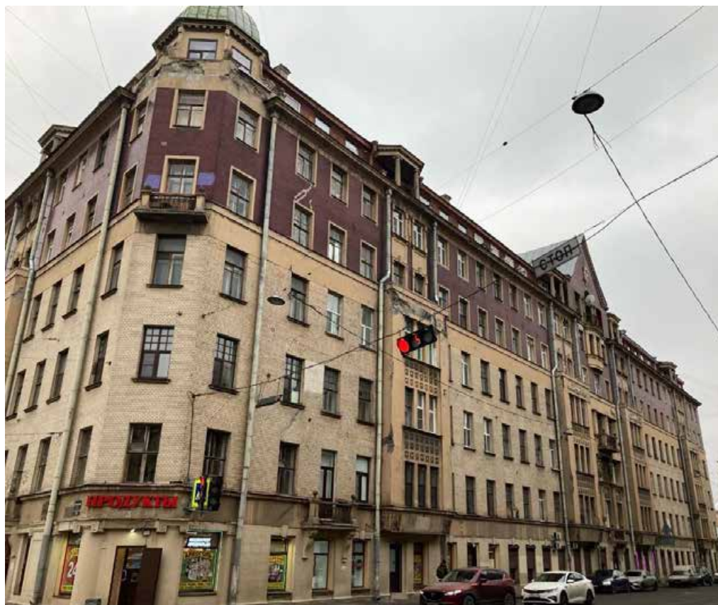
Фото 3. Фрагмент лицевого фасада объекта культурного наследия регионального значения «Дом М.Н. Полежаева»
