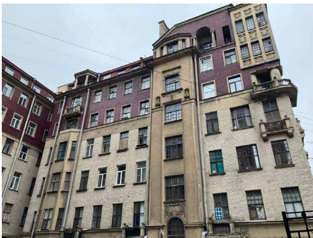
Фото 6. Фрагмент лицевого фасада объекта культурного наследия регионального значения «Дом М.Н. Полежаева»
