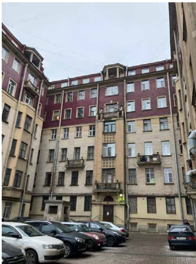
Фото 5. Фрагмент лицевого фасада объекта культурного наследия регионального значения «Дом М.Н. Полежаева»
