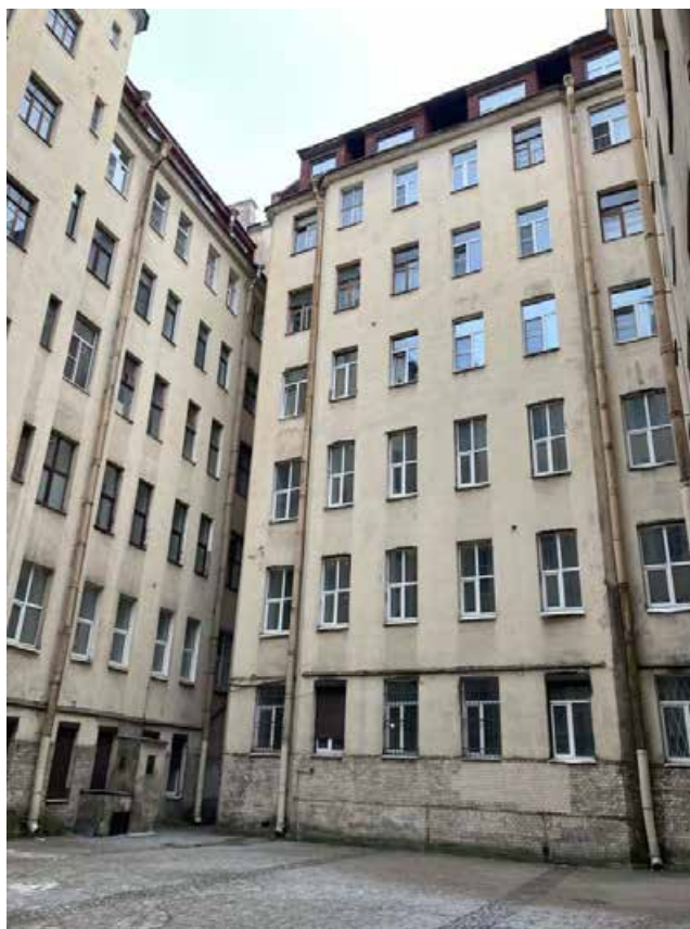
Фото 9. Фрагмент дворового фасада объекта культурного наследия регионального значения «Дом М.Н. Полежаева»
