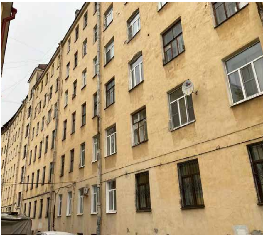
Фото 13. Фрагмент дворового фасада объекта культурного наследия регионального значения «Дом М.Н. Полежаева»
