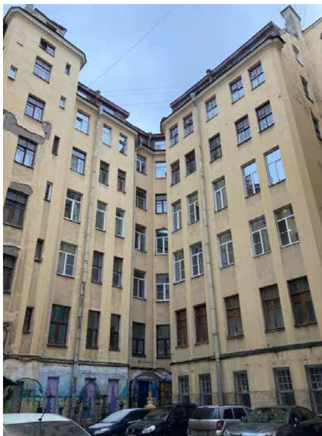
Фото 15. Фрагмент дворового фасада объекта культурного наследия регионального значения «Дом М.Н. Полежаева»
