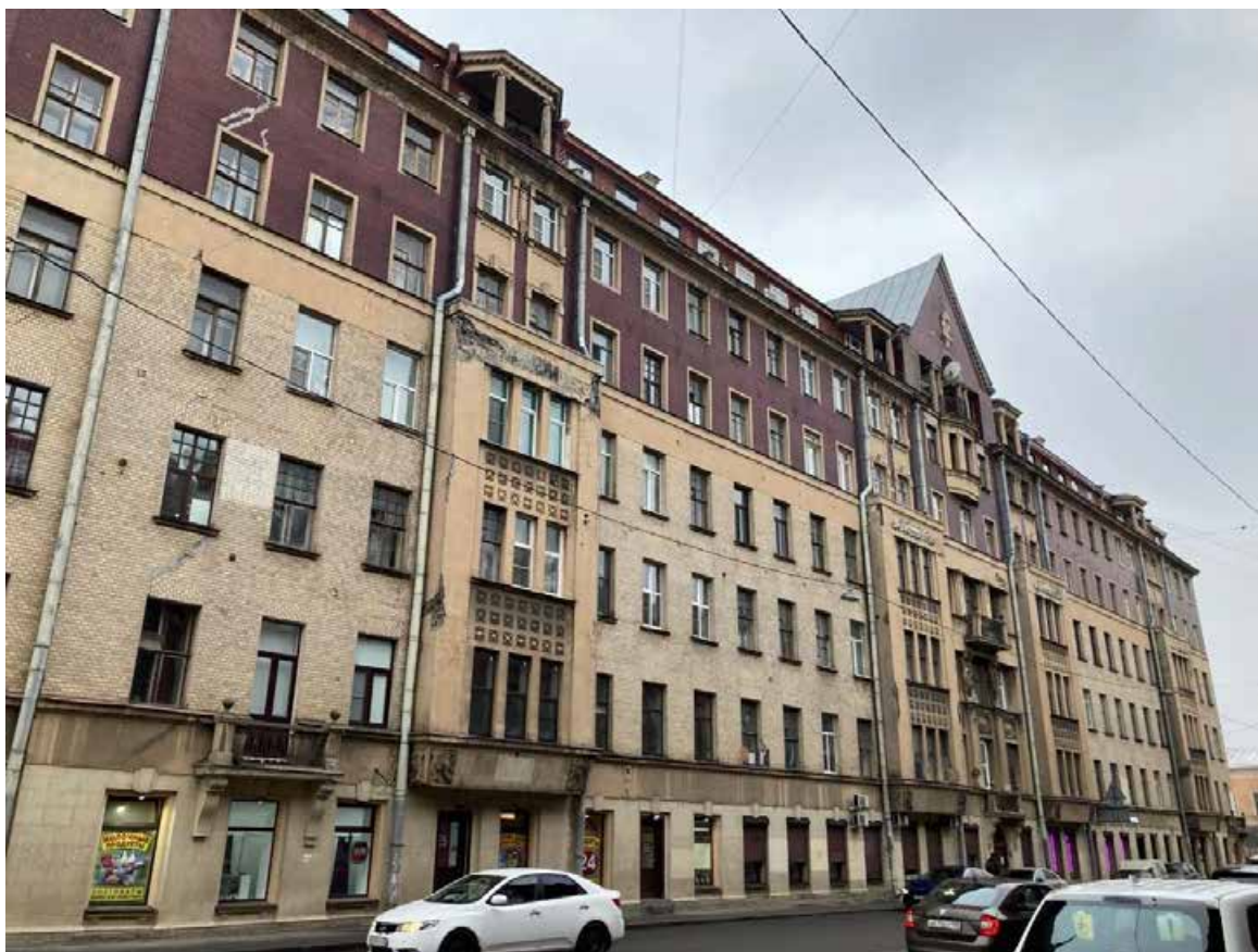
Фото 1. Фрагмент лицевого фасада объекта культурного наследия регионального значения «Дом М.Н. Полежаева»
