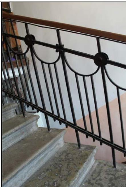
ограждение маршей ЛК-2: материал (металл), техника исполнения (ковка), рисунок (вертикальные прутья гладкие и витые, соединенные витыми узорами);
