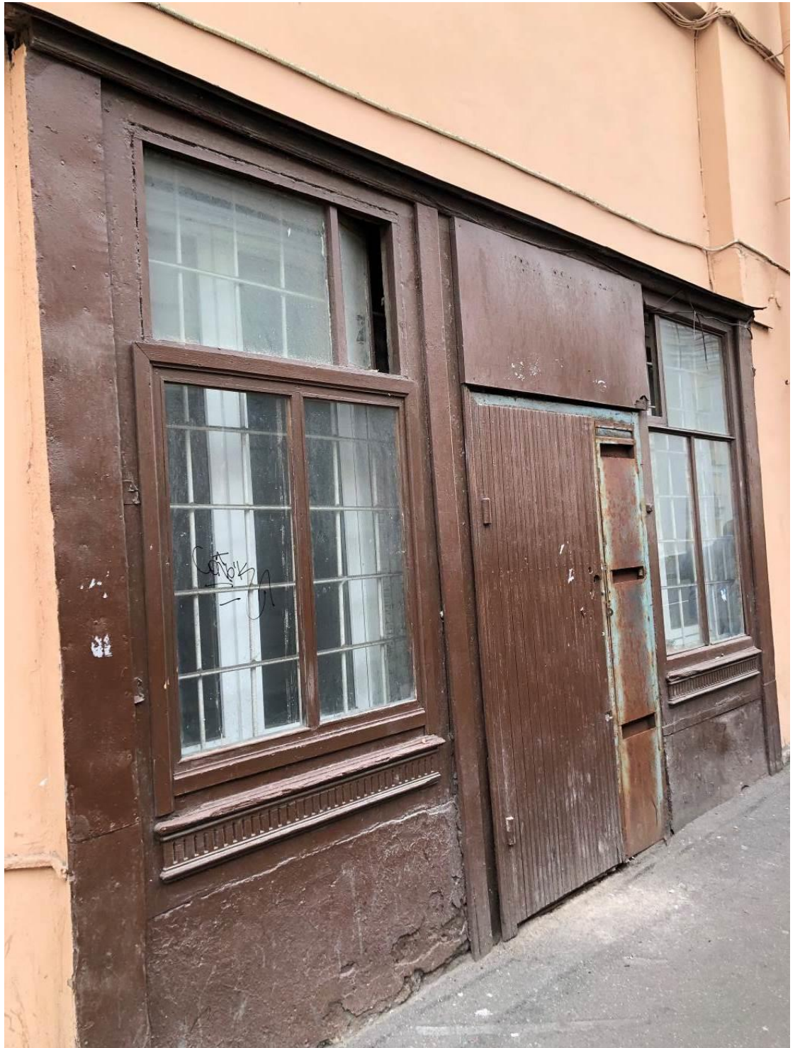
5. Малый Гостиный двор. Новая Банковская линия. Входная группа исследуемого помещения 10-Н. Штиглиц М.С. 28.09.2022 г.
