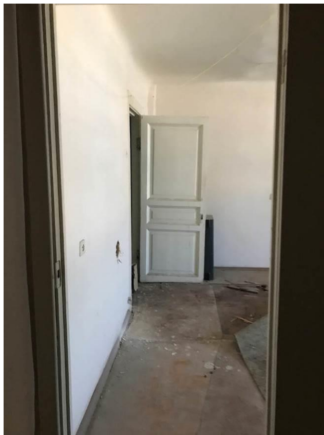
36. Малый Гостиный двор. Новая Банковская линия. Помещение 10-Н, 4-й этаж. Штиглиц М.С. 28.09.2022 г.
