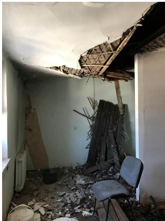
38. Малый Гостиный двор. Новая Банковская линия. Помещение 10-Н, 4-й этаж. Штиглиц М.С. 28.09.2022 г.
