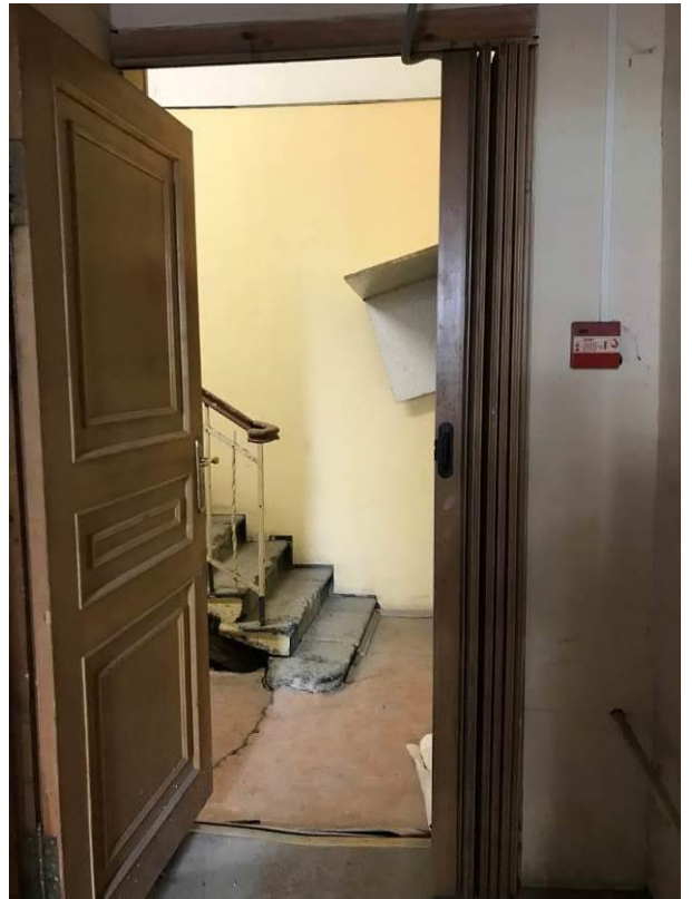
14. Малый Гостиный двор. Новая Банковская линия. Помещение 10-Н, 1-й этаж. Выход на лестницу. Штиглиц М.С. 28.09.2022 г.
