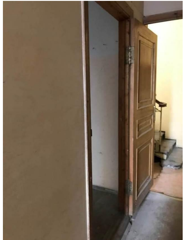
10. Малый Гостиный двор. Новая Банковская линия. Помещение 10-Н, 1-й этаж. Штиглиц М.С. 28.09.2022 г.
