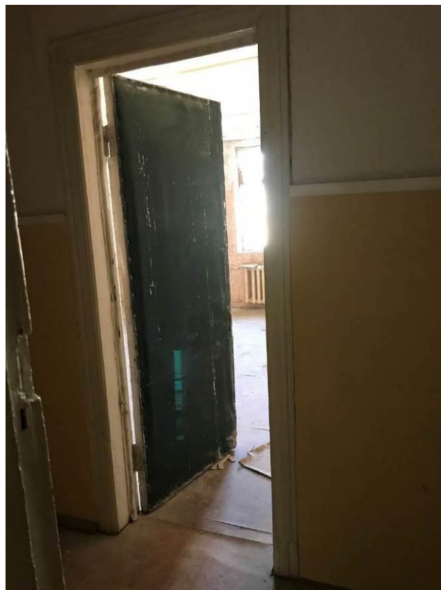
30. Малый Гостиный двор. Новая Банковская линия. Помещение 10-Н, 3-й этаж. Штиглиц М.С. 28.09.2022 г.
