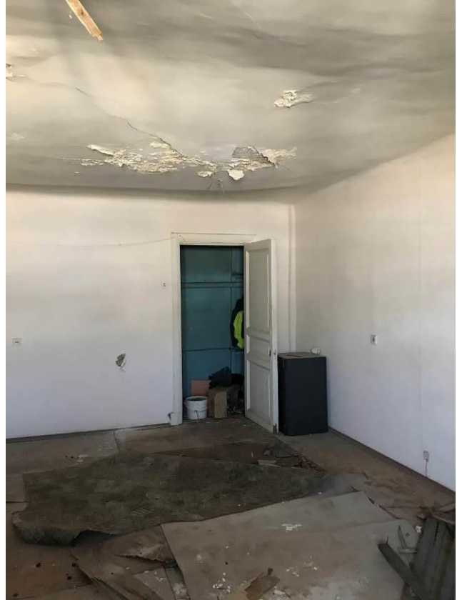
40. Малый Гостиный двор. Новая Банковская линия. Помещение 10-Н, 4-й этаж. Штиглиц М.С. 28.09.2022 г.
