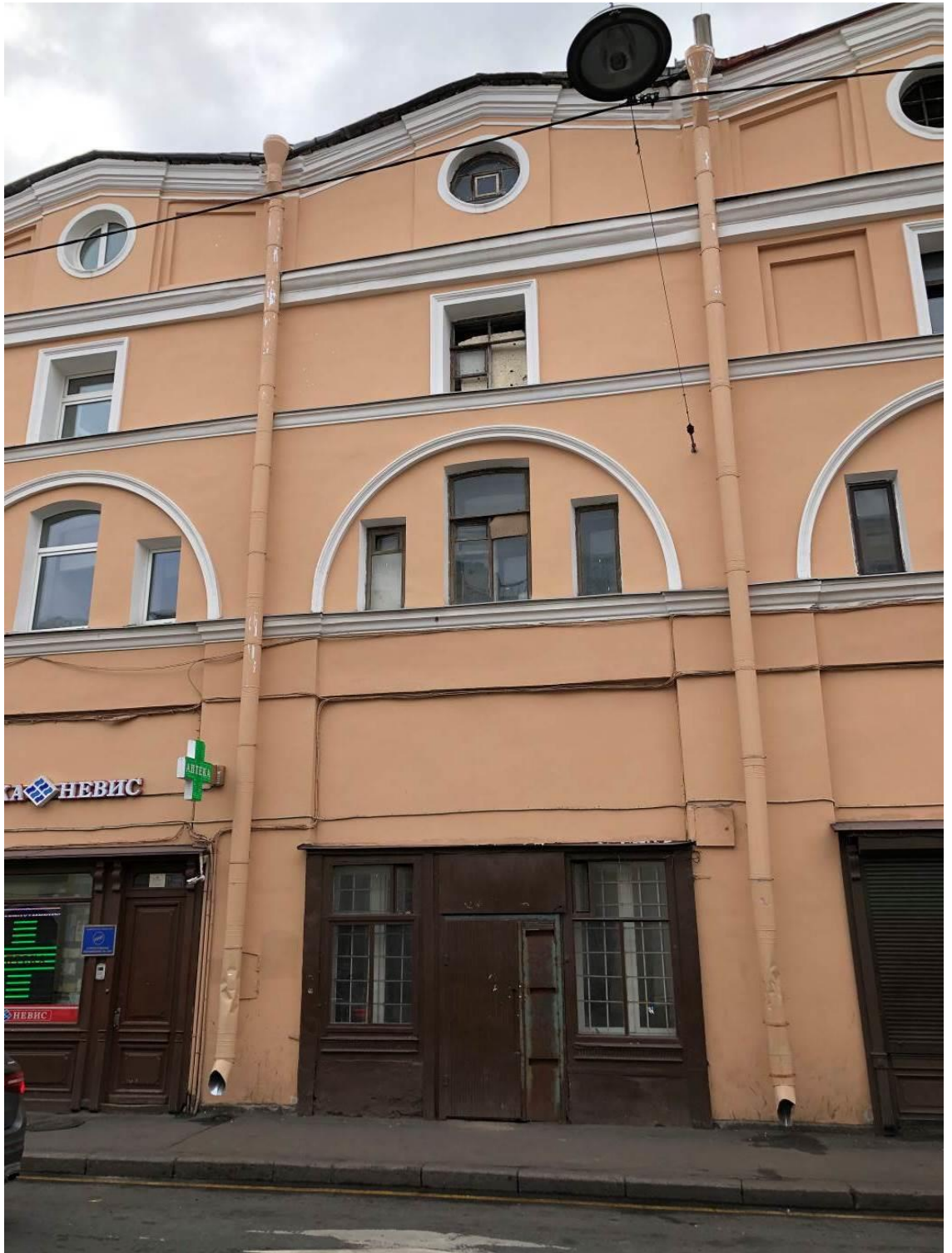
4. Малый Гостиный двор. Новая Банковская линия. Фрагмент главного фасада (вид на помещение 10-Н). Штиглиц М.С. 28.09.2022 г.
