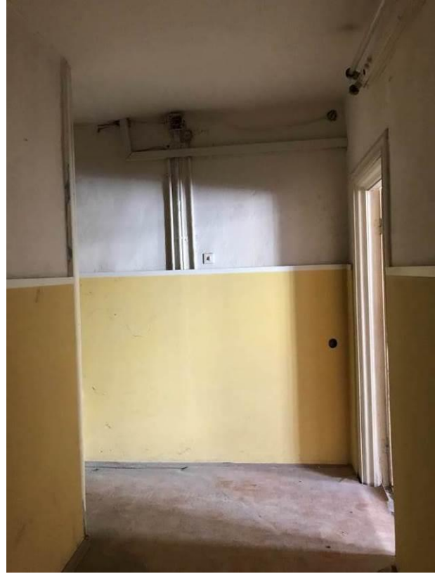
18. Малый Гостиный двор. Новая Банковская линия. Помещение 10-Н, 2-й этаж. Штиглиц М.С. 28.09.2022 г.
