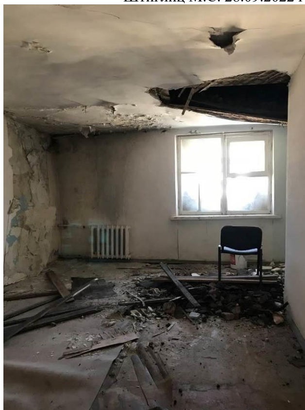
37. Малый Гостиный двор. Новая Банковская линия. Помещение 10-Н, 4-й этаж. Штиглиц М.С. 28.09.2022 г.
