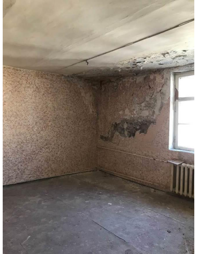
32. Малый Гостиный двор. Новая Банковская линия. Помещение 10-Н, 3-й этаж. Штиглиц М.С. 28.09.2022 г.
