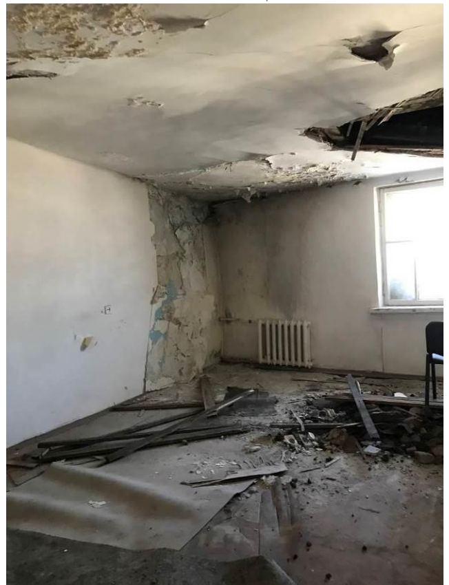
41. Малый Гостиный двор. Новая Банковская линия. Помещение 10-Н, 4-й этаж. Штиглиц М.С. 28.09.2022 г.
