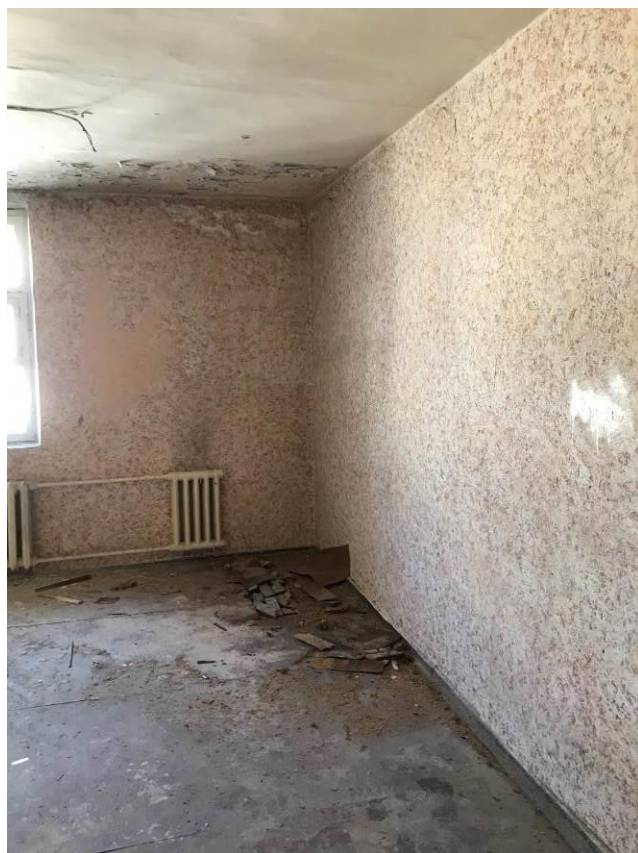
31. Малый Гостиный двор. Новая Банковская линия. Помещение 10-Н, 3-й этаж. Штиглиц М.С. 28.09.2022 г.
