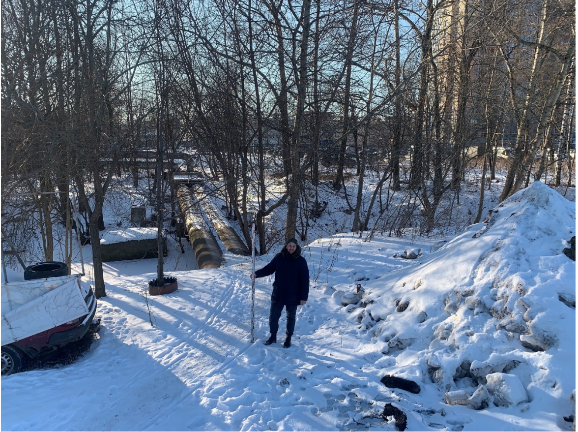
Рис. 18. СПб Черная речка-2023. Точка фотофиксации 6, вид на восток.
