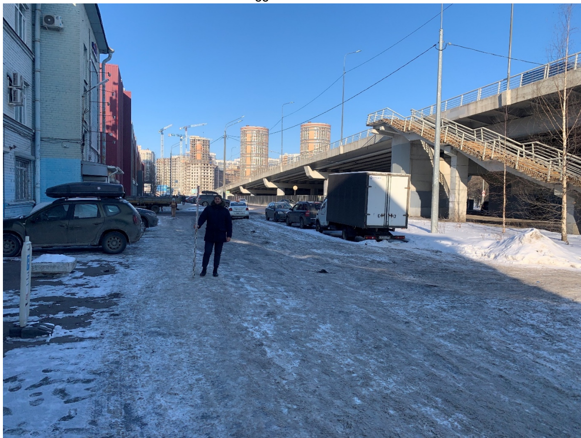
Рис. 16. СПб Черная речка-2023. Точка фотофиксации 4, вид на юго-запад.
