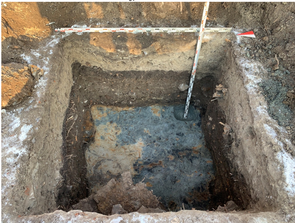
Рис. 40. СПБ, Черная речка-2023. Шурф 1, фиксация по уровню материковой поверхности, вид на восток.
