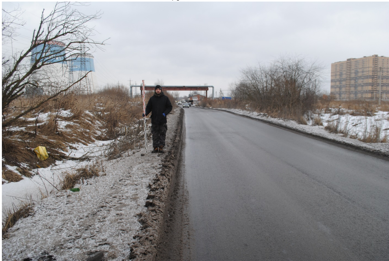
Рис. 18. Санкт-Петербург, Приневская улица. Общий вид участка обследования. Точка съемки 4. Вид на северо-восток.
