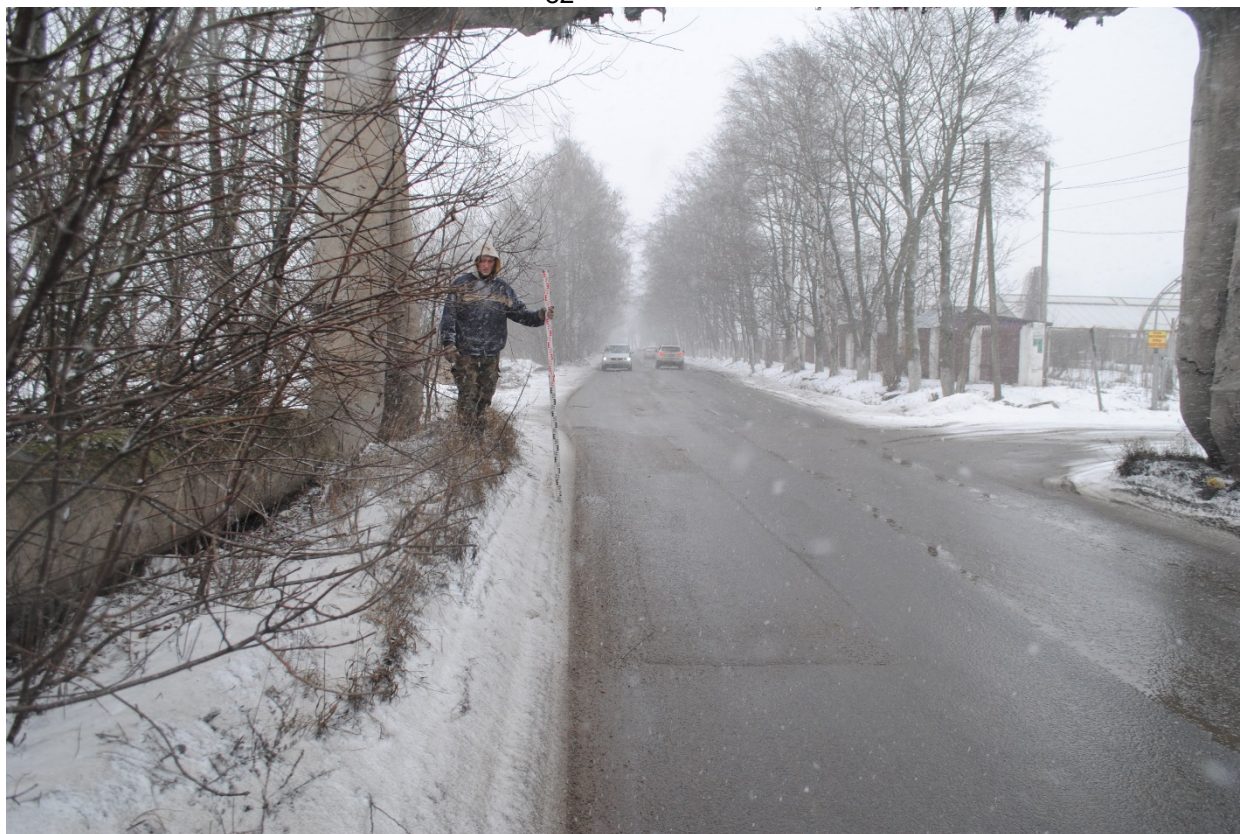
Рис. 30. Санкт-Петербург, Приневская улица. Общий вид участка обследования. Точка съемки 10. Вид на северо-восток.
