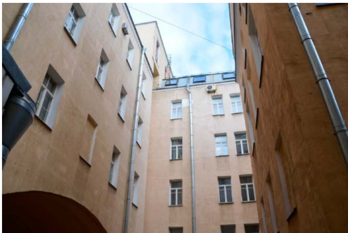
15. Вид на южную стену поперечного флигеля и северную стену центрального дворового флигеля в месте, где в 1913–2004 гг. в уровне 2-го этажа был расположен крытый переход объекта культурного наследия регионального значения «Здание Управления городского телефона и телеграфа». 15.08.2021.
