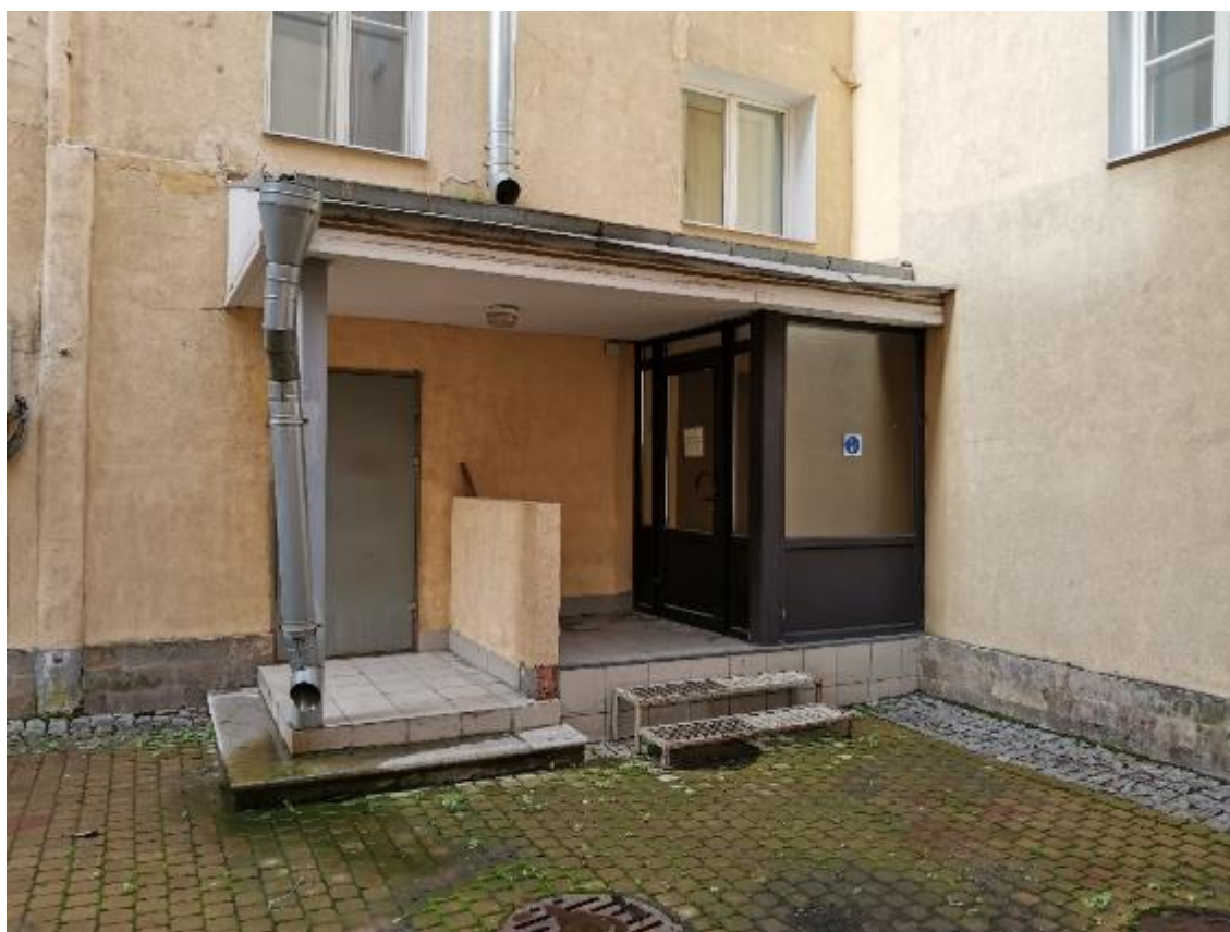
20. Крыльцо поперечным южным дворового фасада объекта культурного наследия регионального значения «Здание Управления городского телефона и телеграфа». 15.08.2021.
