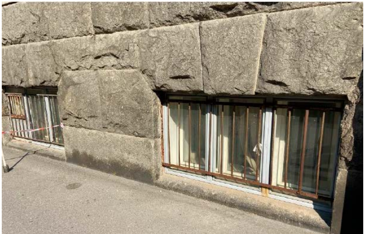
6. Цоколь юго-восточного лицевого фасада по улице Почтамтской объекта культурного наследия регионального значения «Здание Управления городского телефона и телеграфа», расположенного по адресу: г. Санкт-Петербург, Почтамтская ул., 15, литера А. 15.08.2021.
