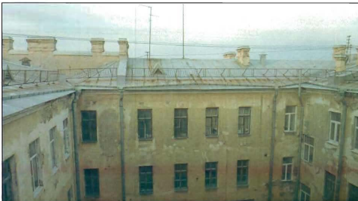
8. Кровля. Вид с юго-востока.
