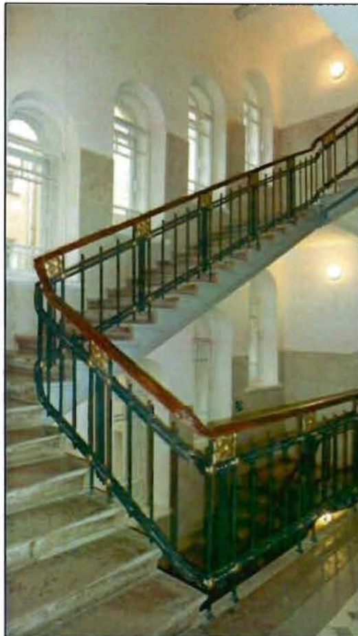
10. Лестница (2 ЛК). Корпус по ул. Почтамтской.
