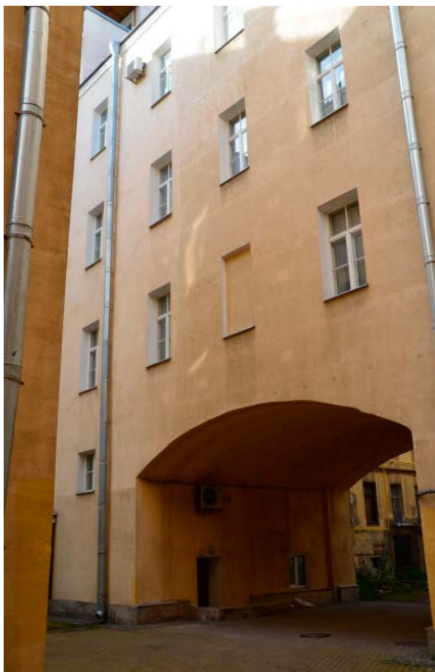
12. Вид поперечного флигеля со стороны центрального двора объекта культурного наследия регионального значения «Здание Управления городского телефона и телеграфа», расположенного по адресу: г. Санкт-Петербург, Почтамтская ул., 15, литера А. 15.08.2021.
