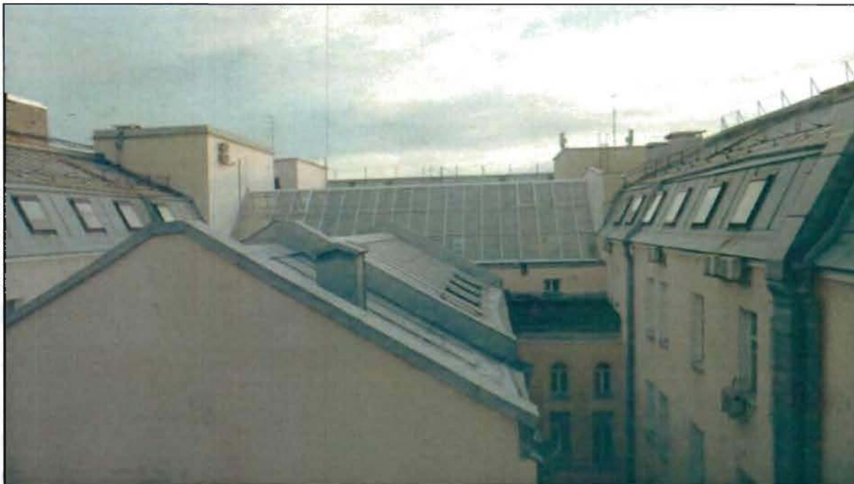
7. Кровля. Вид с северо-запада.
