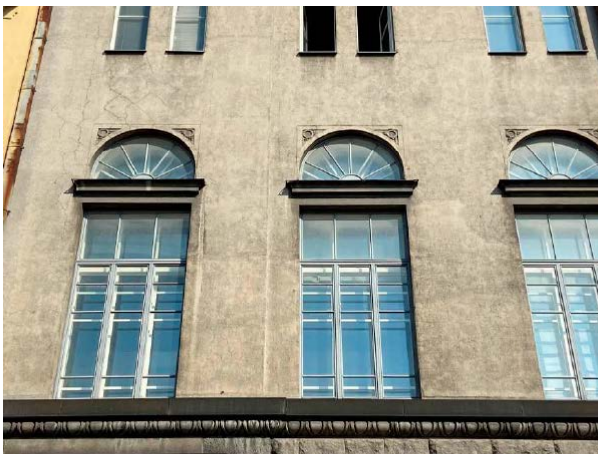
3. Юго-восточный лицевой фасад по улице Почтамтской объекта культурного наследия регионального значения «Здание Управления городского телефона и телеграфа», расположенного по адресу: г. Санкт-Петербург, Почтамтская ул., 15, литера А. Фрагмент. 15.08.2021.
