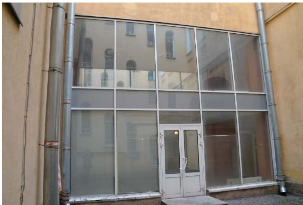
18. Вид стеклянного коридора под историческим переходом между корпусом по Почтамтской улице и поперечным южным флигелем объекта культурного наследия регионального значения «Здание Управления городского телефона и телеграфа». 15.08.2021.
