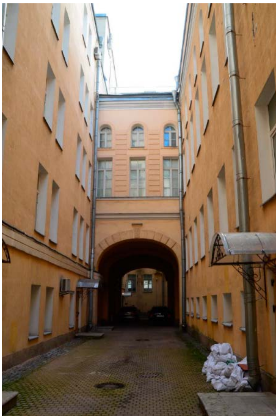
17. Вид на южный поперечный флигель, восточную стену центрального дворового флигеля и западную стену бокового корпуса объекта культурного наследия регионального значения «Здание Управления городского телефона и телеграфа».
