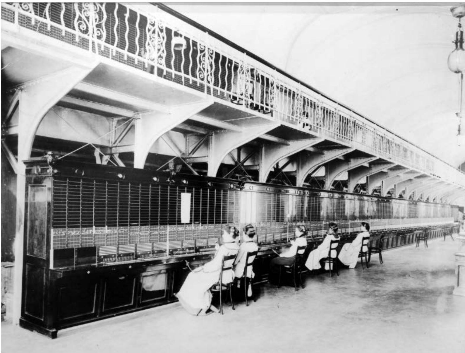
6. Коммутаторный зал Центральной телефонной станции. 1905 // Архив ЦМС им. Попова А.С.
