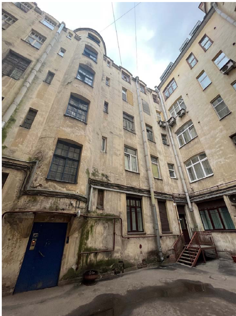
Фото №4. Фрагмент дворового фасада.
