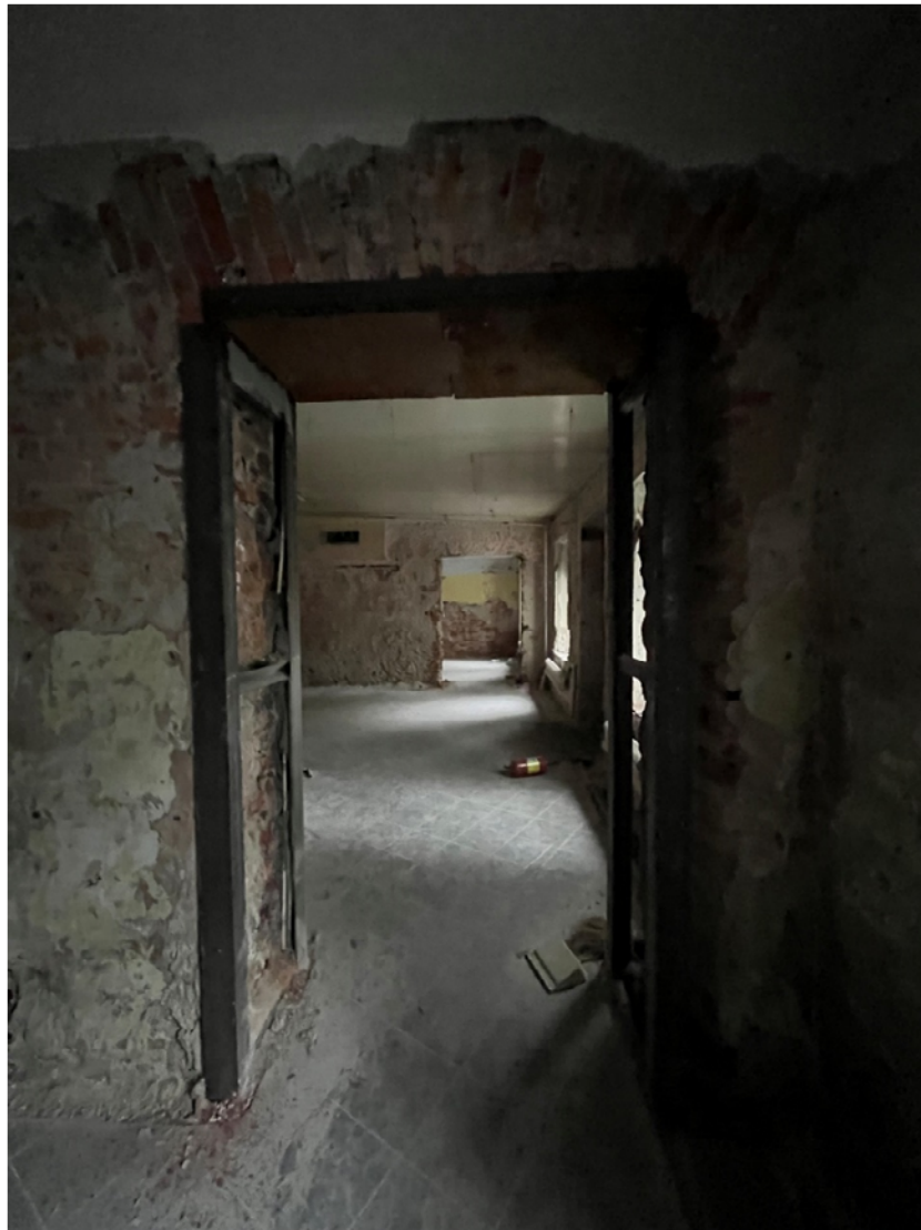
Фото №10. Помещение №3-Н, дверной проем между помещением 2 и 3.
