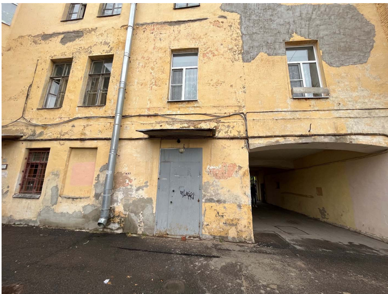
Фото №5. Северо-западный дворовый фасад, вход в помещение №3-Н.
