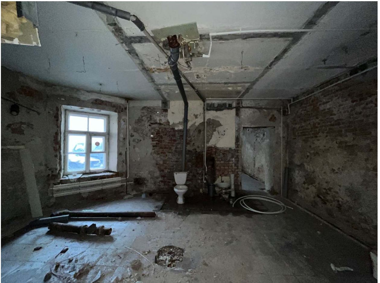
Фото №19. Помещение №3-Н (4, 5, 7, 8, 9), перегородки демонтированы.
