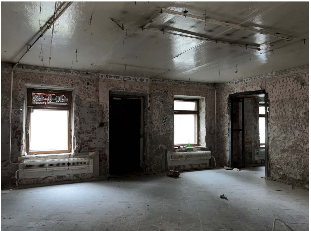
Фото №16. Помещение №3-Н (1, 2), перегородки тамбура (пом. 1) демонтированы.
