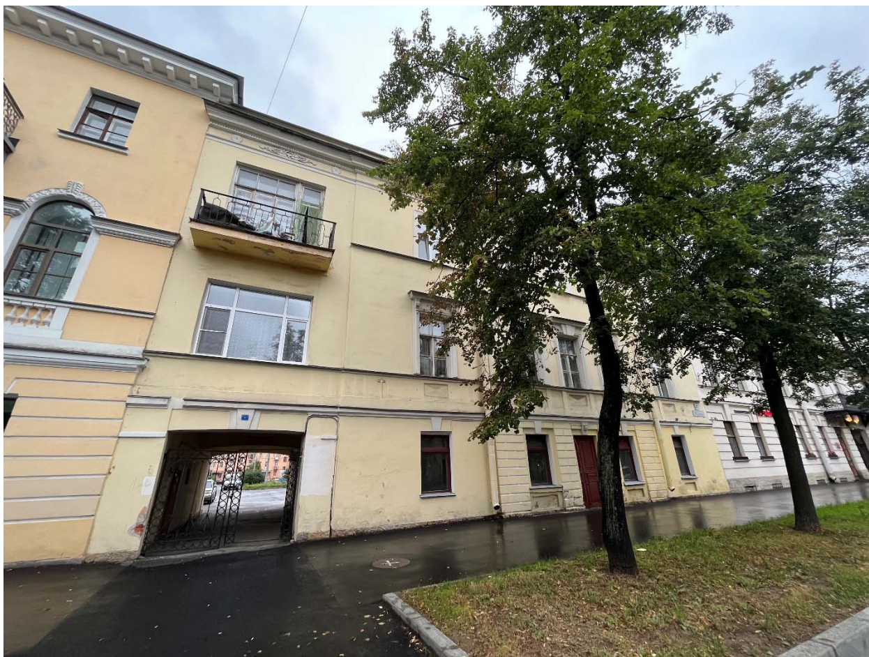
Фото №1. Юго-восточный лицевой фасад, общий вид.
