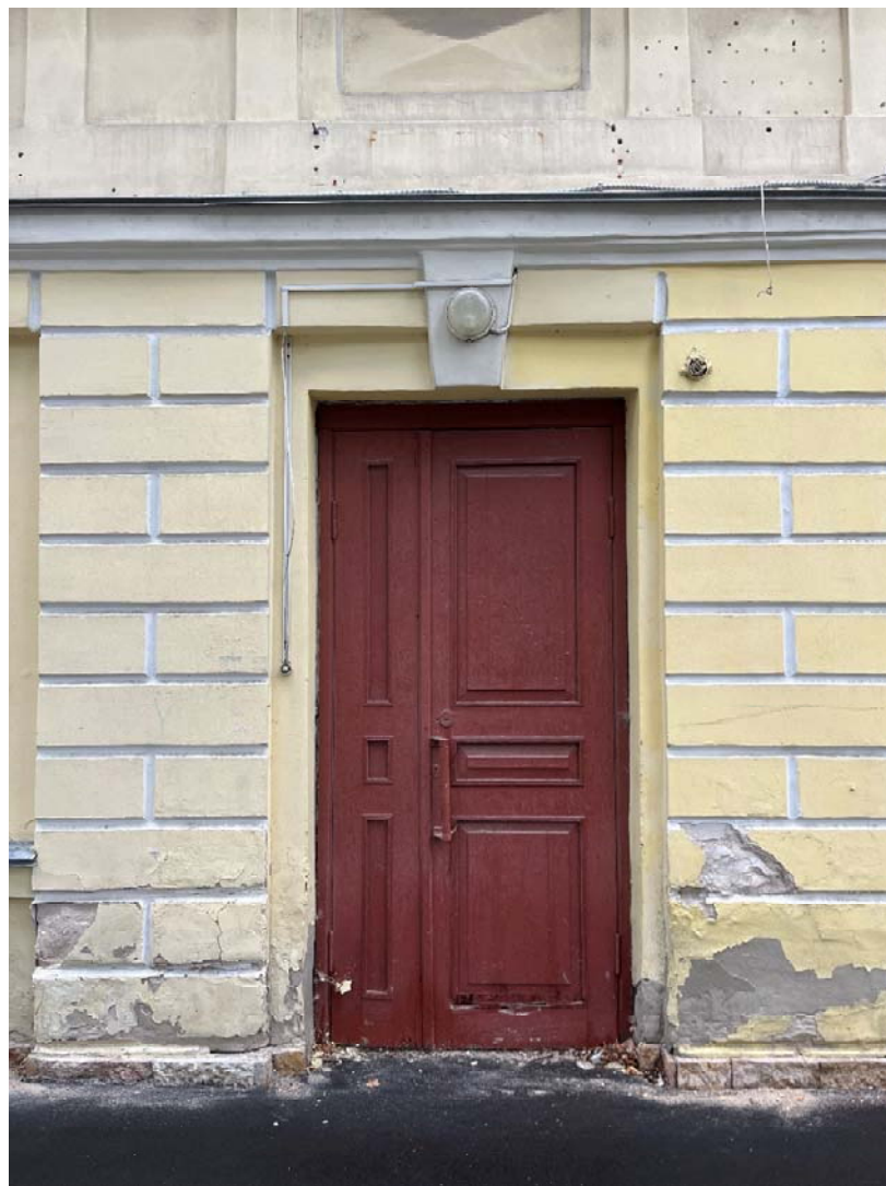
Фото №3. Юго-восточный лицевой фасад, вход в помещение №3-Н.
