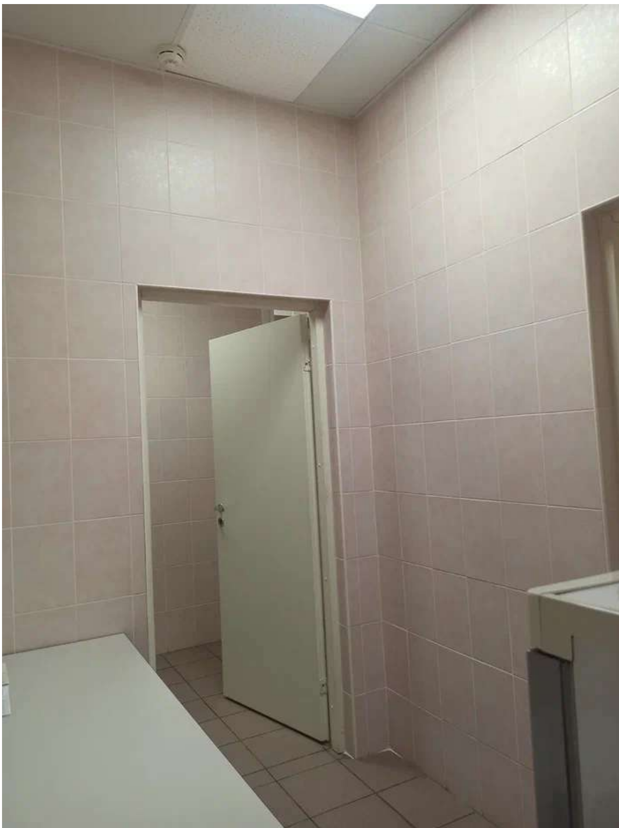
Фото 40. Помещение 125. Вид на помещение, выход в помещение 121.
