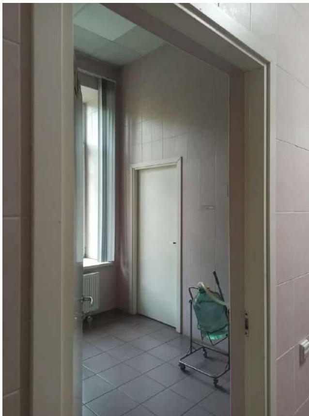
Фото 28. Помещение 121. Вид на помещение 122
