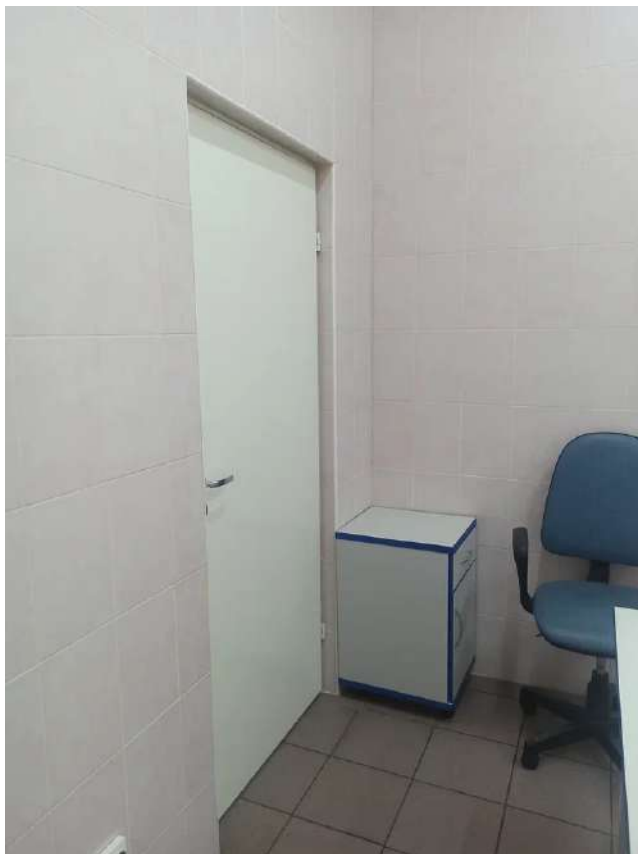
Фото 47. Помещение 124. Фрагмент вида входа в помещение 122.
