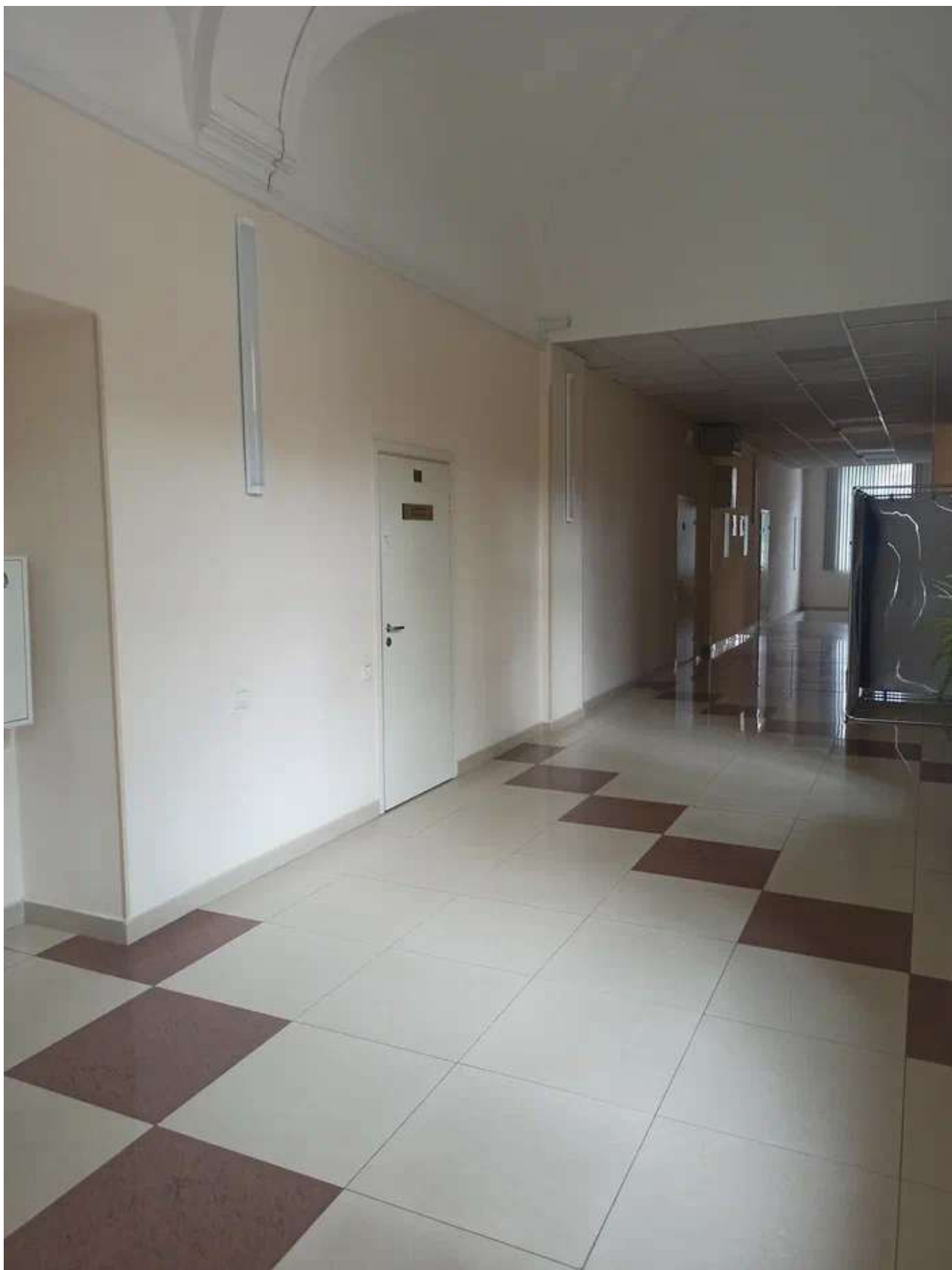
Фото 16. Помещение 138. Вид на вход в помещение 120.
