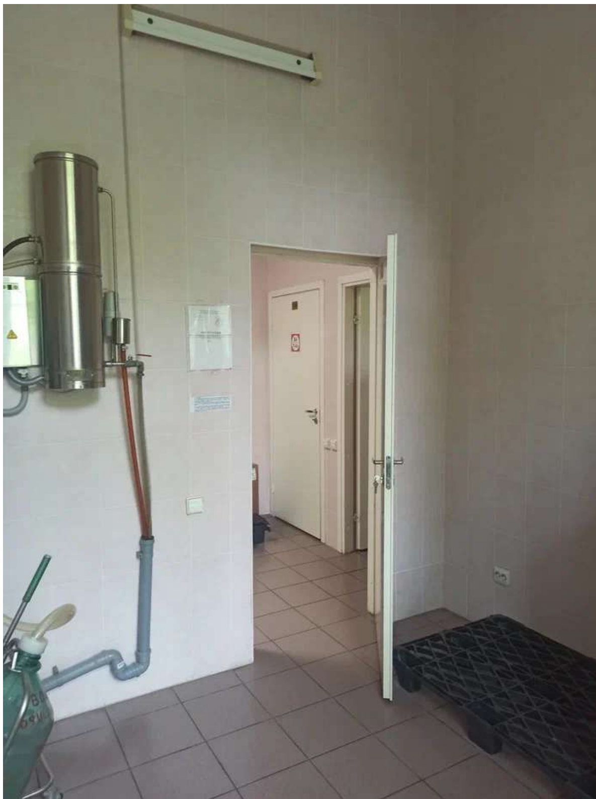
Фото 30. Помещение 122. Вид на выход в помещение 121 со стороны окна.
