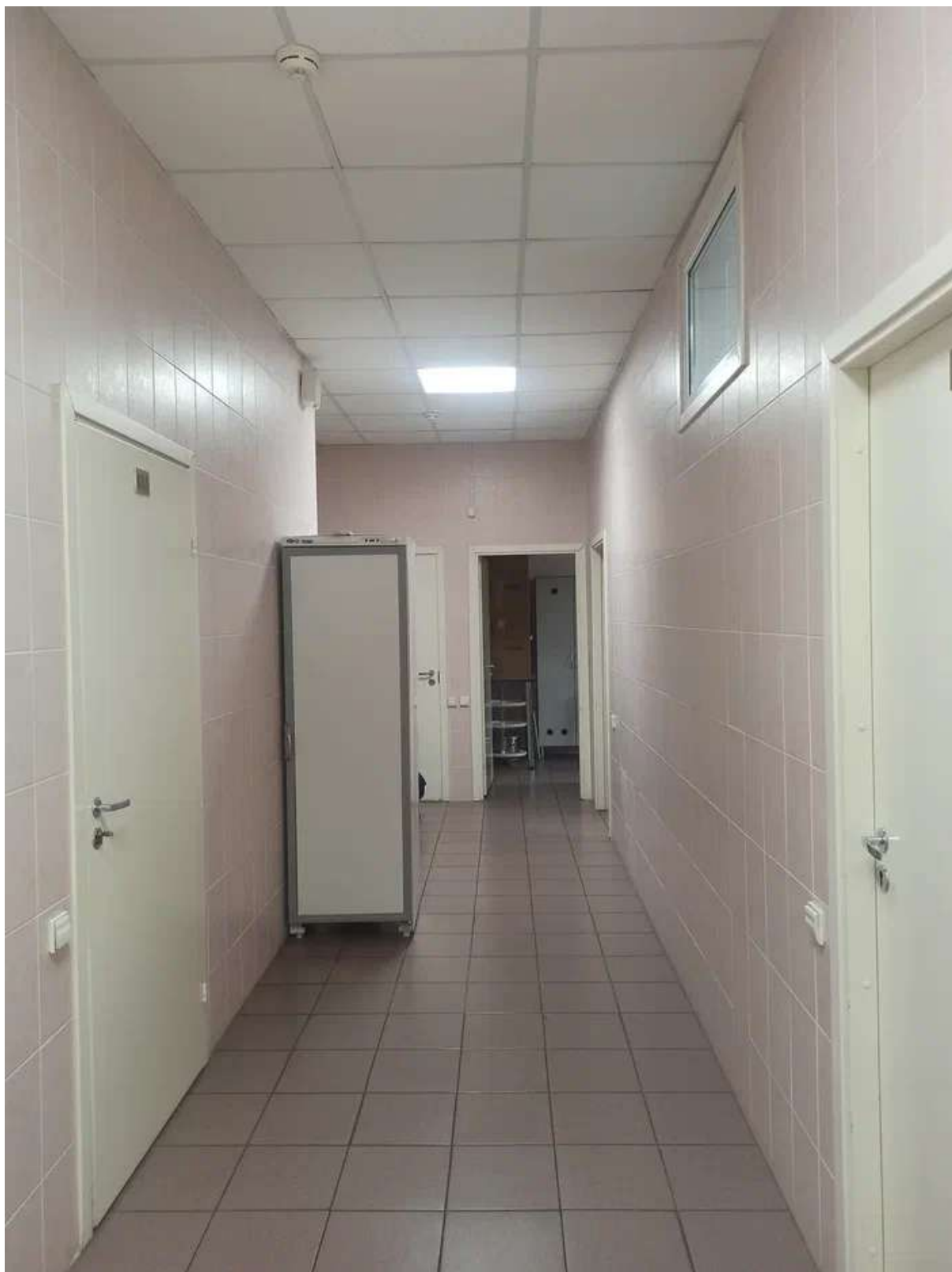
Фото 41. Помещение 121. Общий вид.
