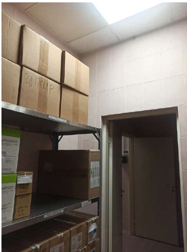
Фото 20. Помещение 119. Вид на обзорный проем, потолок.
