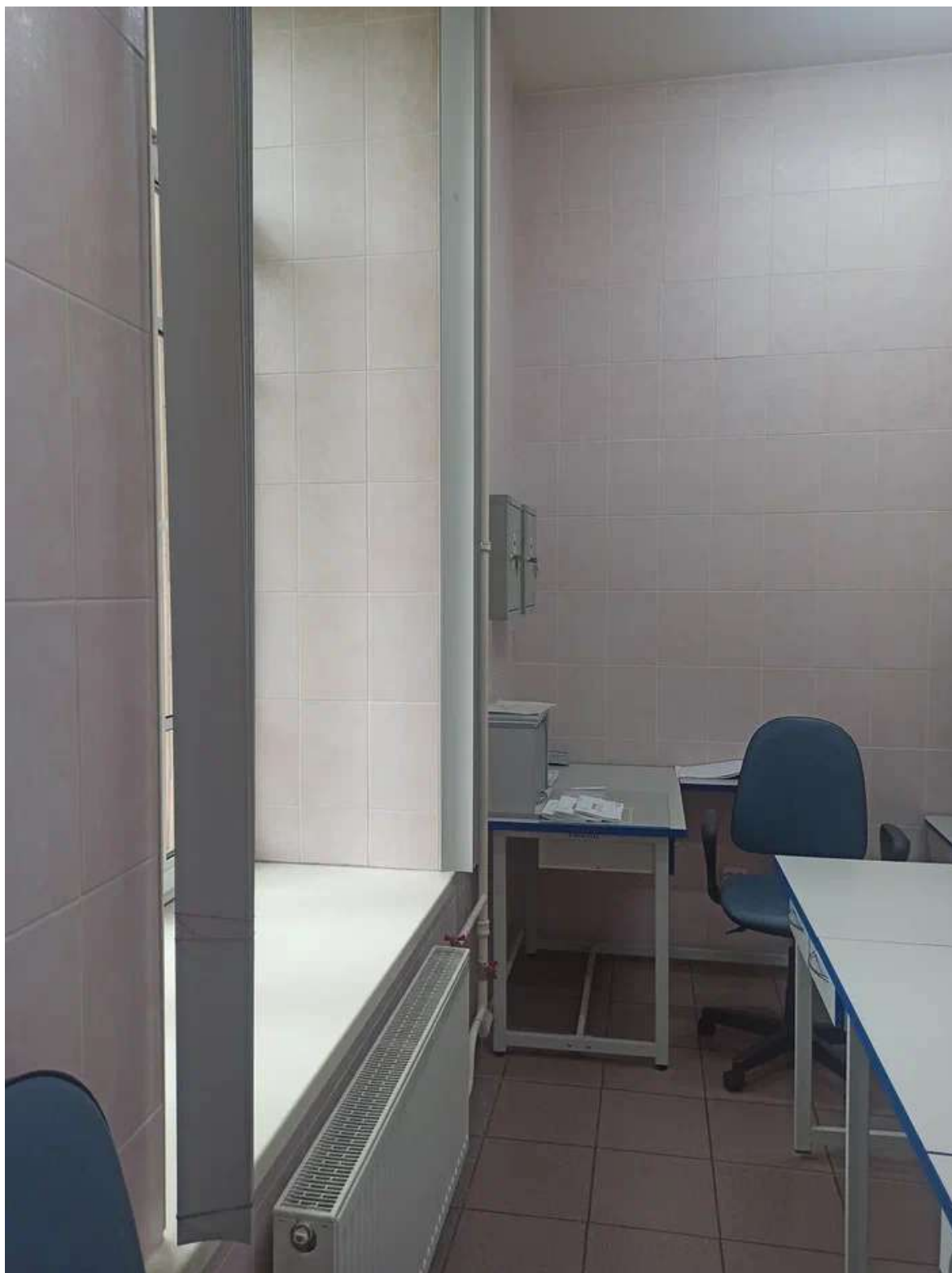
Фото 49. Помещение 124 Вид на оконный проем со стороны входа в помещение 122.
