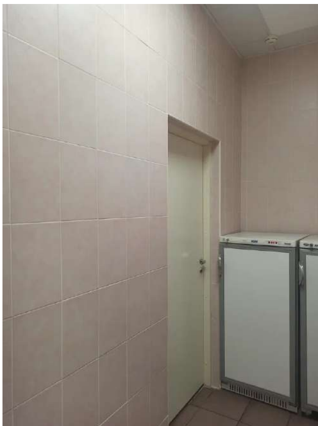
Фото 38. Помещение 125. Вид на вход в помещение 126.
