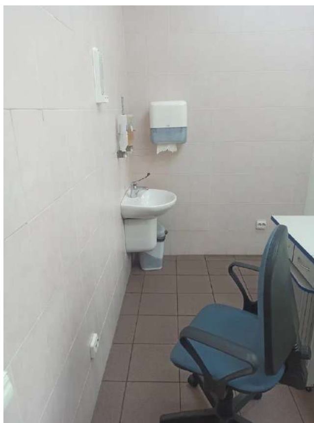
Фото 45. Помещение 124. Вид на мойку.
