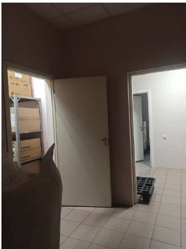
Фото 18. Помещение 120. Вид на входы в помещения 119 и 121 со стороны дверного проема.
