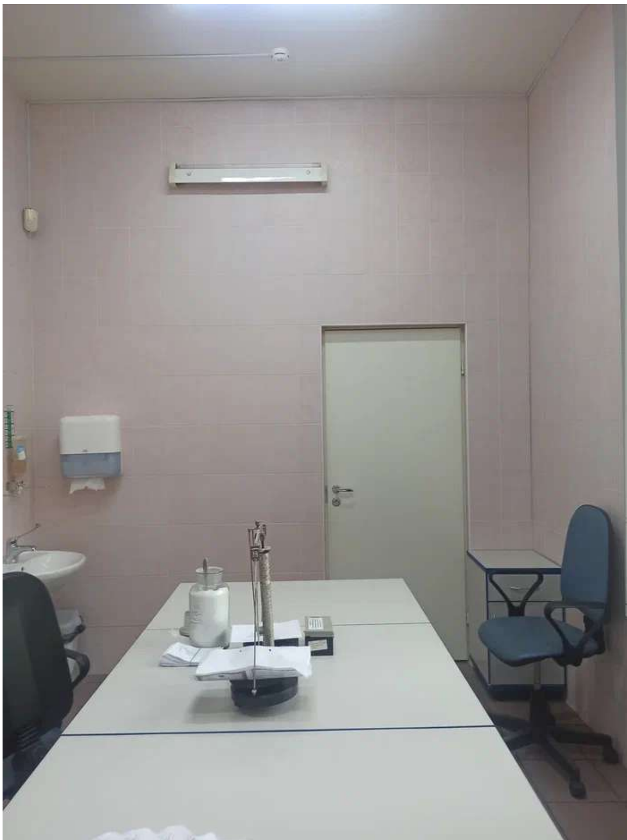
Фото 46. Помещение 124. Вид на вход в помещение 122.
