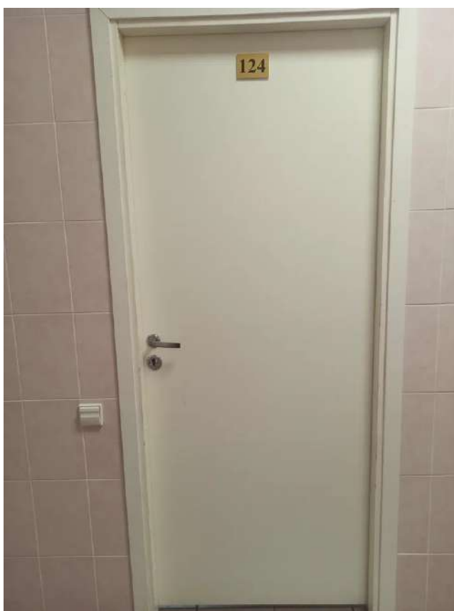
Фото 4.3. Помещение 121. Фрагмент вида дверного заполнения входа в помещение 124.
