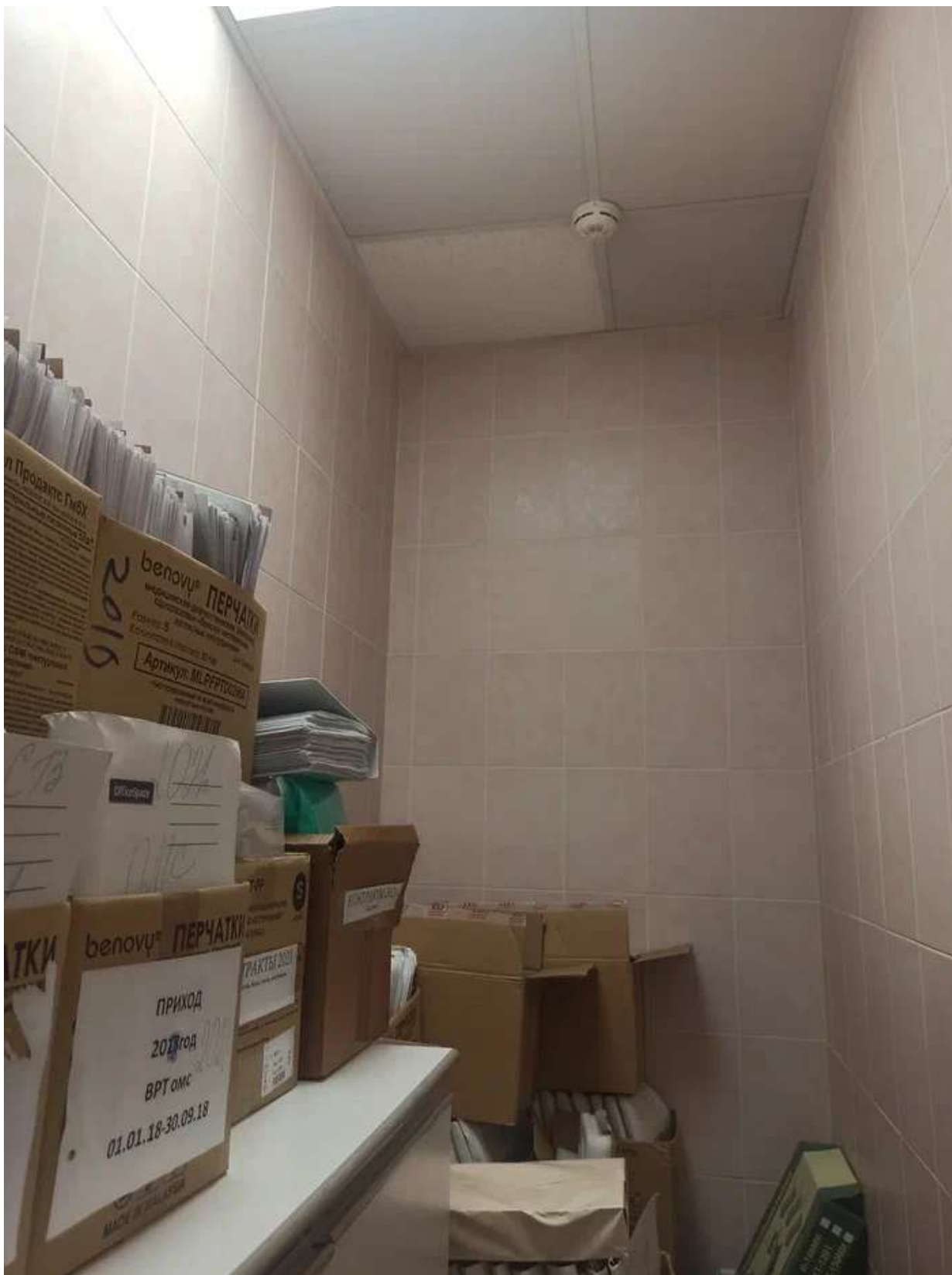
Фото 22. Помещение 118. Общий вид.
