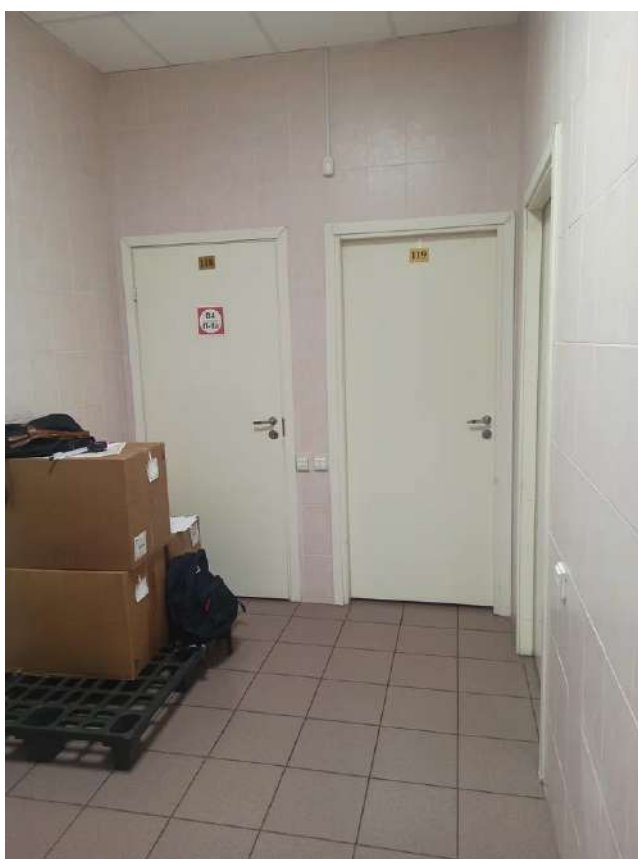
Фото 21. Помещение 121. Вид на входы в помещения 118 и 119.
