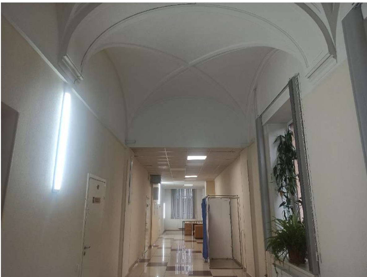
Фото 12. Помещение №138 по плану ПИБ. Общий вид
