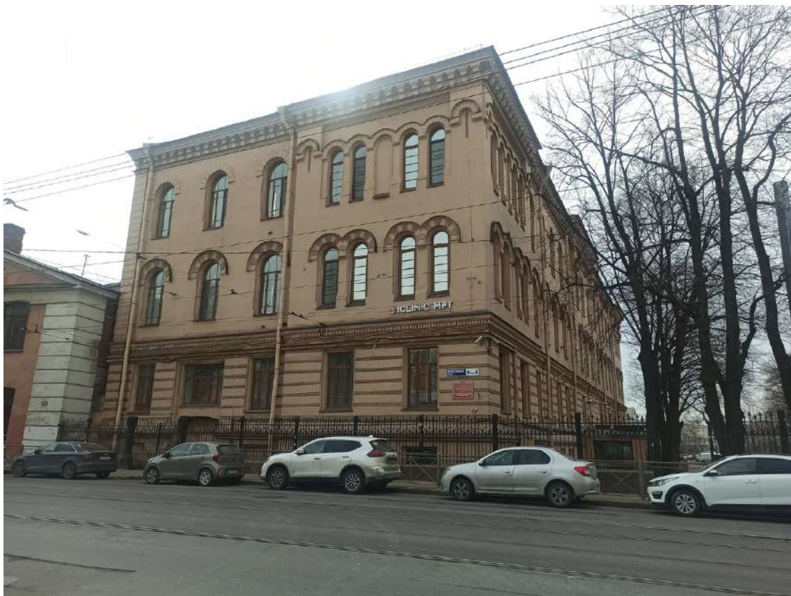
Фото 1. Общий вид на здание и ограду с ул. Комсомола
