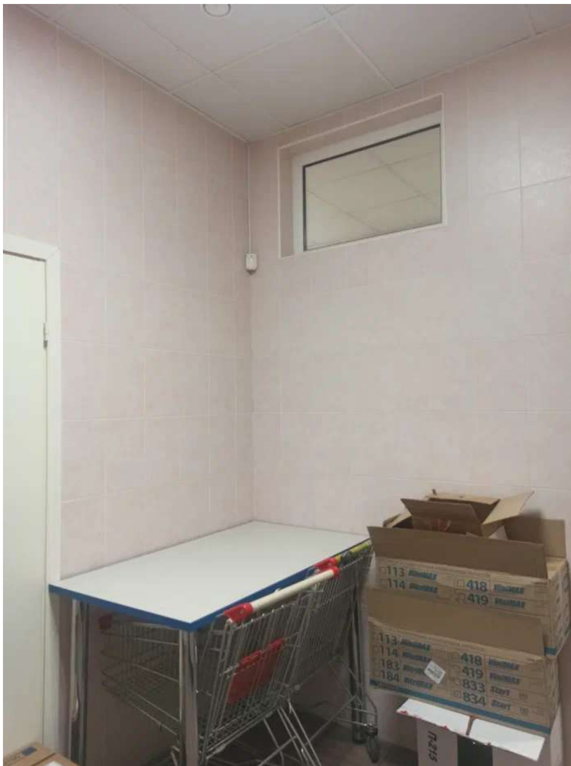
Фото 53. Помещение 3. Вид на окно в помещении 10.
