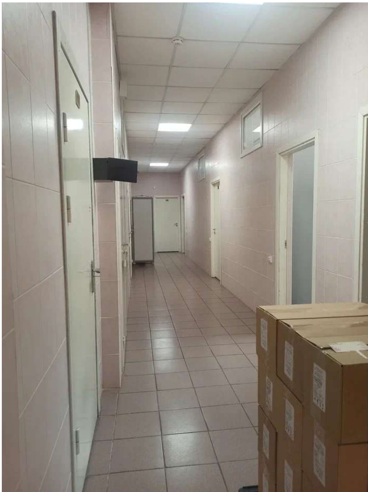
Фото 55. Помещение 10. Общий вид.
