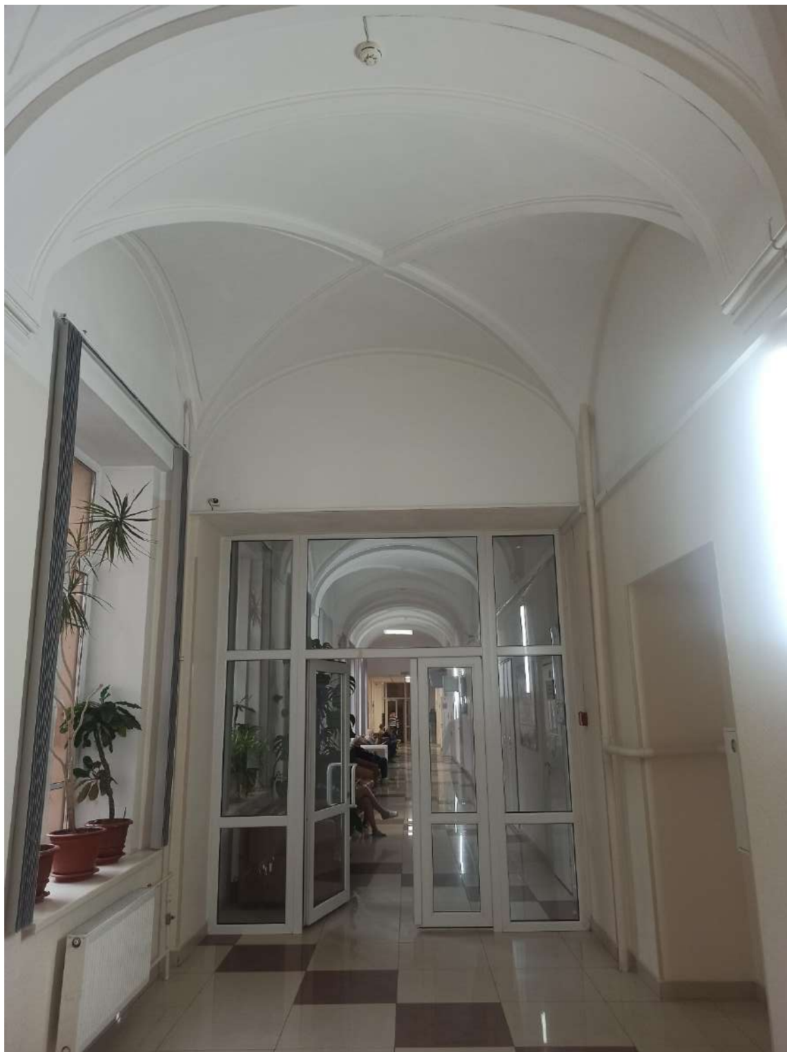
Фото 10. Помещение №138 по плану ПИБ. Вид на металлопластиковую перегородку, своды
