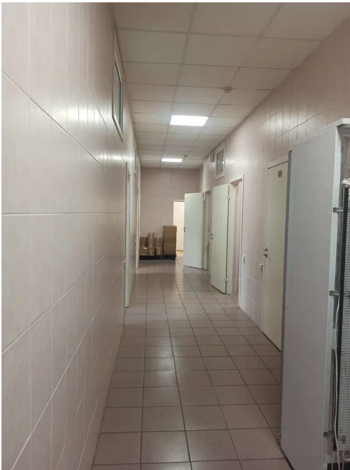
Фото 31. Помещение 121. Общий вид.
