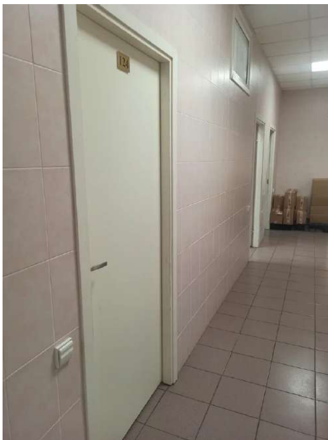
Фото 4.2. Помещение 121. Вид на вход в помещение 124.
