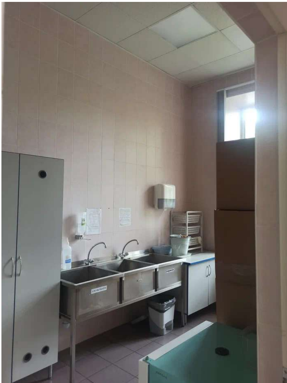
Фото 25. Помещение 119. Вид на помещение со стороны дверного проема.
