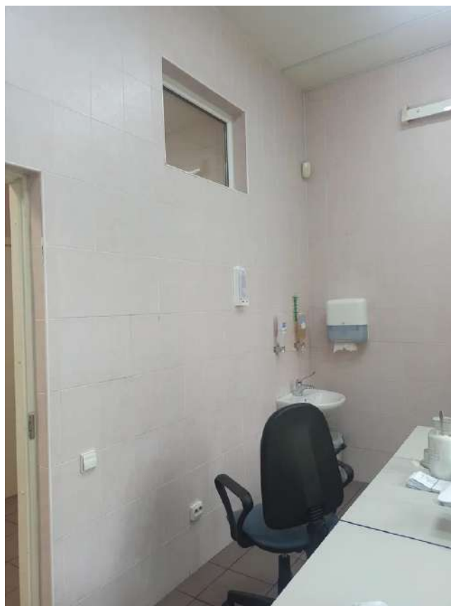
Фото 44. Помещение 124. Вид на окно в помещении 121.
