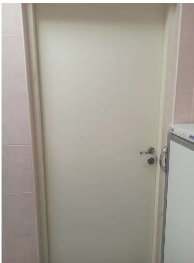
Фото 39. Помещение 125. Фрагмент вида дверного заполнения входа в помещение 126.
