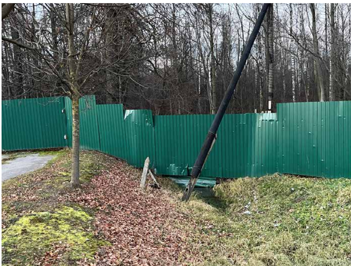
Фото 8. Вид на временное ограждение и прилегающую территорию вдоль северной границы объекта культурного наследия. Дата съемки: 20.11.2022
