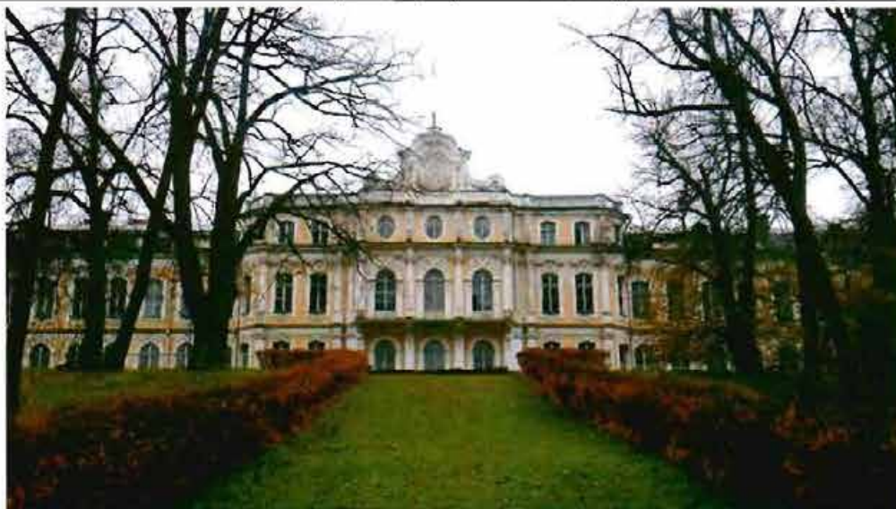
Фото 4. Общий вид на пандус с северной стороны (со стороны грота).
