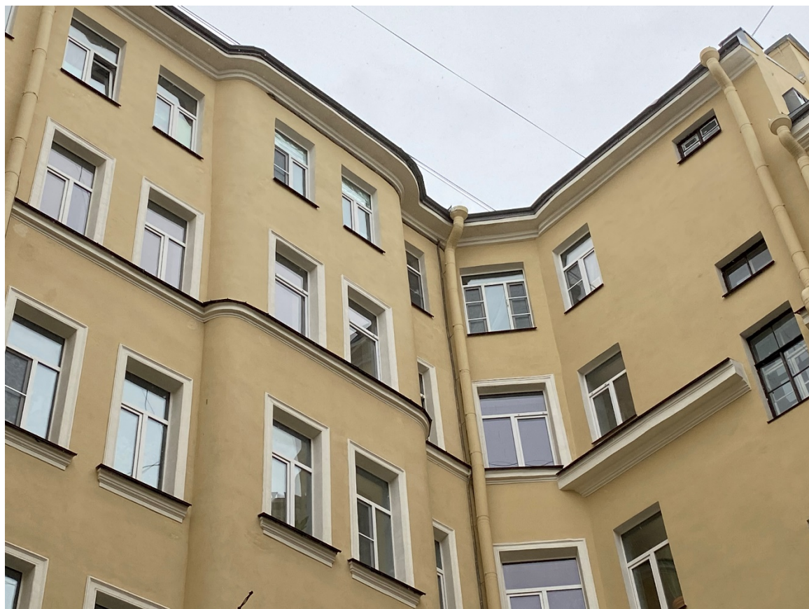
Фото 5. Фрагмент западного и северного фасадов выявленного объекта культурного наследия с оконными проемами в уровне 5-го этажа квартиры № 20.
