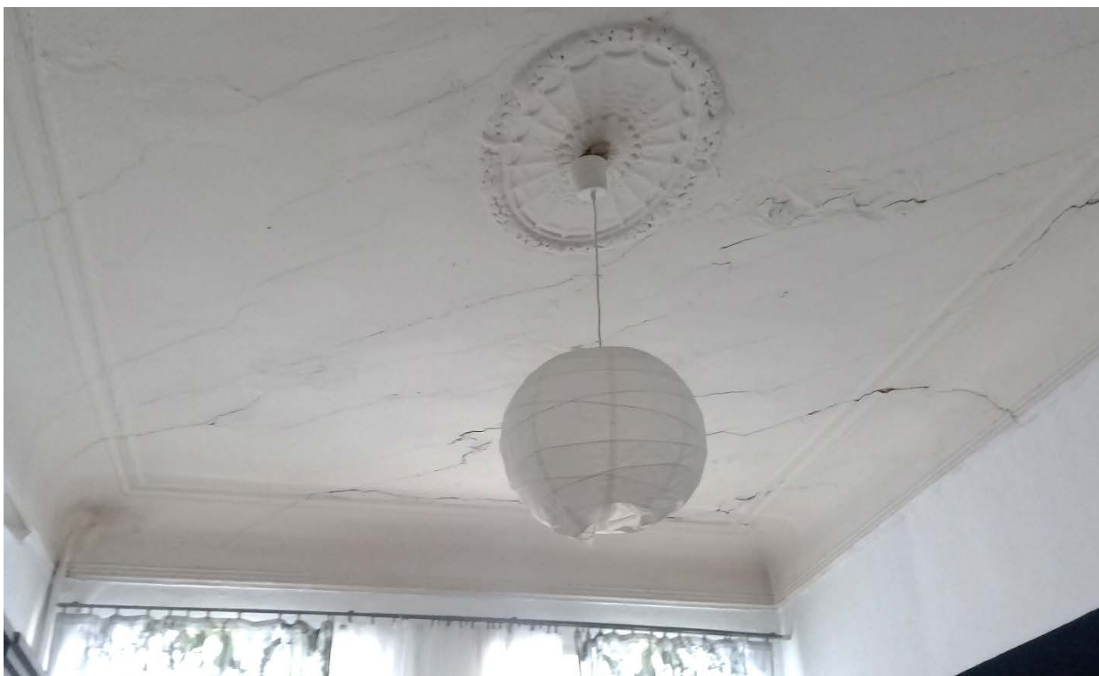
Фото 11. Потолок с розеткой в помещении комнаты № 3 (по техпаспорту).
