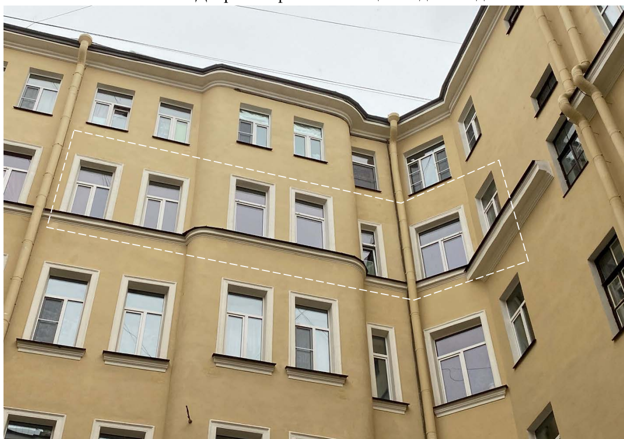
Фото 4. Фрагмент западного (слева) и северного (справа) фасадов выявленного объекта культурного наследия «Дом Л.Л., С.Л., и Д.Л. Фуфаевских» с оконными проемами в уровне 5-го этажа в границах квартиры № 20.
