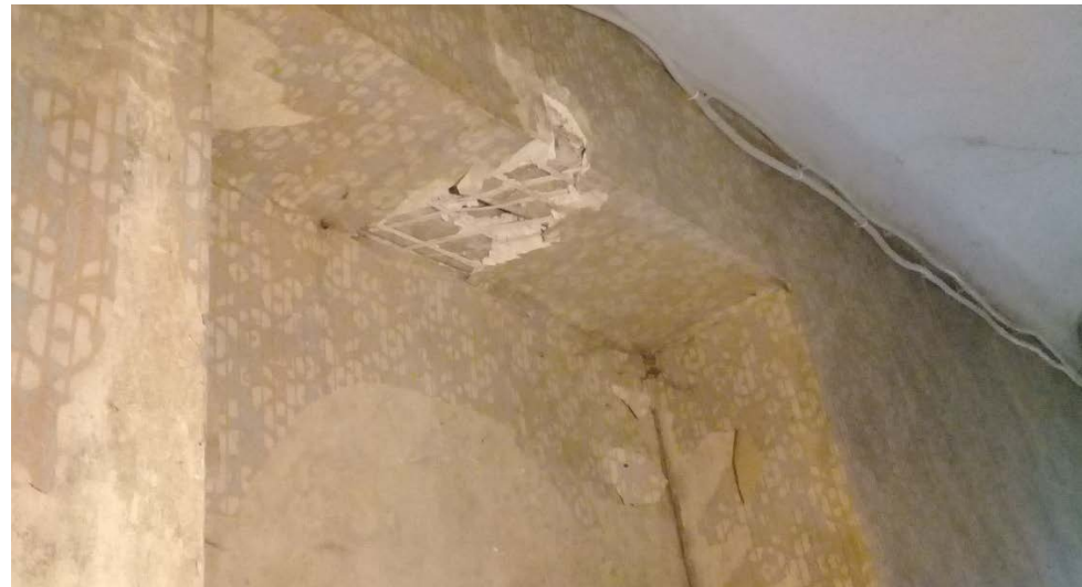
Фото 16. Ниша в помещении коридора № 7.
