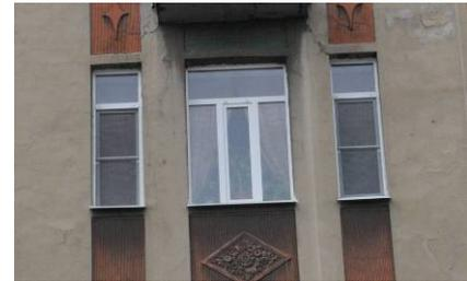
проем балконной двери в уровне 2-го этажа, габариты, конфигурация (проем фланкирован двумя щелевидными оконными проемами- дверной и оконные проемы объединенными лучковой перемычкой);
