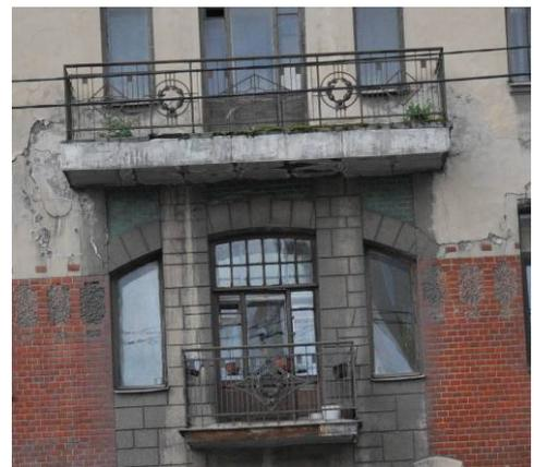
ограждение из черного металла, техника исполнения (прокат, литье, ковка), рисунок ограждения (стержни прямоугольного сечения с наложенными на них: тремя ромбами (лавровый венок и восьмилепестковые розетки в центре ромбов);
