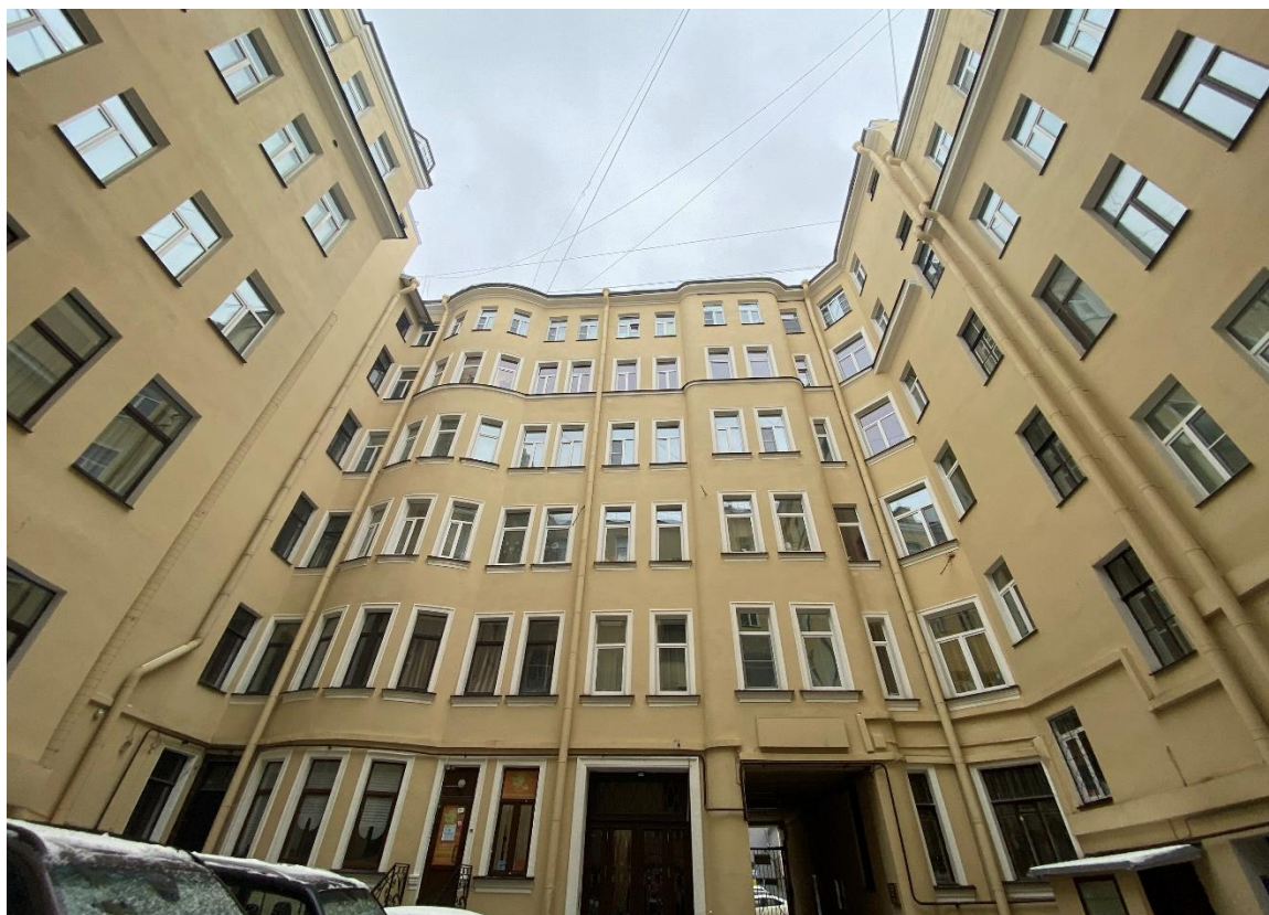
Фото 3. Дворовые флигели выявленного объекта культурного наследия «Дом Л.Л., С.Л., и Д.Л. Фуфаевских». Общий вид со двора.
