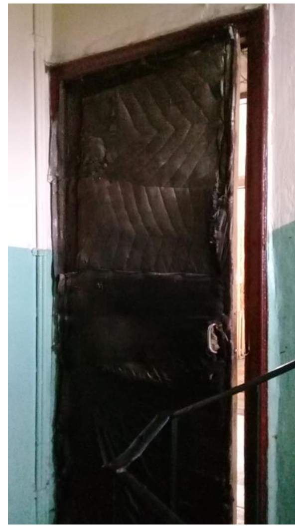
Фото 31. Дверное заполнение входа в квартиру № 30 со стороны черной лестницы.
