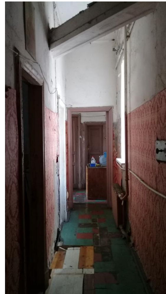
Фото 25. Фрагмент пом. коридора № 5.
