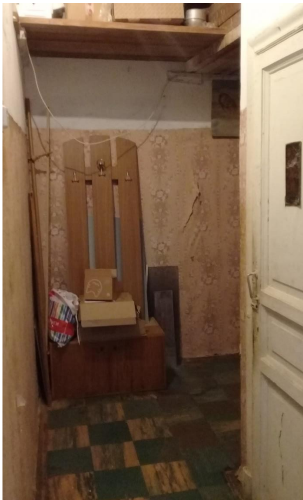
Фото 23. Фрагмент пом. коридора № 5.
