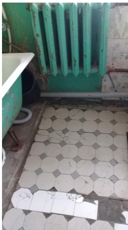
Фото 21. Напольное покрытие из метлахской плитки в ванной № 6.
