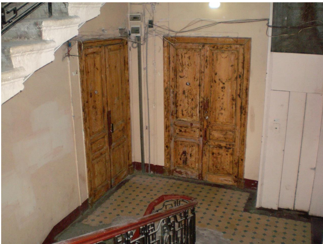
Фото 7. Общий вид помещения парадной лестничной клетки ЛЗ с дверными проемами входов в квартиры № 30 (слева) и № 20 (справа).
