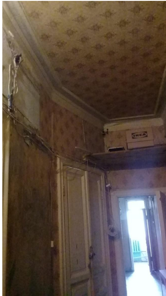
Фото 10. Общий вид помещения коридора № 1 (по техпаспорту).
