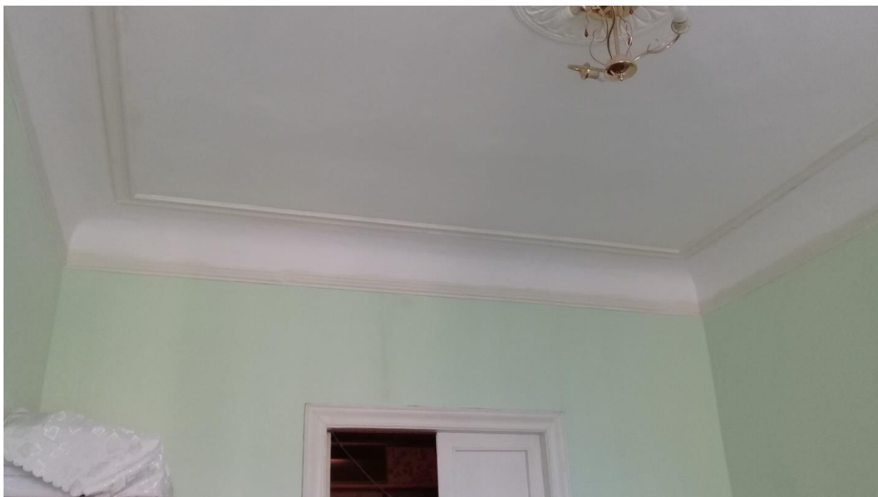
Фото 12. Оформление потолка в помещении комнаты № 2 (по техпаспорту).
