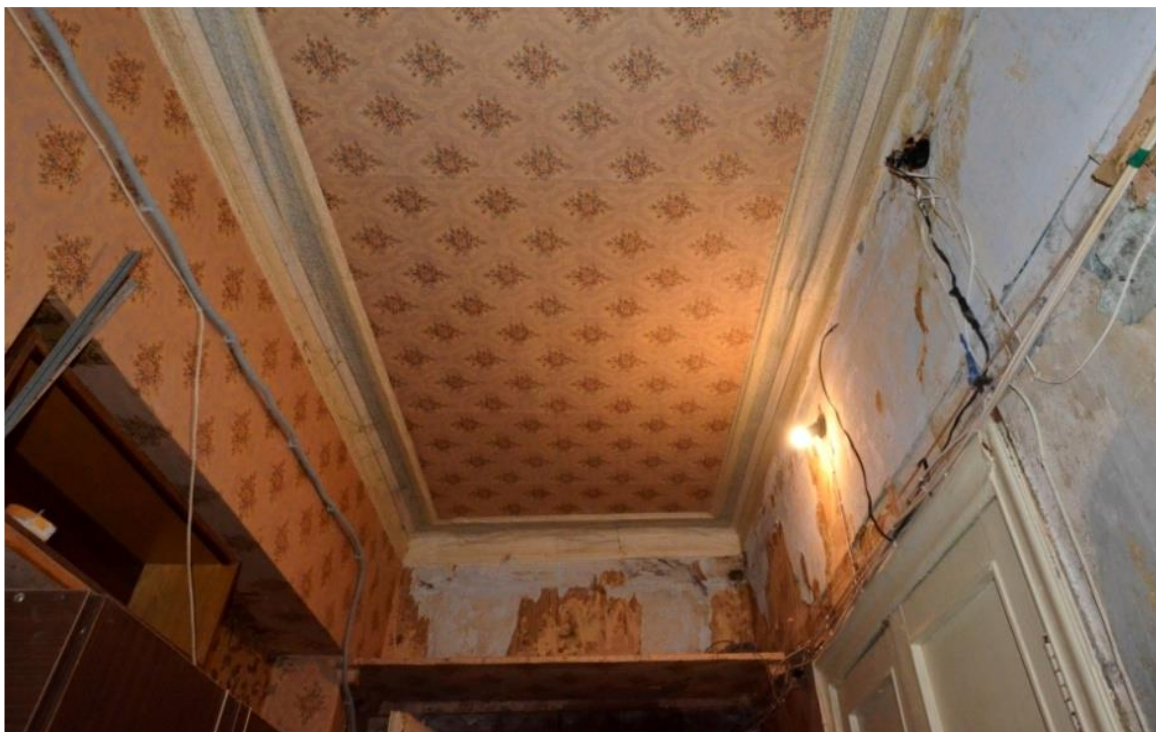
Фото 8. Фрагмент помещения коридора № 1, слева – ниша в стене (нумерация помещений указана по техпаспорту квартиры № 30).
