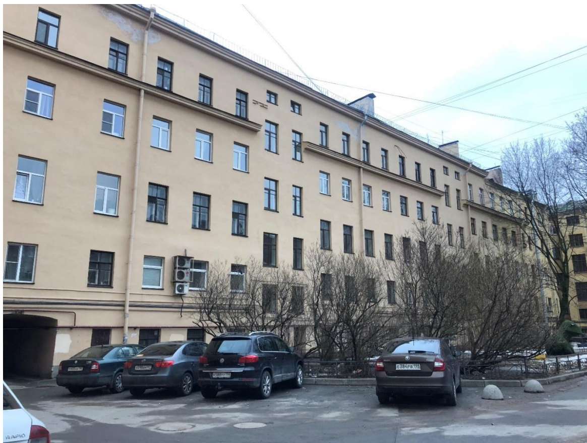
Фото 5. Вид на дворовый фасад дома № 15.
