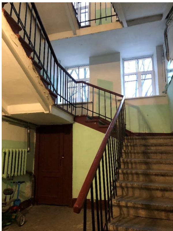
Фото 1. Вид на лестницу.
