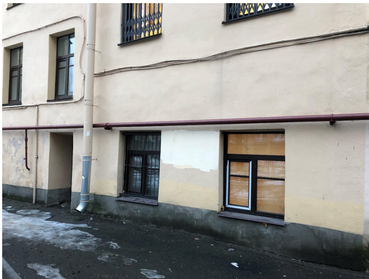
Фото 6. Заполнения оконных проемов исследуемой квартиры со стороны дворового фасада.
