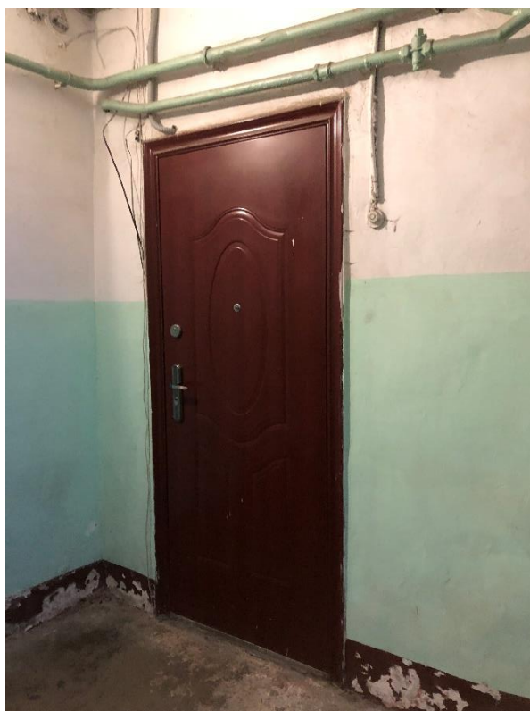
Фото 2. Вид на входную дверь квартиры № 22.
