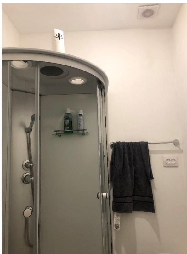
Фото 8. Вид на помещение № 6.
