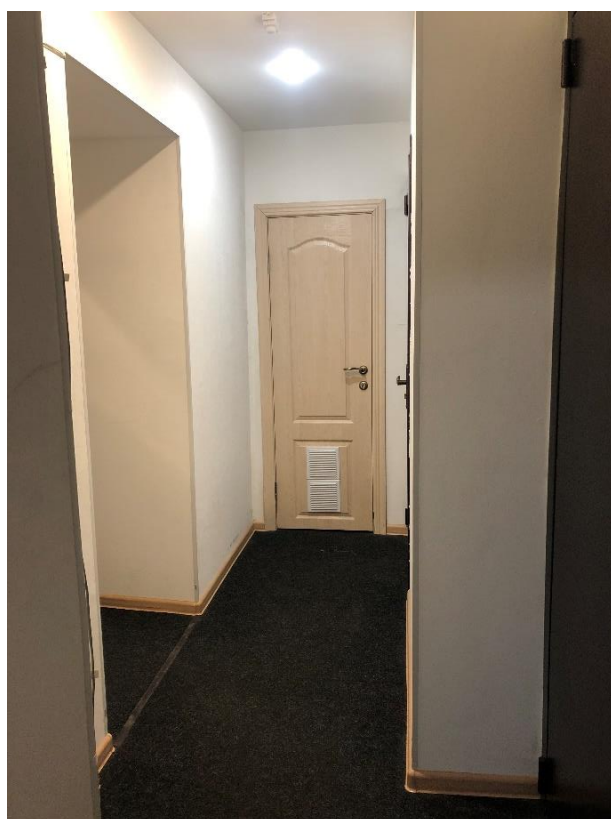
Фото 3. Вид на помещение № 1.
