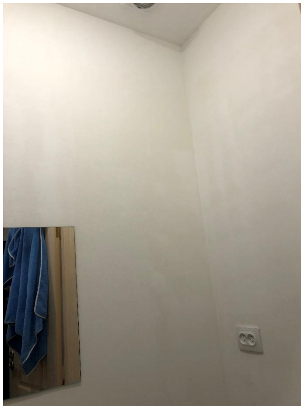
Фото 10. Вид на помещение № 8.
