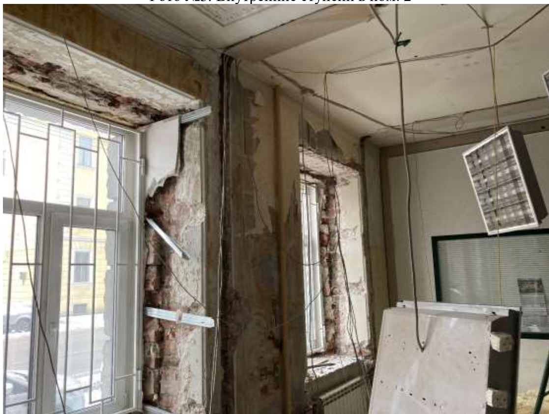
Фото №6. Часть пом. 2 после демонтажа отделки
