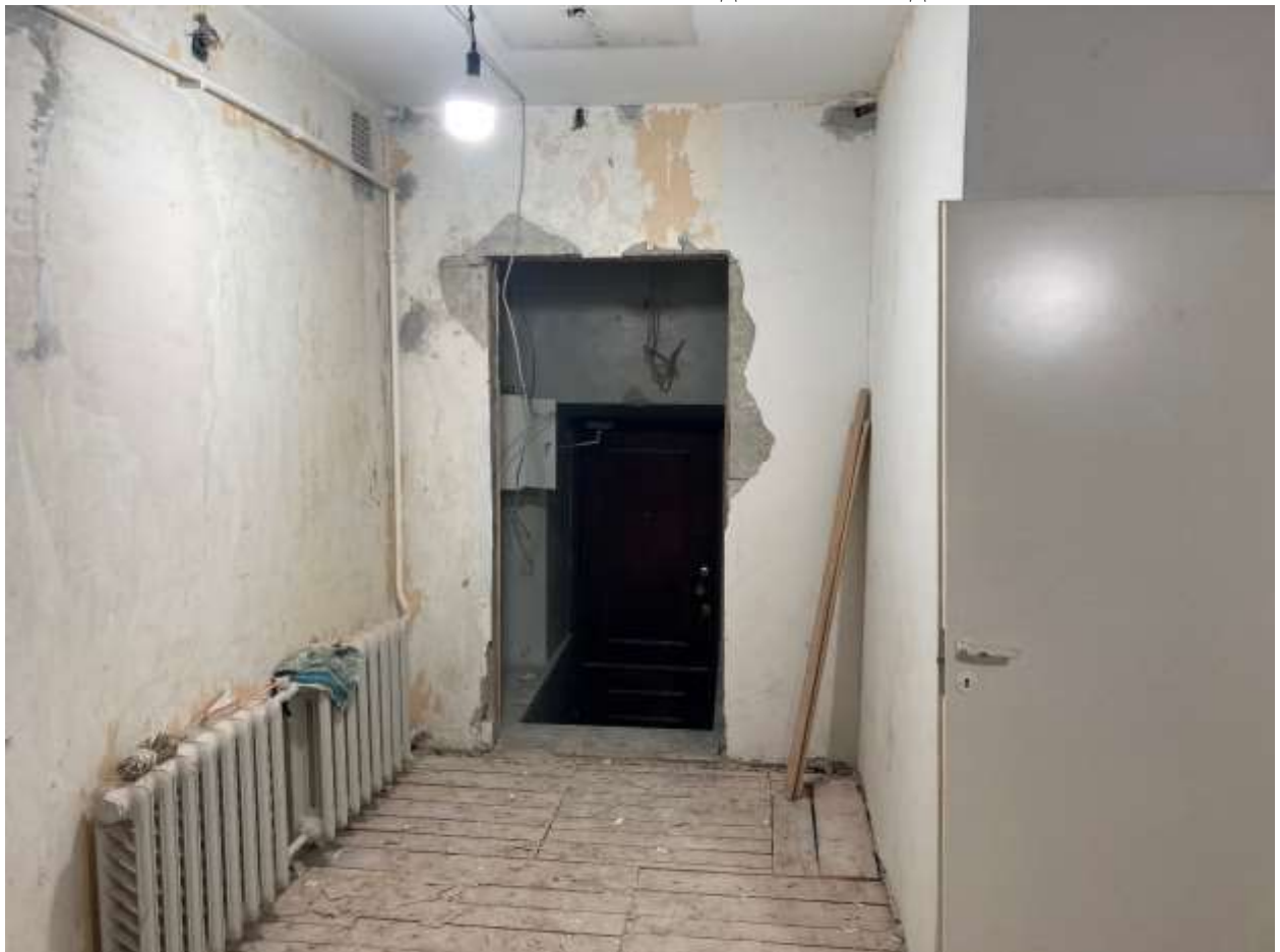
Фото №10. Часть пом. 6 после демонтажа отделки
