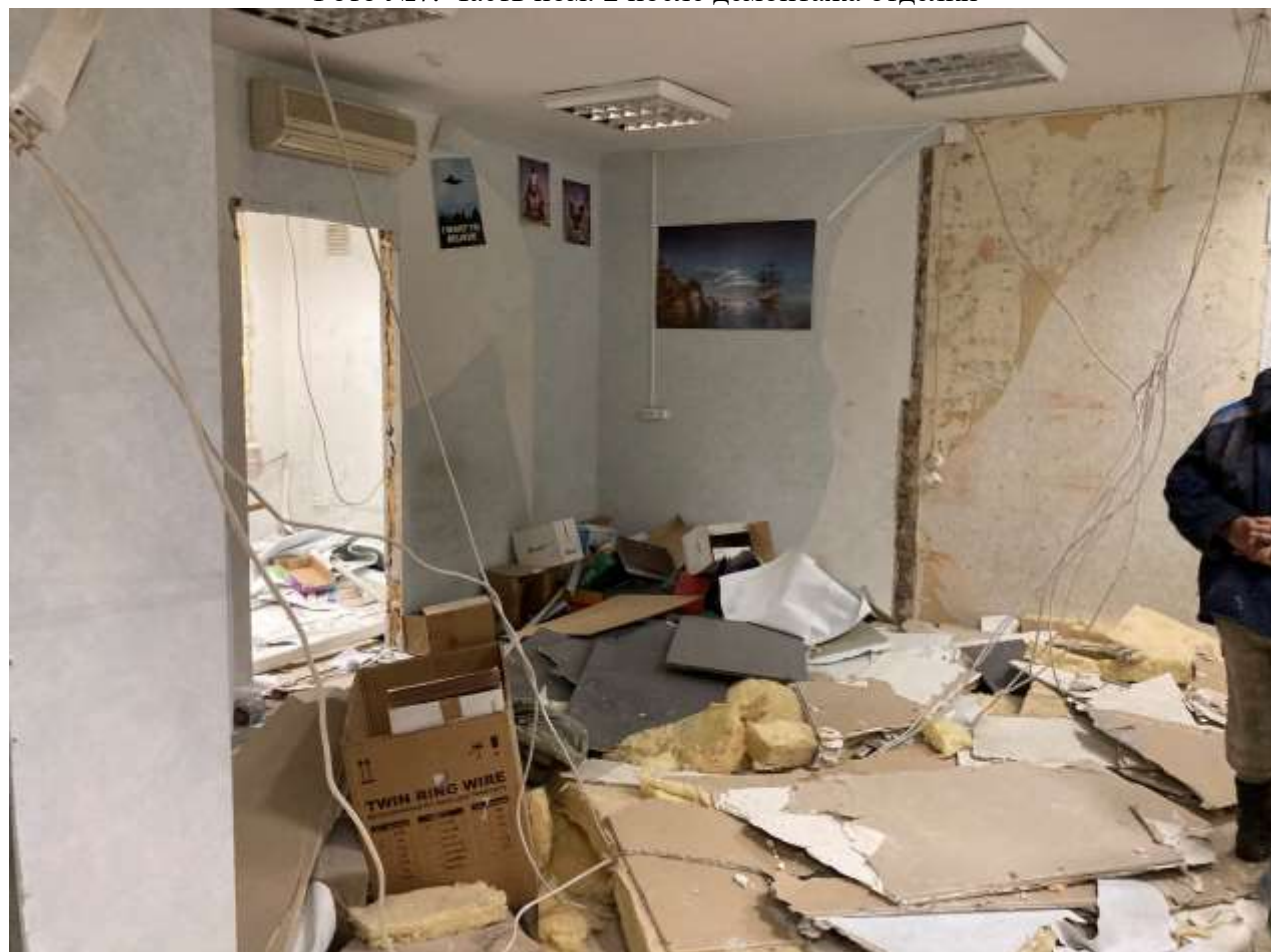
Фото №8. Часть пом. 13 после демонтажа отделки
