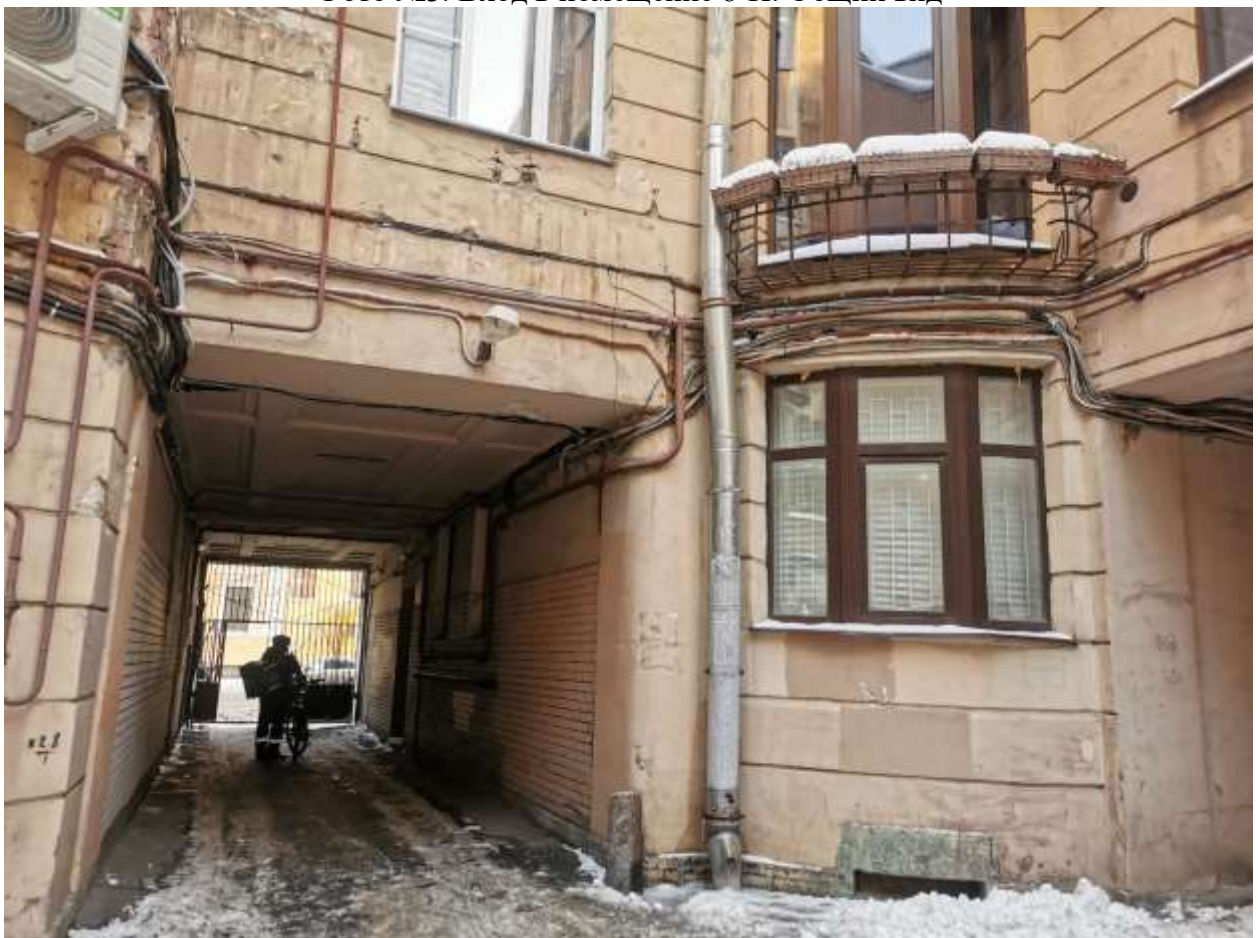
Фото №4. Оконное заполнение со стороны дворового фасада
