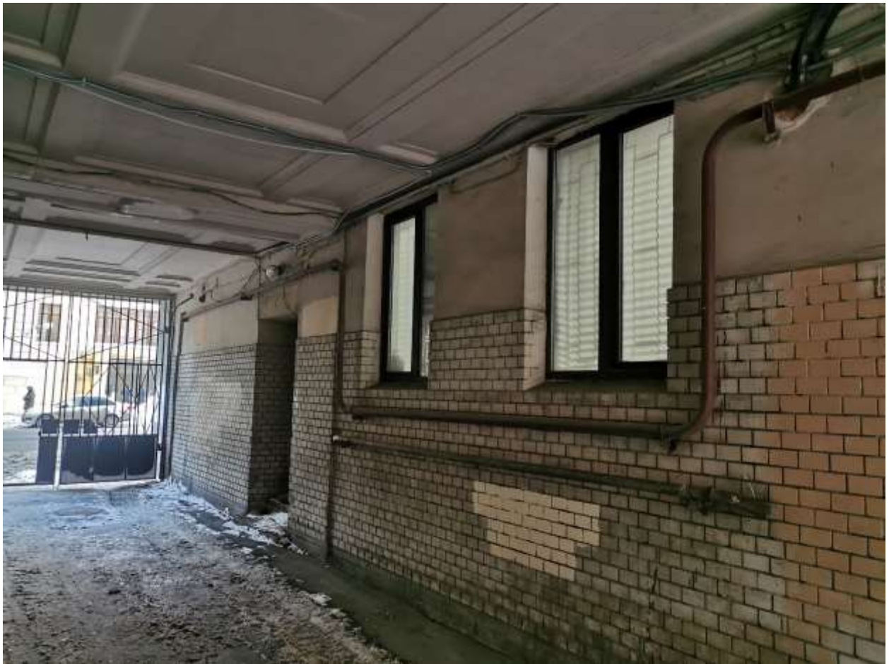
Фото №3. Вход в помещение 8-Н. Общий вид
