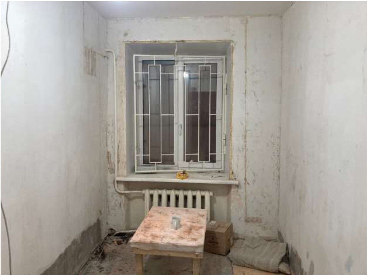
Фото №9. Часть пом. 10 после демонтажа отделки
