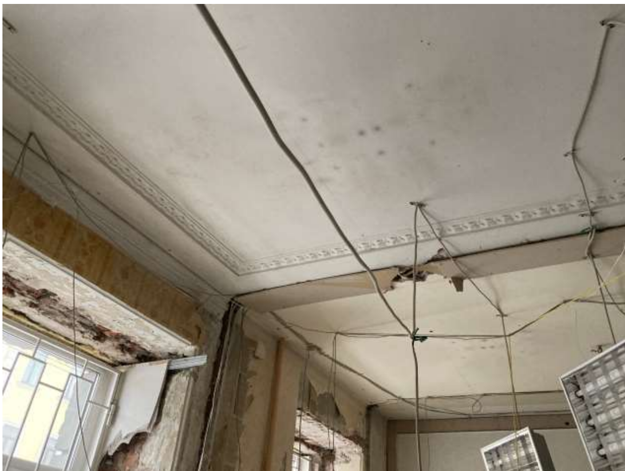
Фото №7. Часть пом. 2 после демонтажа отделки
