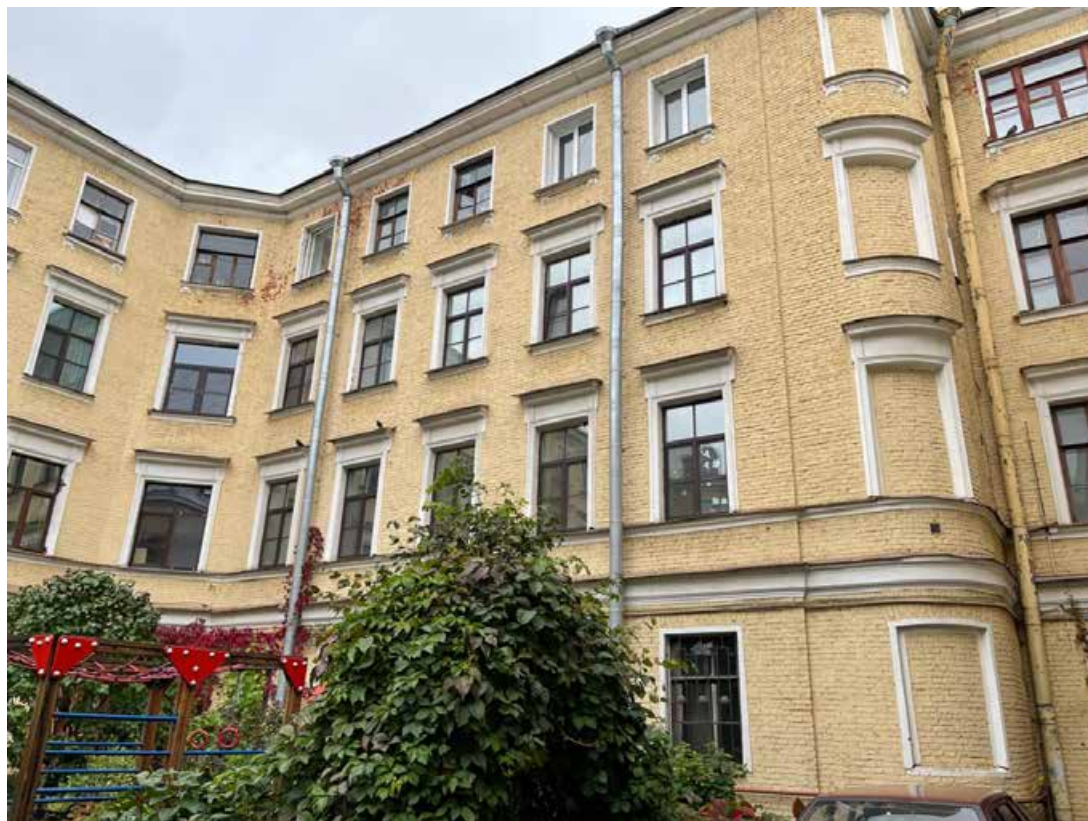
23. Дворовый корпус, первый двор (фрагмент). Выявленный объект культурного наследия «Дом Ю. Н. Адельсон», расположенный по адресу: г. Санкт-Петербург, Гороховая ул, дом 33, литера А
