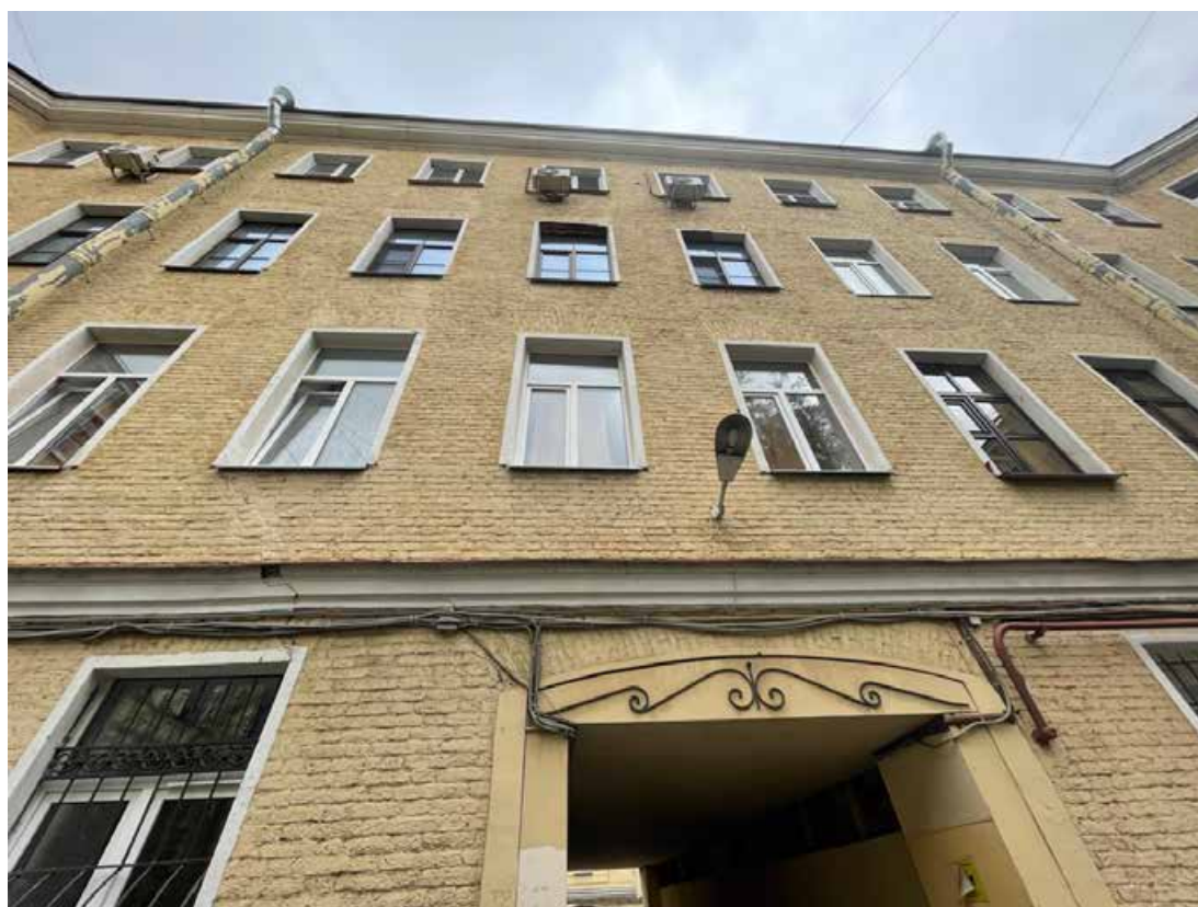
28. Дворовый корпус, второй двор (фрагмент). Выявленный объект культурного наследия «Дом Ю. Н. Адельсон», расположенный по адресу: г. Санкт-Петербург, Гороховая ул, дом 33, литера А
