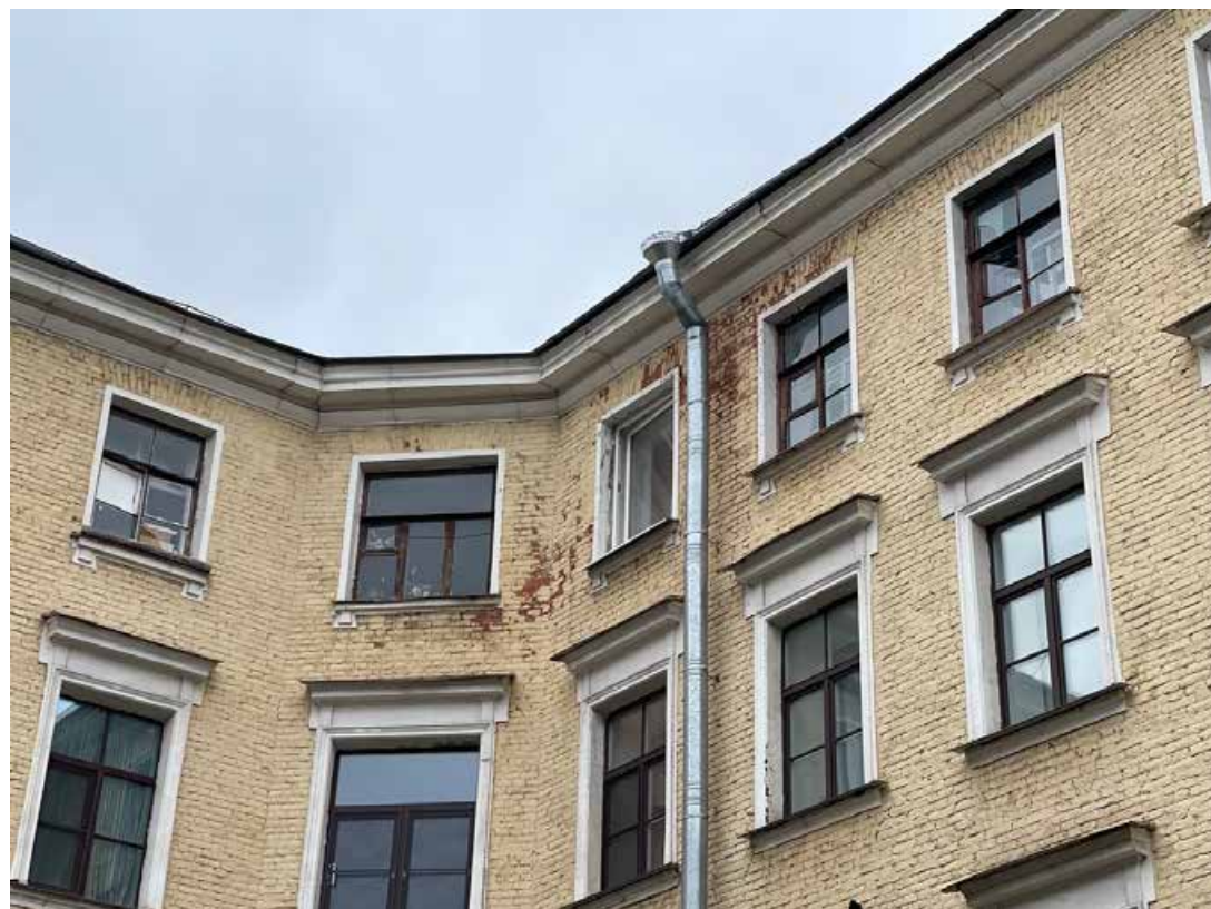
24. Дворовый корпус, первый двор (фрагмент). Выявленный объект культурного наследия «Дом Ю. Н. Адельсон», расположенный по адресу: г. Санкт-Петербург, Гороховая ул, дом 33, литера А
