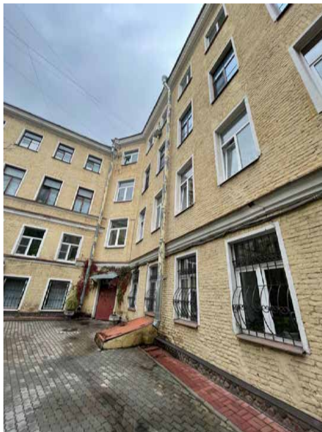
27. Дворовый корпус, второй двор (фрагмент). Выявленный объект культурного наследия «Дом Ю. Н. Адельсон», расположенный по адресу: г. Санкт-Петербург, Гороховая ул, дом 33, литера А
