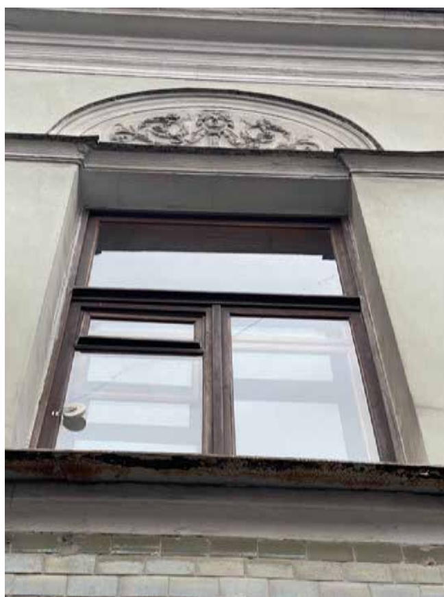
12. Деревянное заполнение оконного проема по световой оси 9 в уровне 2 этажа. Выявленный объект культурного наследия «Дом Ю. Н. Адельсон», расположенный по адресу: г. Санкт-Петербург, Гороховая ул, дом 33, литера А
