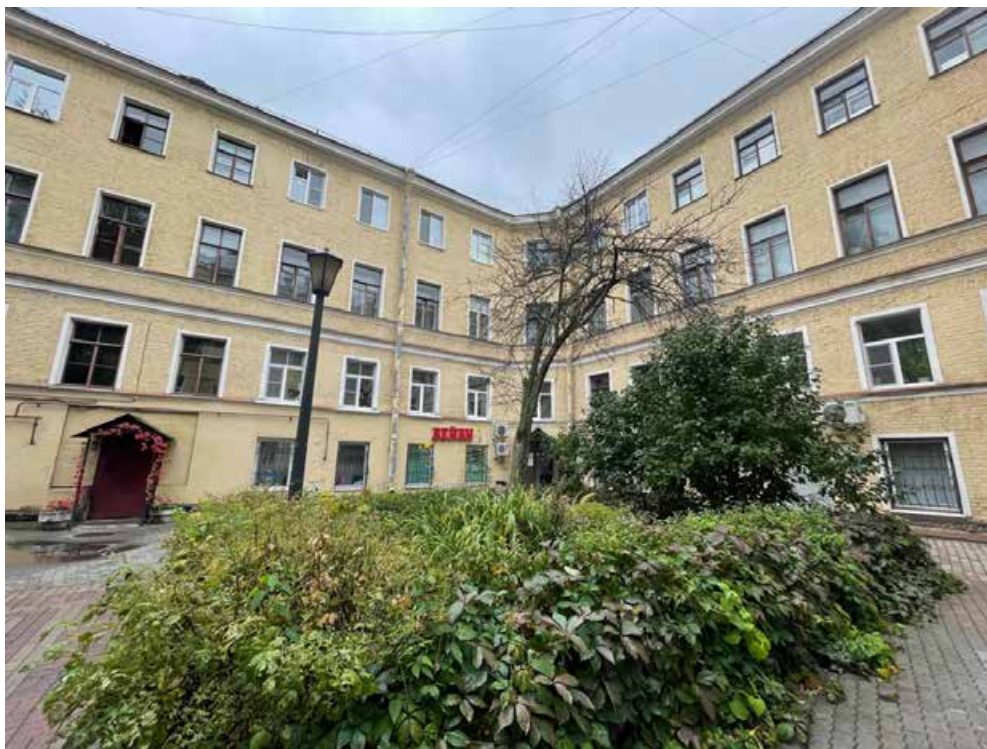
31. Дворовый корпус, второй двор (фрагмент). Выявленный объект культурного наследия «Дом Ю. Н. Адельсон», расположенный по адресу: г. Санкт-Петербург, Гороховая ул, дом 33, литера А
