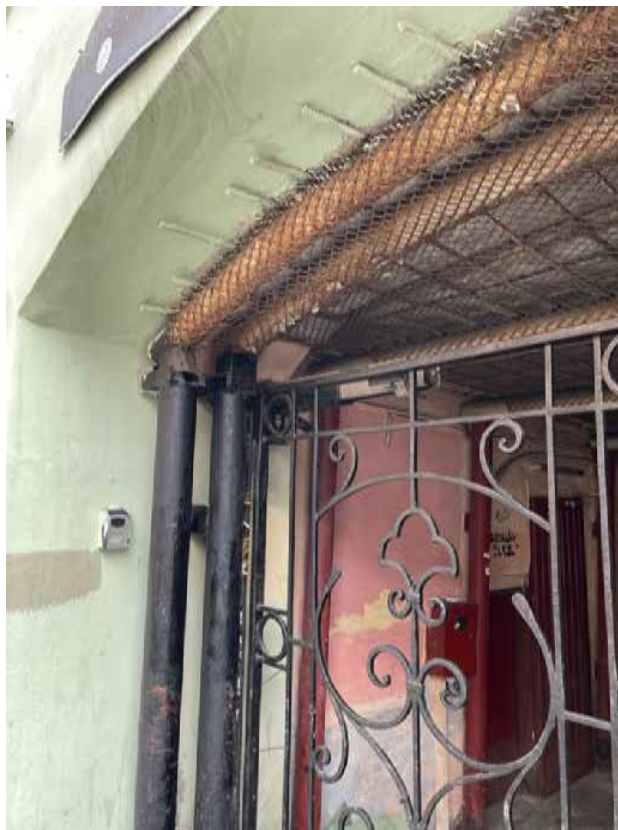
11. Фрагмент проездных ворот со стороны лицевого фасада. Выявленный объект культурного наследия «Дом Ю. Н. Адельсон», расположенный по адресу: г. Санкт-Петербург, Гороховая ул, дом 33, литера А
