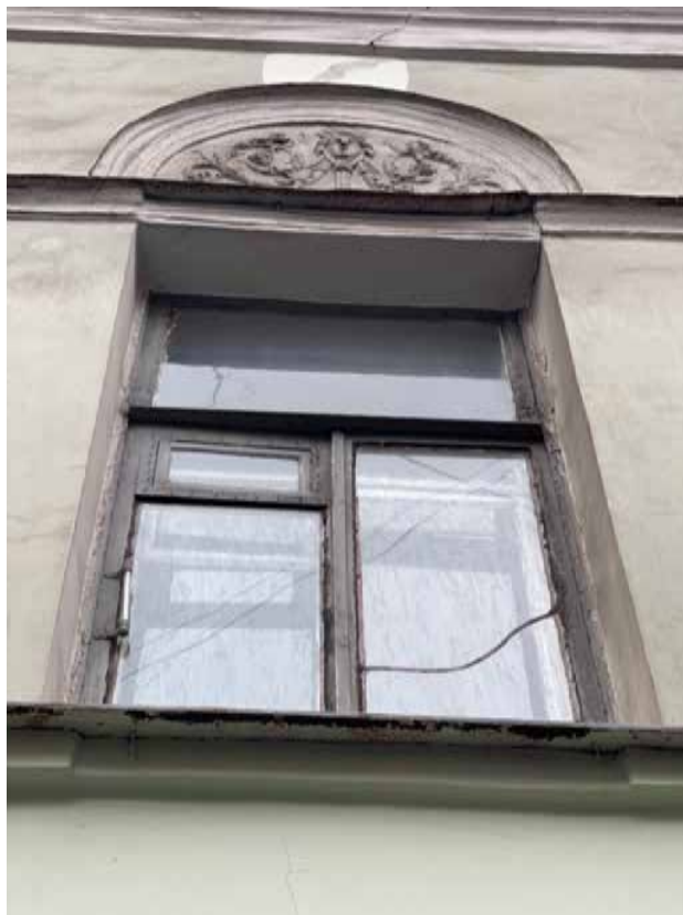
13. Деревянное заполнение оконного проема по световой оси 14 в уровне 2 этажа. Выявленный объект культурного наследия «Дом Ю. Н. Адельсон», расположенный по адресу: г. Санкт-Петербург, Гороховая ул, дом 33, литера А
