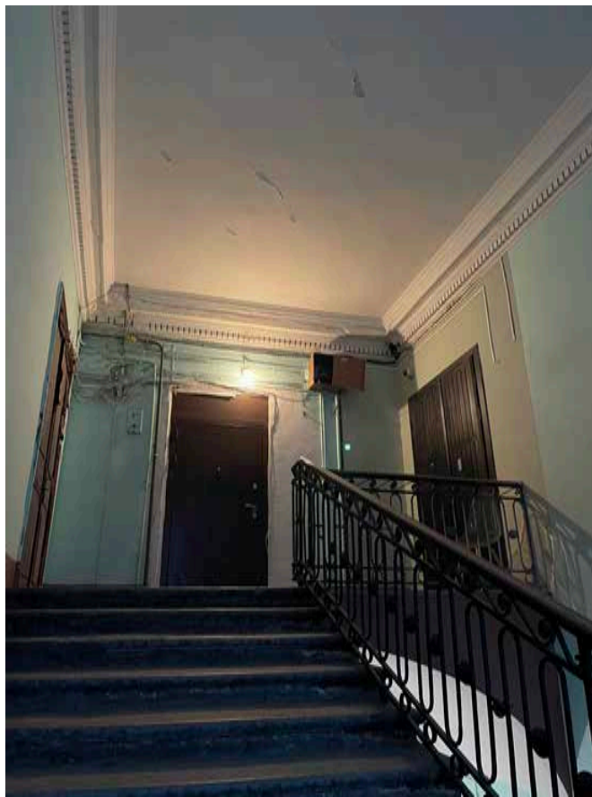
41. Перекрытие лестничной клетки и профилированный карниз с дентикулами. Выявленный объект культурного наследия «Дом Ю. Н. Адельсон», расположенный по адресу: г. Санкт-Петербург, Гороховая ул, дом 33, литера А
