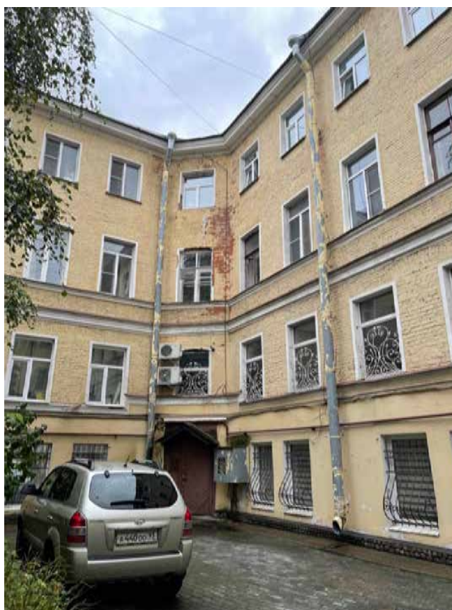
32. Дворовый корпус, второй двор (фрагмент). Выявленный объект культурного наследия «Дом Ю. Н. Адельсон», расположенный по адресу: г. Санкт-Петербург, Гороховая ул, дом 33, литера А
