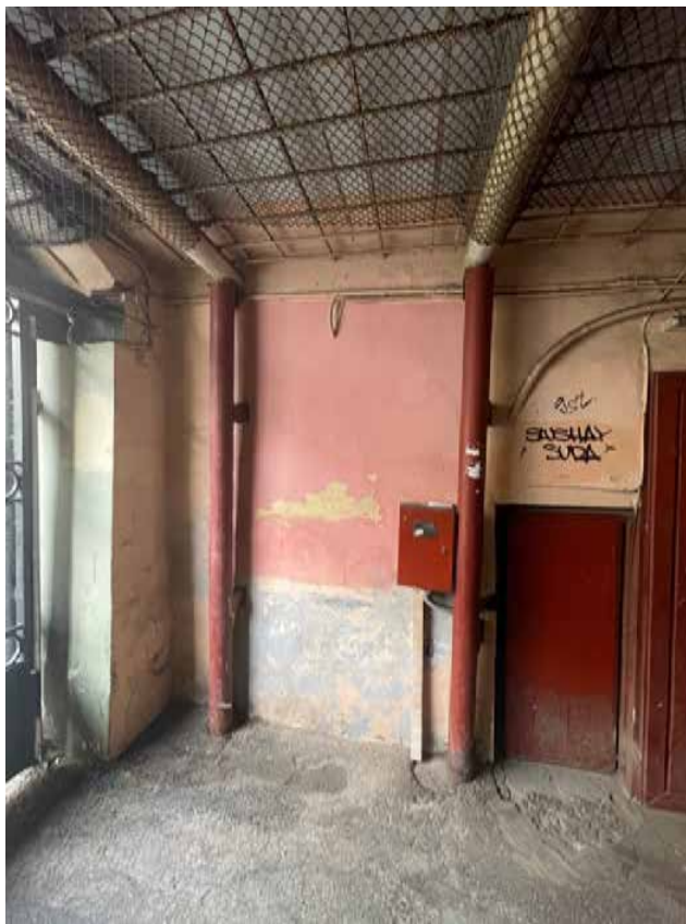
35. Проездная арка лицевого корпуса (фрагмент). Выявленный объект культурного наследия «Дом Ю. Н. Адельсон», расположенный по адресу: г. Санкт-Петербург, Гороховая ул, дом 33, литера А
