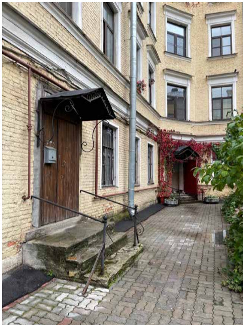
25. Дворовый корпус, первый двор (фрагмент). Выявленный объект культурного наследия «Дом Ю. Н. Адельсон», расположенный по адресу: г. Санкт-Петербург, Гороховая ул, дом 33, литера А
