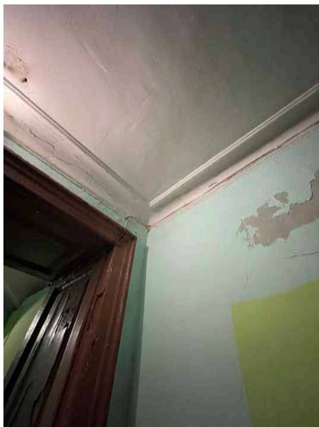
45. Профилированный карниз парадной. Выявленный объект культурного наследия «Дом Ю. Н. Адельсон», расположенный по адресу: г. Санкт-Петербург, Гороховая ул, дом 33, литера А
