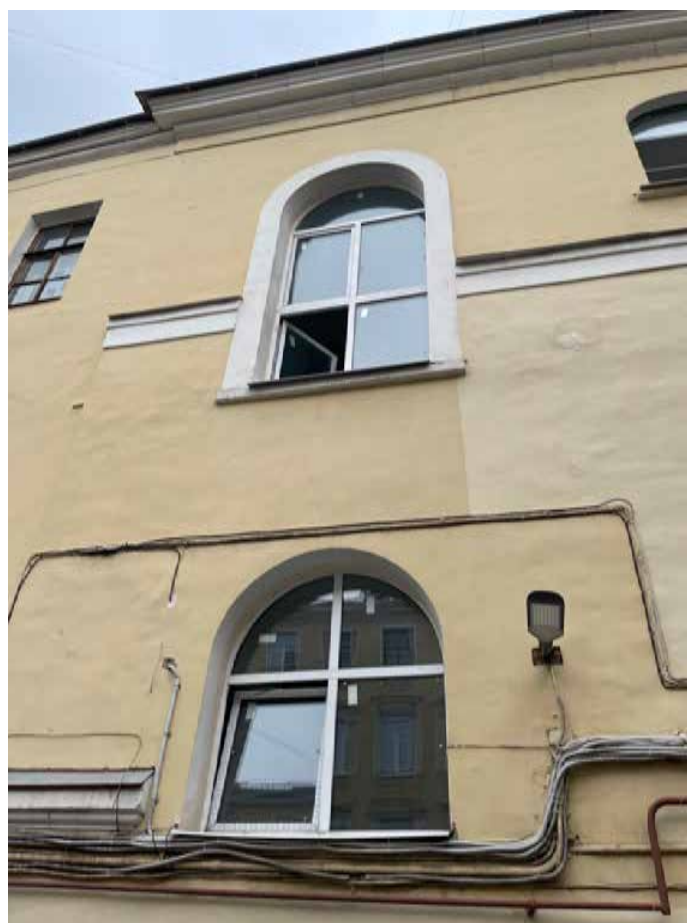
34. Дворовый фасад лицевого корпуса в световой оси 11 в уровне 2, 3 этажей. Выявленный объект культурного наследия «Дом Ю. Н. Адельсон», расположенный по адресу: г. Санкт-Петербург, Гороховая ул, дом 33, литера А
