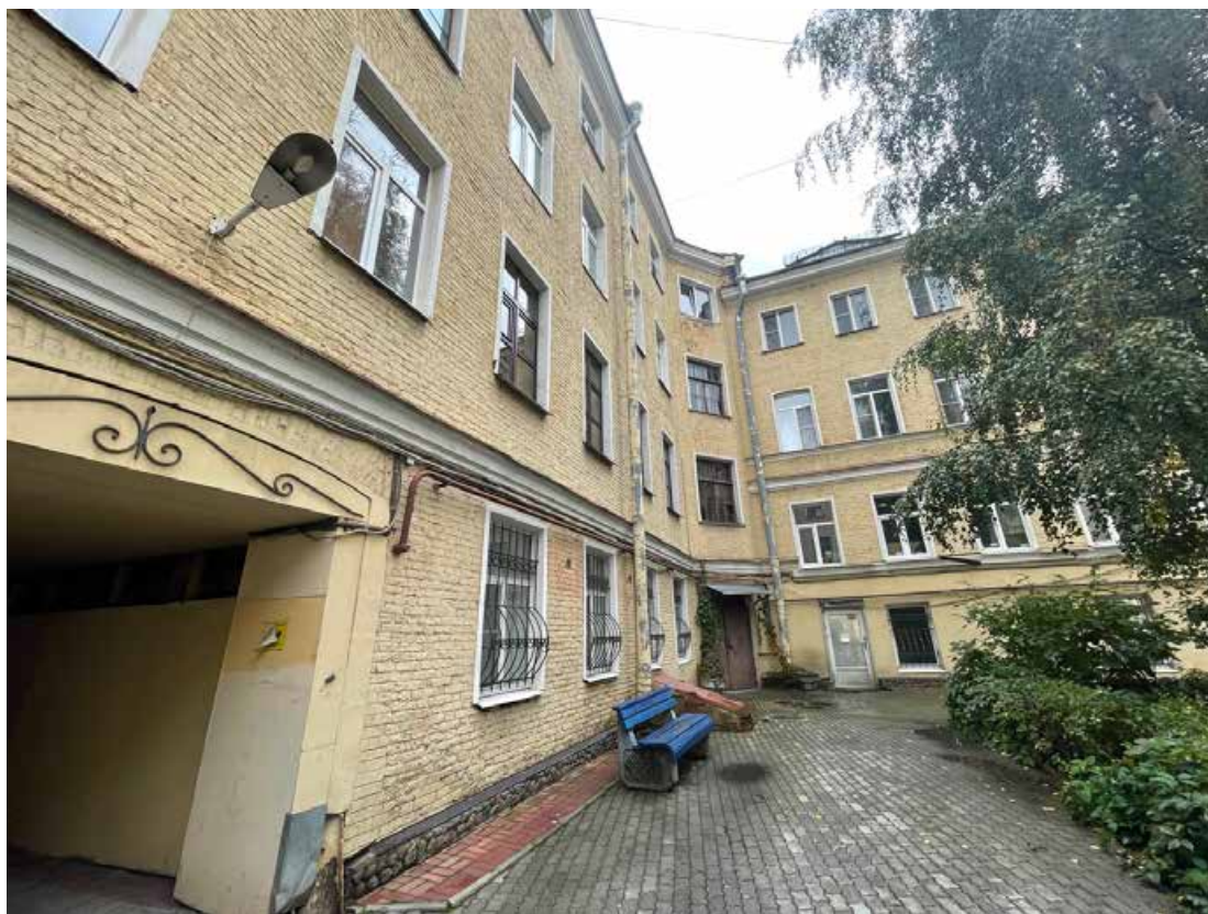
29. Дворовый корпус, второй двор (фрагмент). Выявленный объект культурного наследия «Дом Ю. Н. Адельсон», расположенный по адресу: г. Санкт-Петербург, Гороховая ул, дом 33, литера А
