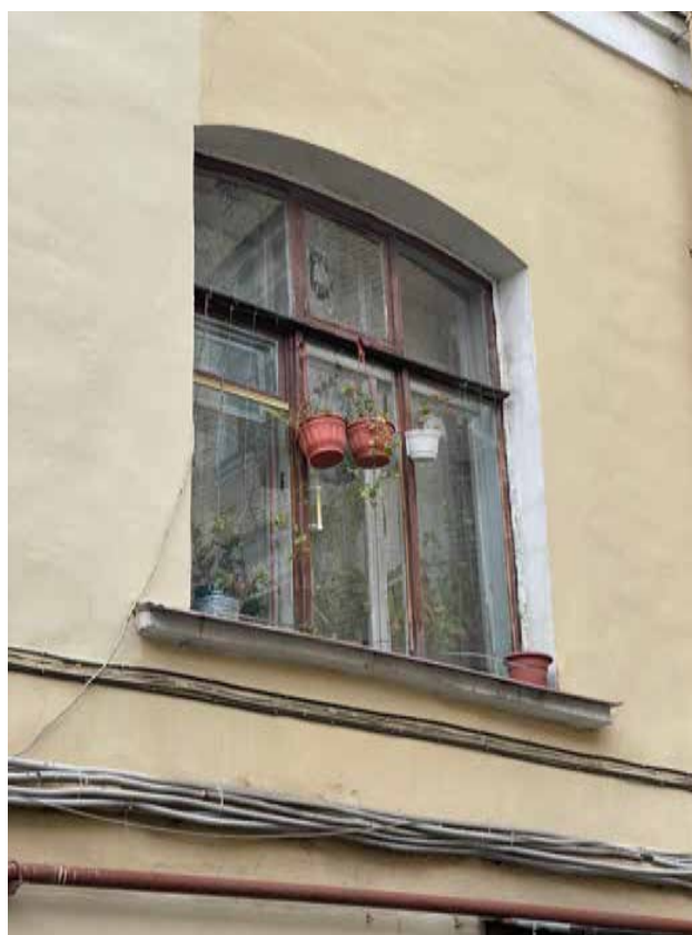
16. Дворовый фасад лицевого корпуса. Деревянное заполнение оконного проема с лучковым завершением по световой оси 11 в уровне 2 этажа. Выявленный объект культурного наследия «Дом Ю. Н. Адельсон», расположенный по адресу: г. Санкт-Петербург, Гороховая ул, дом 33, литера А
