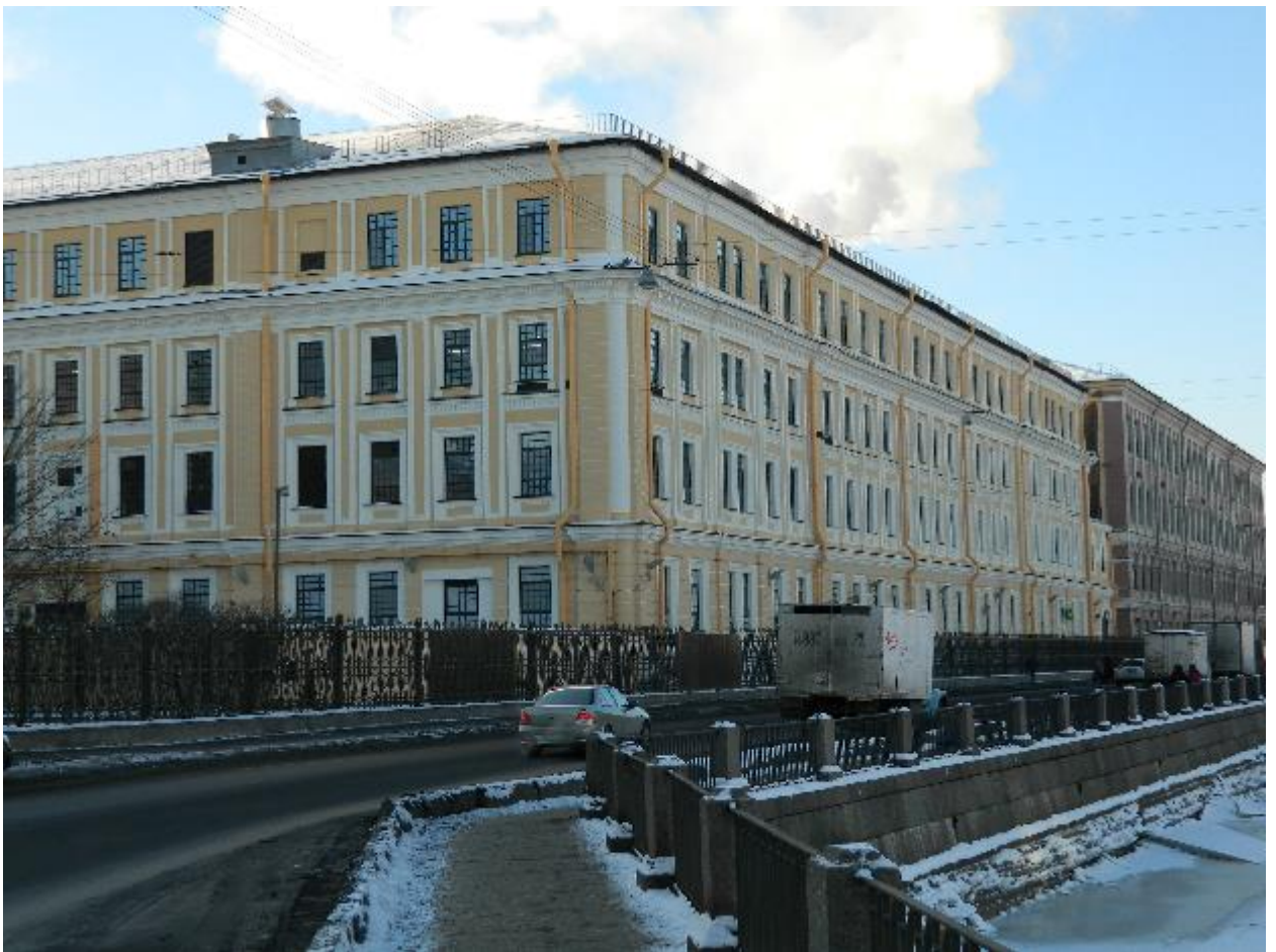
2. Объект культурного наследия федерального значения «Ограда», расположенного по адресу: г. Санкт-Петербург, наб. реки Фонтанки, 144, Рижский пр., 5, 7, входящего в состав объекта культурного наследия федерального значения «Экспедиция заготовления государственных бумаг». Вид с наб. реки Фонтанки. 20.03.2022
