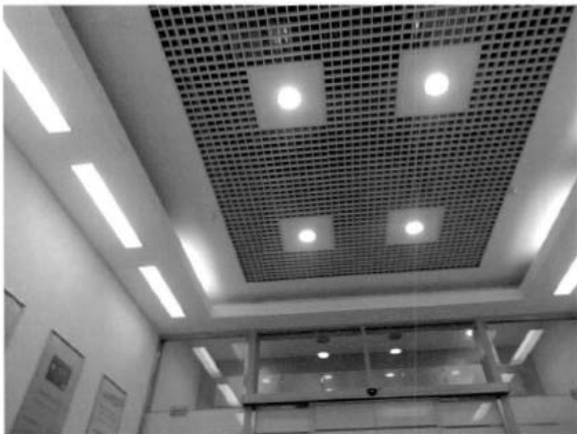
Фото №12. Перекрытие тамбура 1-го этажа.
