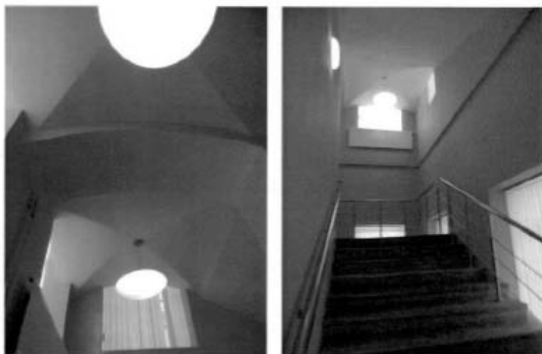
Фото №7, 8. Сводчатые перекрытия лестниц и лестничный марш.
