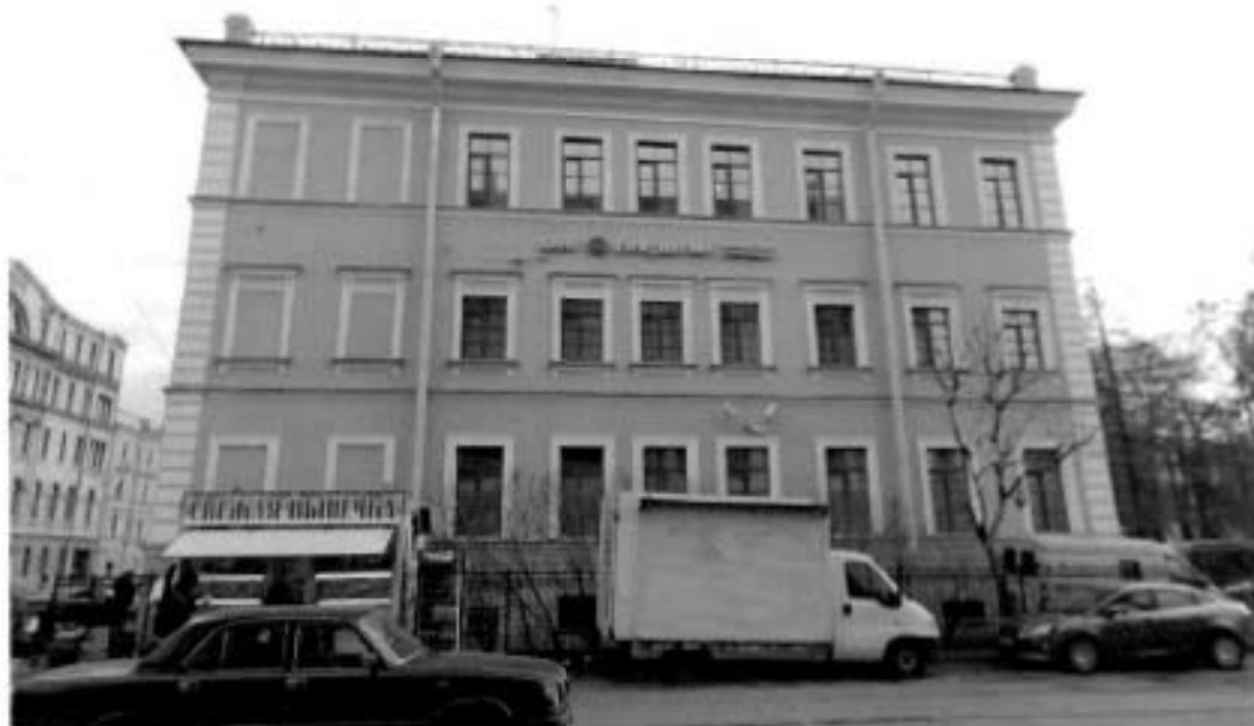
Фото №4. Торцевой (северо-западный) фасад.
