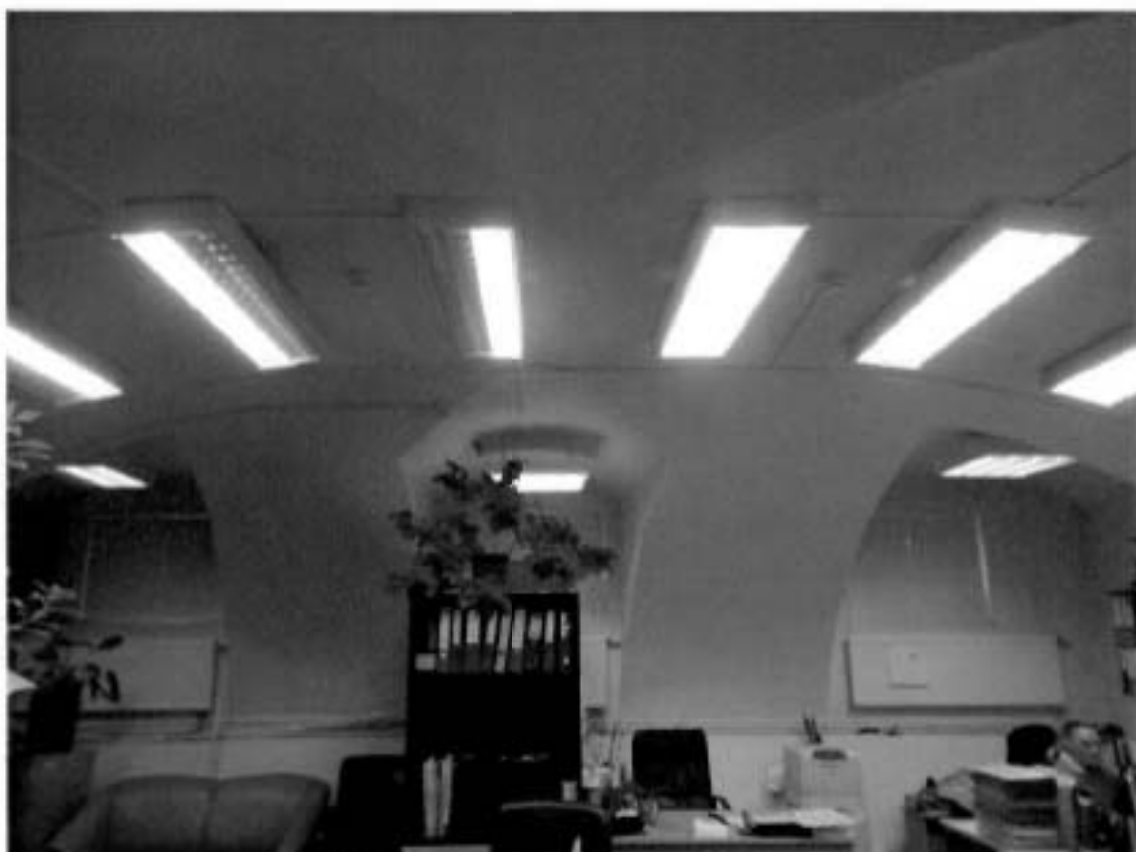
Фото №9. Сводчатые перекрытия цокольного этажа.
