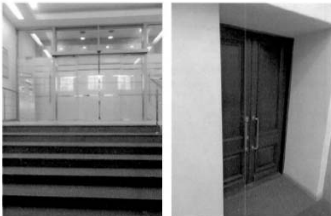
Фото №10, 11. Входные группы тамбура 1-го этажа.
