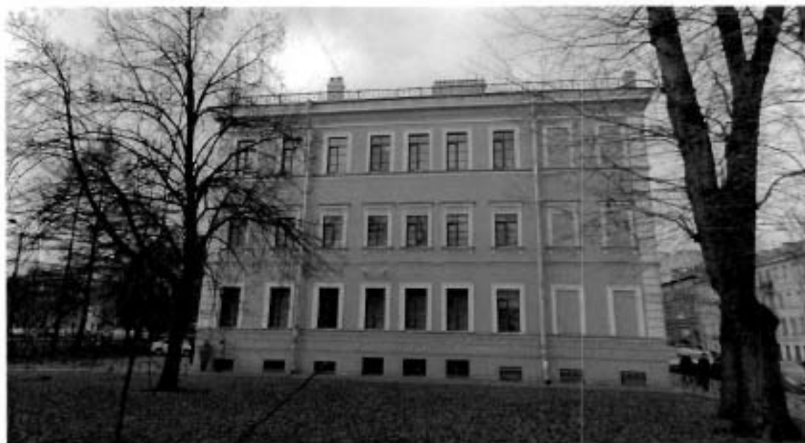
Фото №5. Торцевой (юго-восточный) фасад.
