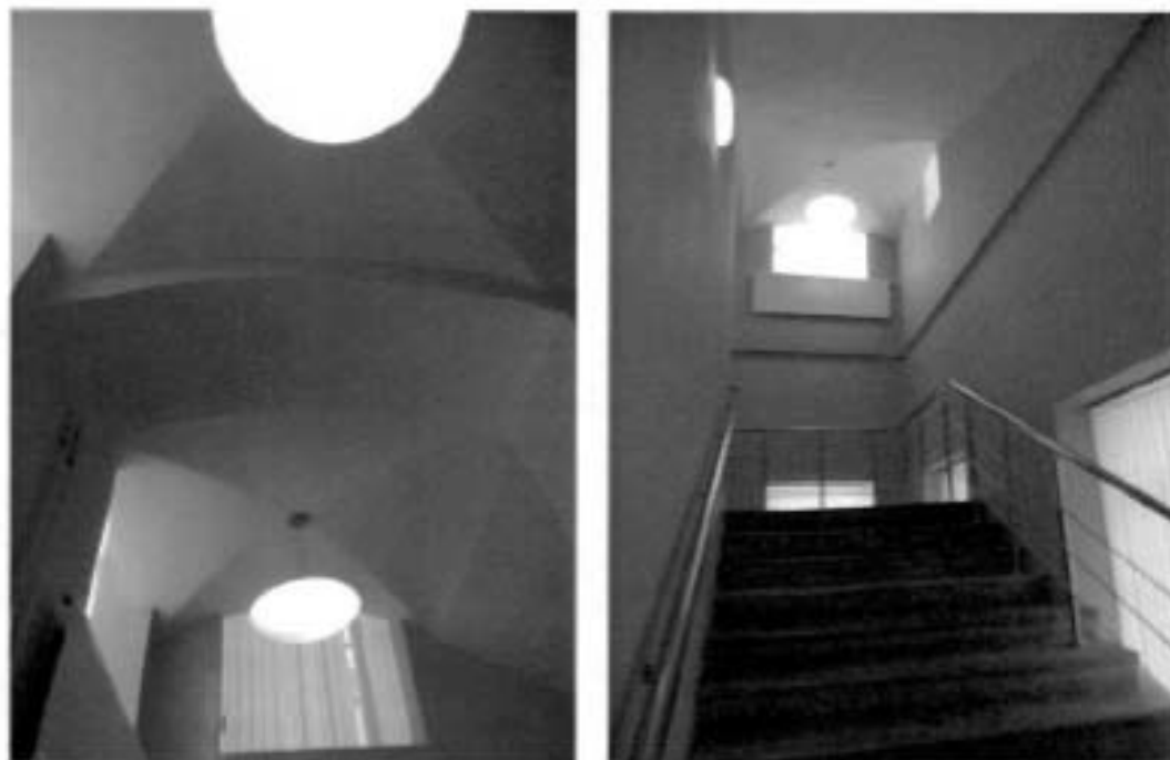
Фото №7, 8. Сводчатые перекрытия лестниц и лестничный марш.
