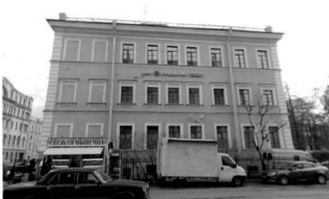
Фото №4. Торцевой (северо-западный) фасад.
