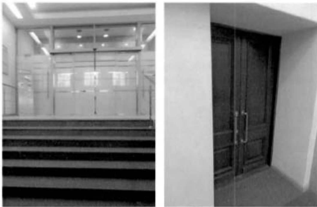
Фото №10, 11. Входные группы тамбура 1-го этажа.
