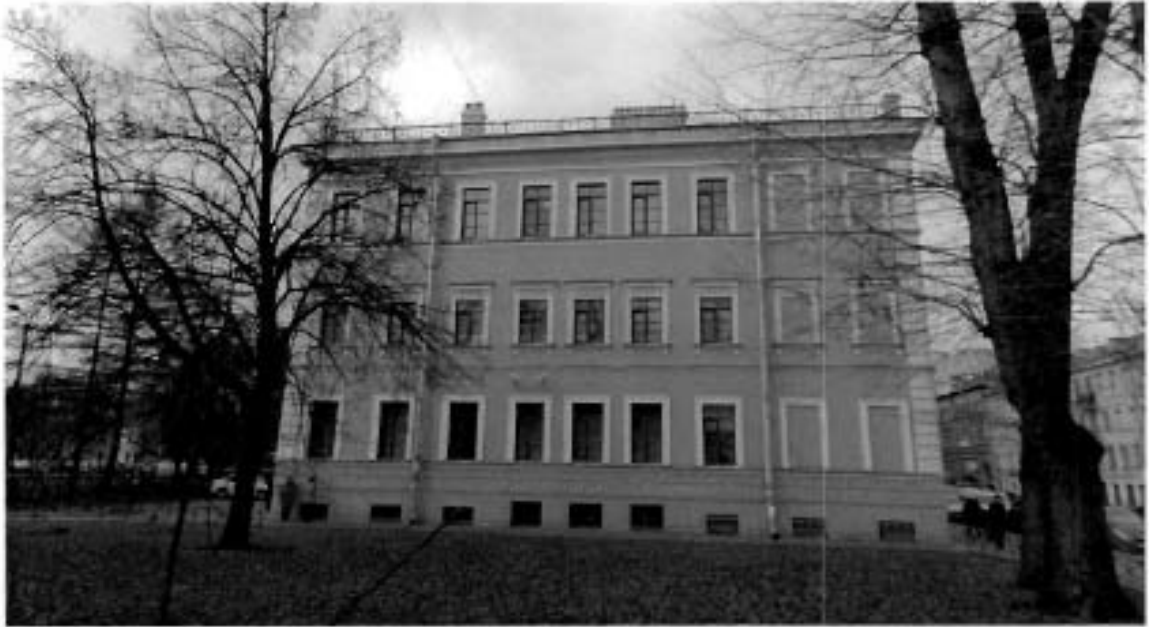
Фото №5. Торцевой (юго-восточный) фасад.
