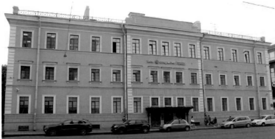
Фото №1. Лицевой фасад. Вид со стороны ул. Звенигородской.
