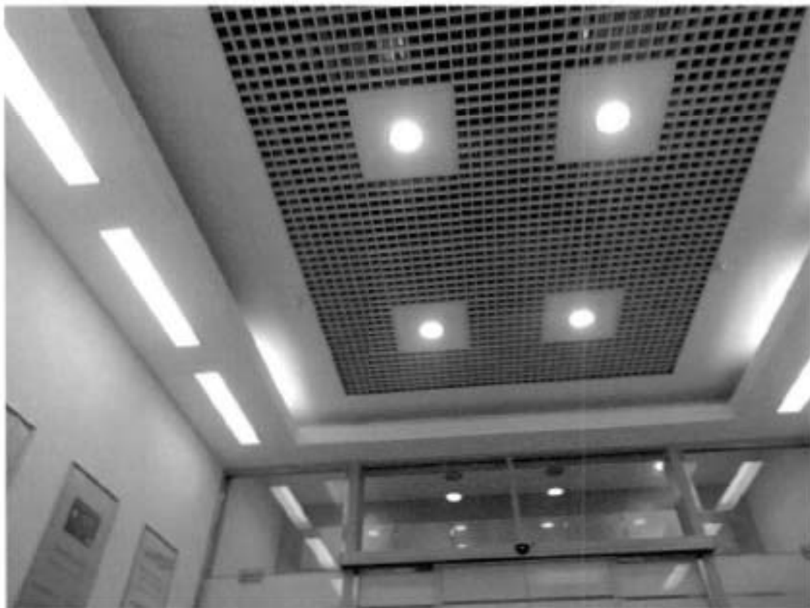
Фото №12. Перекрытие тамбура 1-го этажа.
